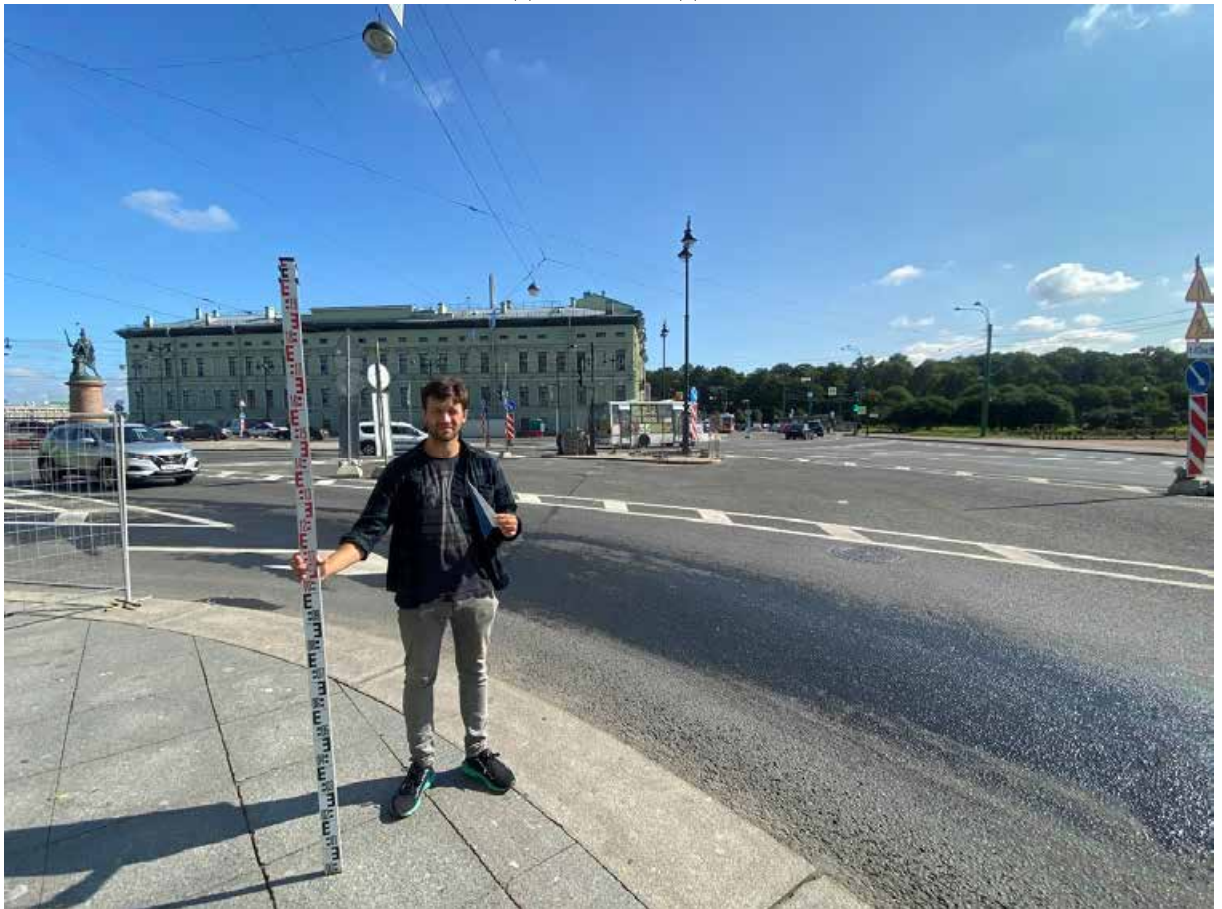
Рис. 23. СПб, Центральный район, Суворовская площадь. ТФ 8. Общий вид территории обследования. Вид с ЮВ
