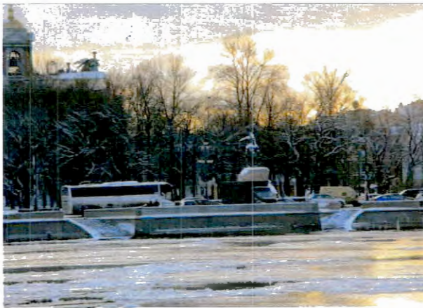
9. Устой береговой Исаакиевского наплавного моста
