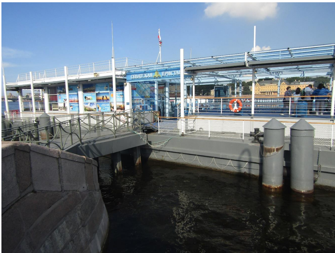
Фото 17. Вид на траповый переход, дебаркадер и швартовно-отбойные палы с северо-востока.
