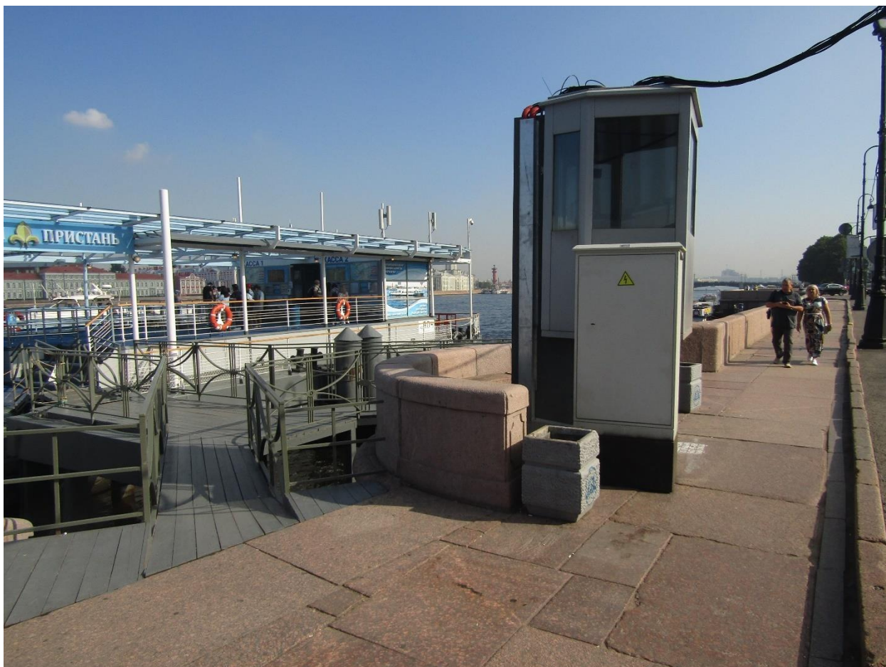
Фото 5. Общий вид трапового перехода и верхней площадки спуска № 4.
