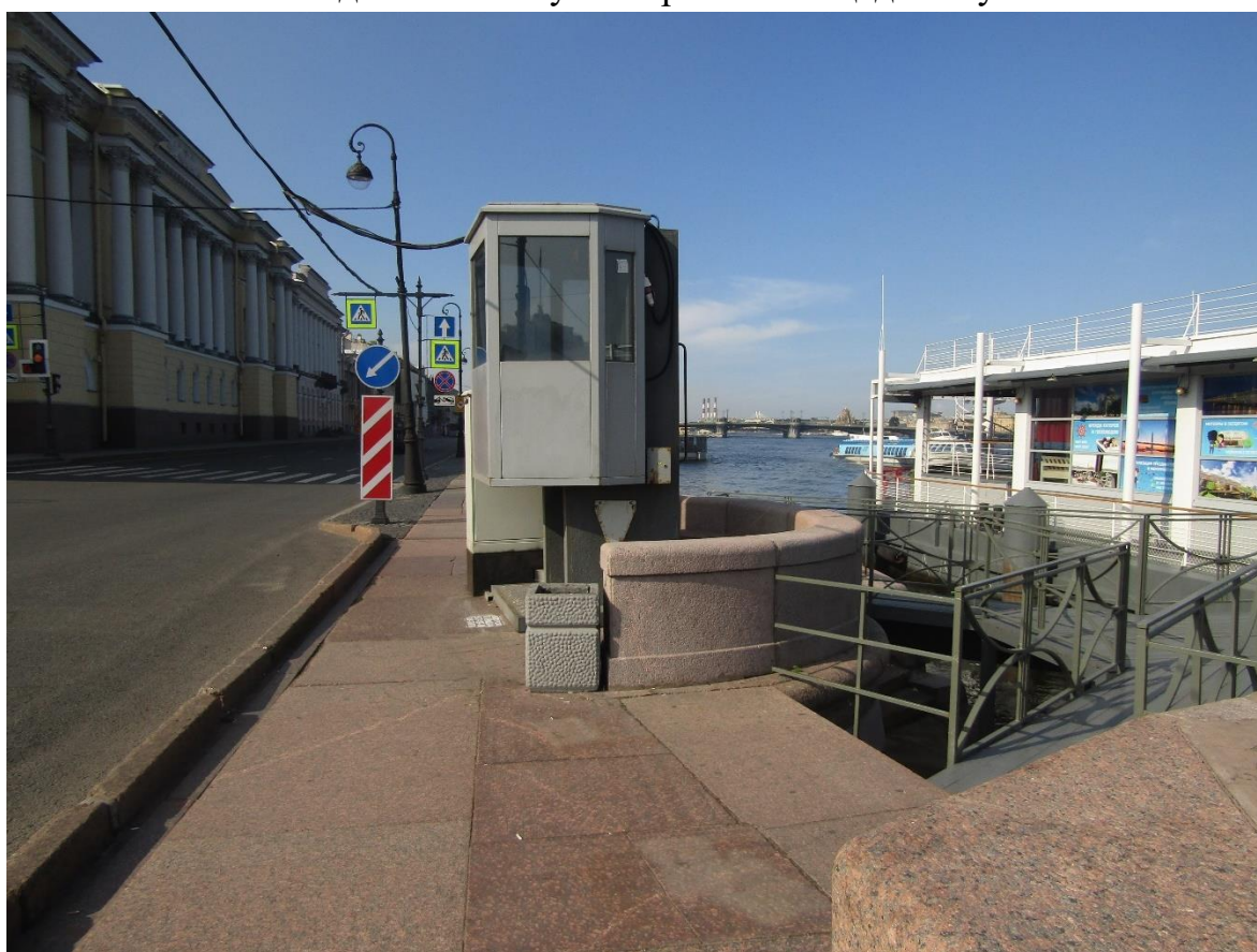
Фото 16. Вид на верхнюю площадку спуска № 4 с северо-востока.
