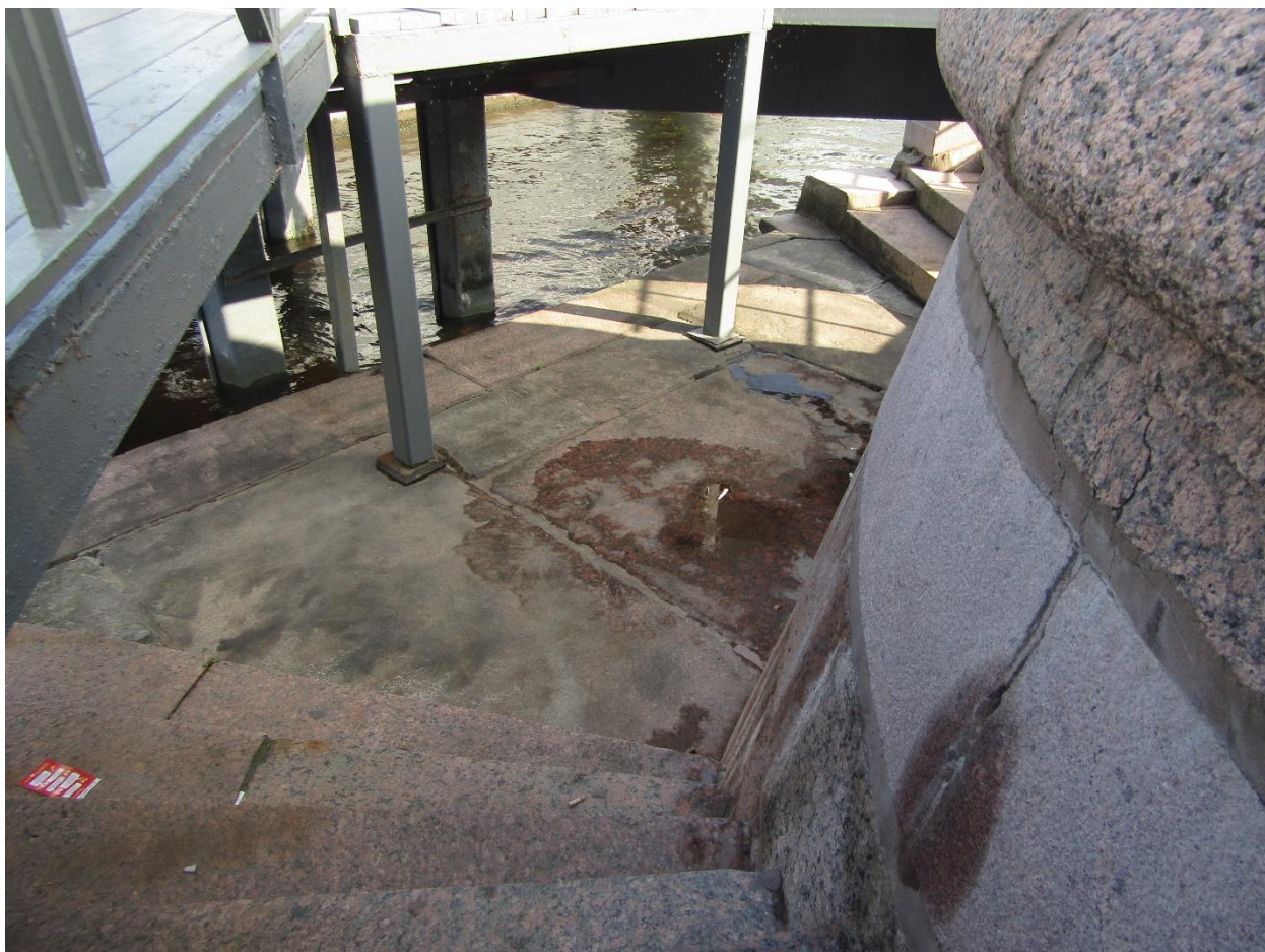
Фото 7. Вид на нижнюю площадку спуска № 4.
