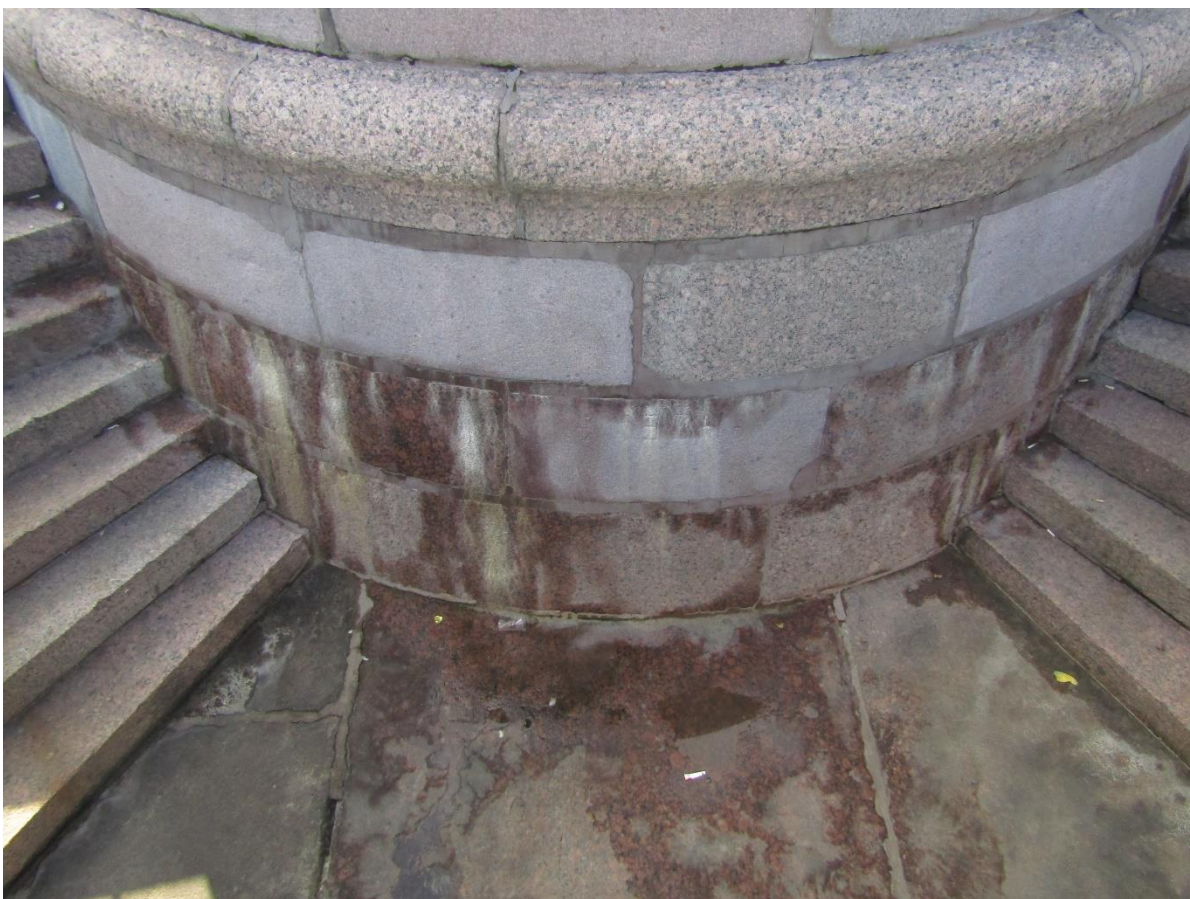
Фото 13. Вид на нижнюю площадку спуска № 4.
