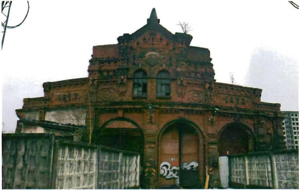
1. Юго-восточный торцевой фасад.
