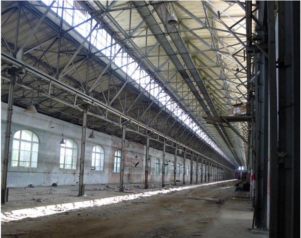
10. Внутренний металлический каркас здания: сборные металлические колонны с болтовым соединением и система металлических ферм перекрытия раскосного типа. Фрагмент.
