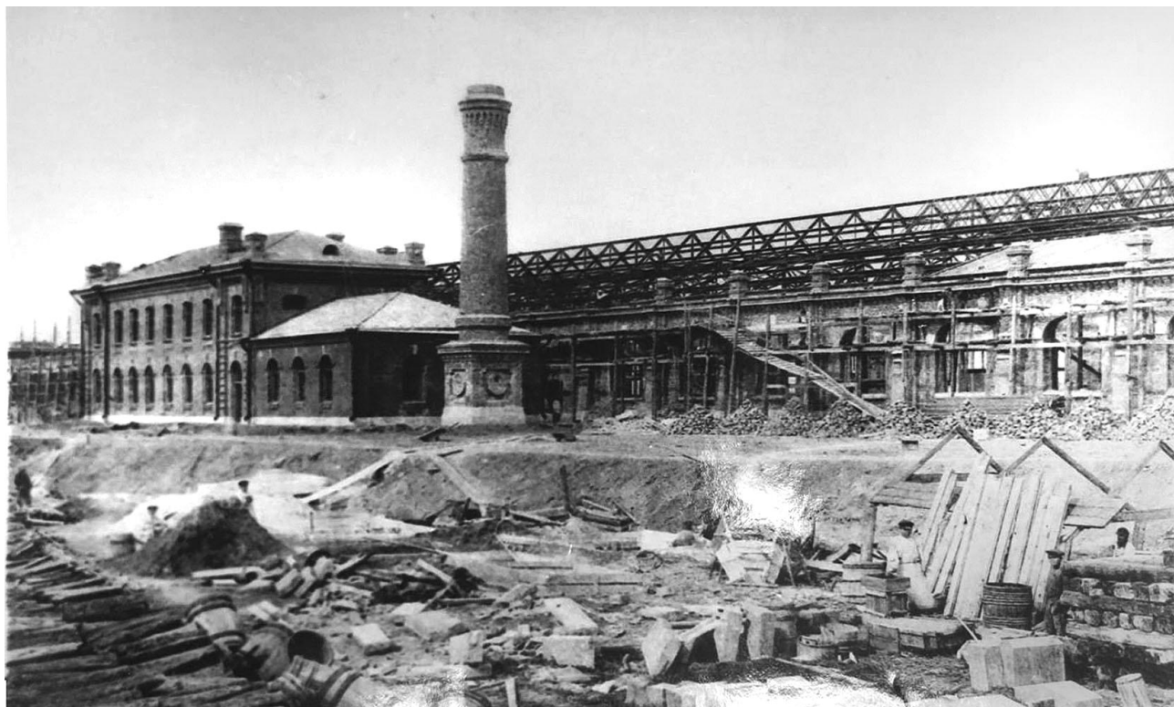
Илл. 17. «Общий вид сарая для Императорских поездов и пристройки к нему. Приготовление цементно-бетонных облицовочных камней». 1897-1898 гг. Акт по результатам государственной историко-культурной экспертизы... 2013 г. Приложение № 2, илл. 32.
