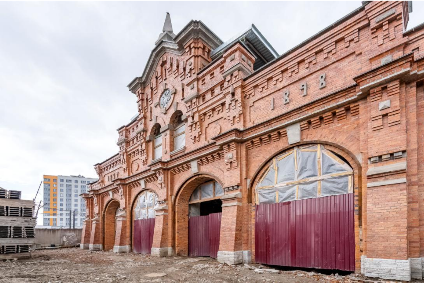
2. Торцевой (юго-восточный) фасад-портал. Общий вид.
