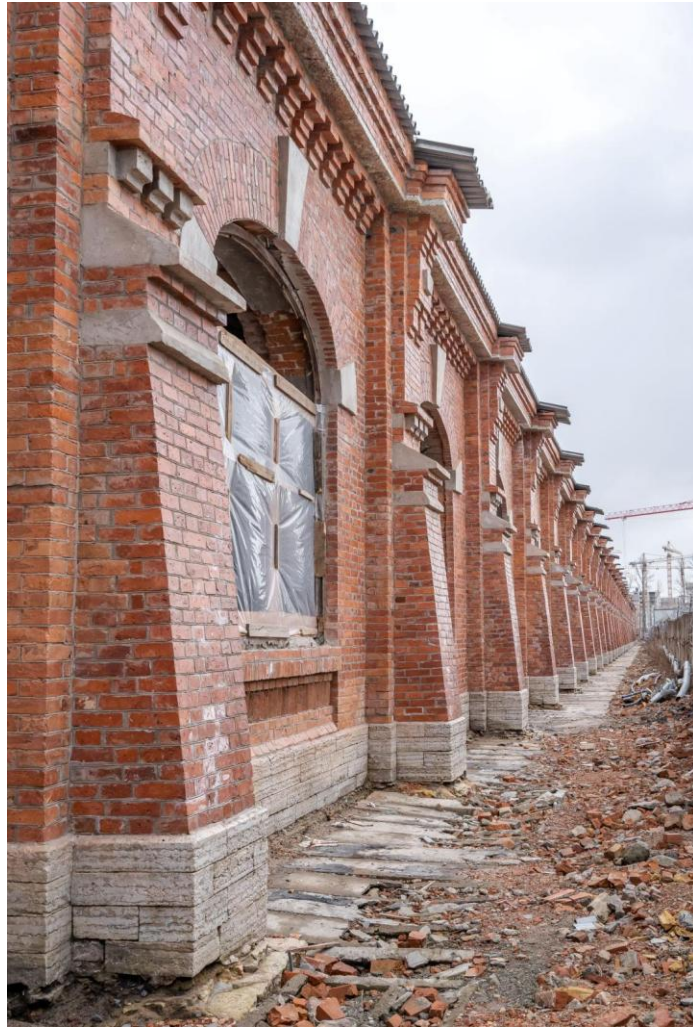
7. Продольный (юго-западный) фасад здания.
