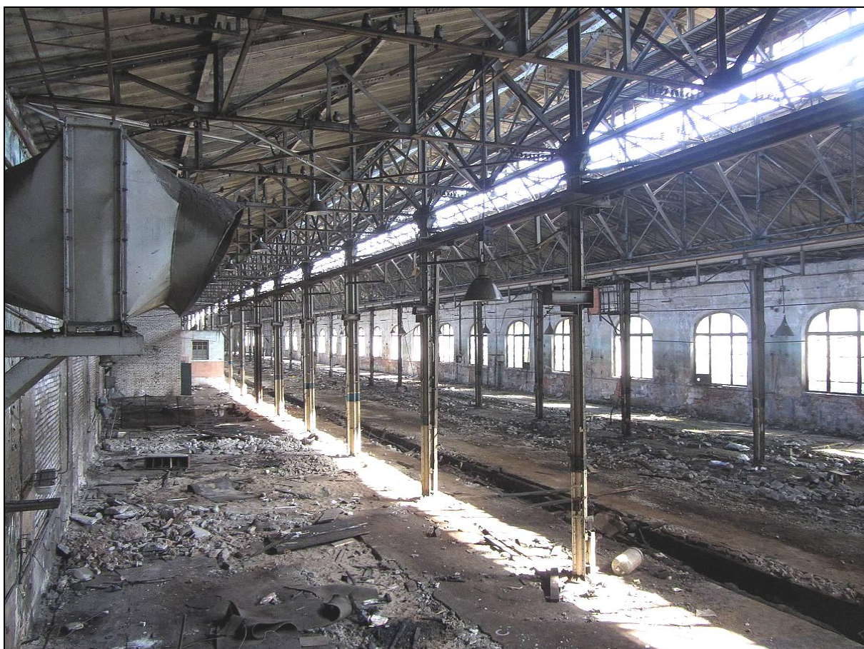
Илл. 33. Внутренне пространство здания. Вид на наружную северо-восточную стену. Фото 2014 г.
