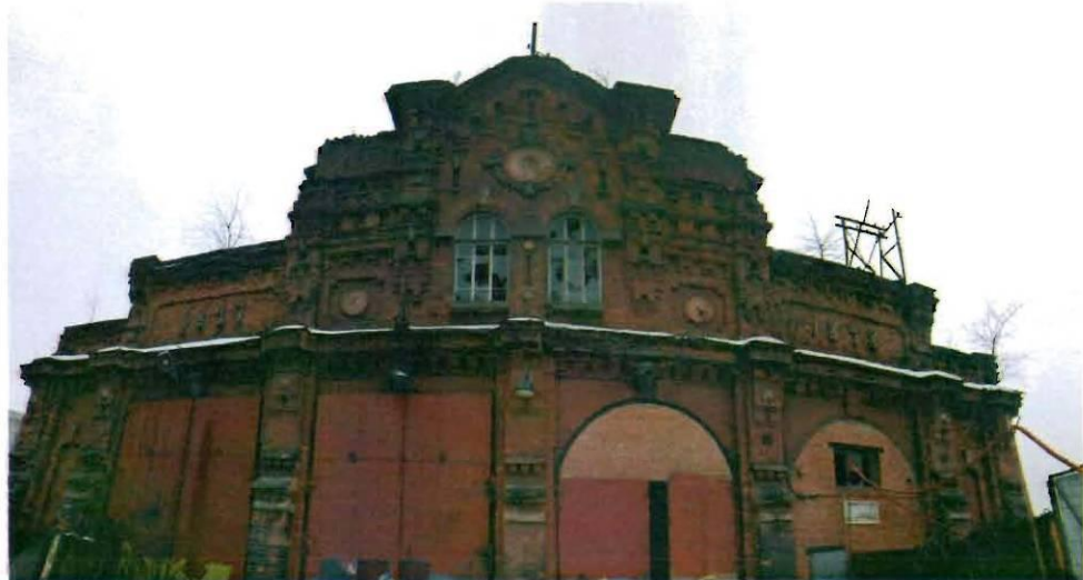
2. Северо-западный торцевой фасад.
