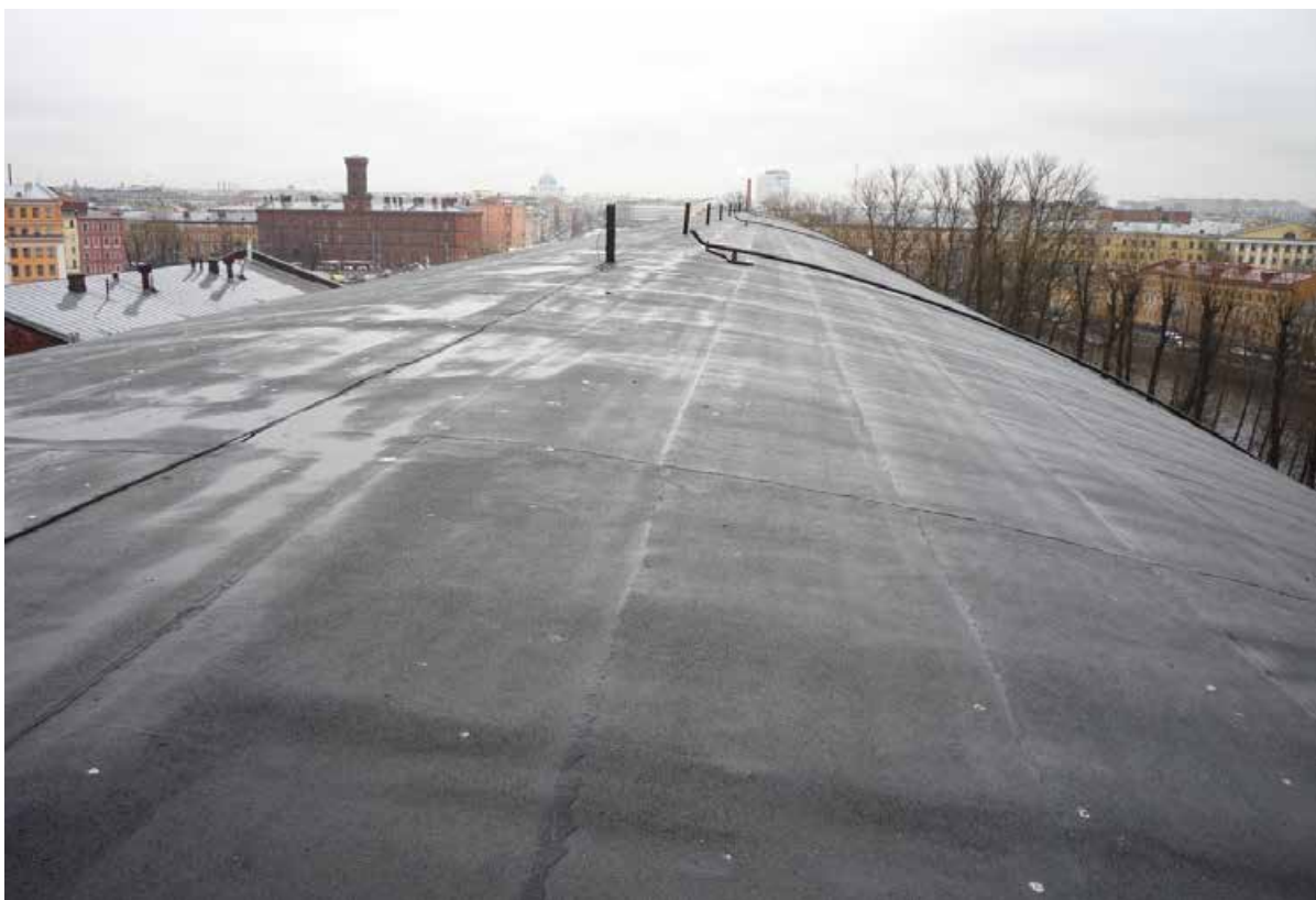
15. Выявленный объект культурного наследия «Разбивочный плаз». Кровля. Вид на восток. Съёмка 23 марта 2021 г.
