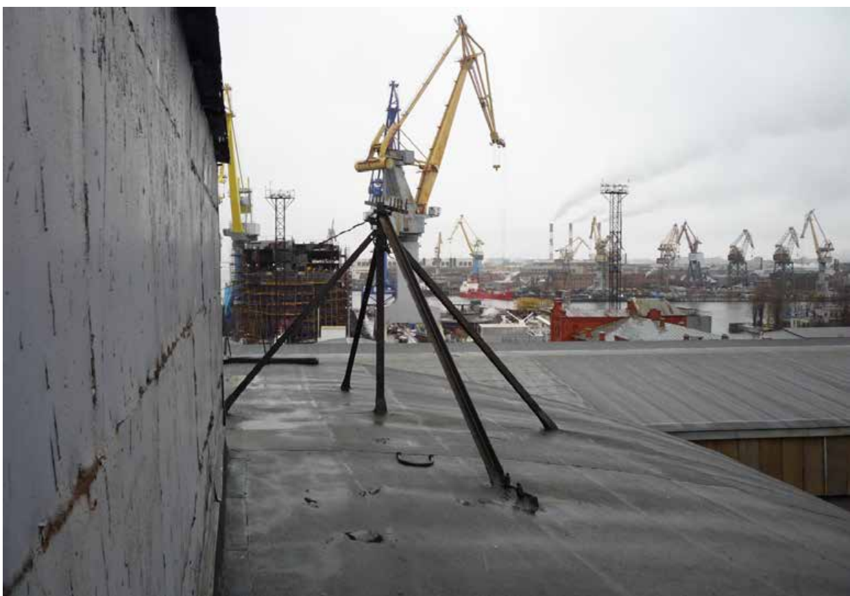
16. Выявленный объект культурного наследия «Разбивочный плаз». Кровля. Вид на запад. Фрагмент. Съёмка 23 марта 2021 г.
