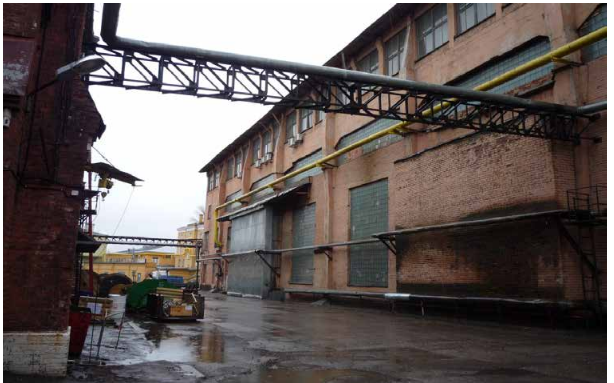
8. Выявленный объект культурного наследия «Разбивочный плаз». Фрагмент северного (продольного) фасада. Съёмка 23 марта 2021 г.
