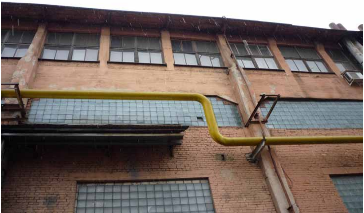
12. Выявленный объект культурного наследия «Разбивочный плаз». Фрагмент южного (продольного) фасада. Съёмка 23 марта 2021 г.
