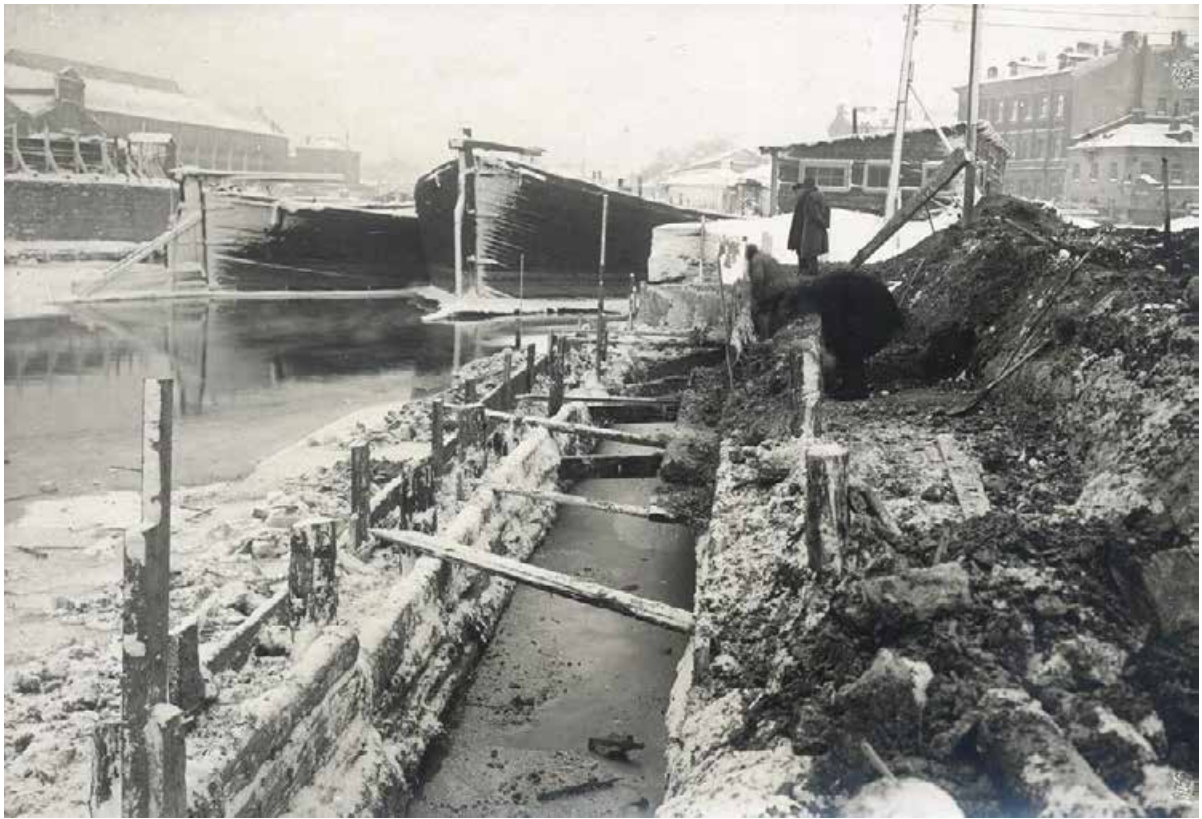
Илл.25. Фонтанка, укрепление берега в районе устья. 1929 г. Код доступа URL: https://pastvu.com/p/535654 . Дата обращения 15 апреля 2021 г.
