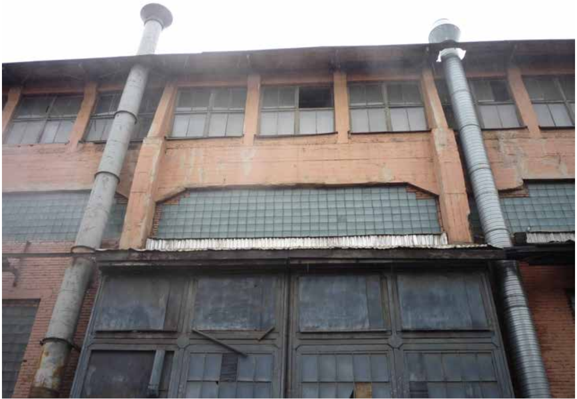
7. Выявленный объект культурного наследия «Разбивочный плаз». Фрагмент северного (продольного) фасада. Съёмка 23 марта 2021 г.
