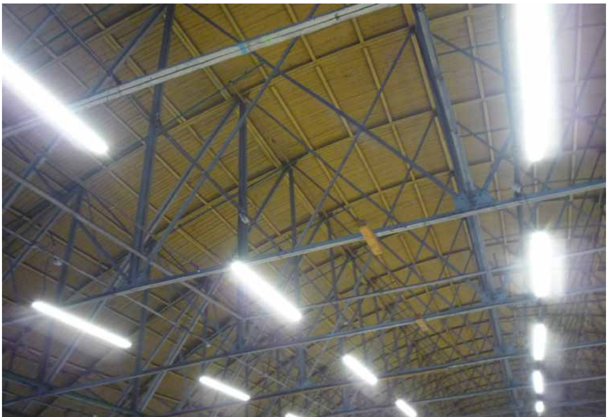
28. Выявленный объект культурного наследия «Разбивочный плаз». Вид цеха на 4 этаже (на запад). Конструкции ферм. Съёмка 23 марта 2021 г.
