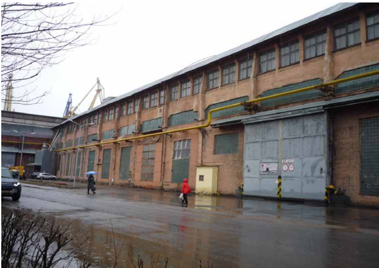
9. Выявленный объект культурного наследия «Разбивочный плаз». Общий вид южного (продольного) фасада. Съёмка 23 марта 2021 г.
