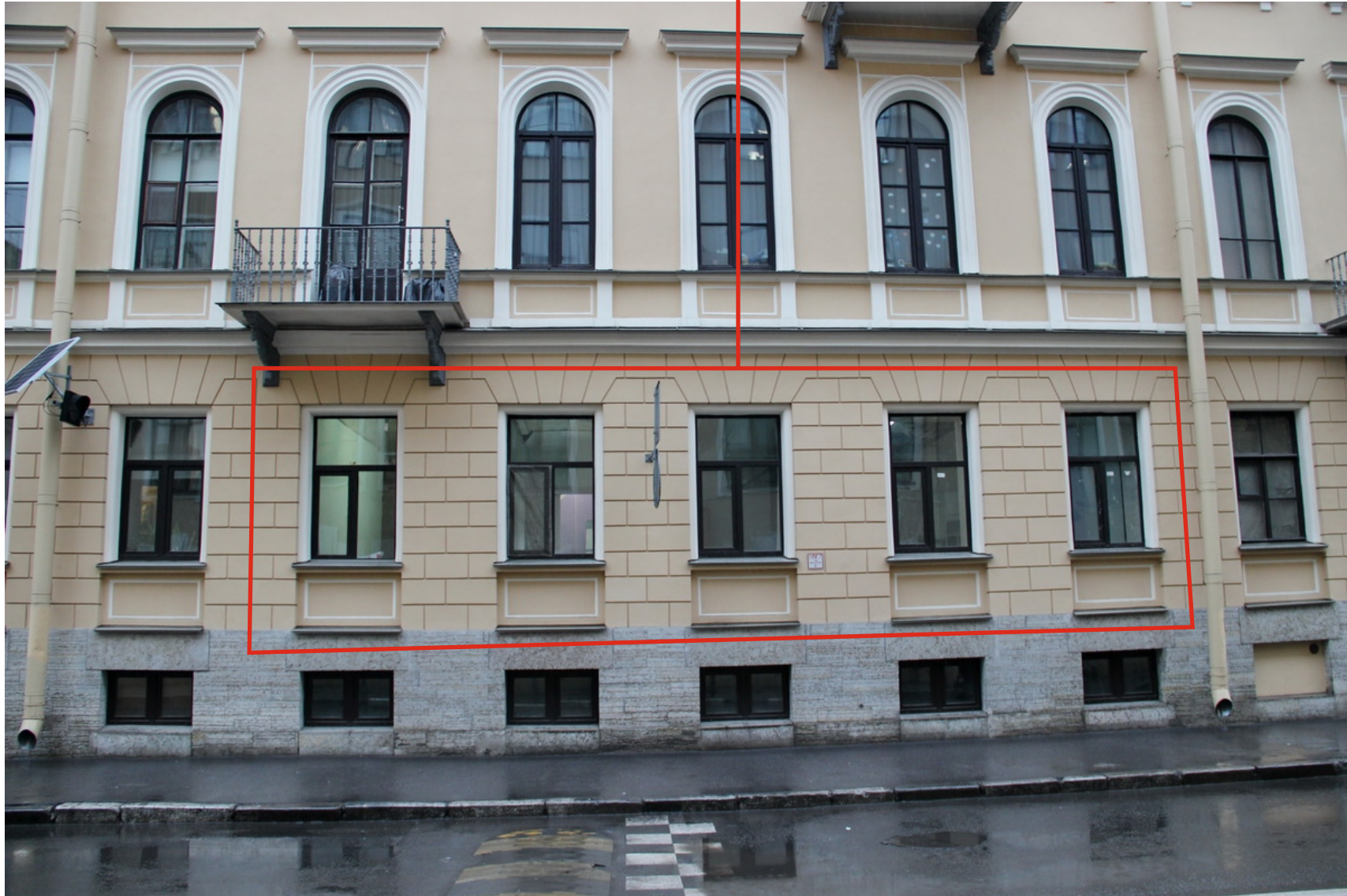
2 Санкт-Петербург, наб. реки Мойки, д. 82, Лит. А, кв. 45 Вид на восточный фасад здания с Фонарного пер. Дата съемки: 25.11.2021
