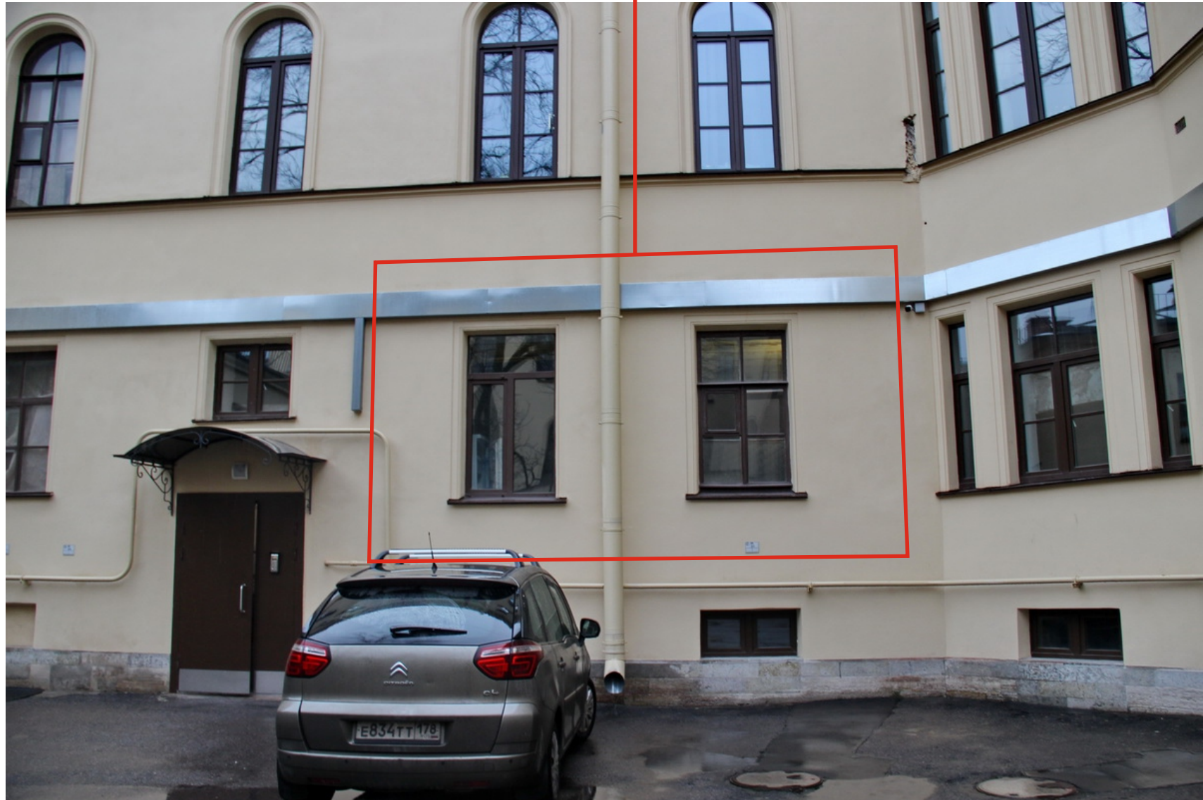
3 Санкт-Петербург, наб. реки Мойки, д. 82, Лит. А, кв. 45 Вид на западный (дворовый) фасад здания Дата съемки: 25.11.2021
