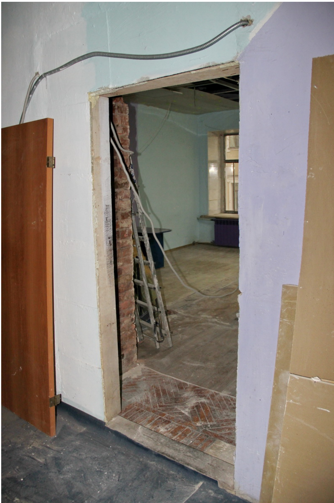
10 Санкт-Петербург, наб. реки Мойки, д. 82, Лит. А, кв. 45 Вид из помещения № 1 на дверной проем в помещение № 2 Дата съемки: 25.11.2021
