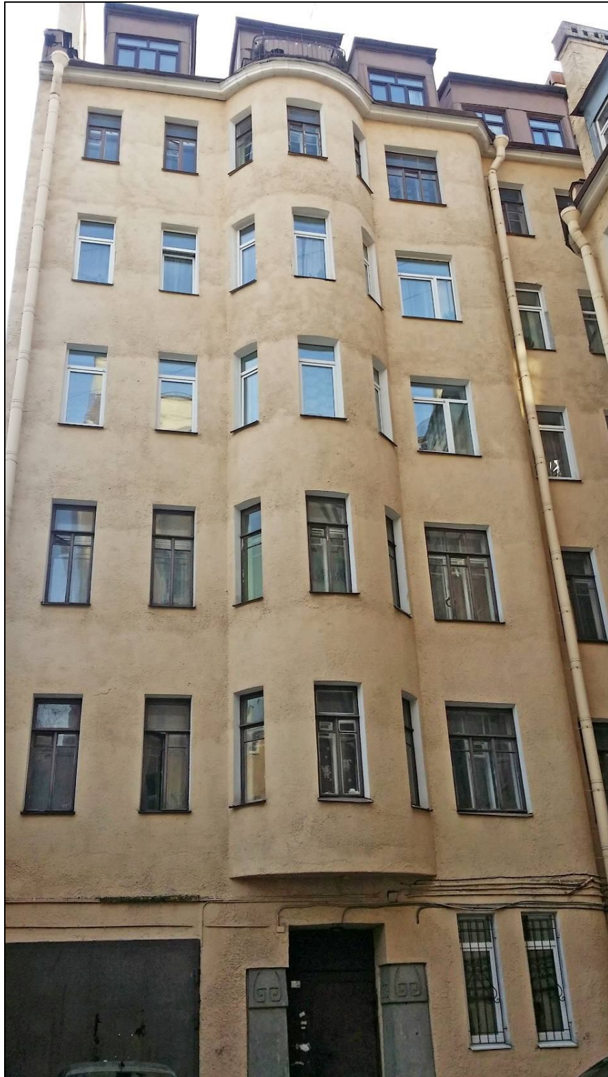
03. Фрагмент дворового фасада юго-восточного дворового флигеля.
