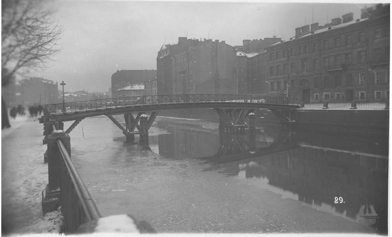
Рис.11. Фотография 1936 г. Источник: https://mostotrest-spb.ru/bridges/kolomenskij
