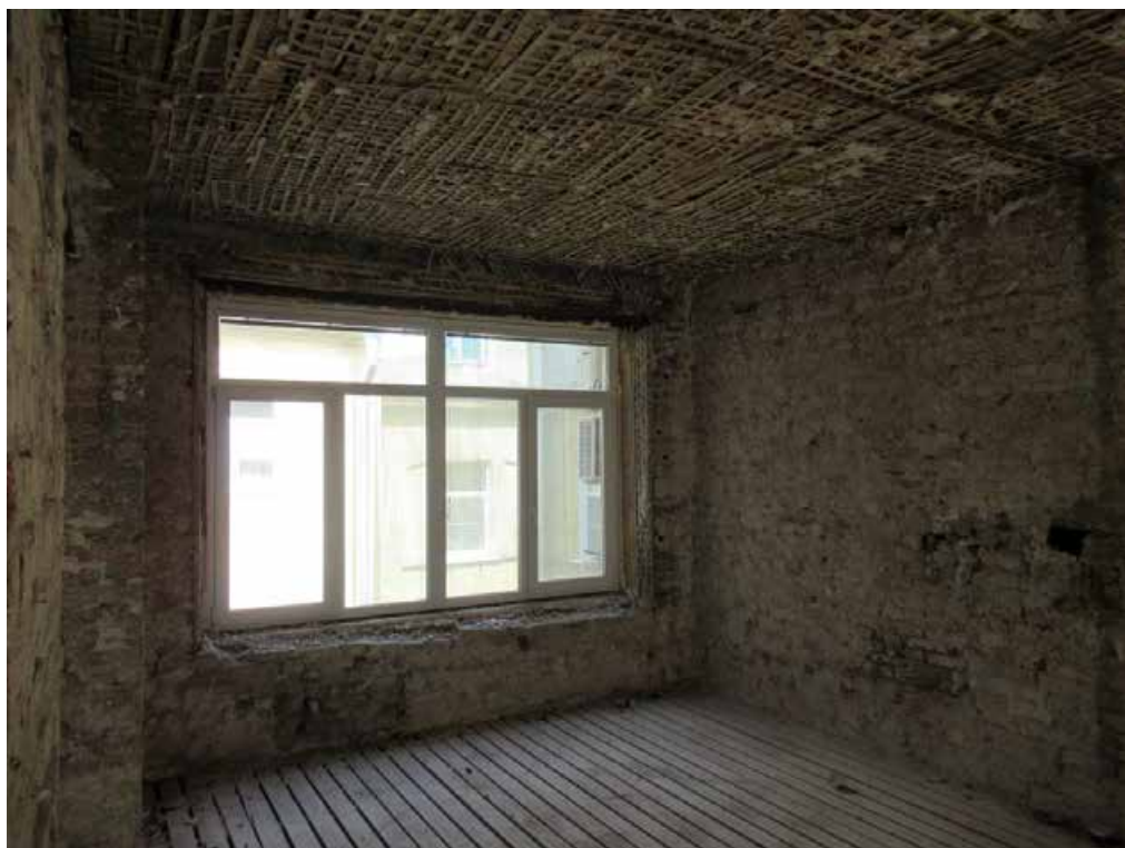
Илл. 65. 4-й этаж. Помещение 87. Съемка 02.04.2021 г. Трушковский В. Э.
