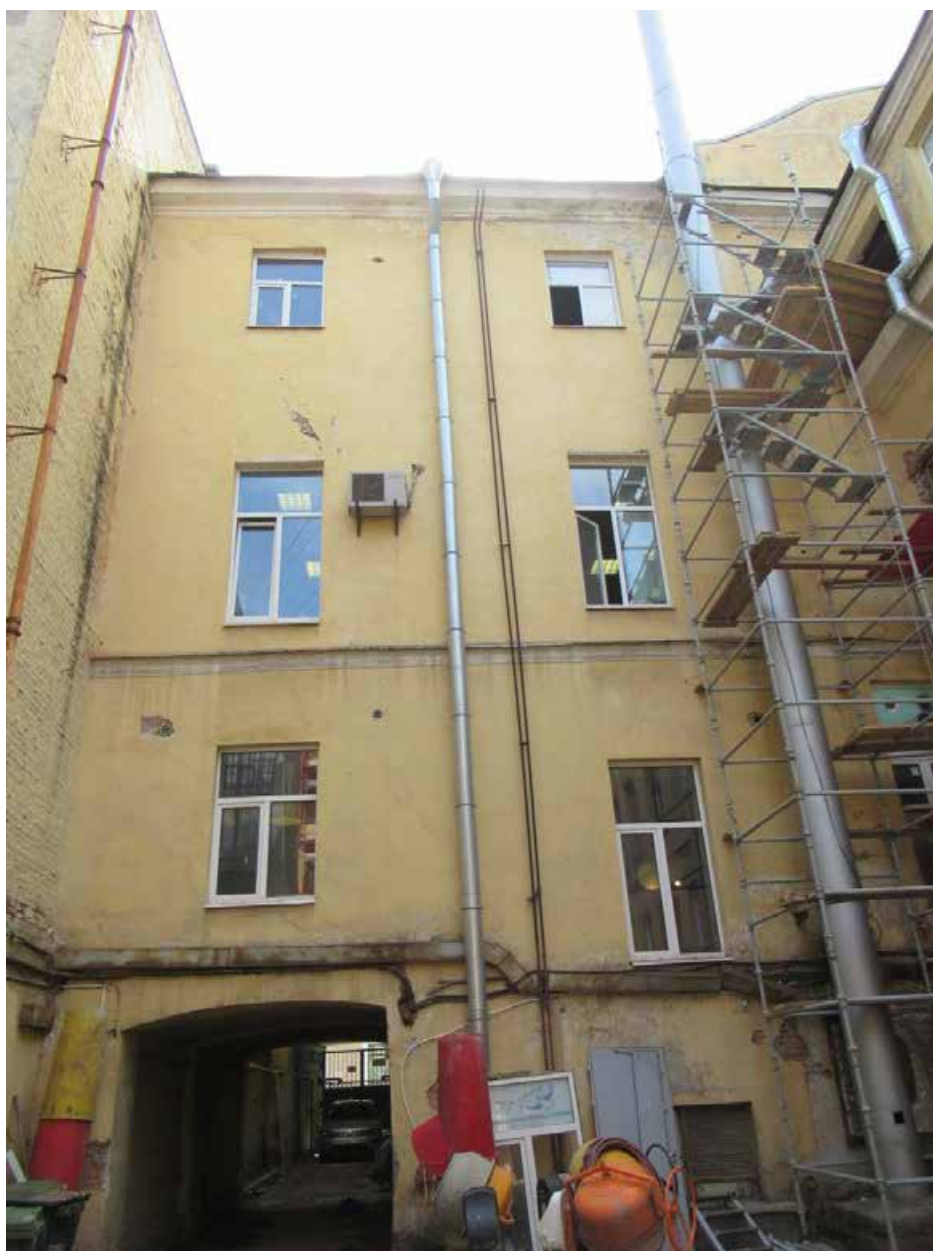
Илл. 5. Здание по адресу: г. Санкт-Петербург, ул. Большая Морская д. 19, литера А. Дворовой фасад. Съемка 02.04.2021 г. Трушковский В. Э.
