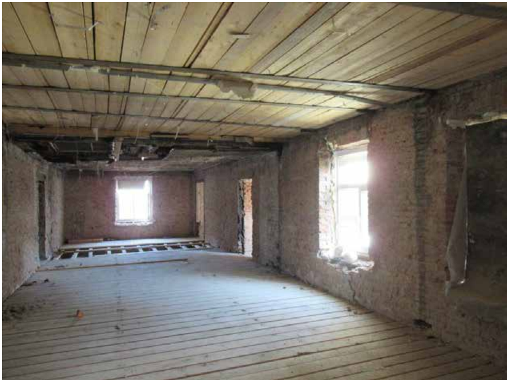
Илл. 58. 4-й этаж. Помещение 86; 84; 83; 81. Съемка 02.04.2021 г. Трушковский В. Э.
