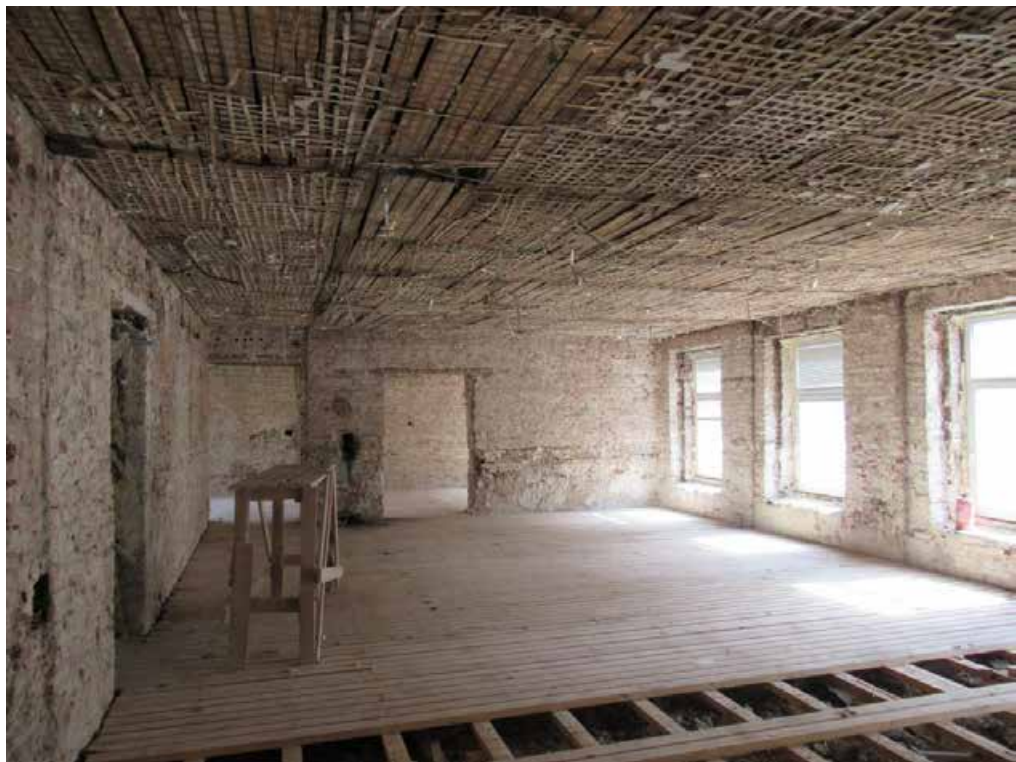
Илл. 64. 4-й этаж. Помещение 90; 91; 89; 88. Съемка 02.04.2021 г. Трушковский В. Э.
