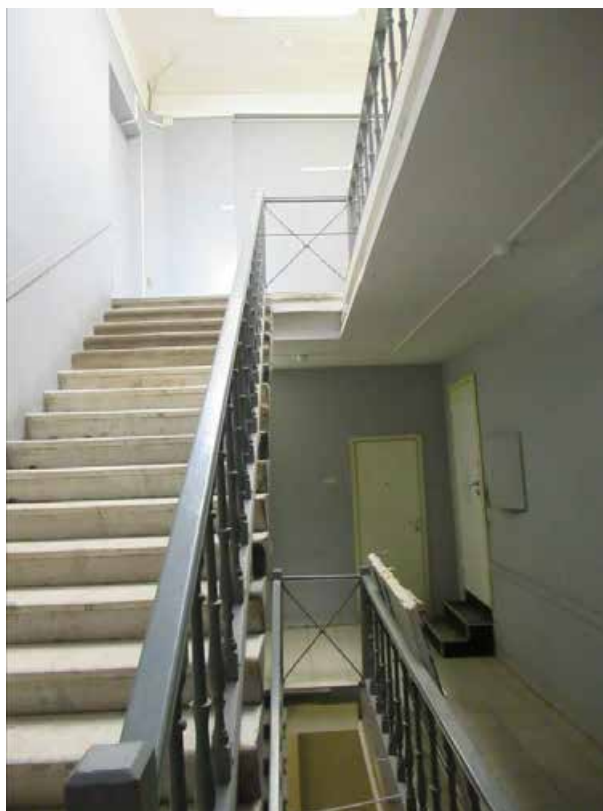
Илл. 56. 4-й этаж. Центральная лестница. Съемка 02.04.2021 г. Трушковский В. Э.
