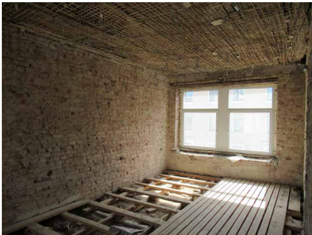
Илл. 69. 5-й этаж. Помещение 112. Съемка 02.04.2021 г. Трушковский В. Э.
