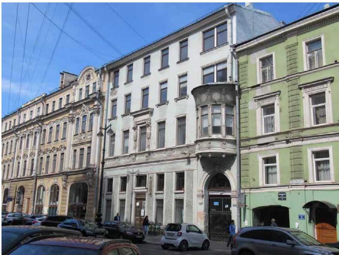
Илл. 01. Вид на здание по адресу: г. Санкт-Петербург, ул. Большая Морская д. 19, литера А с Большой Морской ул. Съемка 02.04.2021 г. Трушковский В. Э.
