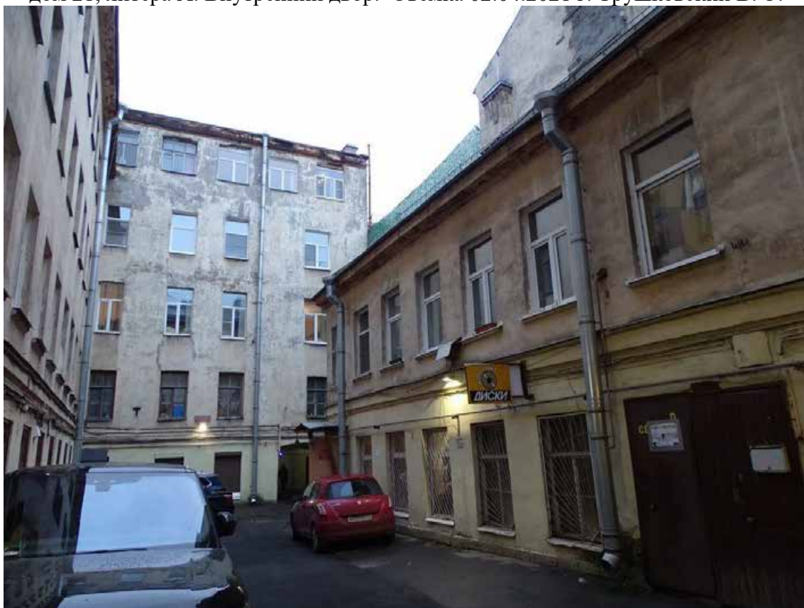
Илл. 04. Здание по адресу: по адресу: г. Санкт-Петербург, Большая Морская улица, дом 21, литера А. Внутренний двор. Съемка 02.04.2021 г. Трушковский В. Э.
