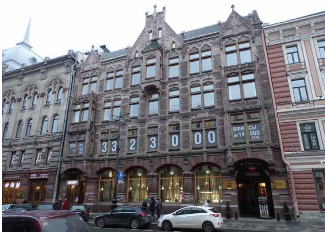
Илл. 02. Здание по адресу: по адресу: г. Санкт-Петербург, Большая Морская улица, дом 22, литера А. Лицевой корпус. Вид с Большой Морской ул. Съемка 02.04.2021 г. Трушковский В. Э.
