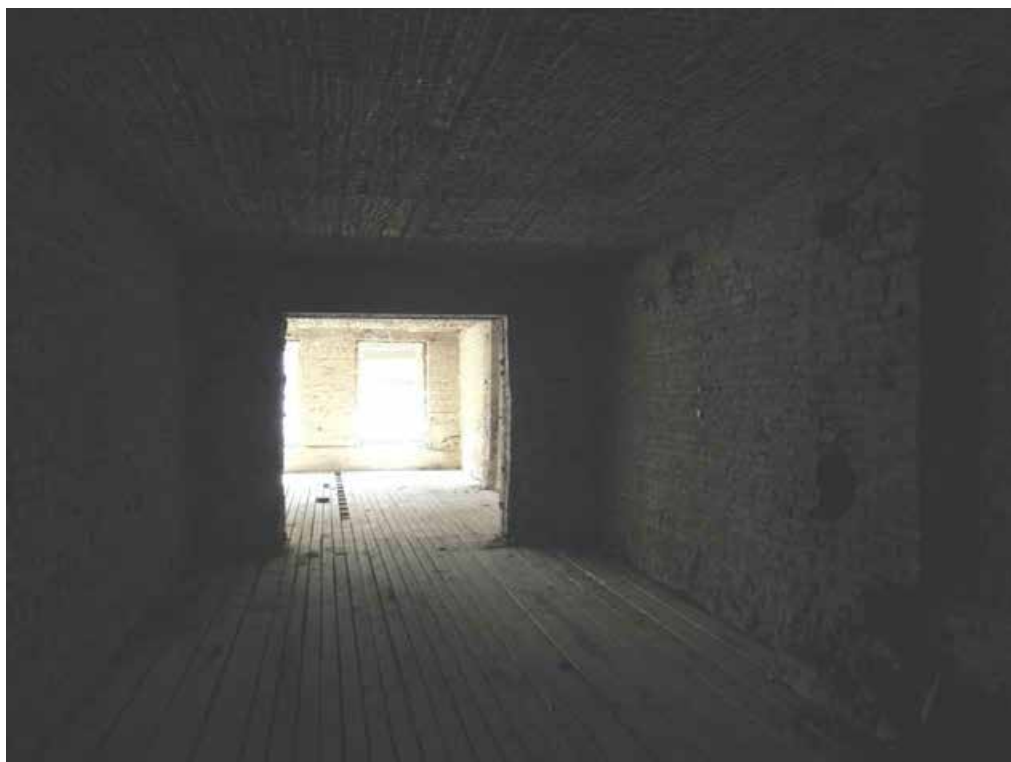
Илл. 62. 4-й этаж. Помещение 92. Съемка 02.04.2021 г. Трушковский В. Э.
