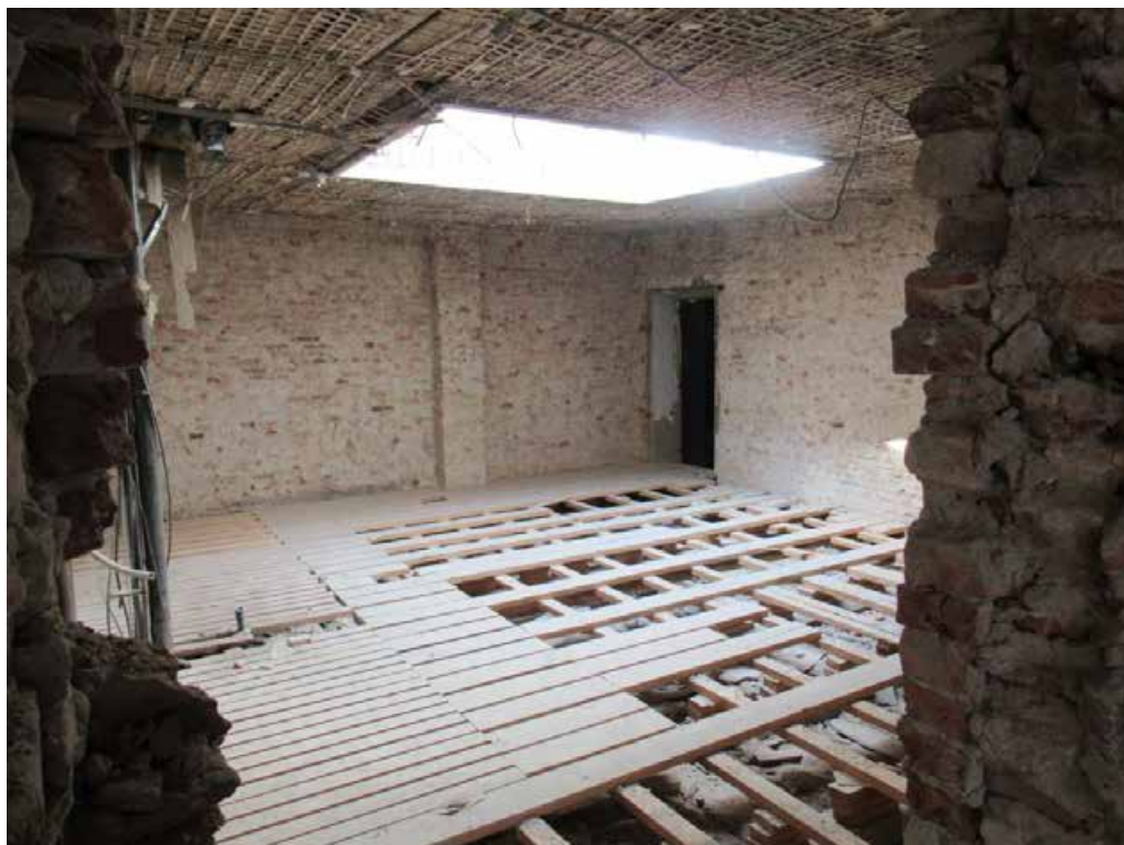
Илл. 73. 5-й этаж. Помещение 120; 121. Съемка 02.04.2021 г. Трушковский В. Э.
