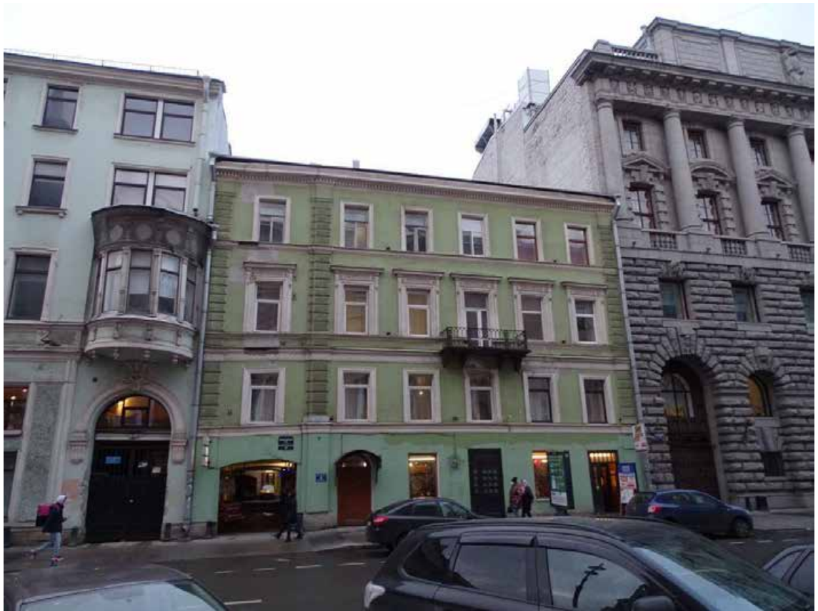
Илл. 01. Здание по адресу: по адресу: г. Санкт-Петербург, Большая Морская улица, дом 21, литера А. Лицевой корпус. Вид с Большой Морской ул. Съемка 02.04.2021 г. Трушковский В. Э.
