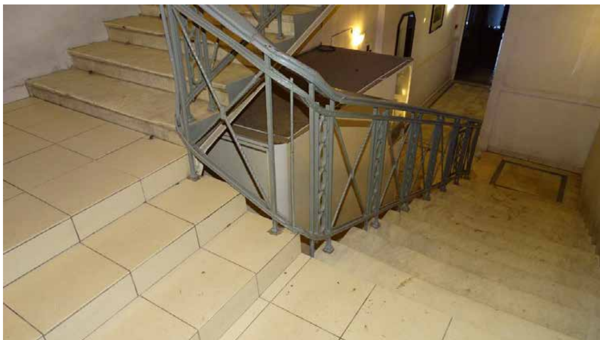
Илл. 05. 1-й этаж. Центральная лестница. Вид на вестибюль 1-го этажа. Съемка 02.04.2021 г. Трушковский В. Э.
