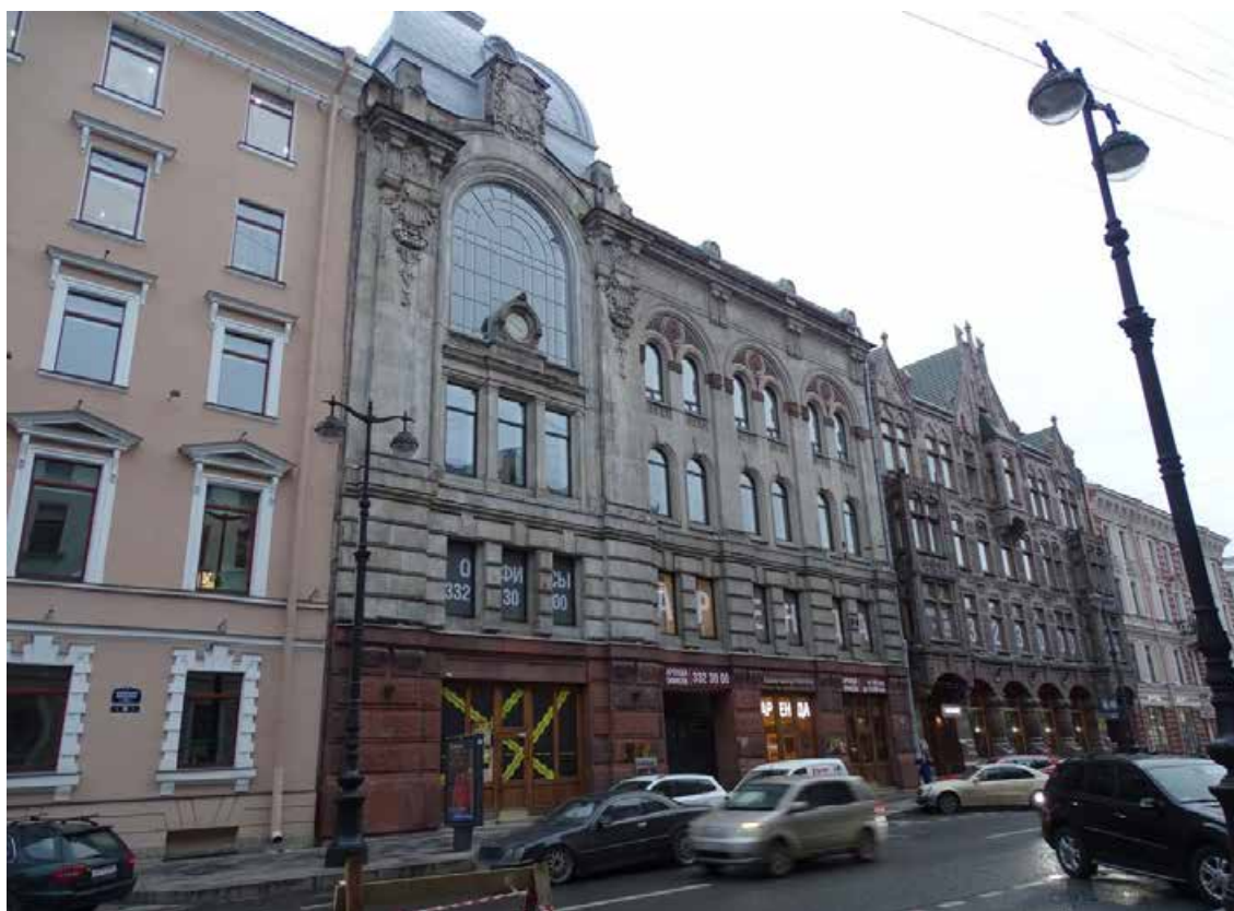
Илл. 01. Здание по адресу: по адресу: г. Санкт-Петербург, Большая Морская улица, дом 22, литера А. Лицевой корпус. Вид с Большой Морской ул. Съемка 02.04.2021 г. Трушковский В. Э.
