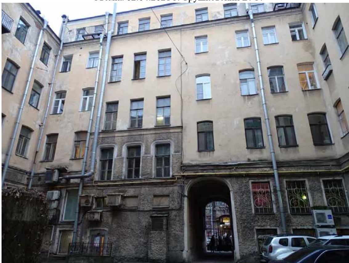
Илл. 02. Здание по адресу: по адресу: г. Санкт-Петербург, Большая Морская улица, дом 21, литера А. Лицевой корпус. Вид со стороны двора. Съемка 02.04.2021 г. Трушковский В. Э.
