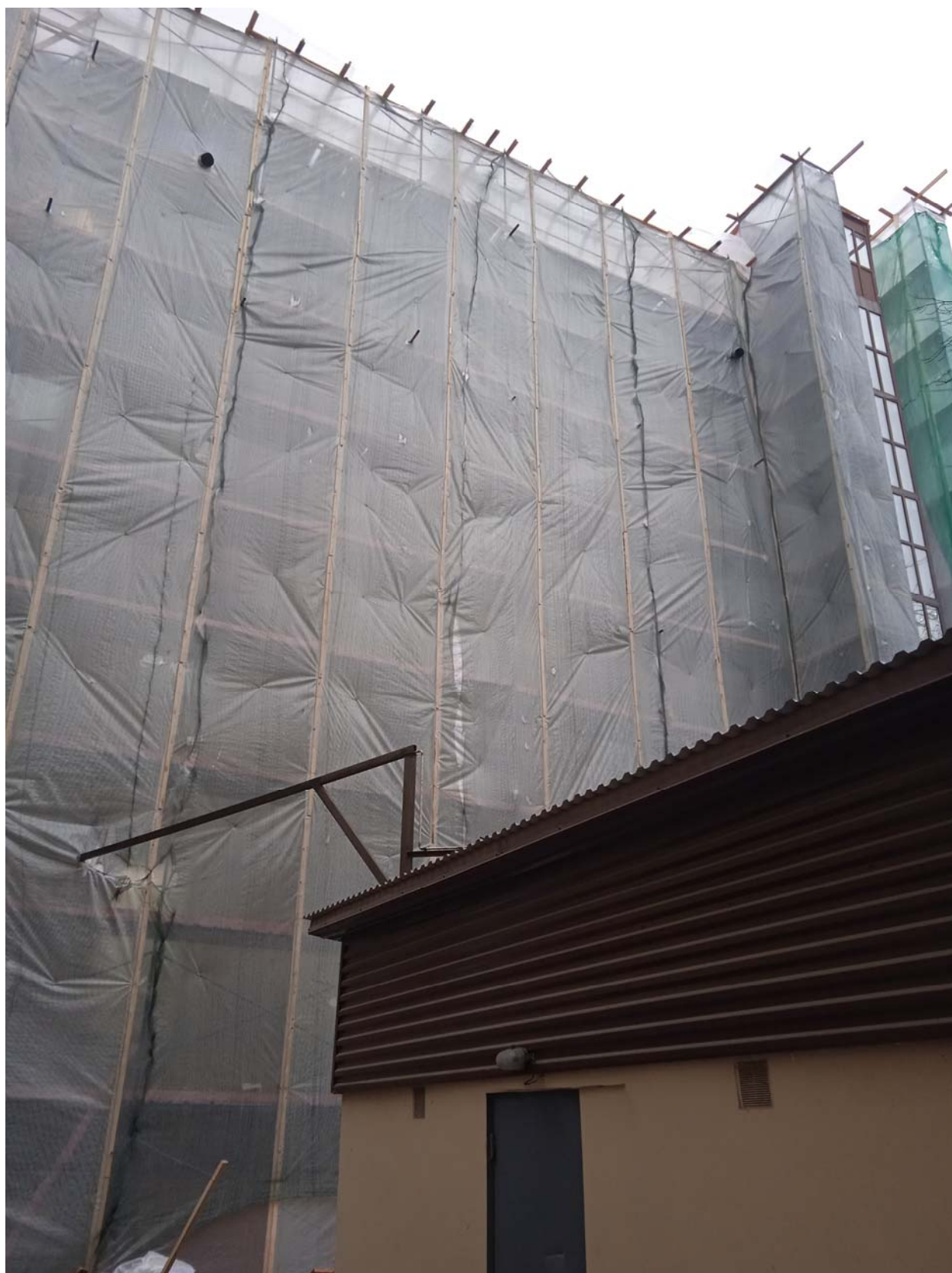
4. Юго-западный фасад здания. Общий вид.
