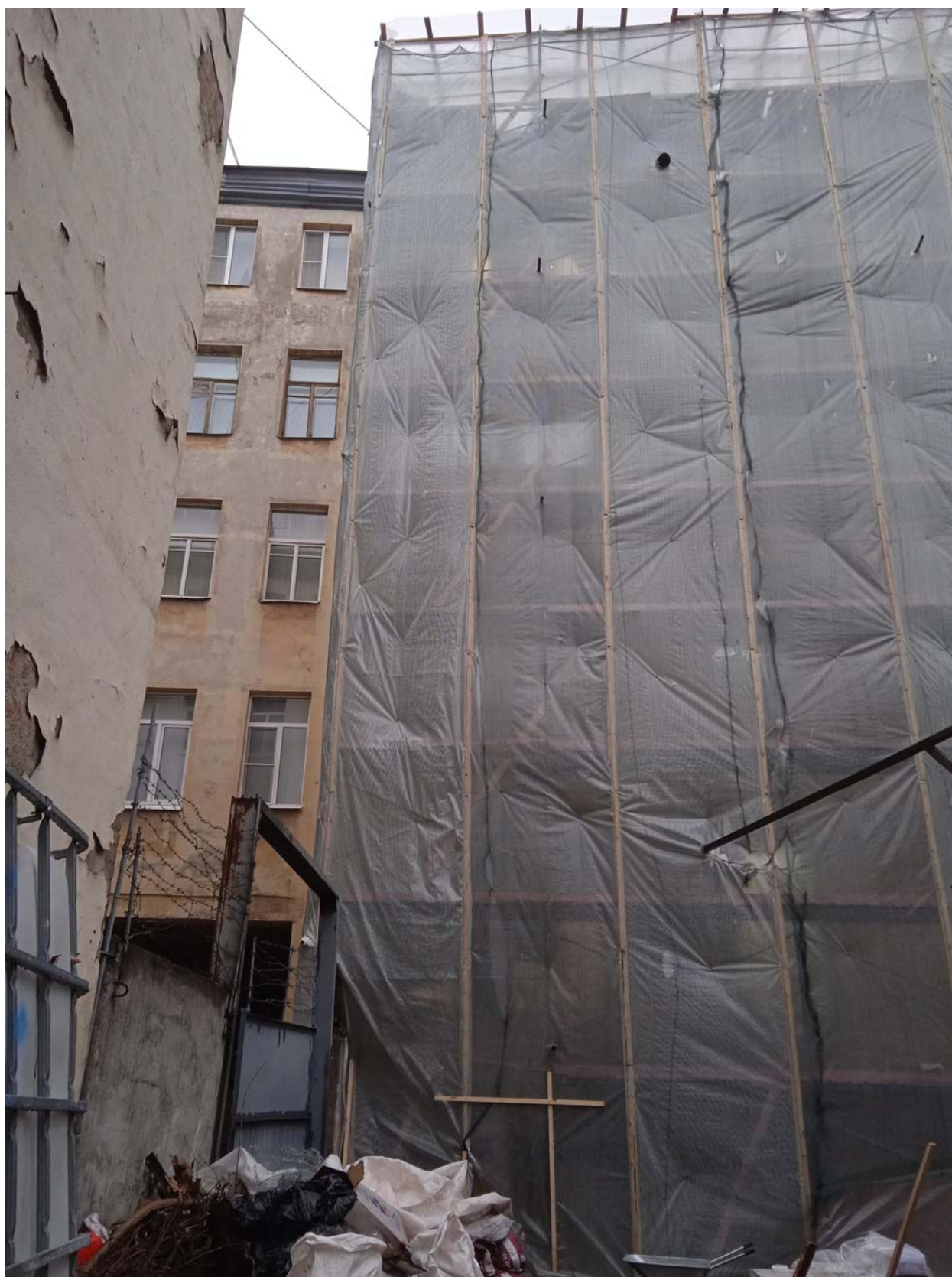
3. Юго-западный фасад здания между осями 25/В-Д.
