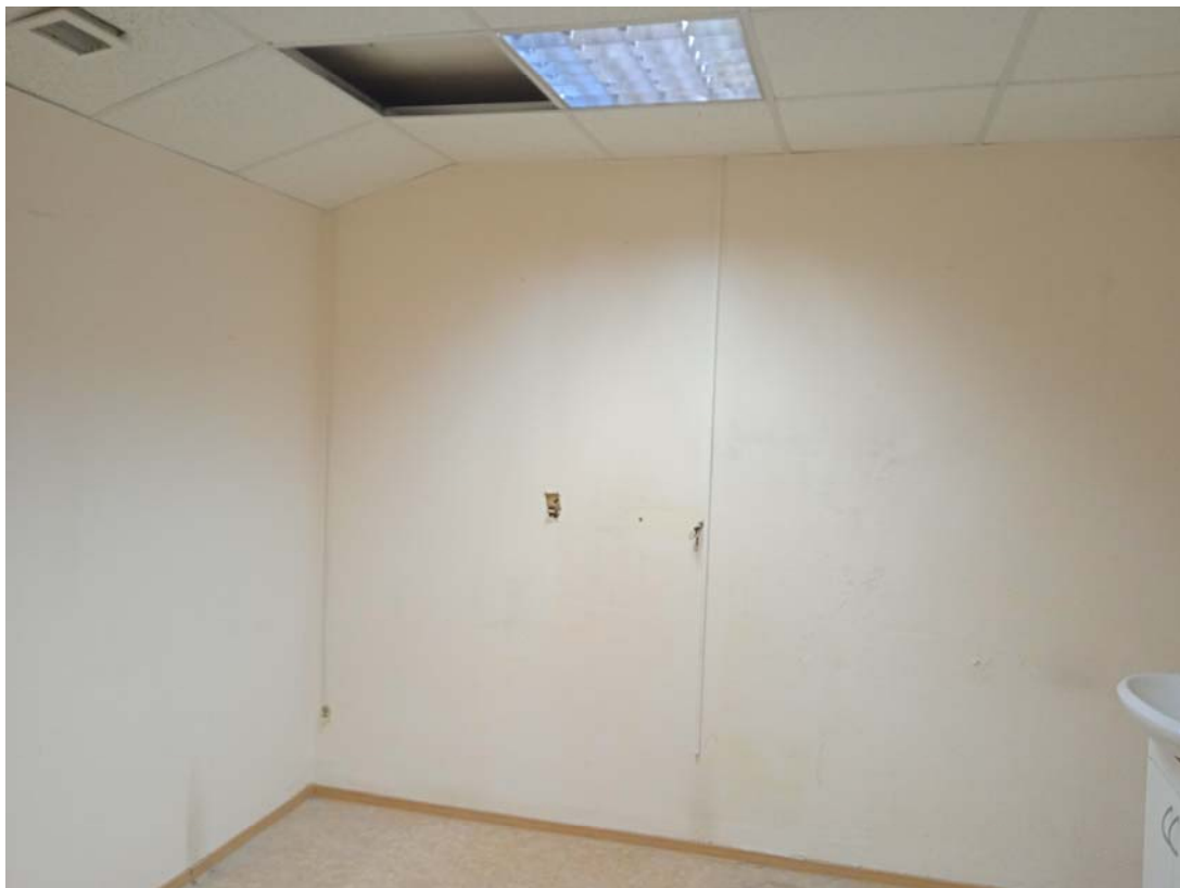
10. Помещение № 21 цокольного этажа.
