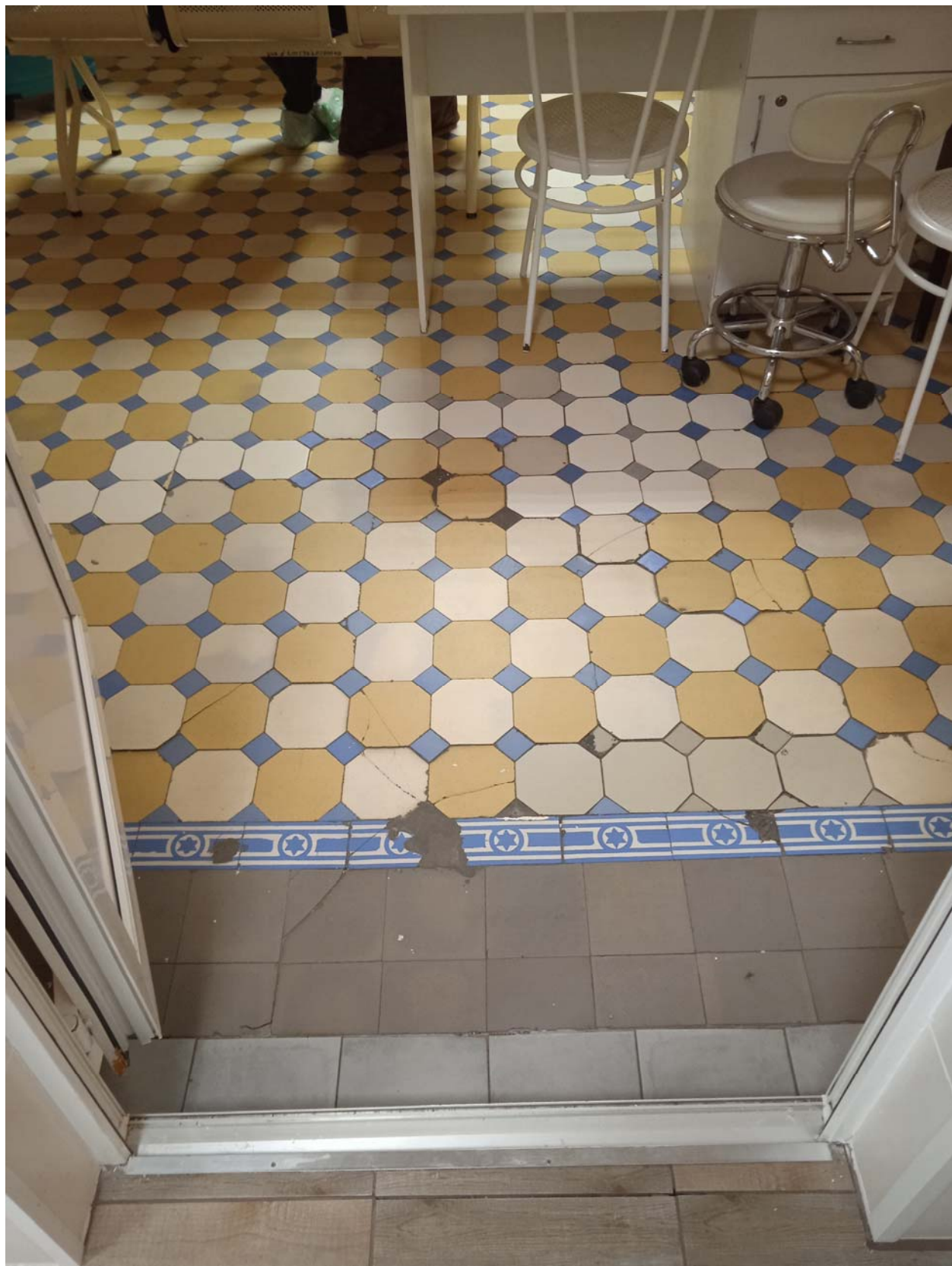
19. Облицовка пола метлахской плиткой в помещении № 17 первого этажа.
