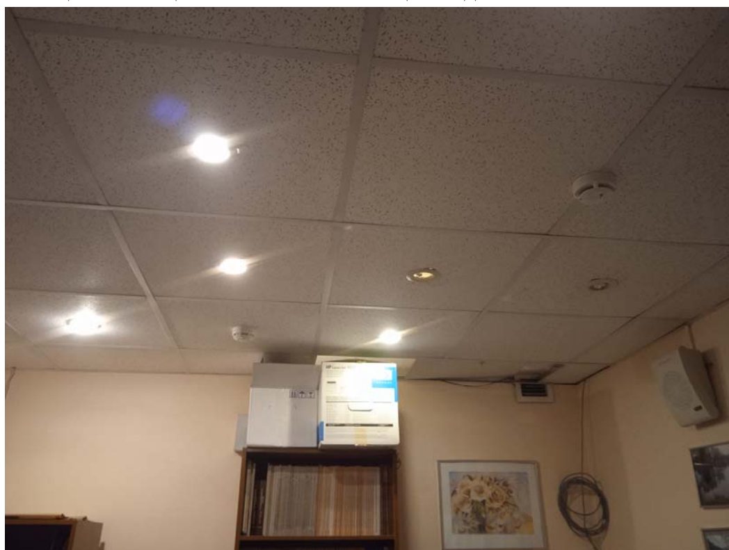
9. Помещение № 2 цокольного этажа. Отделка потолка панелями «Армстронг».
