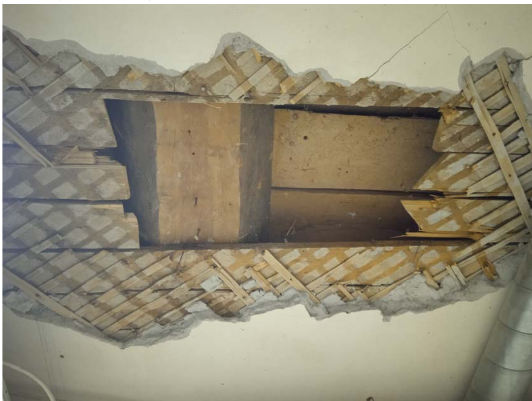
11. Помещение № 21 цокольного этажа. Вскрытие конструкций перекрытия цокольного этажа.
