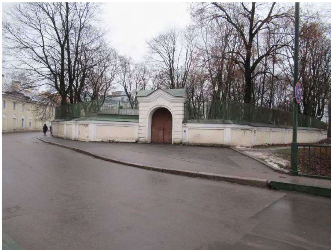
4. Объект культурного наследия регионального значения «Лаврский 2-ой мост» по адресу: г. Санкт-Петербург, через реку Монастырку по Лаврскому проезду. Вид на ограду Тихвинского кладбища с низовой части моста. (Дата съемки 01.12.2020)
