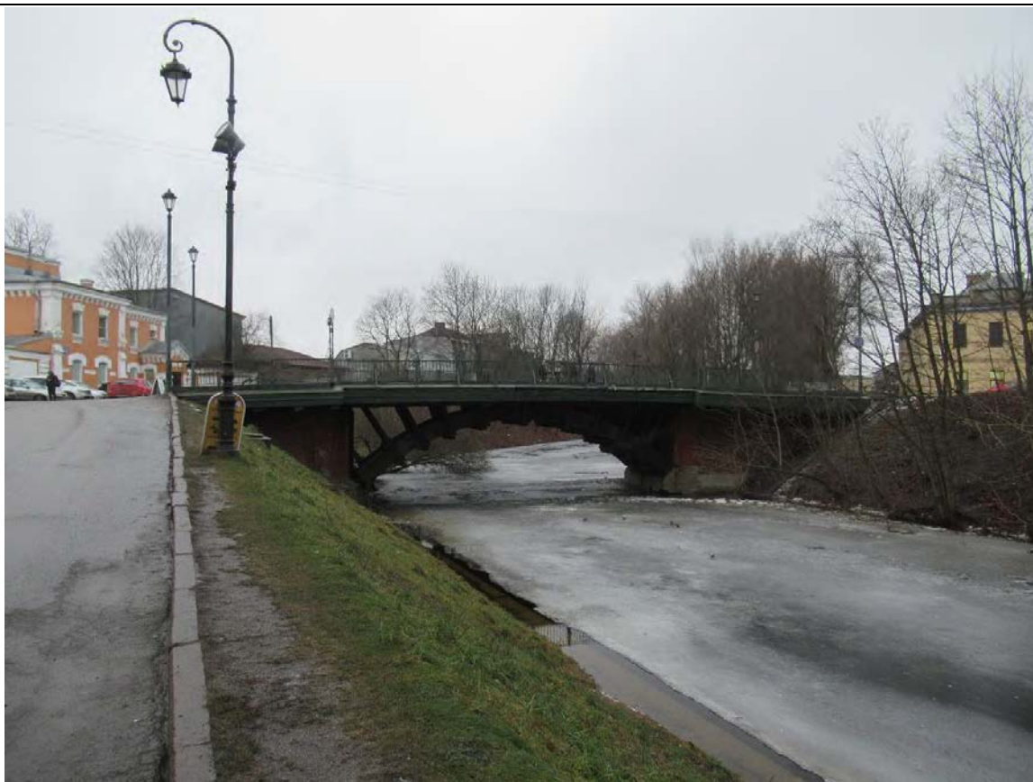
36. Объект культурного наследия регионального значения «Лаврский 2-ой мост» по адресу: г. Санкт-Петербург, через реку Монастырку по Лаврскому проезду. Вид на верховую часть моста от Северо-Западной башни (ризницы). (Дата съемки 01.12.2020)
