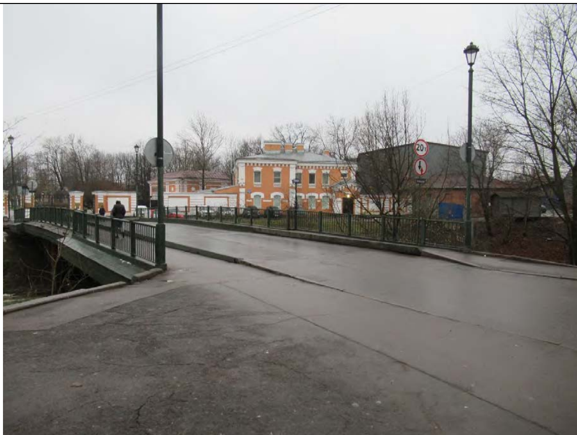
1. Объект культурного наследия регионального значения «Лаврский 2-ой мост» по адресу: г. Санкт-Петербург, через реку Монастырку по Лаврскому проезду. Вид на мост от ограды Тихвинского кладбища. (Дата съемки 01.12.2020)
