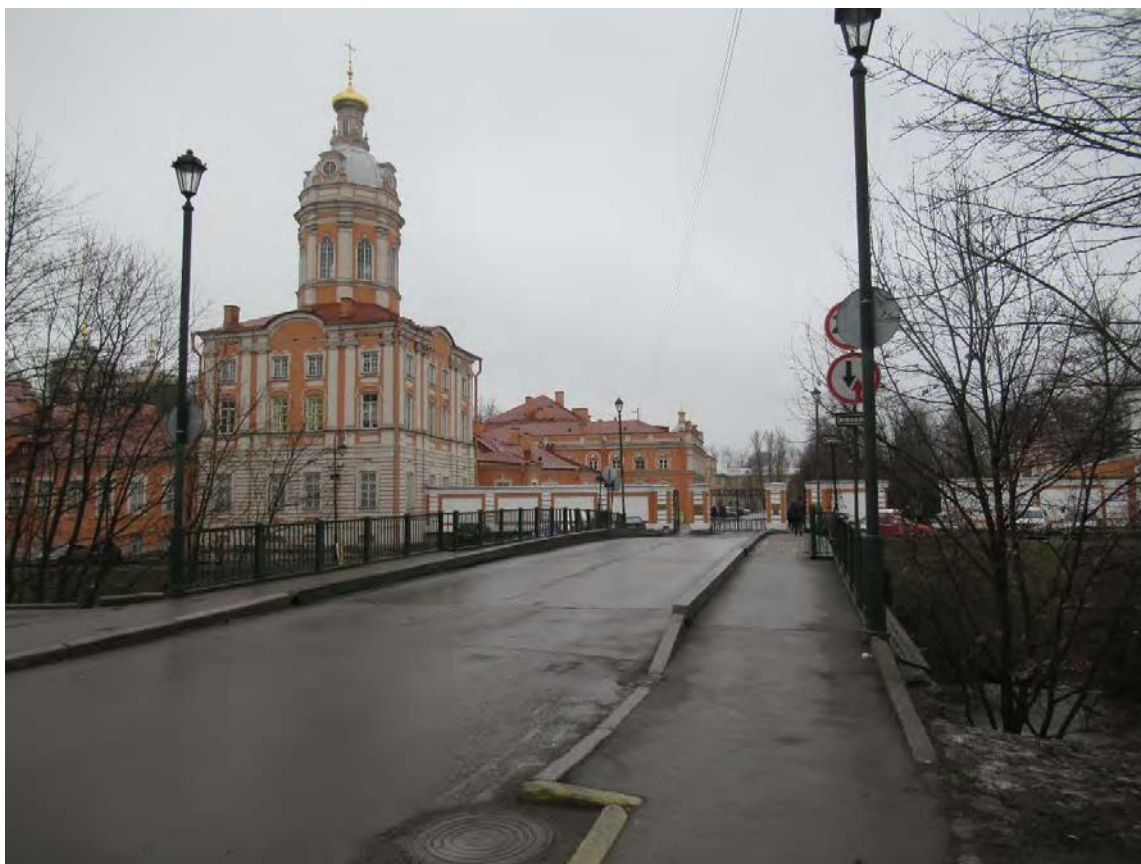
5. Объект культурного наследия регионального значения «Лаврский 2-ой мост» по адресу: г. Санкт-Петербург, через реку Монастырку по Лаврскому проезду. Вид на верхнюю часть моста и Северо-западную башню (ризницу) Александро-Невской Лавры (Дата съемки 01.12.2020)
