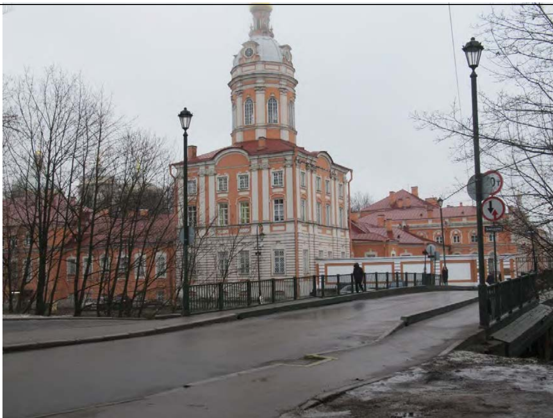
25. Объект культурного наследия регионального значения «Лаврский 2-ой мост» по адресу: г. Санкт-Петербург, через реку Монастырку по Лаврскому проезду. Вид на верховую часть моста от Монастырской больницы в Конюшенном дворе Александро-Невской лавры. (Дата съемки 01.12.2020)
