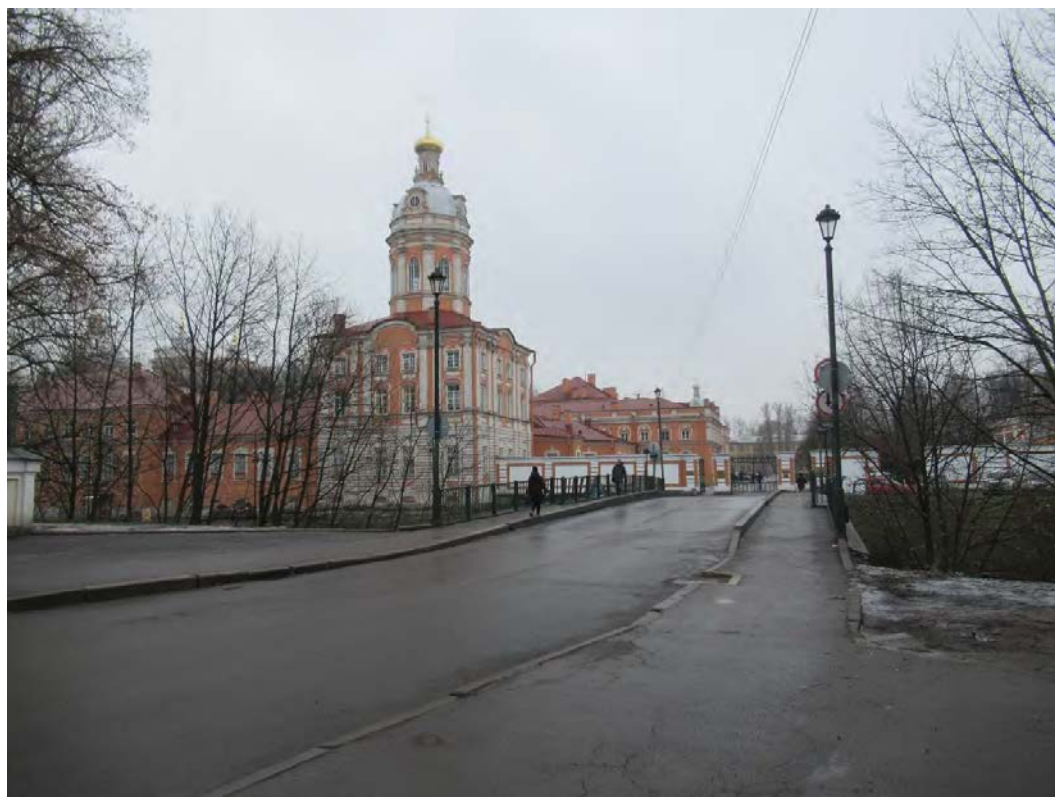
24. Объект культурного наследия регионального значения «Лаврский 2-ой мост» по адресу: г. Санкт-Петербург, через реку Монастырку по Лаврскому проезду. Вид на мост от Монастырской больницы в Конюшенном дворе Александро-Невской лавры. (Дата съемки 01.12.2020)
