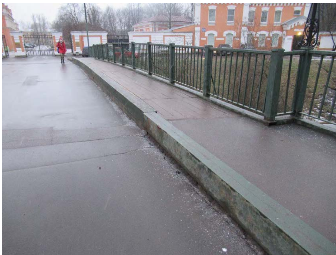
34. Объект культурного наследия регионального значения «Лаврский 2-ой мост» по адресу: г. Санкт-Петербург, через реку Монастырку по Лаврскому проезду. Вид на перильную ограду, тротуар и колесоотбойное ограждение низовой части моста. (Дата съемки 01.12.2020)
