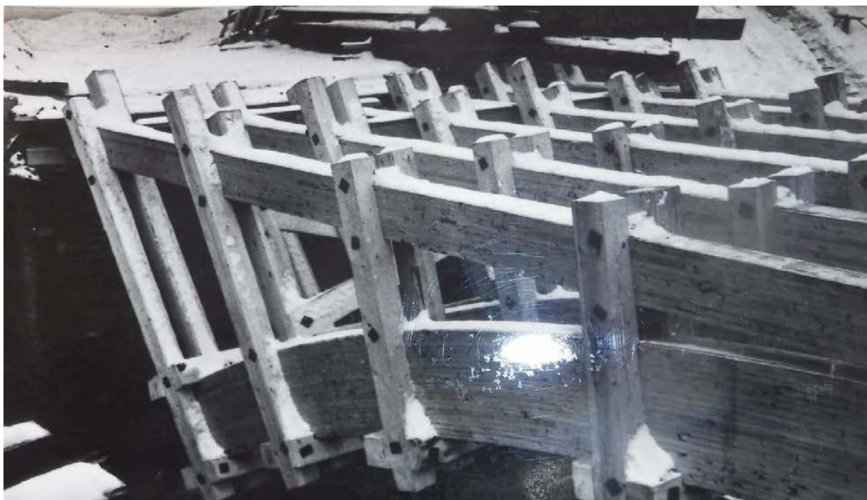
Ил. 25. Лаврский 2-й мост. Реконструкция. 1981.
