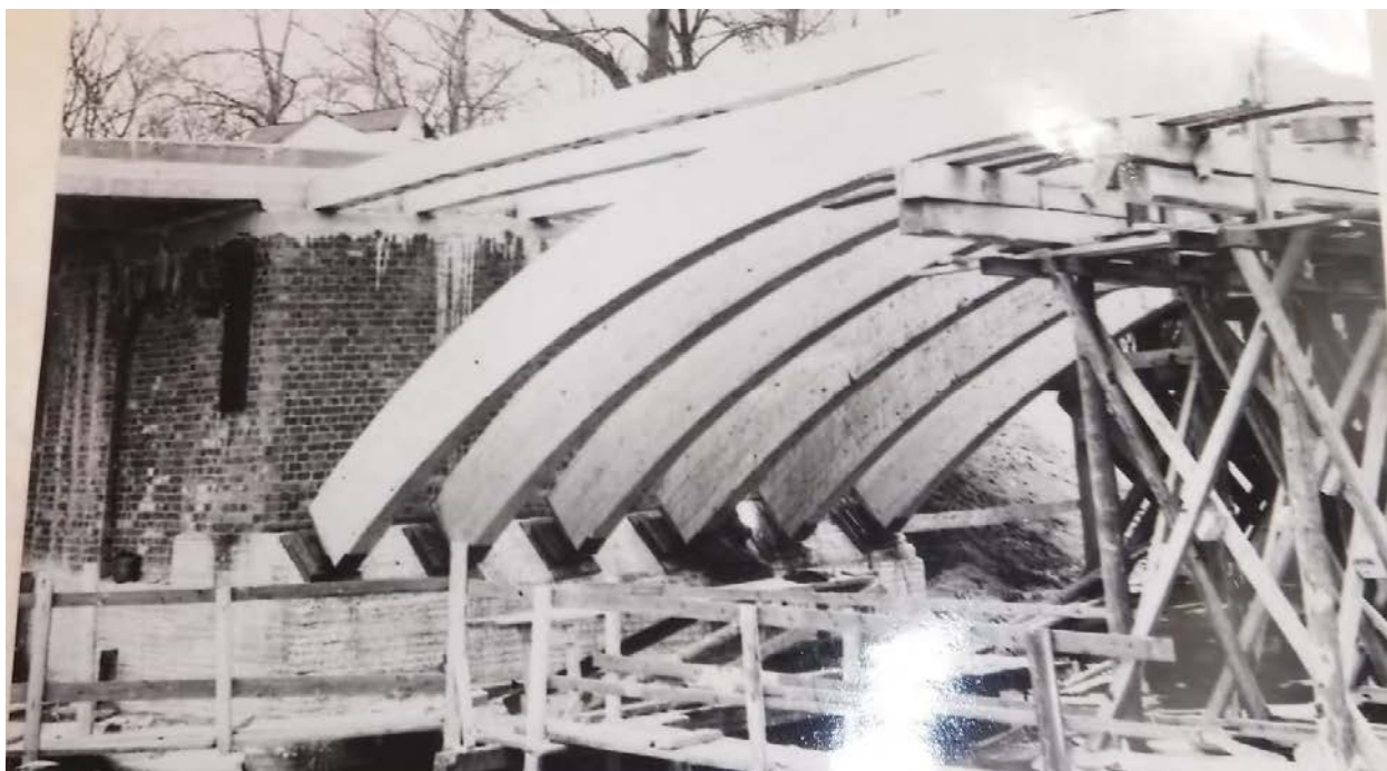
Ил. 23. Лаврский 2-й мост. Конструкции пролетных строений. 1981.
