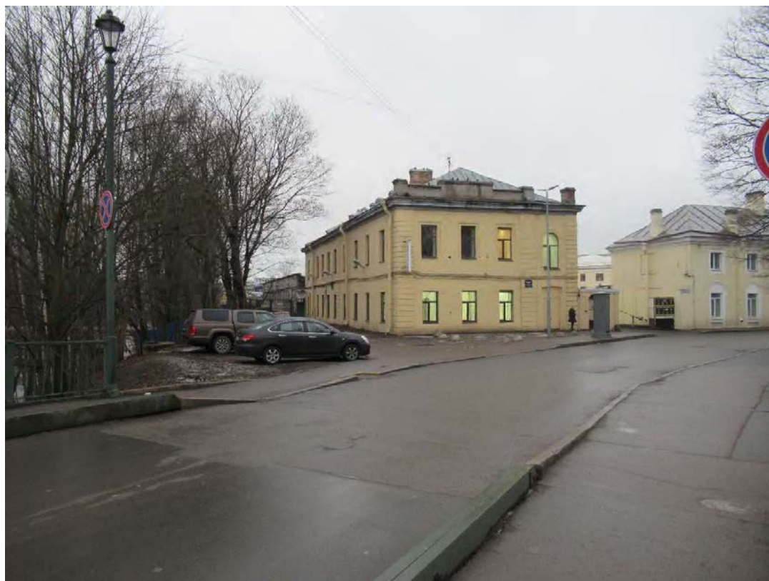
6. Объект культурного наследия регионального значения «Лаврский 2-ой мост» по адресу: г. Санкт-Петербург, через реку Монастырку по Лаврскому проезду. Вид на Монастырскую больницу в Конюшенном дворе Александро-Невской лавры (Дата съемки 01.12.2020)
