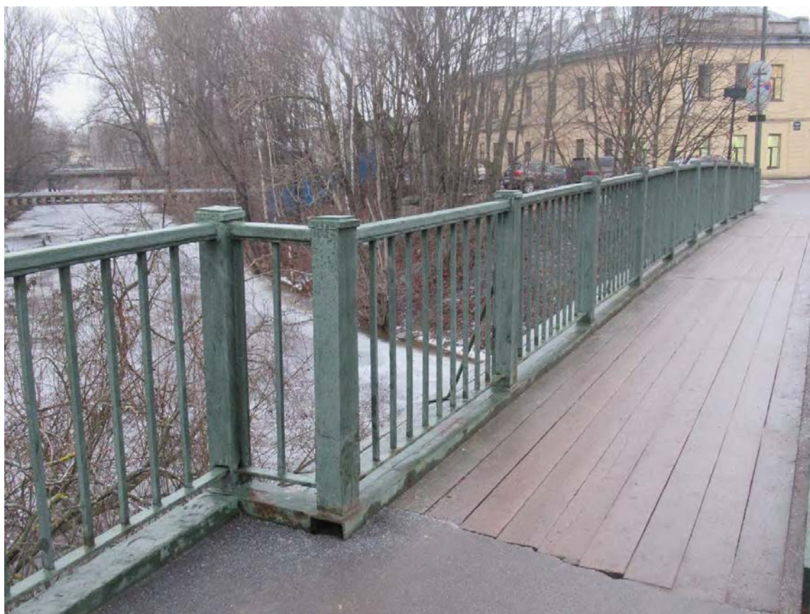
28. Объект культурного наследия регионального значения «Лаврский 2-ой мост» по адресу: г. Санкт-Петербург, через реку Монастырку по Лаврскому проезду. Вид на перильную ограду низовой части моста. (Дата съемки 01.12.2020)
