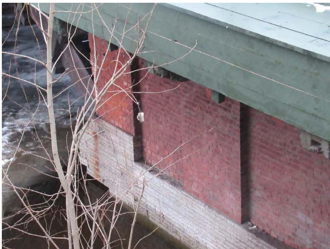
20. Объект культурного наследия регионального значения «Лаврский 2-ой мост» по адресу: г. Санкт-Петербург, через реку Монастырку по Лаврскому проезду. Вид на кирпичную опору (устой) с известняковыми блоками. (Дата съемки 01.12.2020)
