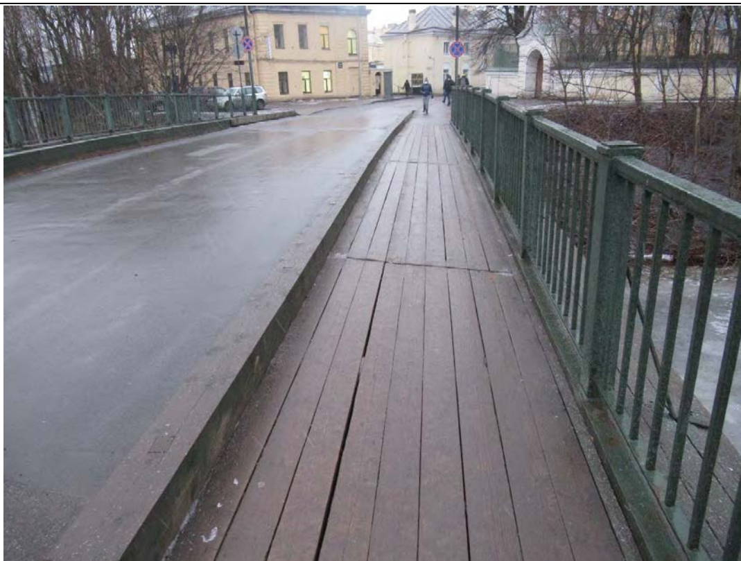
38. Объект культурного наследия регионального значения «Лаврский 2-ой мост» по адресу: г. Санкт-Петербург, через реку Монастырку по Лаврскому проезду. Вид на мостового покрытия (дошатога настила) верховой части моста. (Дата съемки 01.12.2020)
