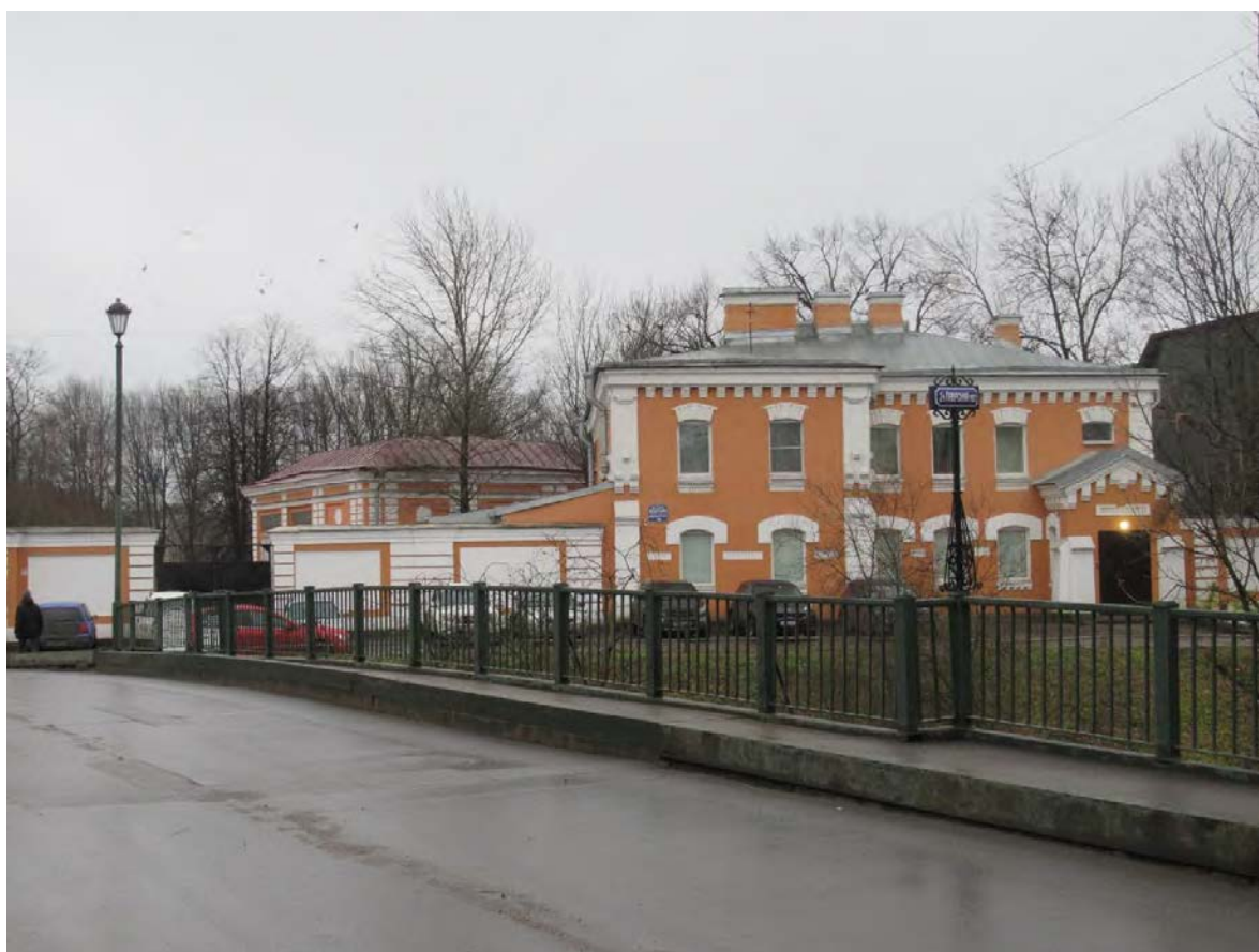
2. Объект культурного наследия регионального значения «Лаврский 2-ой мост» по адресу: г. Санкт-Петербург, через реку Монастырку по Лаврскому проезду. Вид на низовую часть моста и Епархиальную просфорную. (Дата съемки 01.12.2020)
