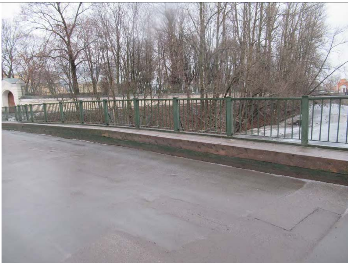
31. Объект культурного наследия регионального значения «Лаврский 2-ой мост» по адресу: г. Санкт-Петербург, через реку Монастырку по Лаврскому проезду. Вид на колесоотбойное ограждение – деревянный брус - верховой части моста. (Дата съемки 01.12.2020)
