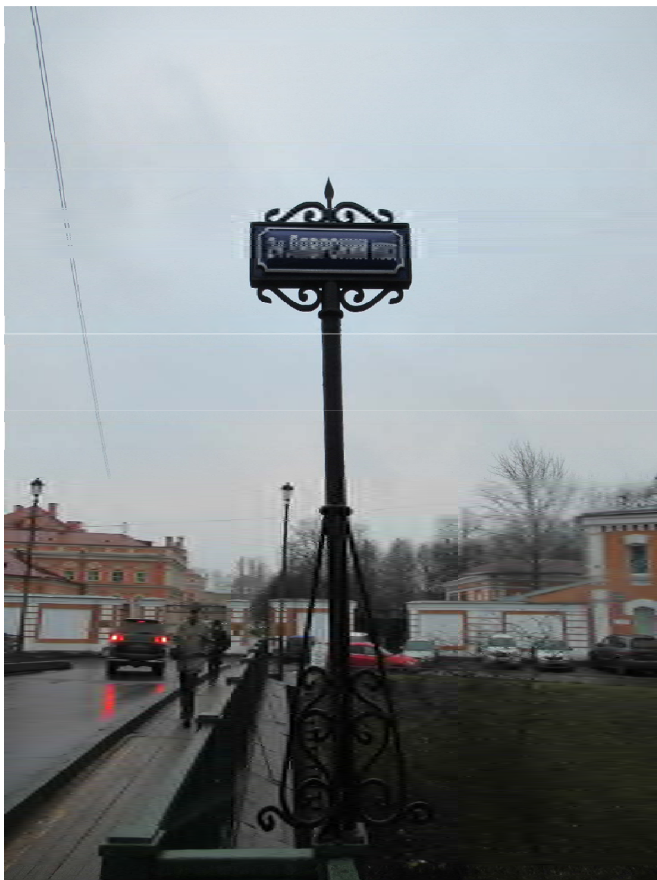
35. Объект культурного наследия регионального значения «Лаврский 2-ой мост» по адресу: г. Санкт-Петербург, через реку Монастырку по Лаврскому проезду. Вид на металлическую кованную стойку с эмалевой табличкой с названием на низовой части моста. (Дата съемки 01.12.2020)
