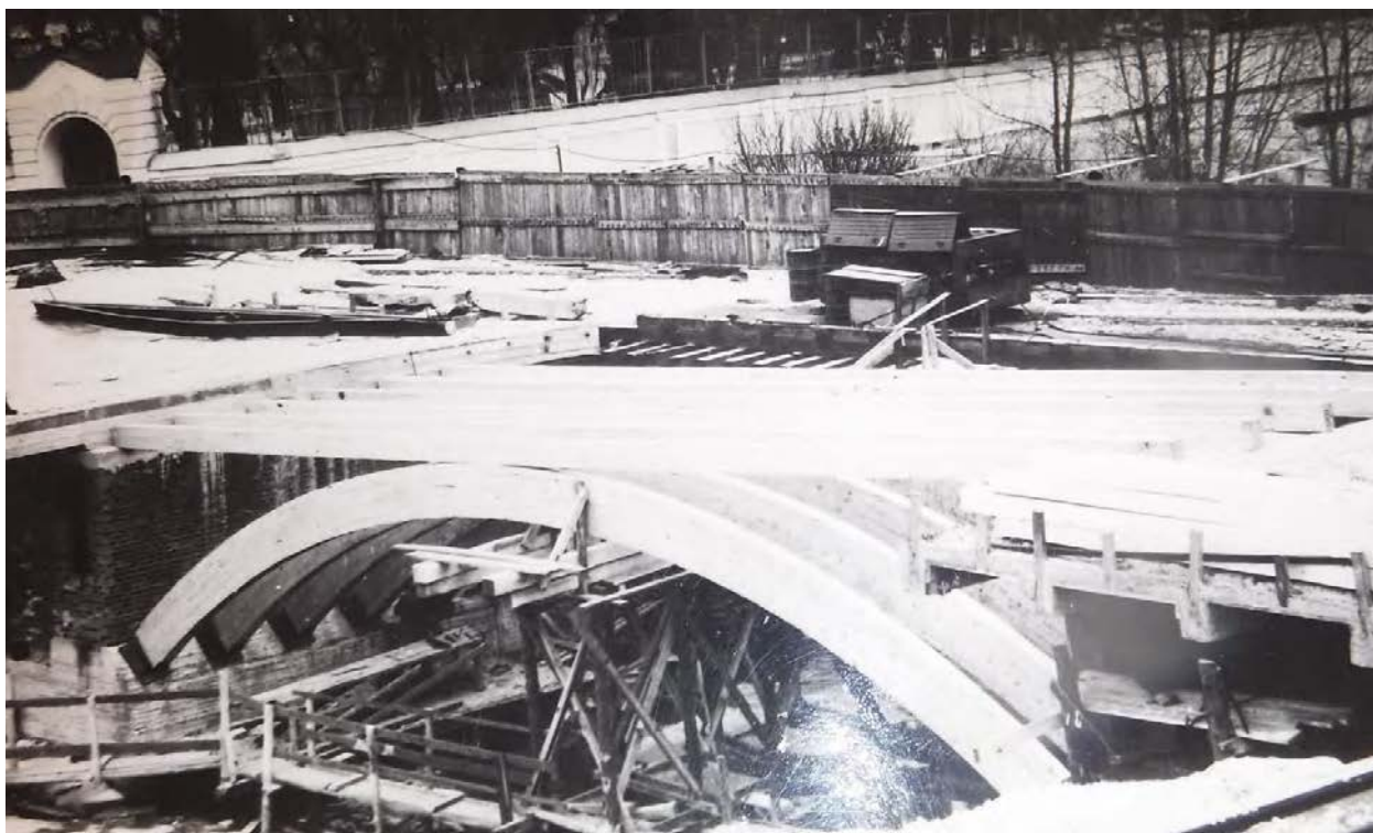
Ил. 24. Лаврский 2-й мост. Реконструкция. 1981.
