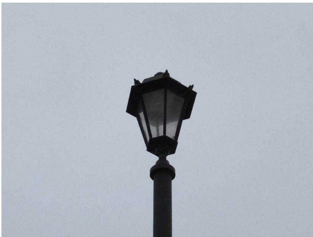
39. Объект культурного наследия регионального значения «Лаврский 2-ой мост» по адресу: г. Санкт-Петербург, через реку Монастырку по Лаврскому проезду. Вид на шестигранный плафон фонаря матового стекла в металлическом обрамлении. (Дата съемки 01.12.2020)
