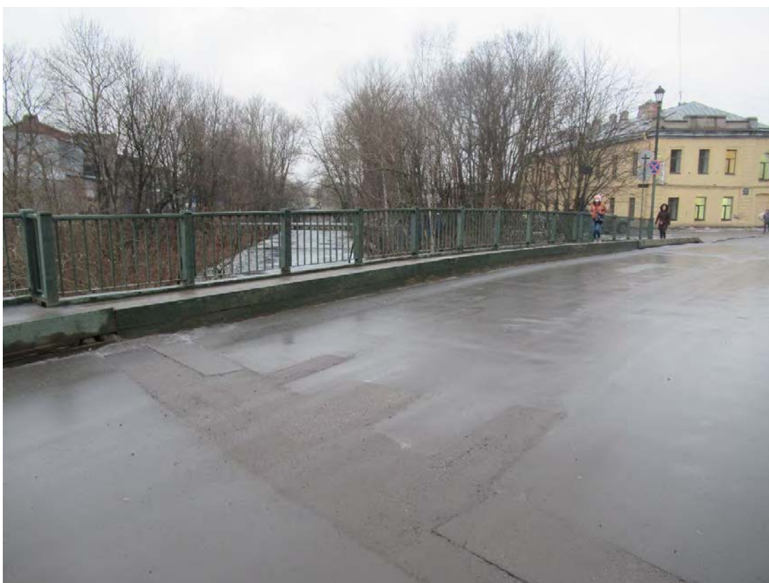
30. Объект культурного наследия регионального значения «Лаврский 2-ой мост» по адресу: г. Санкт-Петербург, через реку Монастырку по Лаврскому проезду. Вид на колесоотбойное заграждение низовой части моста. (Дата съемки 01.12.2020)
