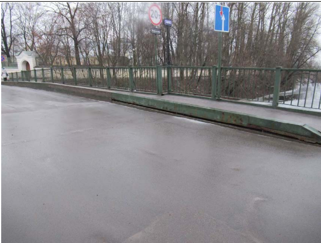
29. Объект культурного наследия регионального значения «Лаврский 2-ой мост» по адресу: г. Санкт-Петербург, через реку Монастырку по Лаврскому проезду. Вид на колесоотбойное заграждение верховой части моста. (Дата съемки 01.12.2020)
