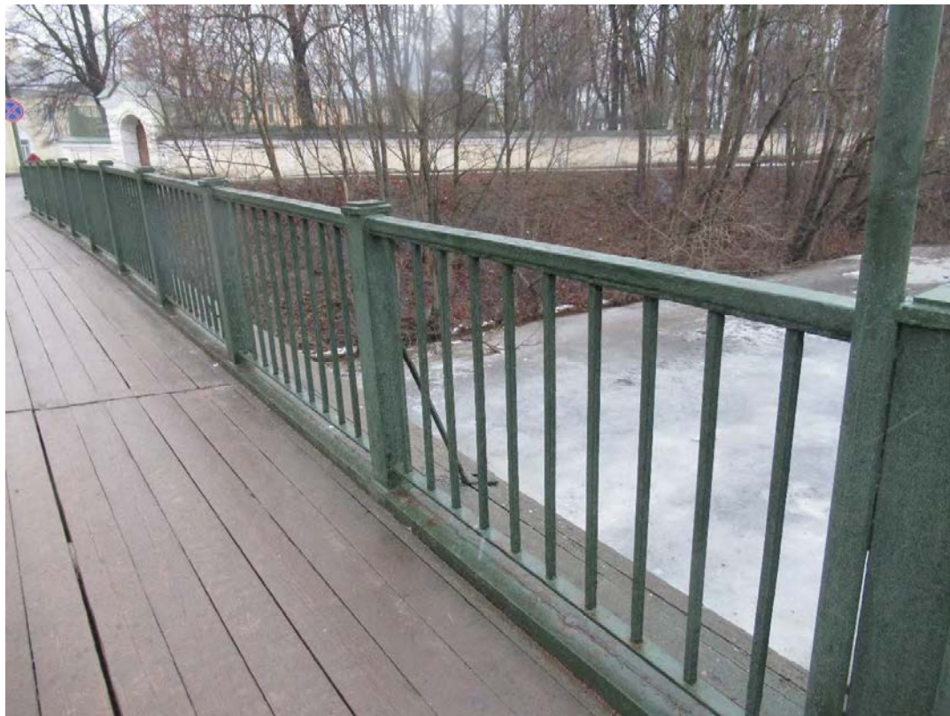
18. Объект культурного наследия регионального значения «Лаврский 2-ой мост» по адресу: г. Санкт-Петербург, через реку Монастырку по Лаврскому проезду. Вид на перильную ограду верховой части моста. (Дата съемки 01.12.2020)
