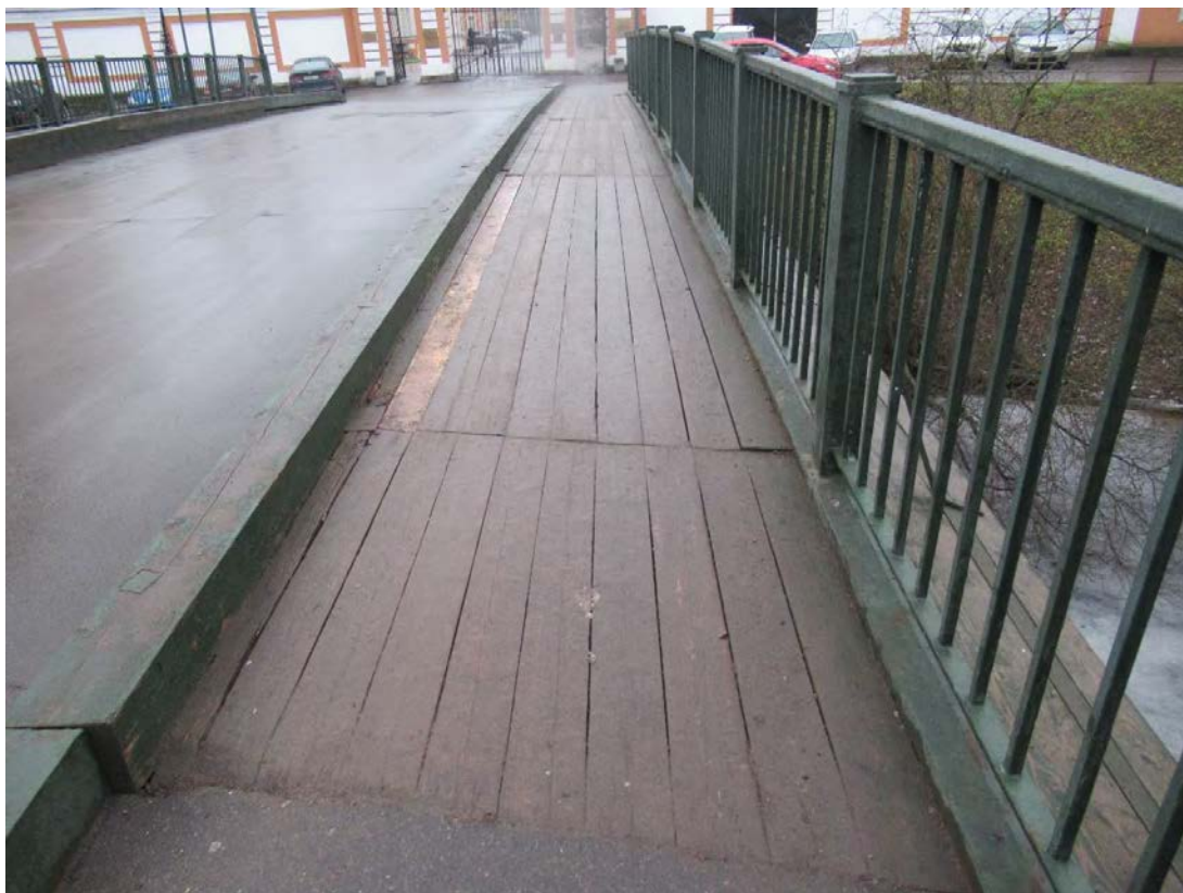
7. Объект культурного наследия регионального значения «Лаврский 2-ой мост» по адресу: г. Санкт-Петербург, через реку Монастырку по Лаврскому проезду. Вид на мостового покрытия (дощатого настила) низовой части моста. (Дата съемки 01.12.2020)
