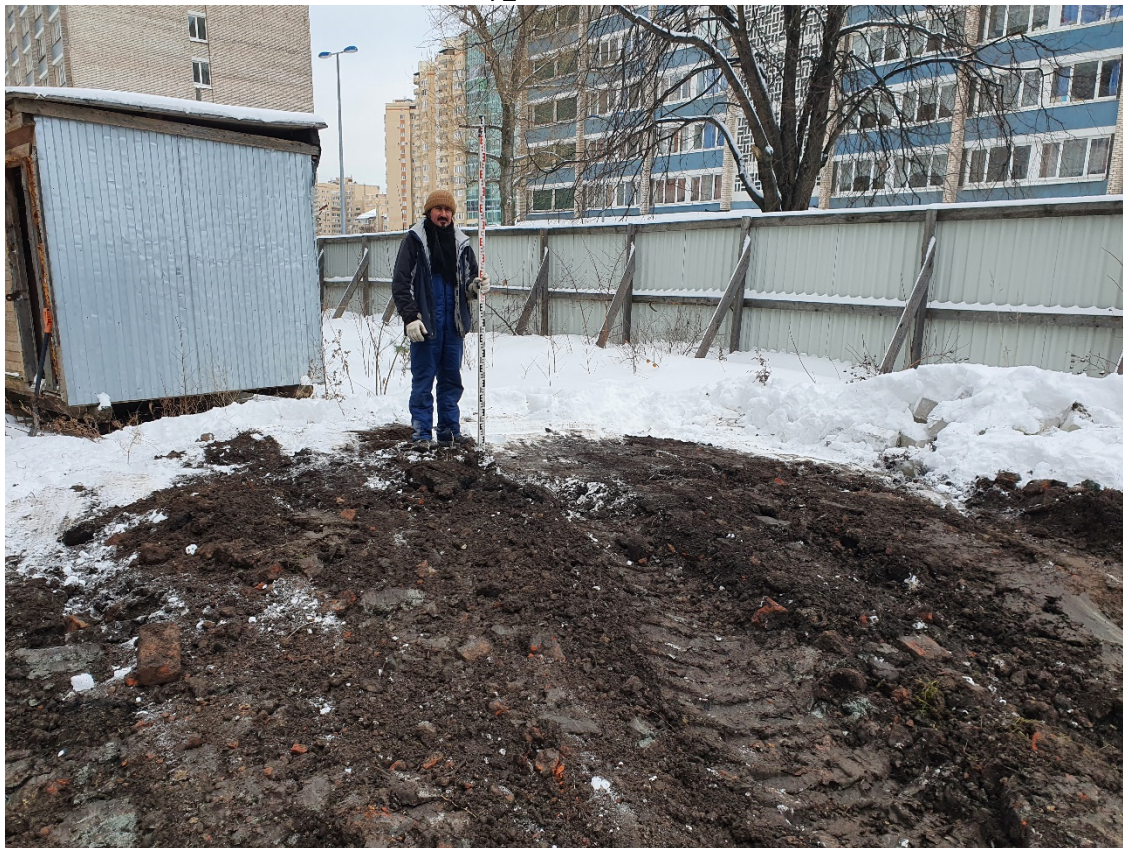
Рис. 24. СПб – 2021. Московский район, Бассейная ул., д. 8. Шурф 1. Общий вид участка обследования после окончания работ
