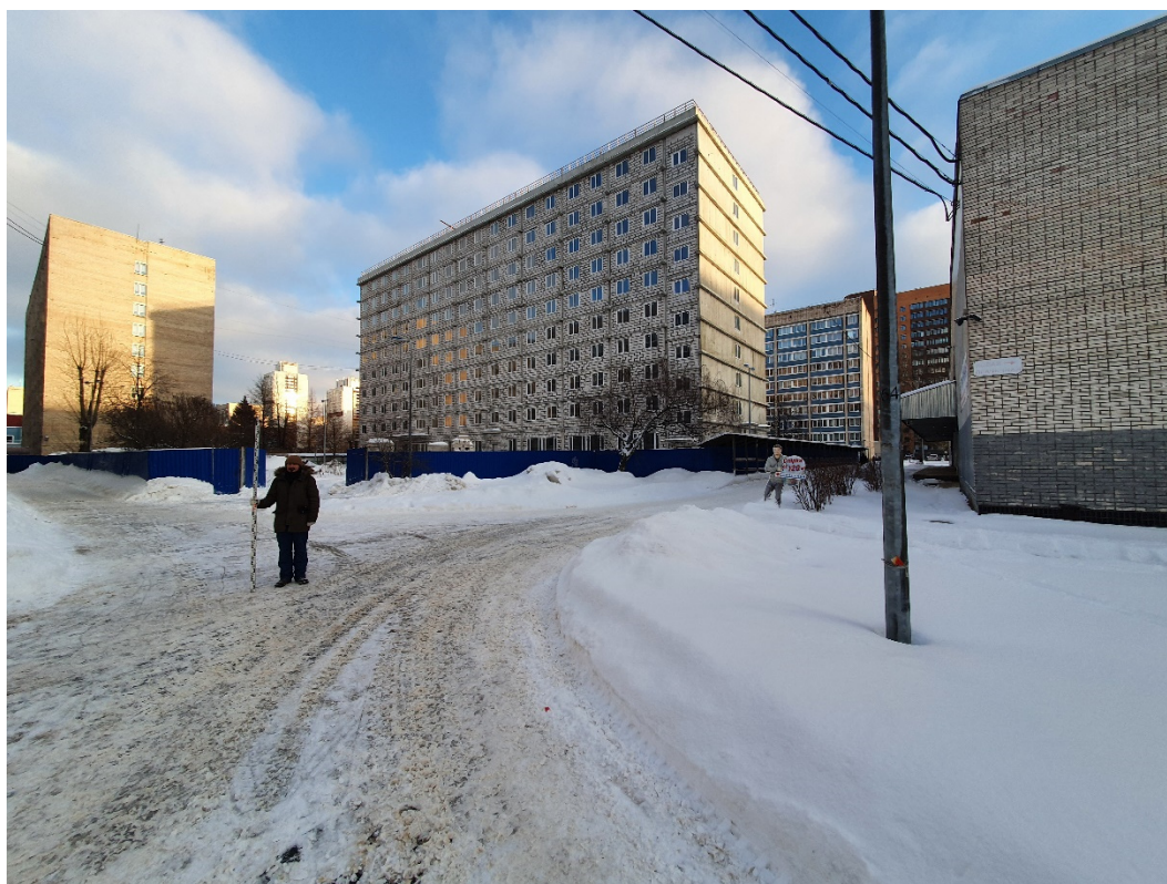
Рис. 16. СПб – 2021. Московский район, Бассейная ул., д. 8. Общий вид участка обследования. Точка фотофиксации 4. Вид с юга
