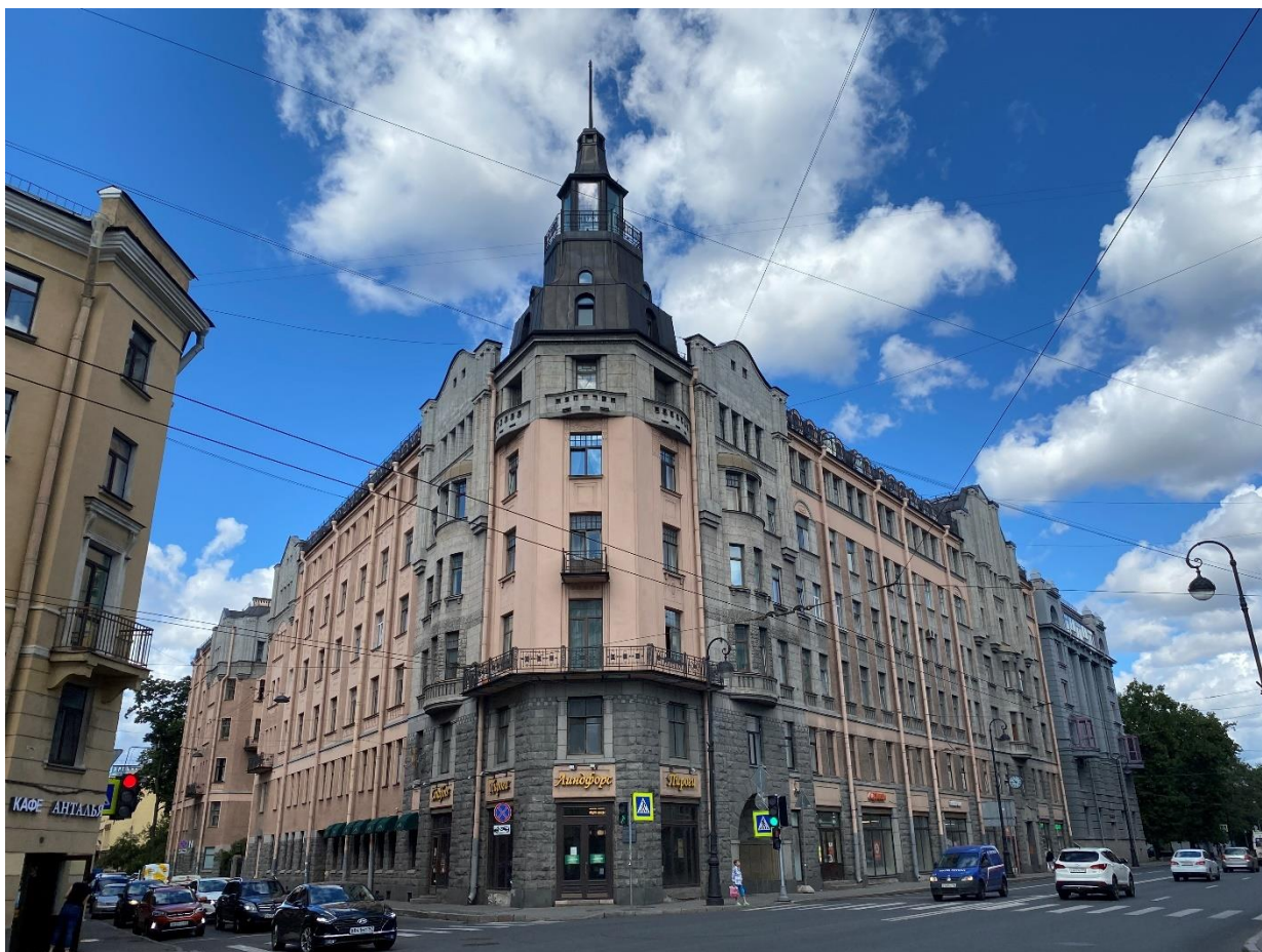
Фото 1. Вид на угловую часть объекта с юго-востока.
