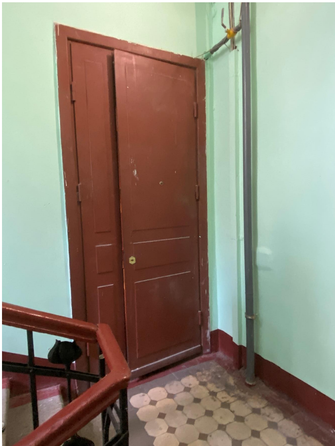
Фото 1. Вид на вход в квартиру № 6.
