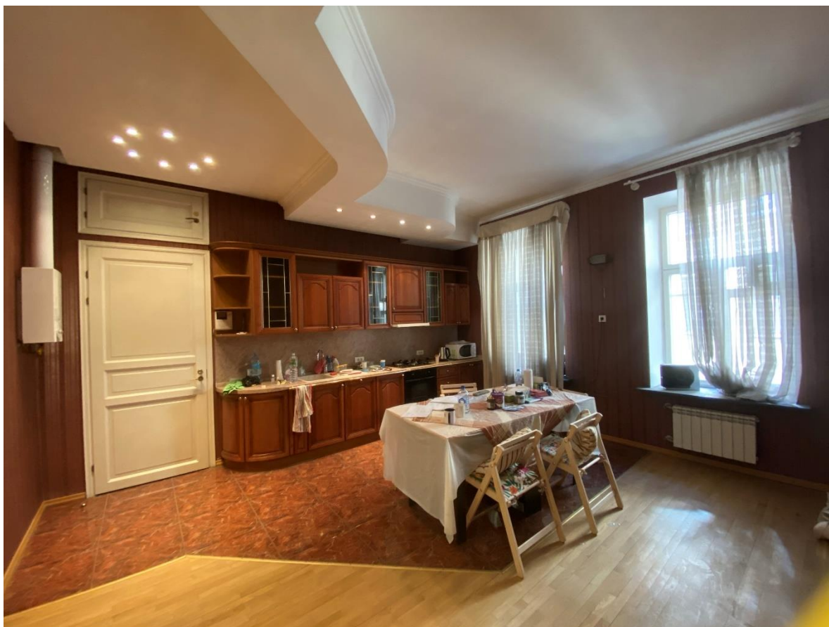
Фото 13. Вид на помещения 1 и 2 (перегородка демонтирована), направление – юго-запад.
