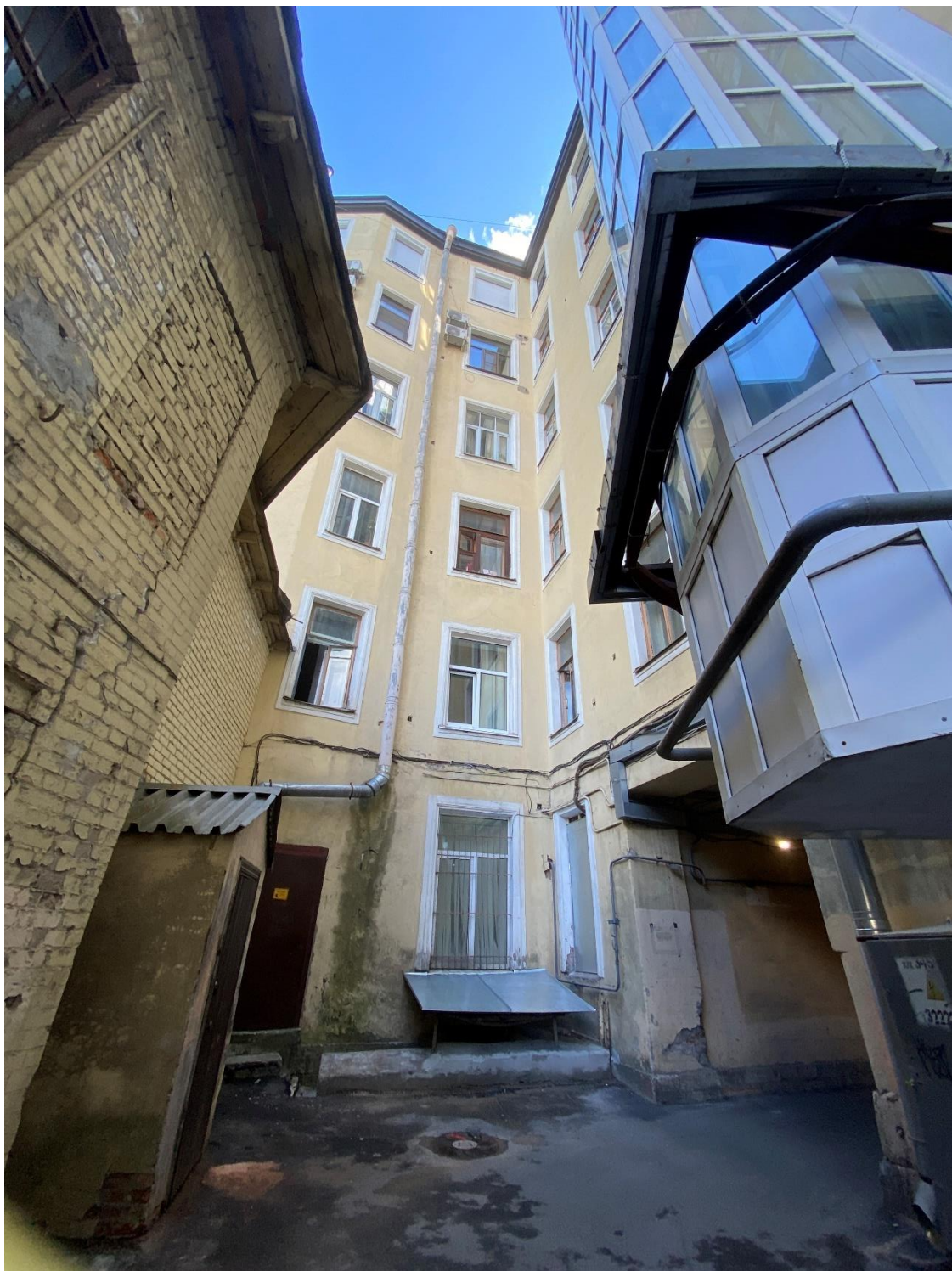
Фото 11. Вид на северный дворовый фасад.
