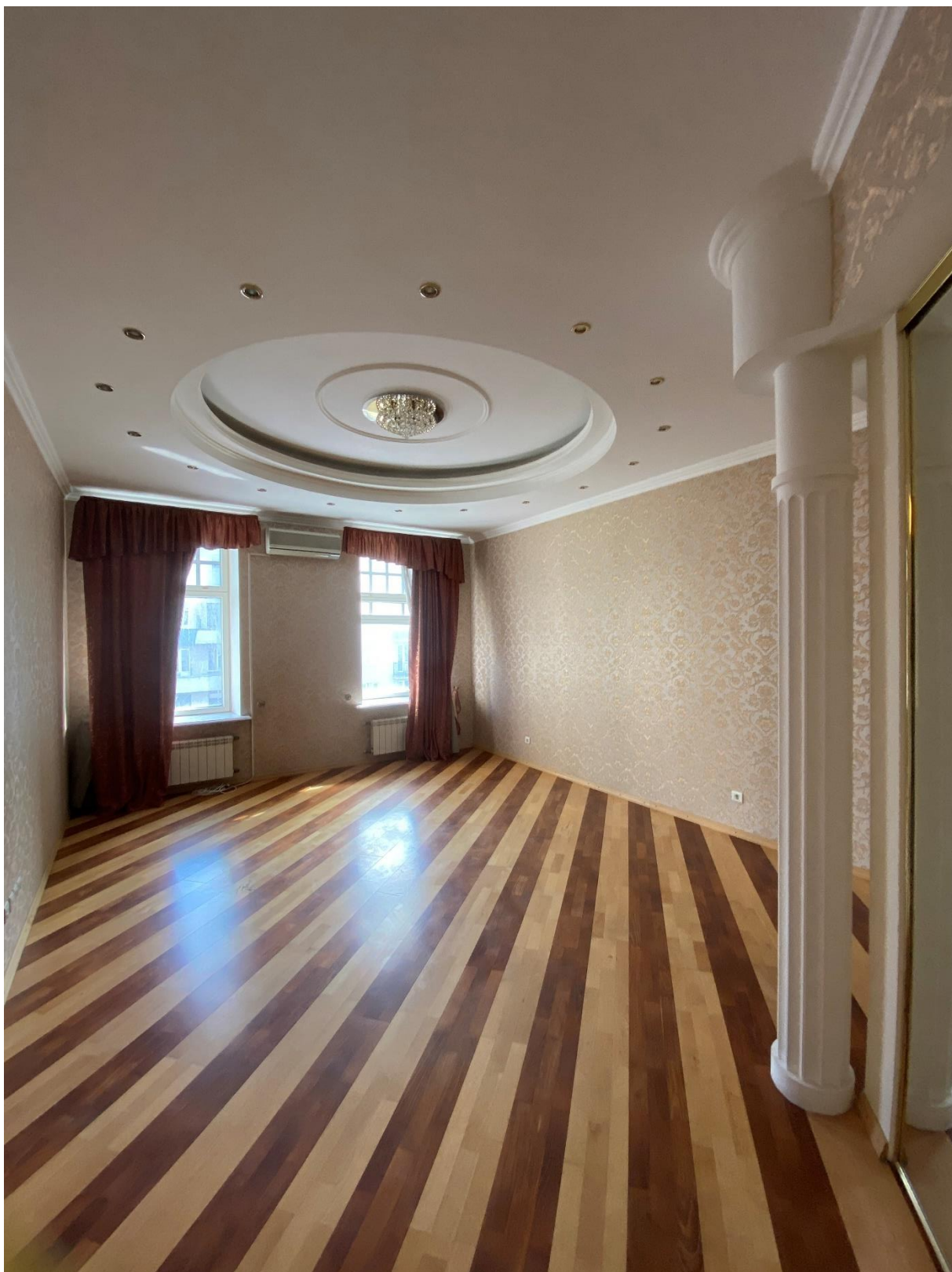
Фото 21. Помещение № 9, расположенное вдоль восточного (лицевого) фасада, вид на восток.
