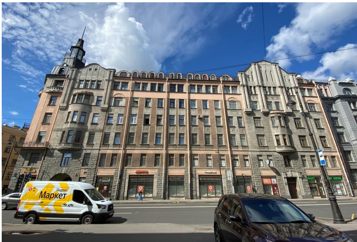
Фото 3. Вид на восточный (лицевой) фасад.
