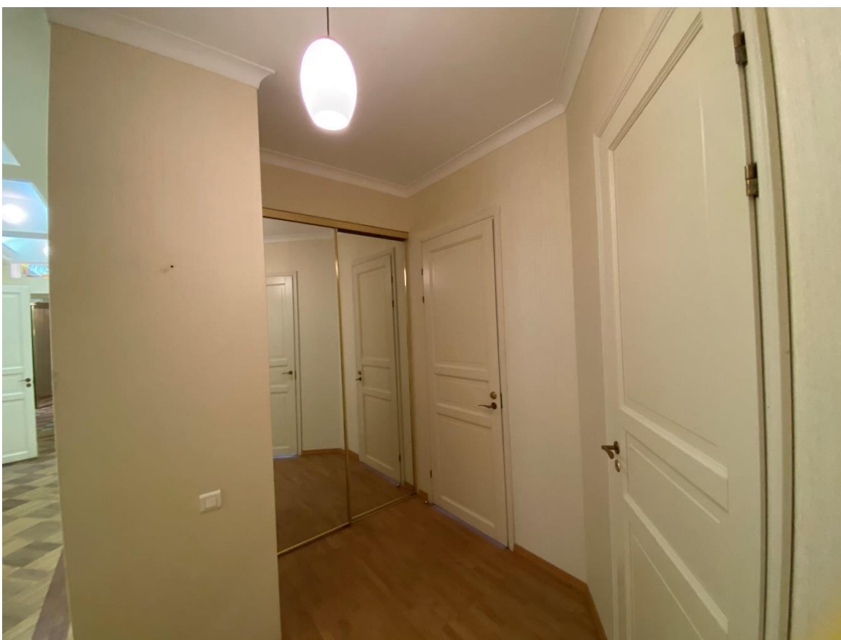
Фото 20. Перепланированный участок квартиры за счет площади помещений 8, 9, 12. Вид на север.
