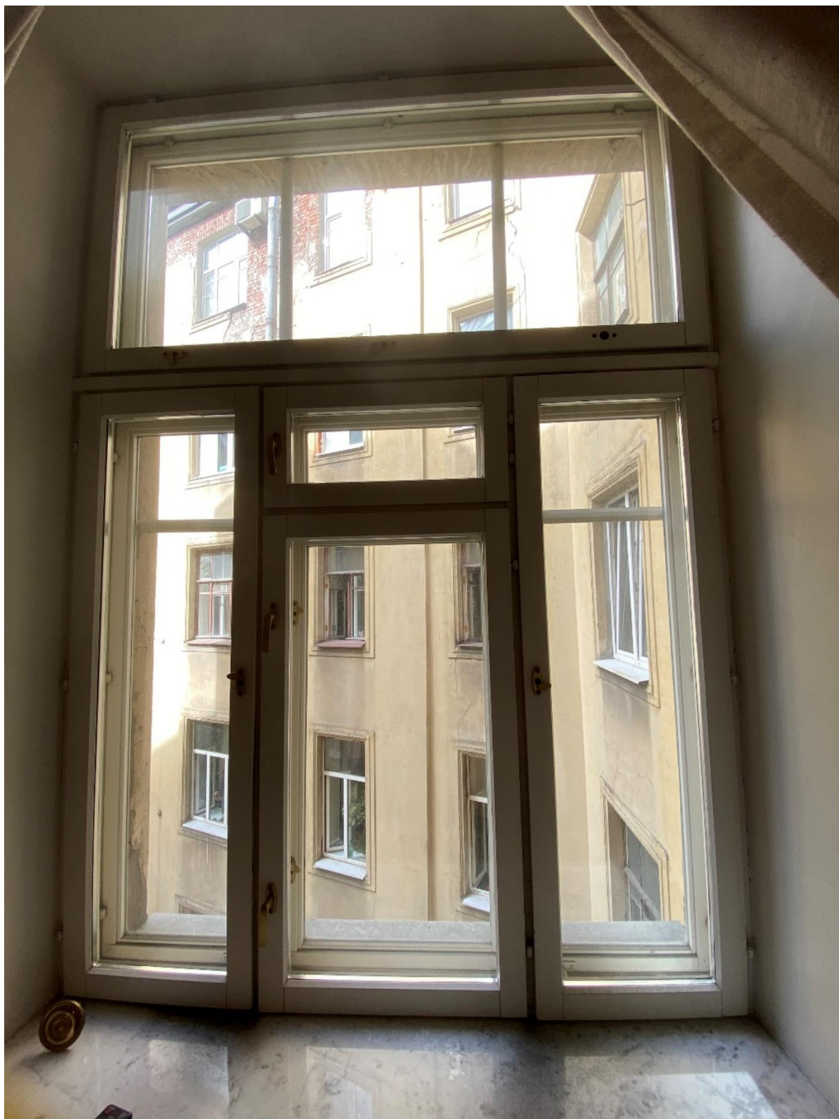
Фото 7. Вид на заполнение оконного проема в комнате у входа (пом. № 4).
