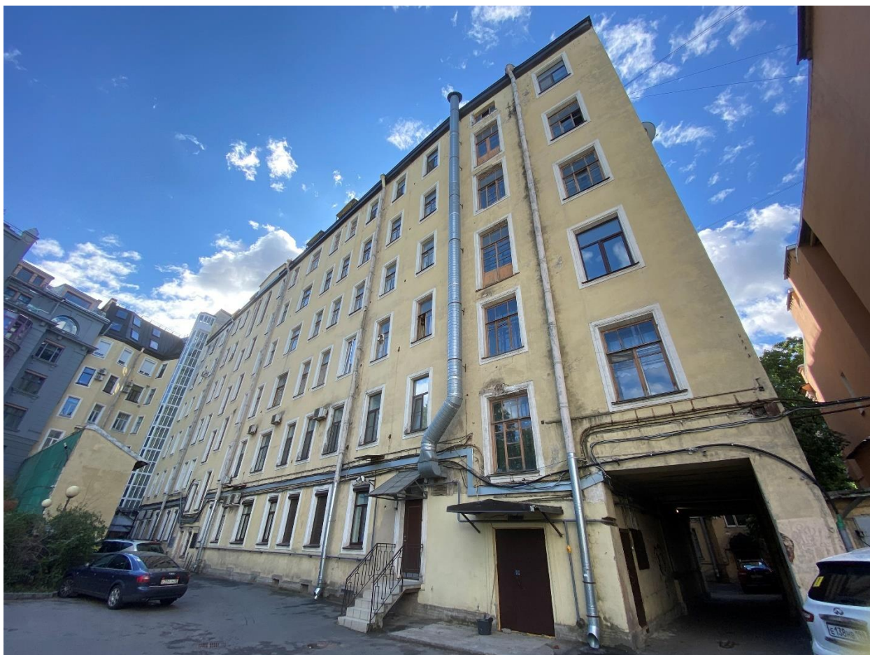
Фото 10. Вид на дворový фасад с севера.
