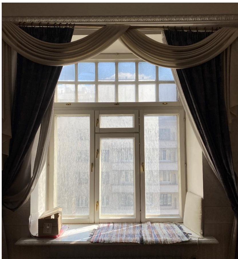
Фото 32. Вид на оконное заполнение в помещении № 6.
