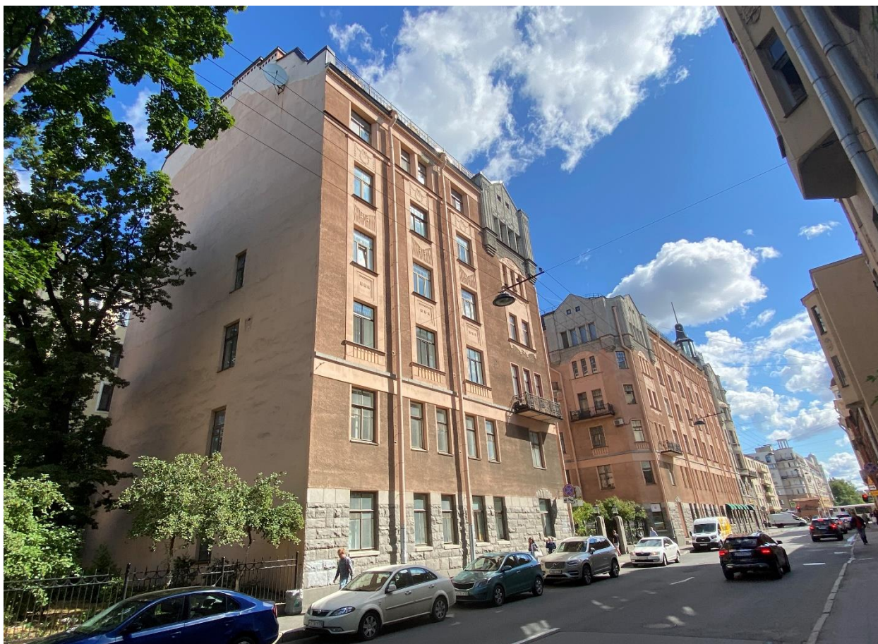
Фото 8. Вид на часть южного (лицевого) фасада и торцевой фасад.
