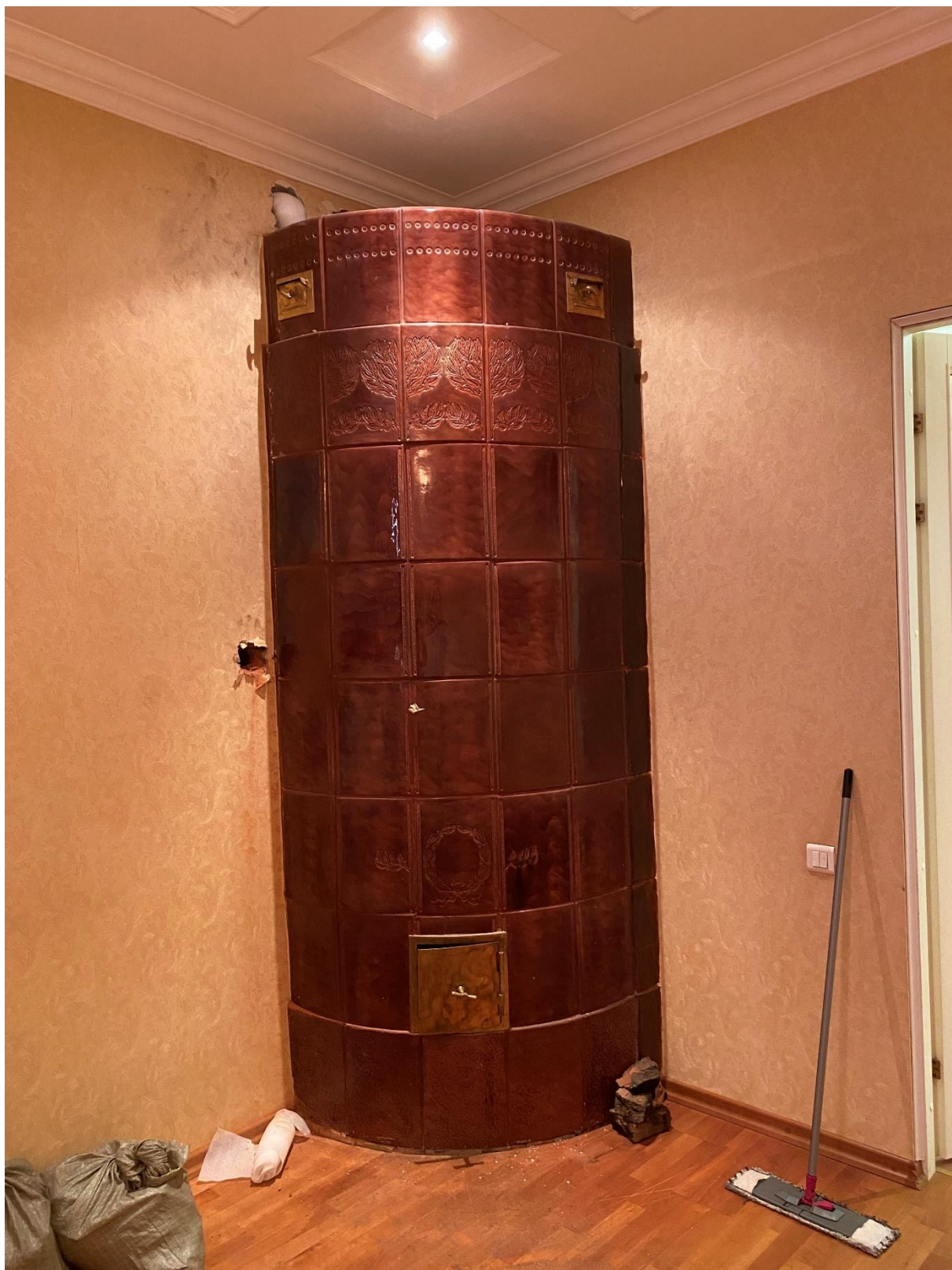
Фото 8. Вид на угловую печь в комнате у входа (пом. № 4).
