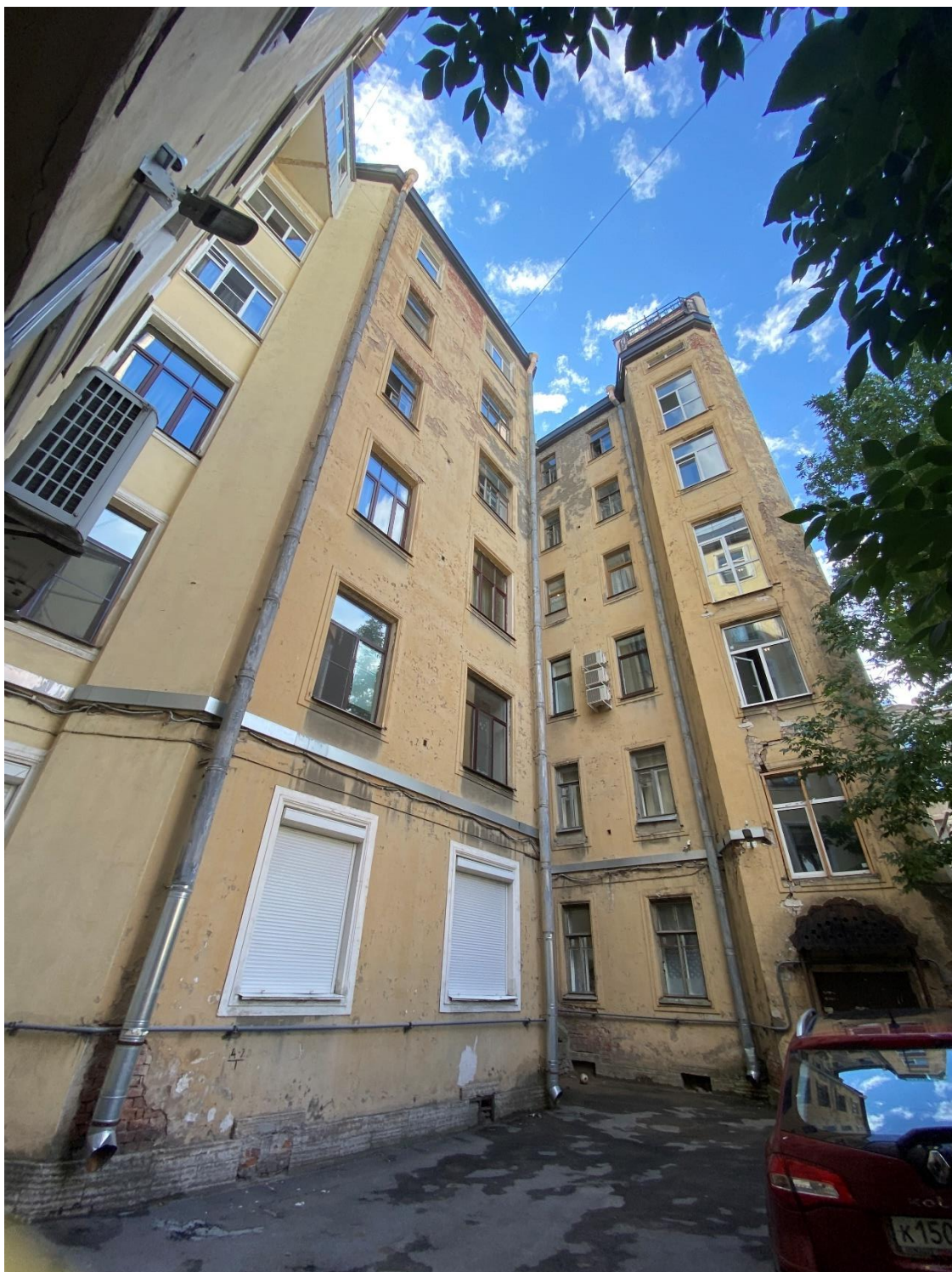
Фото 9. Вид на торцевую часть фасада.
