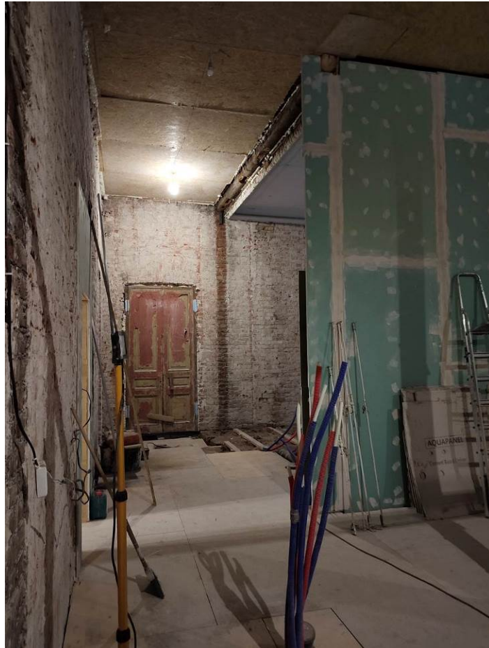
41. ОКН регионального значения «Жилой дом страхового общества “Россия” с садом и оградой» (г. Санкт-Петербург, Моховая ул., 27-29). Помещение кв.№ 70.
