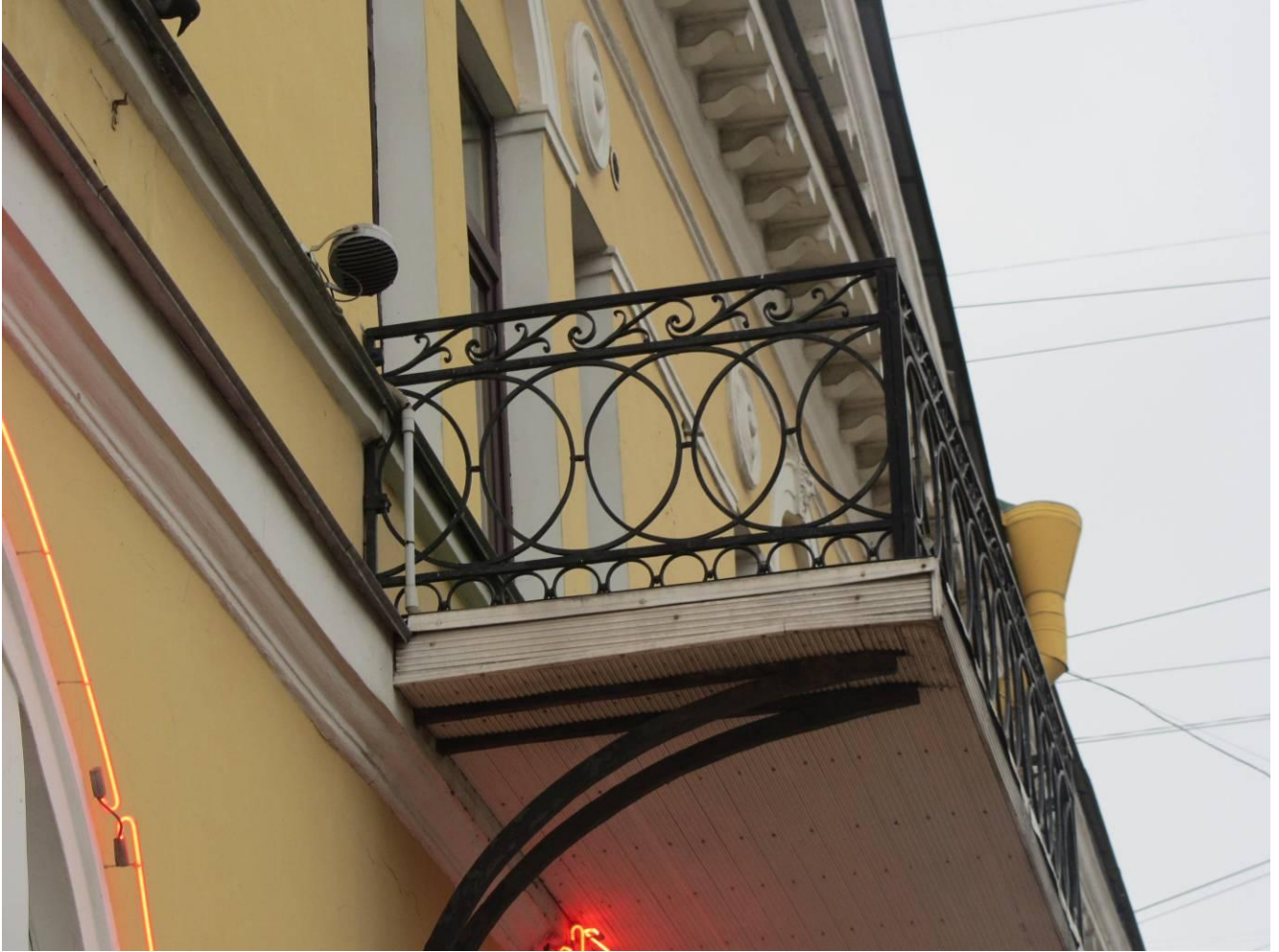
3. Фрагмент северо-восточного фасада дома 56 («Дом Терешиных»).
