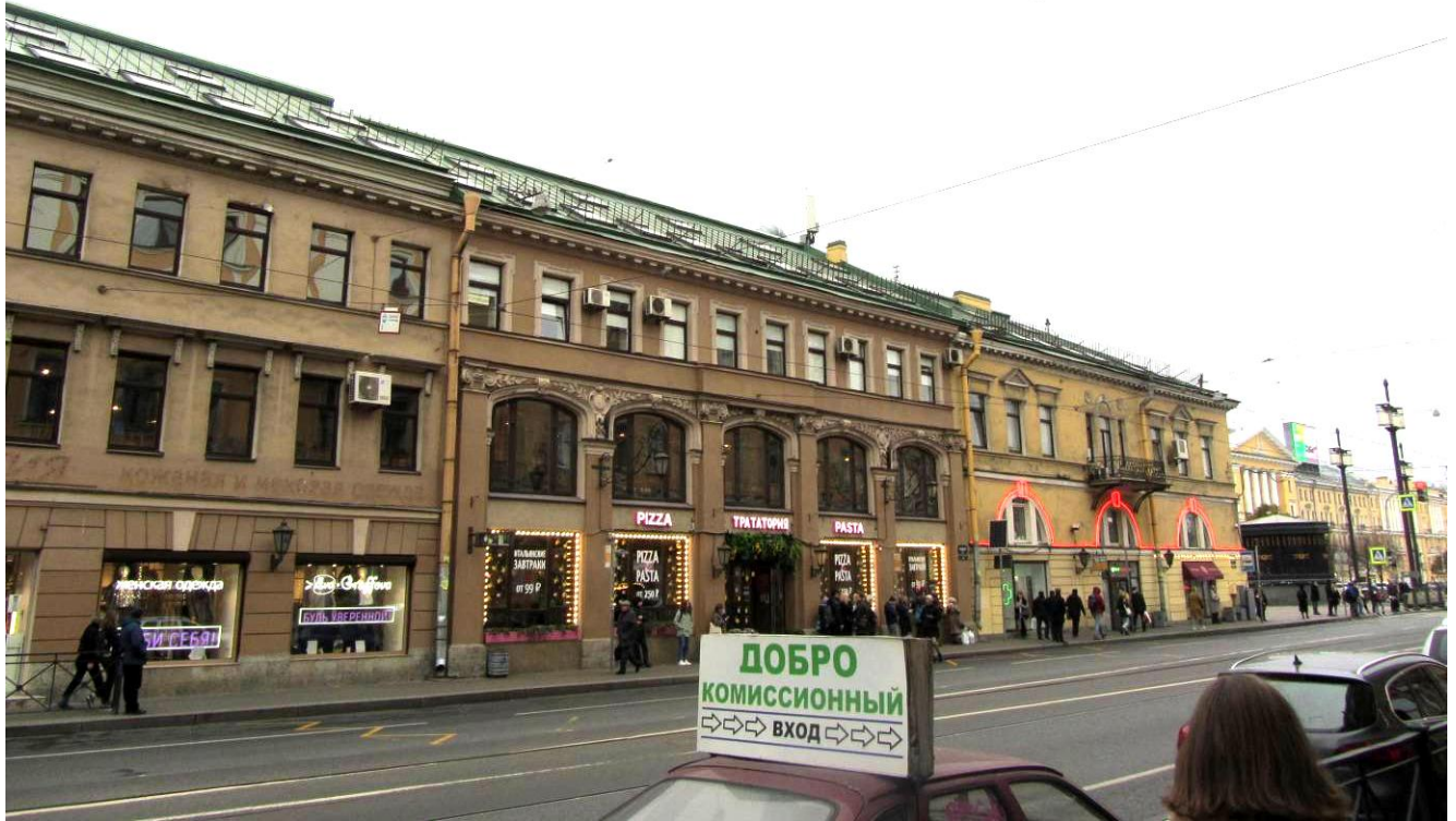
12. Юго-восточные фасады флигелей («Дом Терешиных», «Дом Фалевых») по Садовой улице (дом 56-58). Фрагмент.
