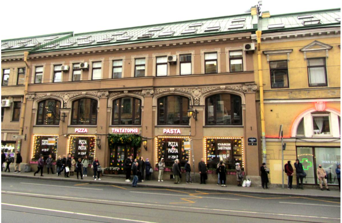
10. Юго-восточный фасад флигеля («Дом Терешиных») по Садовой улице (дом 56).
