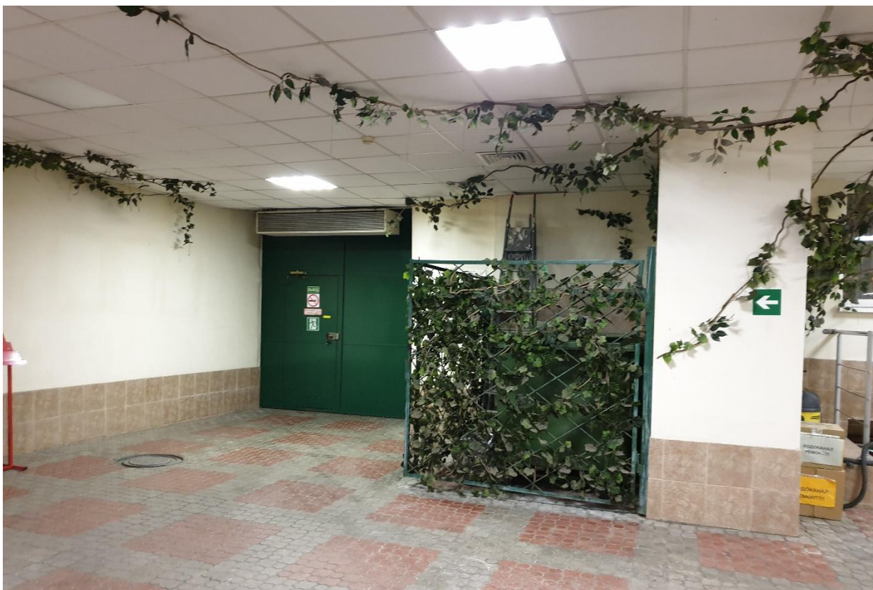
Фото 23. Общий вид на помещение 11
