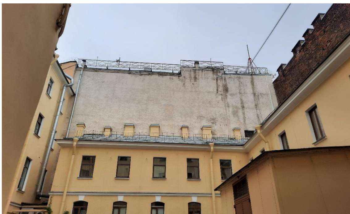
Фото 4. Восточный фасад, вид со стороны двора
