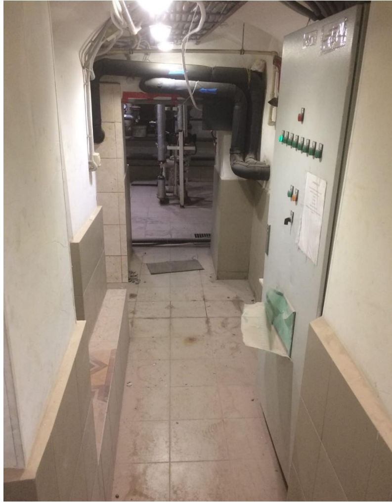
Фото 5. Помещение 6. Вид на помещение 9
