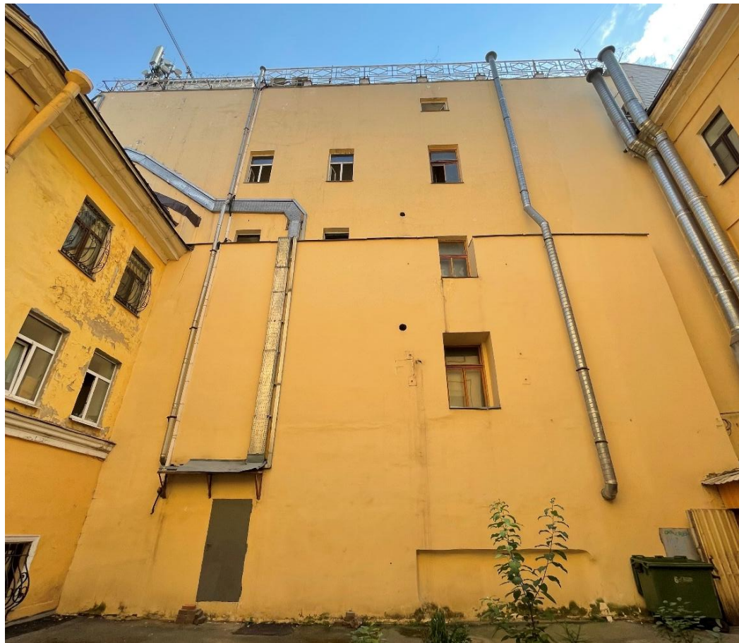
Фото 3. Западный фасад, вид со стороны двора
