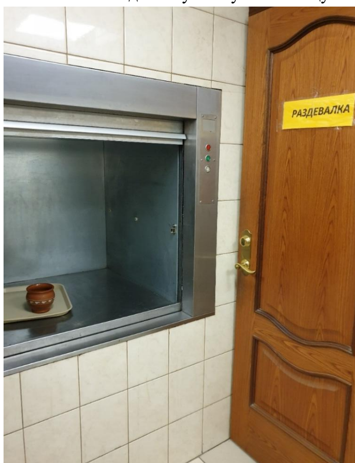
Фото 27. Вид на помещение 71
