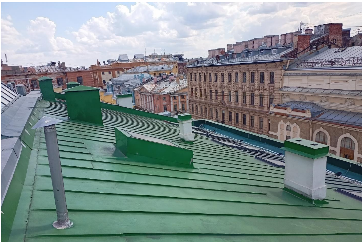
Фото 58. Вид на кровлю
