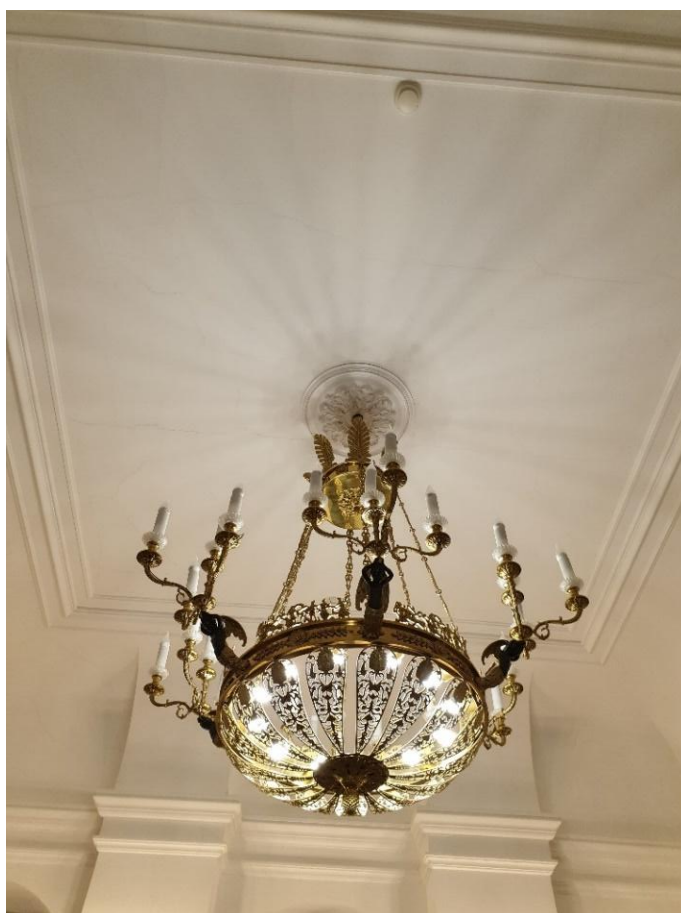
Фото 33. Вид на помещение 60. Потолок
