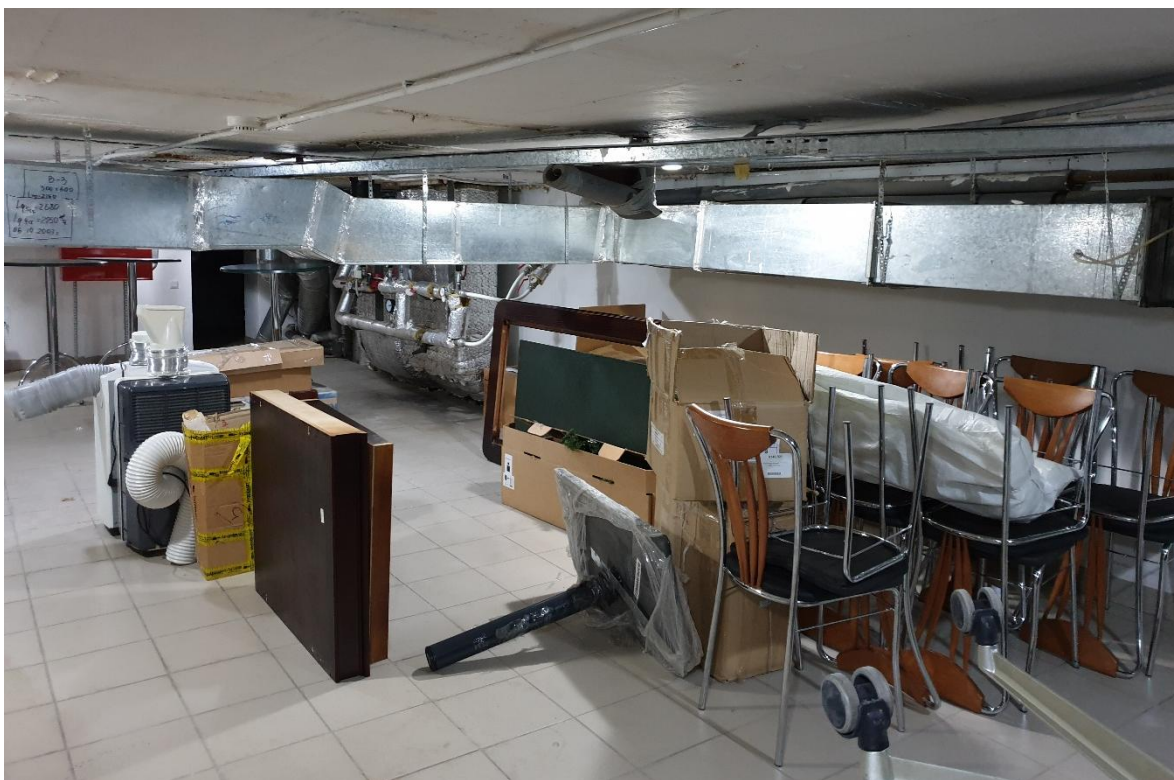
Фото 53. Вид на помещение 167
