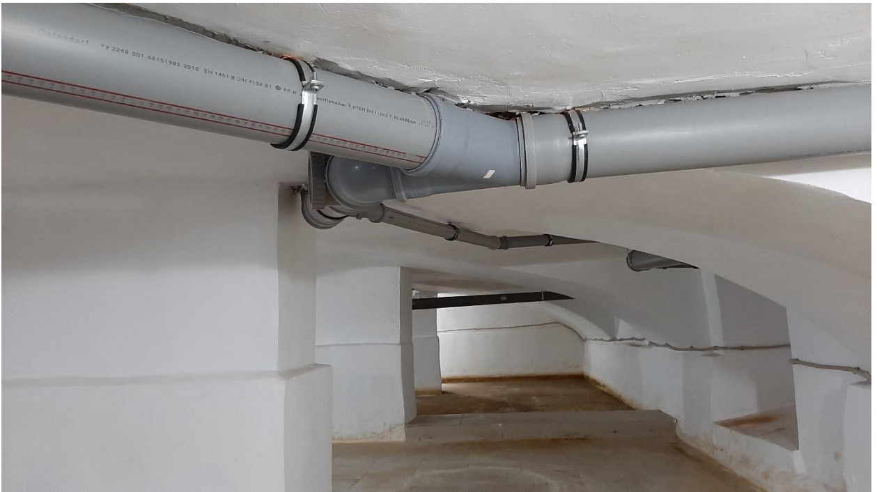
Фото 12. Общий вид помещения
