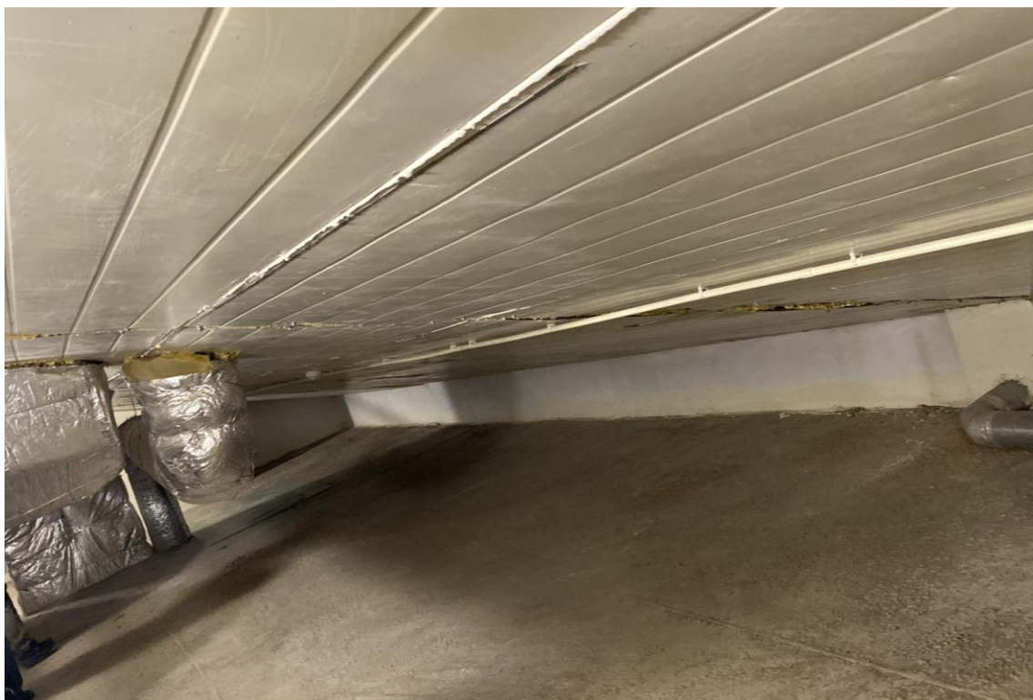
Фото 55. Вид на помещение 168
