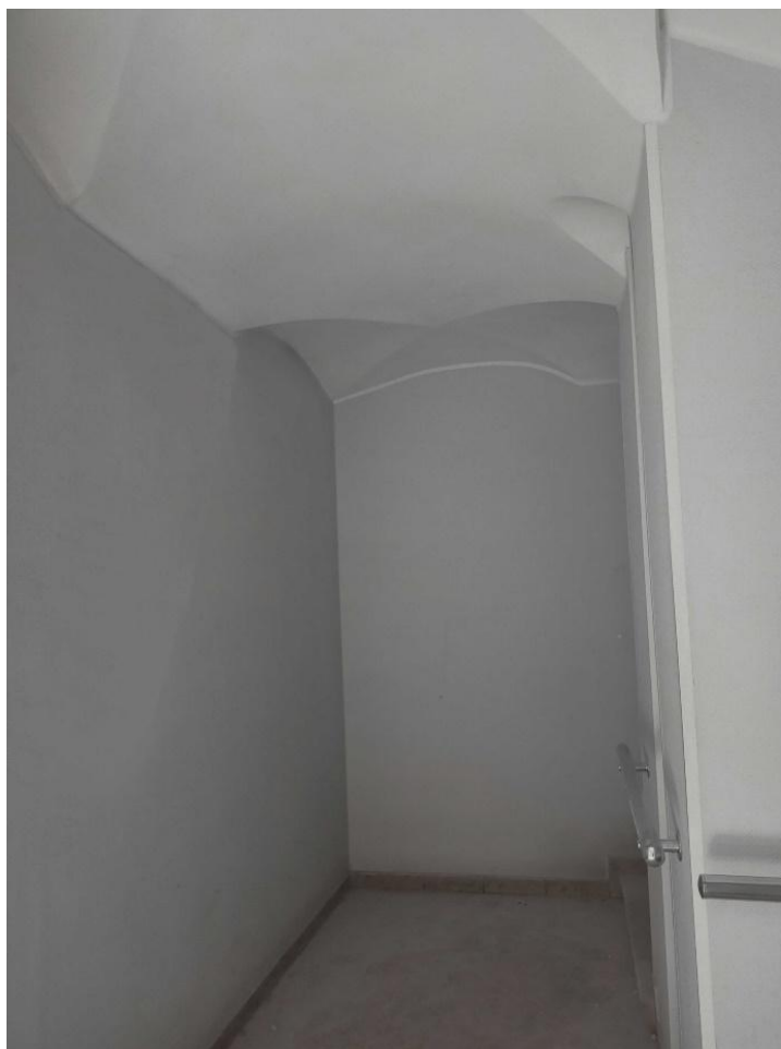
Фото 50. Вид на помещение 158
