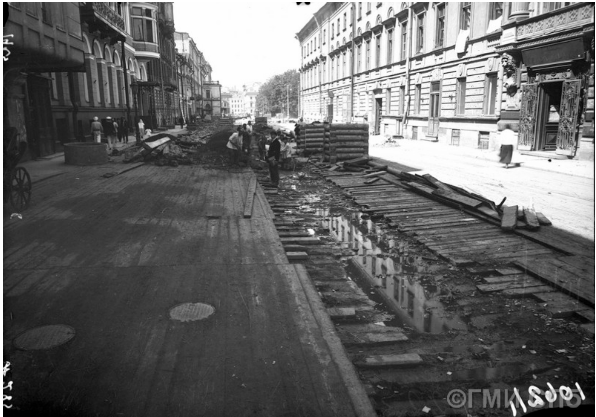
51. Дорожные работы. Снятие деревянной мостовой на улице Ракова (Итальянской улице). 1925 г. ГМИ СПб 221178
