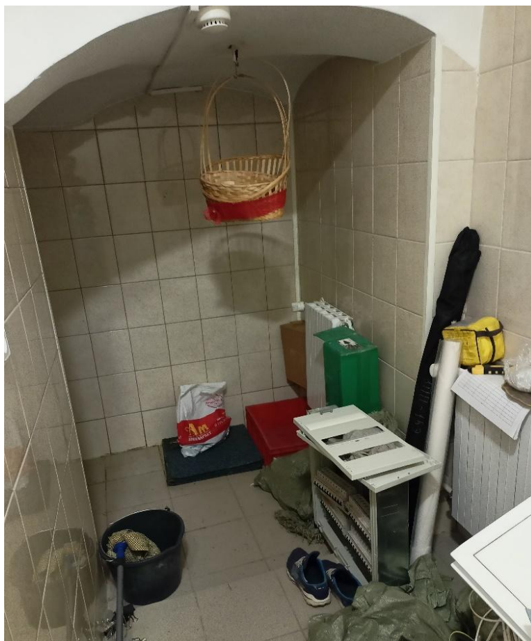
Фото 25. Общий вид на помещение 11
