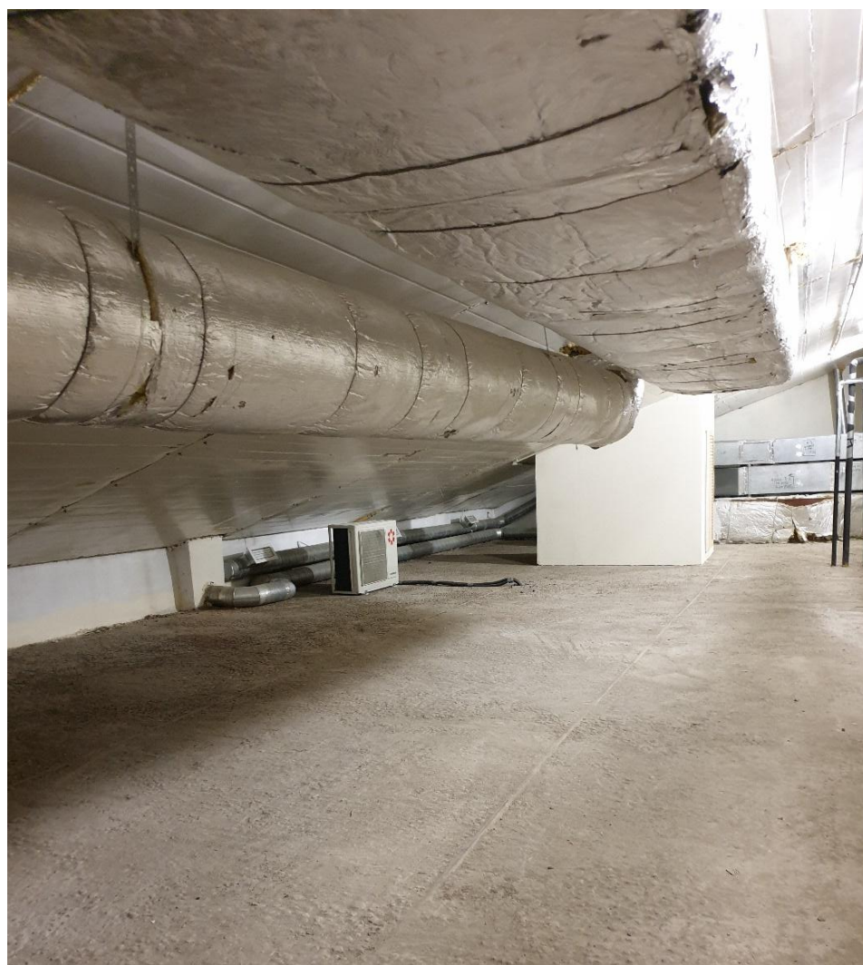
Фото 54. Вид на помещение 168
