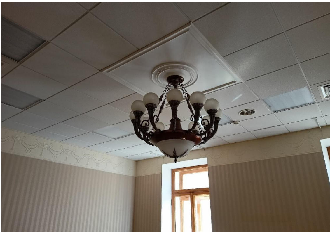
Фото 47. Помещение 114. Вид на потолок
