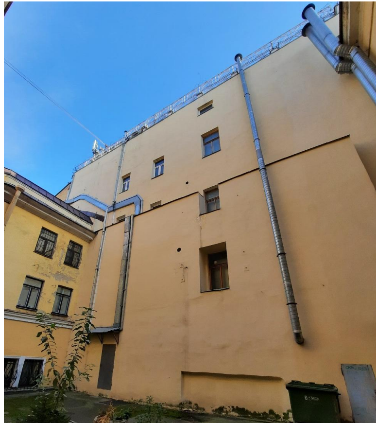
Фото 2. Западный фасад, вид со стороны двора
