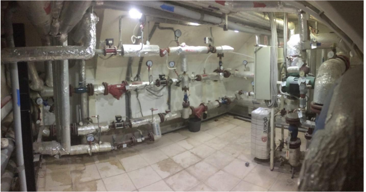
Фото 7. Вид на помещение 9
