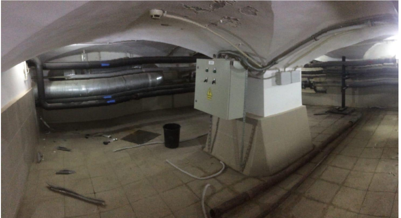
Фото 8. Вид на помещение 10
