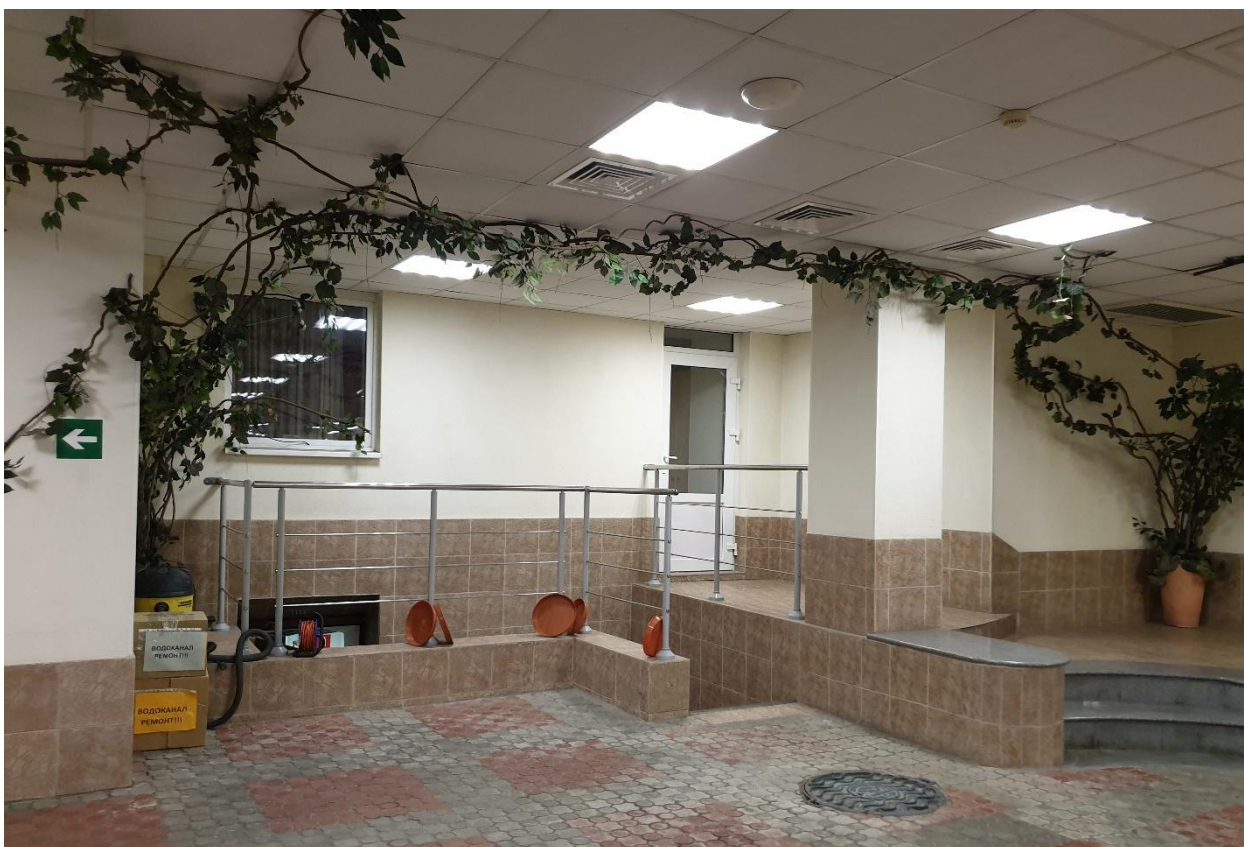
Фото 22. Общий вид на помещение 11
