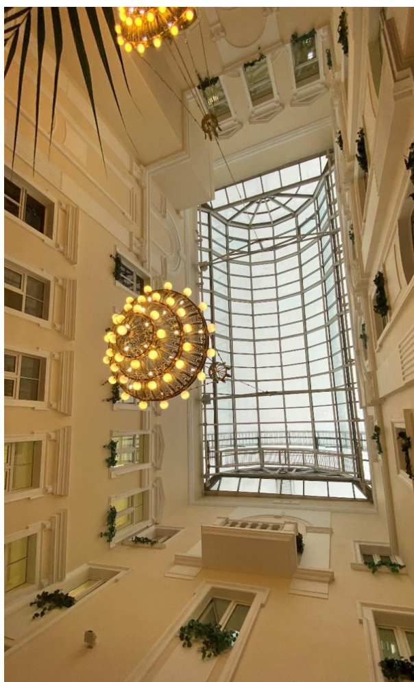
Фото 31. Вид на помещение 61. Световой фонарь
