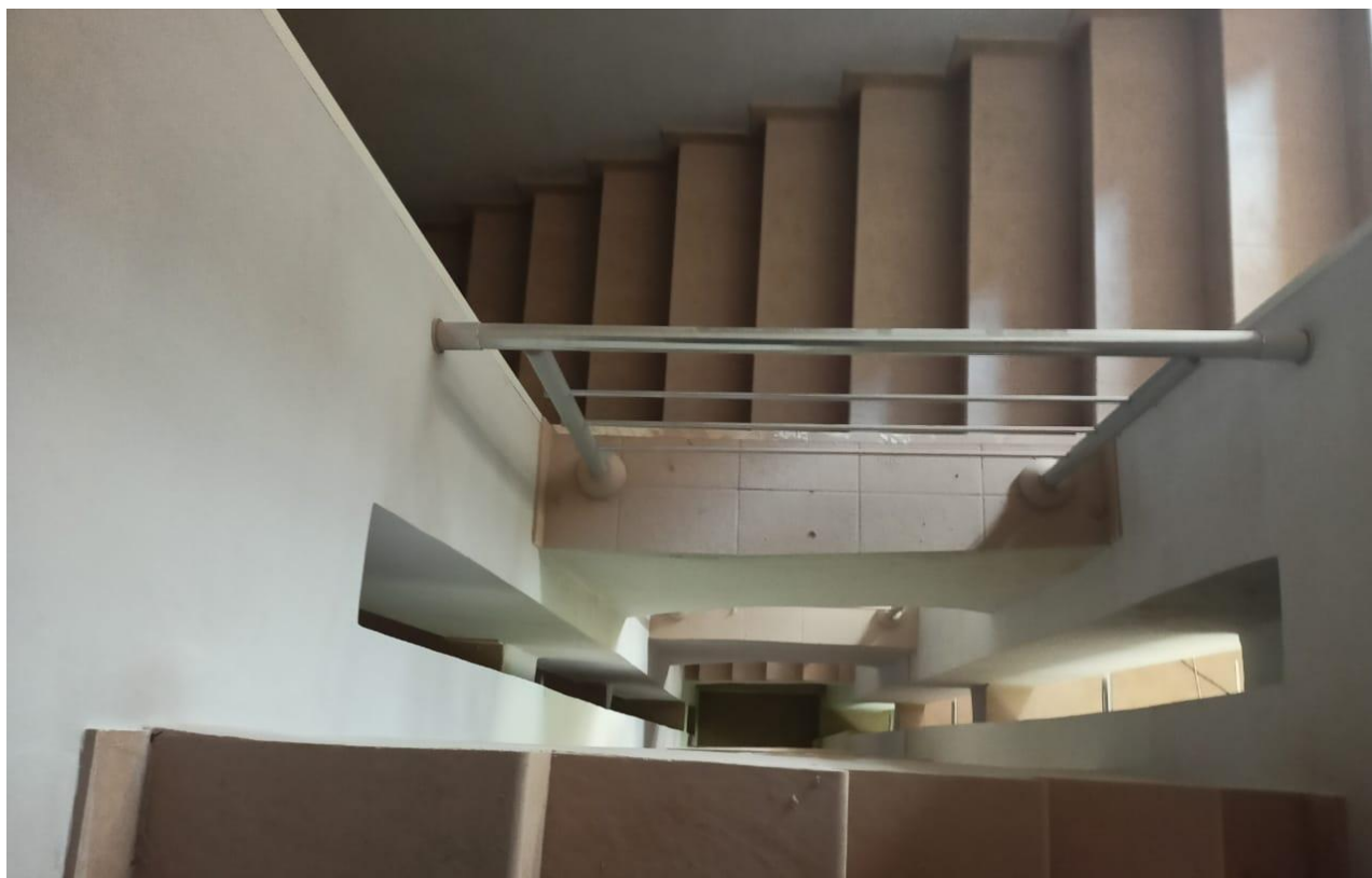
Фото 44. Вид на помещение 45
