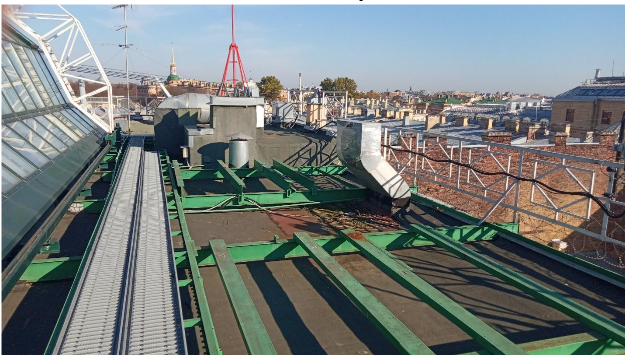
Фото 57. Вид на кровлю
