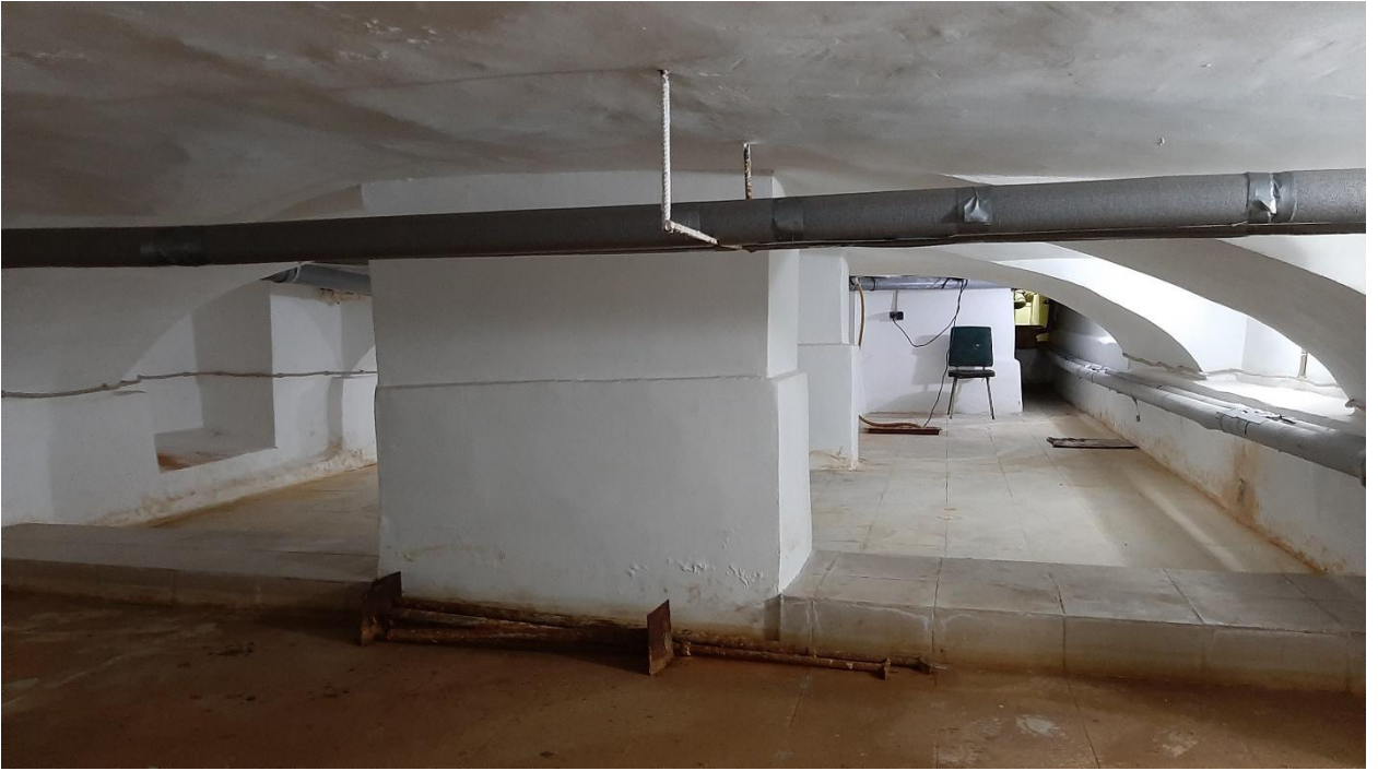
Фото 11. Общий вид помещения
