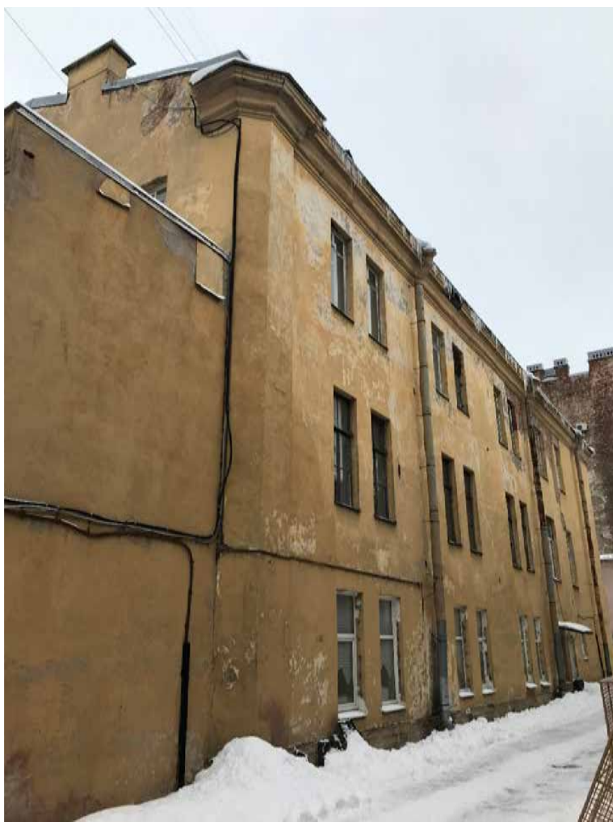
15. Санкт-Петербург, 3-я линия В.О., 30-32. Выявленный объект культурного наследия «Елизаветинская богадельня купцов Елисеевых». Юго-западный дворовый корпус. Дата фотофиксации: 02.12.2021 г.
