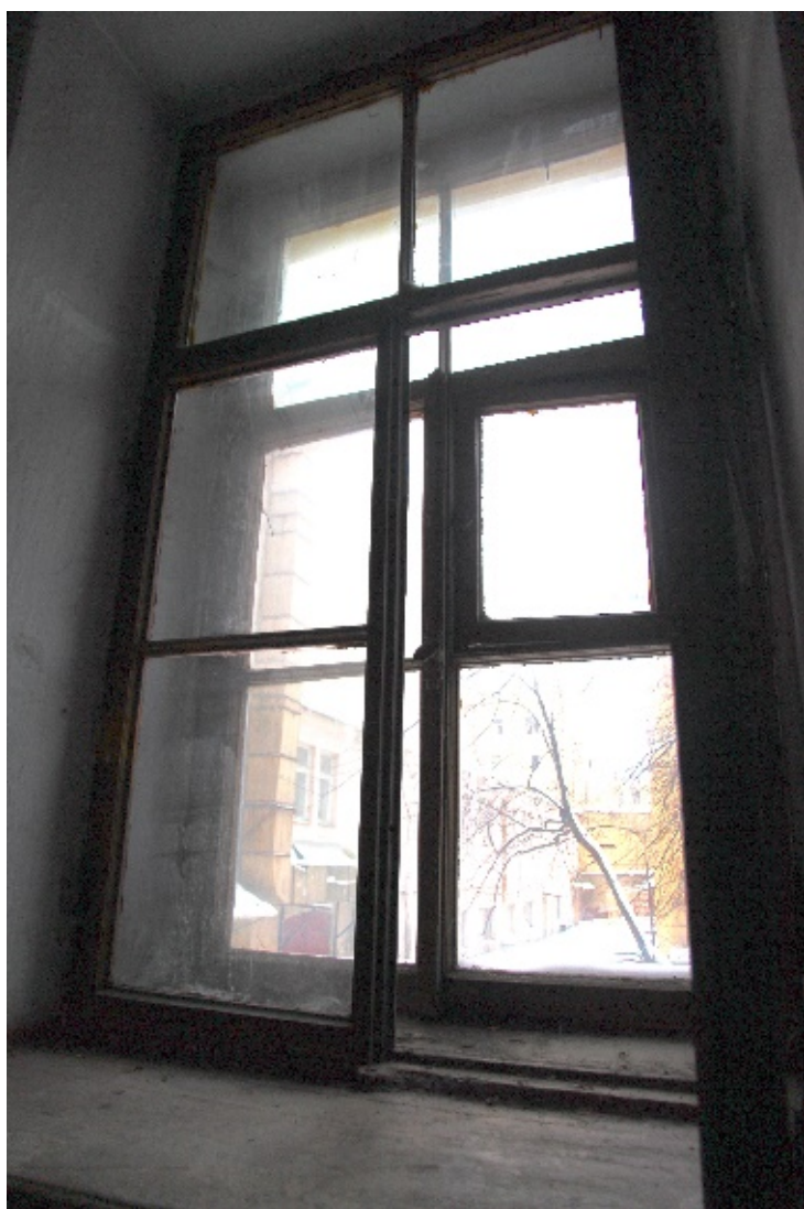
47. Санкт-Петербург, 3-я линия В.О., 30-32. Выявленный объект культурного наследия «Елизаветинская богадельня купцов Елисеевых». Второй этаж. Помещение 2-Н (118) (12,2 кв.м). Оформление оконного проема. Дата фотофиксации: 02.12.2021 г.
