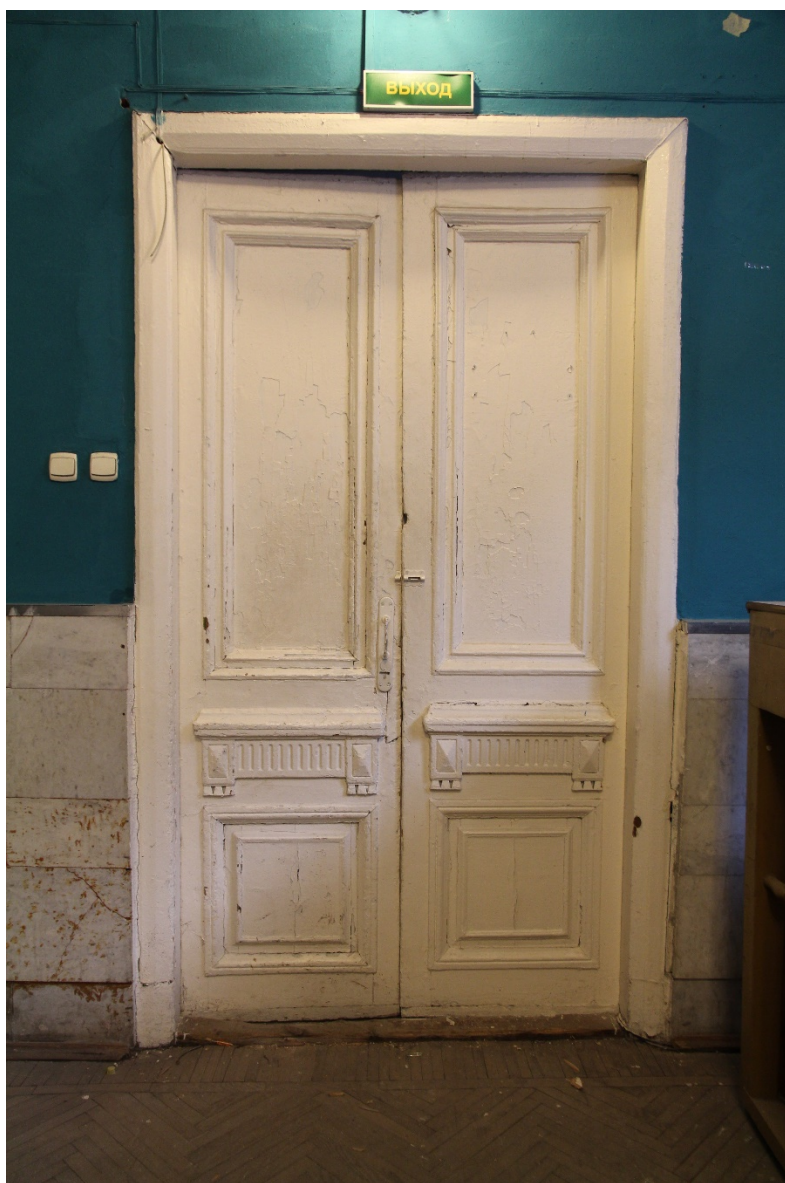
40. Санкт-Петербург, 3-я линия В.О., 30-32. Выявленный объект культурного наследия «Елизаветинская богадельня купцов Елисеевых». Второй этаж. Помещение 153 (182,8 кв.м). Оформление дверного проема. Дата фотофиксации: 02.12.2021 г.
