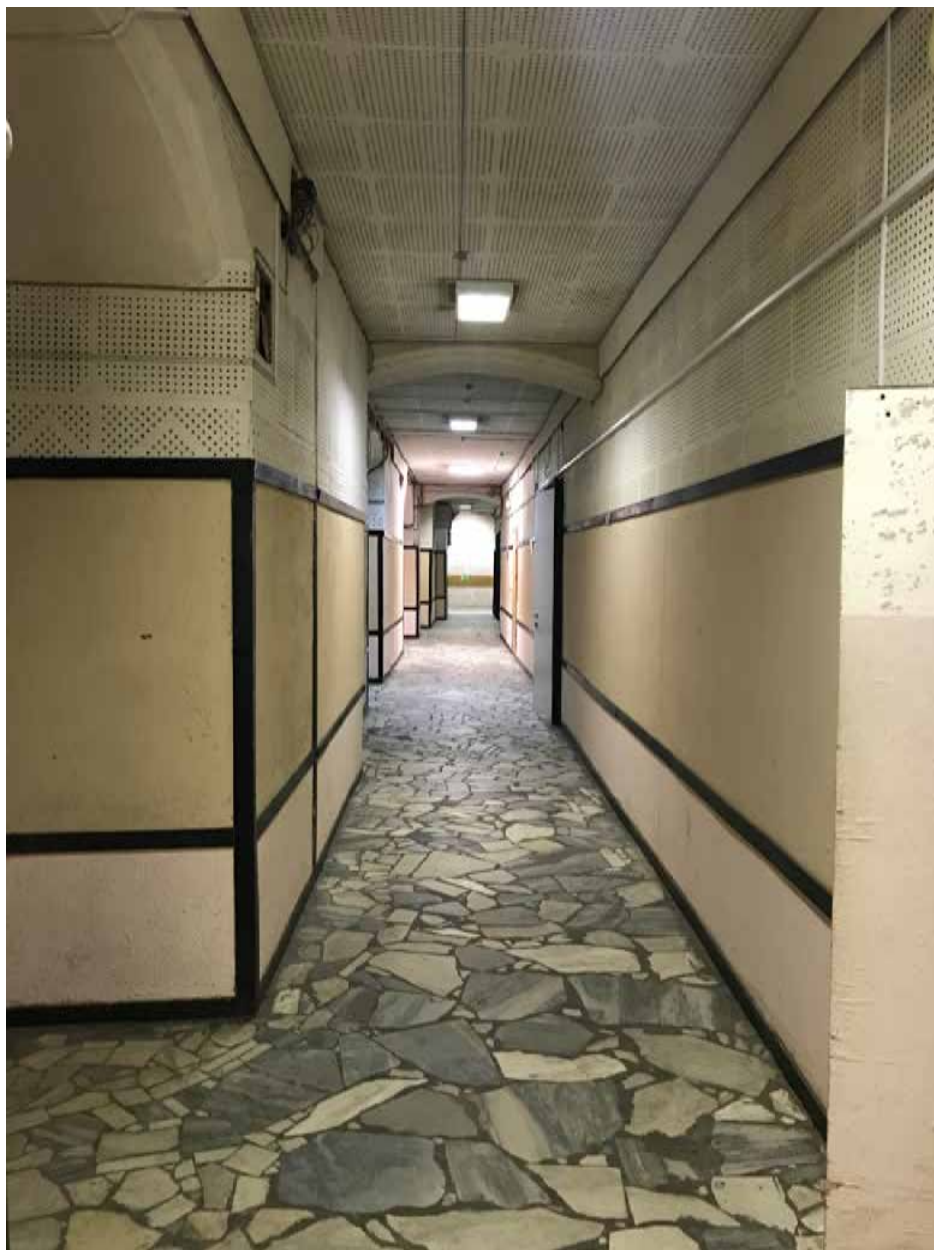
22. Санкт-Петербург, 3-я линия В.О., 30-32. Выявленный объект культурного наследия «Елизаветинская богадельня купцов Елисеевых». Первый этаж. Оформление коридора. Дата фотофиксации: 02.12.2021 г.
