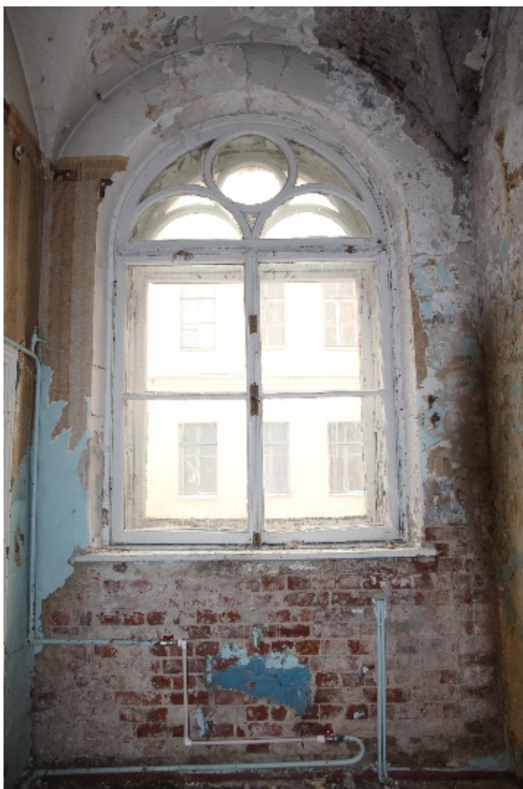
44. Санкт-Петербург, 3-я линия В.О., 30-32. Выявленный объект культурного наследия «Елизаветинская богадельня купцов Елисеевых». Второй этаж. Помещение 154 (9,3 кв.м). Оформление оконного проема. Дата фотофиксации: 02.12.2021 г.
