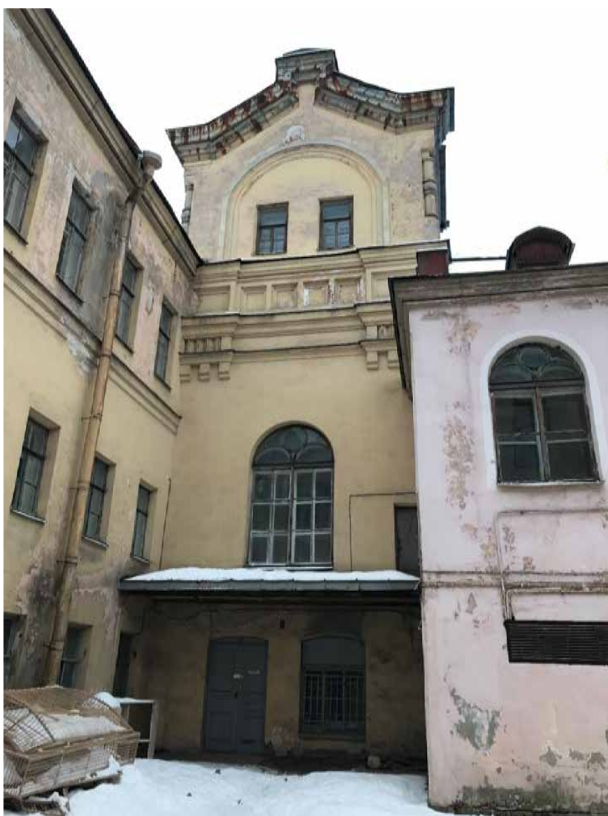
11. Санкт-Петербург, 3-я линия В.О., 30-32. Выявленный объект культурного наследия «Елизаветинская богадельня купцов Елисеевых». Первый двор. Щипцовое завершение атиковидной надстройки. Дата фотофиксации: 02.12.2021 г.
