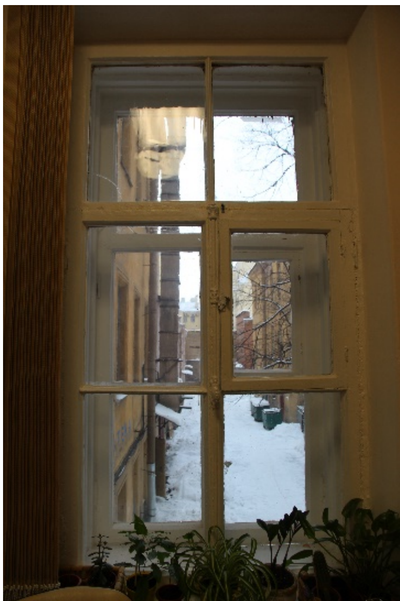
46. Санкт-Петербург, 3-я линия В.О., 30-32. Выявленный объект культурного наследия «Елизаветинская богадельня купцов Елисеевых». Второй этаж. Помещение 116 (16,1 кв.м). Оформление оконного проема. Дата фотофиксации: 02.12.2021 г.
