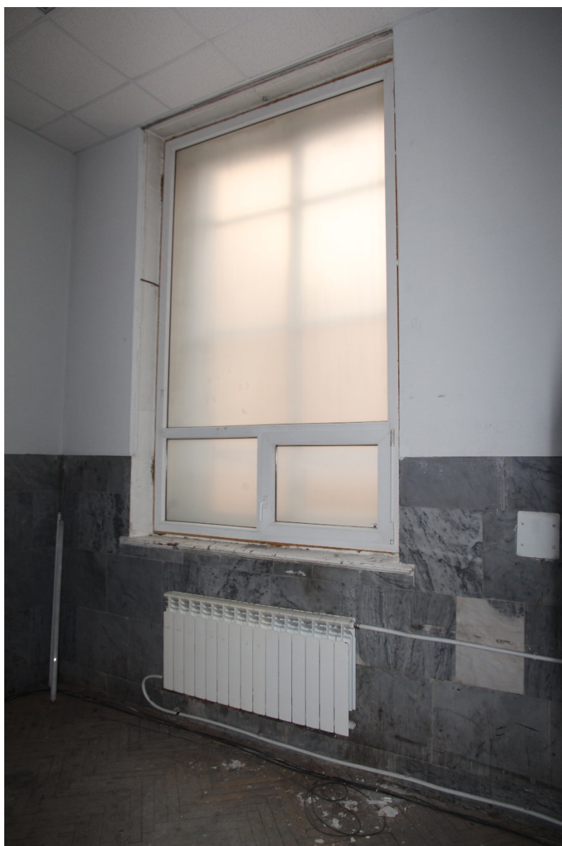
29. Санкт-Петербург, 3-я линия В.О., 30-32. Выявленный объект культурного наследия «Елизаветинская богадельня купцов Елисеевых». Второй этаж. Помещение 149 (54,3 кв.м). Дата фотофиксации: 02.12.2021 г.
