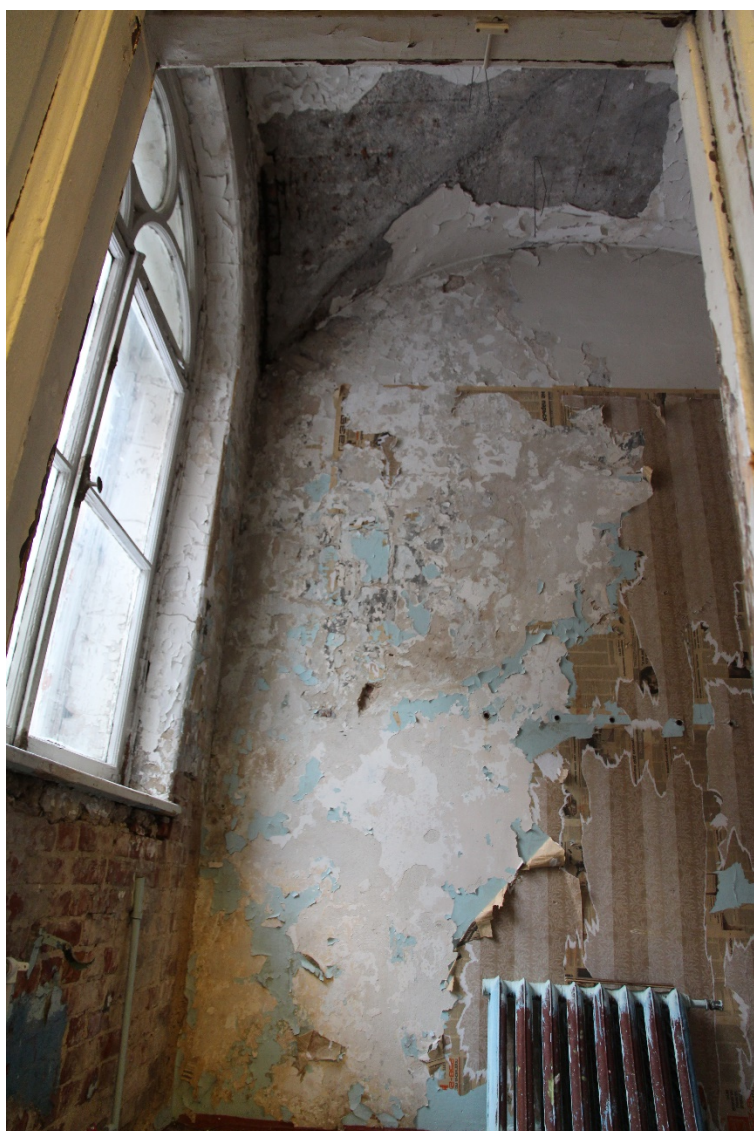
43. Санкт-Петербург, 3-я линия В.О., 30-32. Выявленный объект культурного наследия «Елизаветинская богадельня купцов Елисеевых». Второй этаж. Помещение 154 (9,3 кв.м). Дата фотофиксации: 02.12.2021 г.
