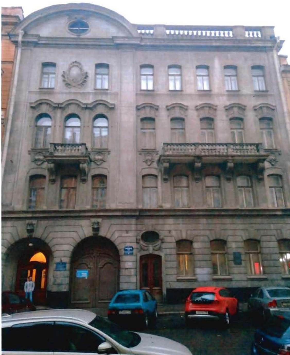
1. Вид на восточный (лицевой) фасад объекта культурного наследия.
