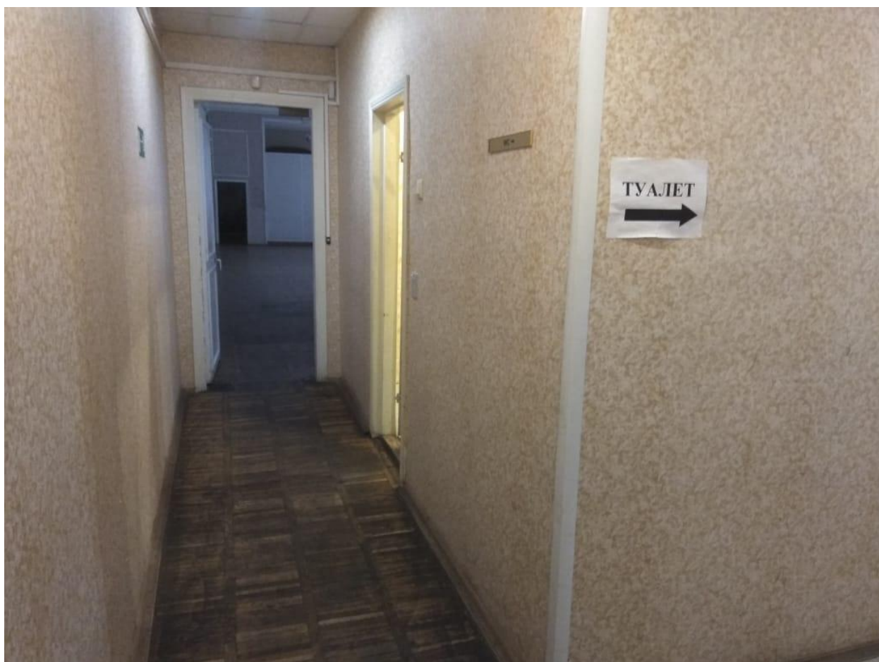
Фото 39. Интерьер помещения 9-Н (часть помещения №10) 3 этаж
