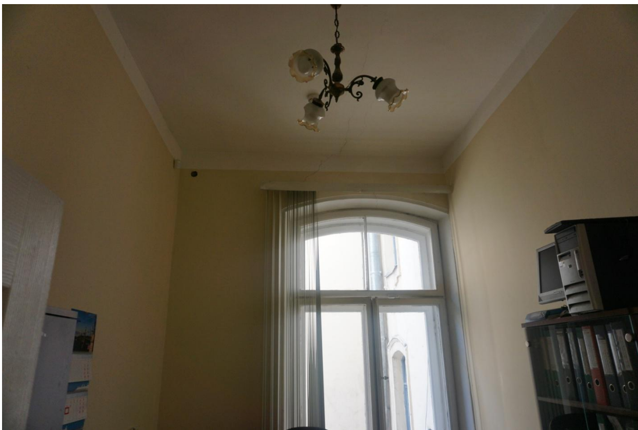
Фото 32. Интерьер помещения 8-Н (часть помещения №17) 2 этаж
