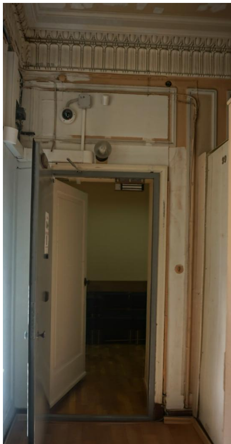
Фото 17. Дверной проём пом. 9-Н.
