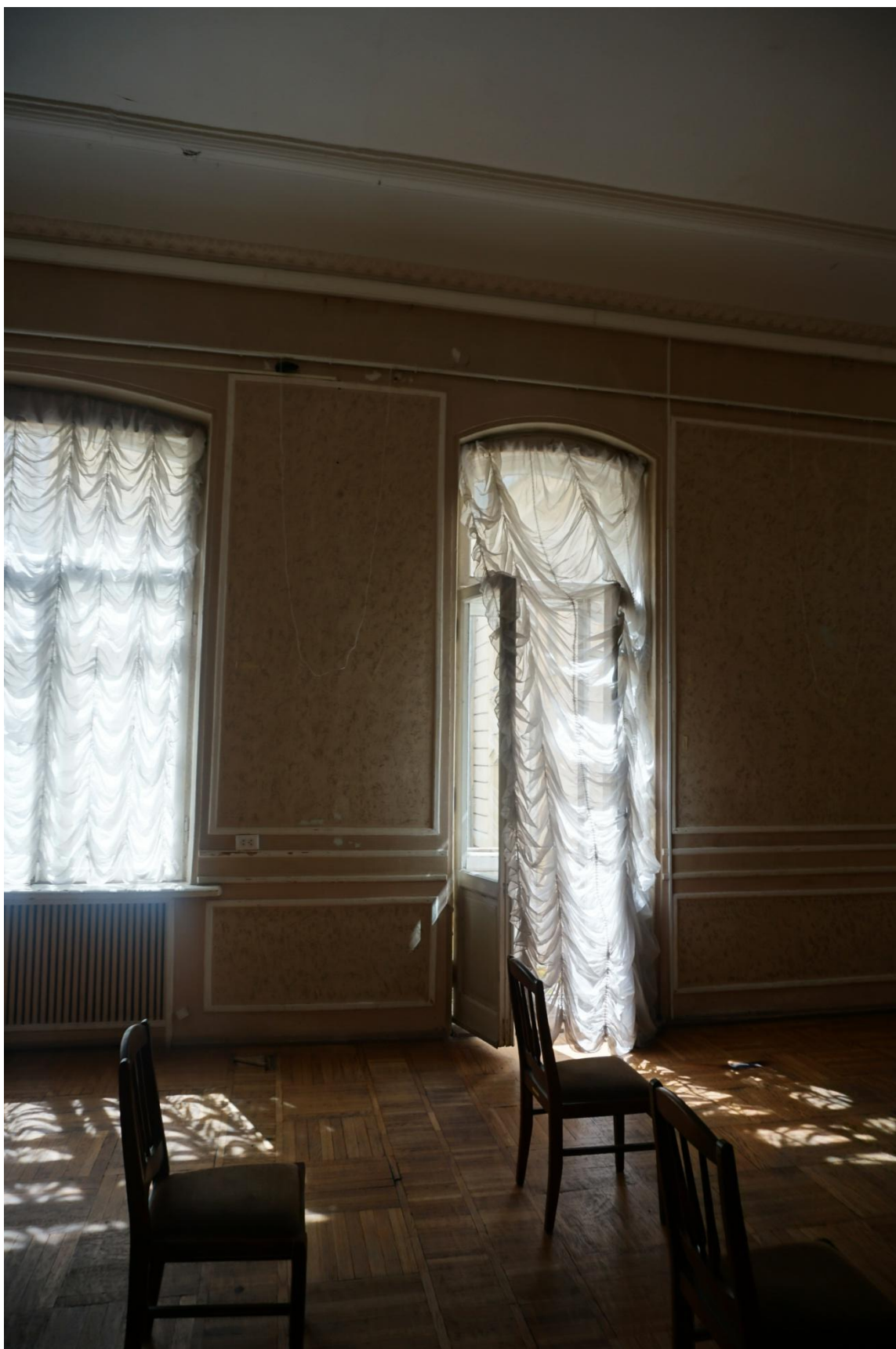
Фото 41. Интерьер помещения 9-Н (часть помещения №9) 3 этаж
