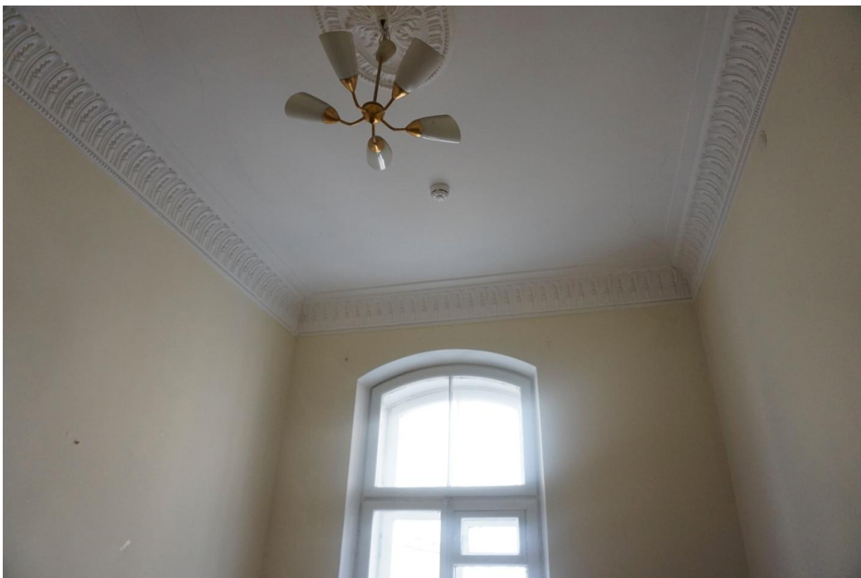
Фото 30. Интерьер помещения 8-Н (часть помещения №13) 2 этаж
