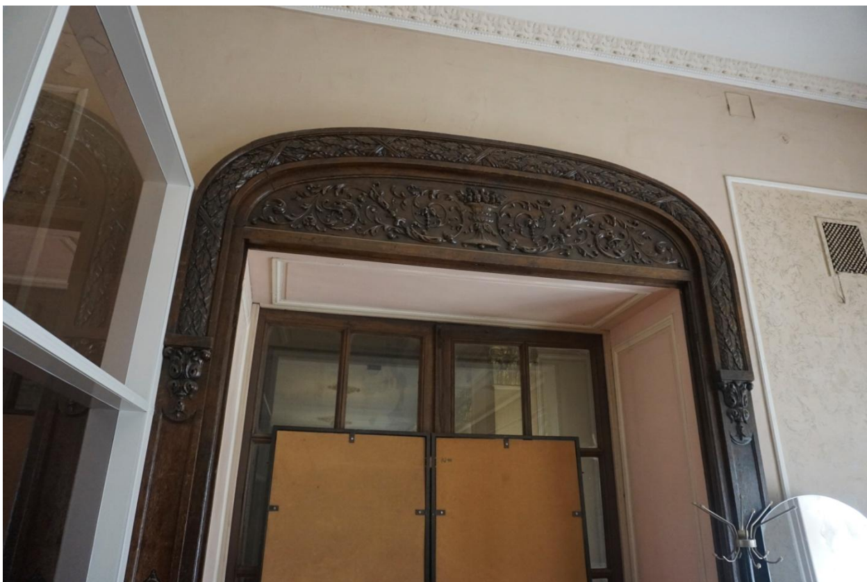
Фото 46. Интерьер помещения 9-Н (часть помещения №8) 3 этаж
