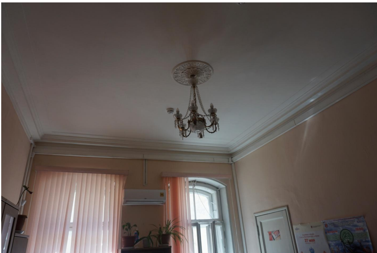
Фото 22. Интерьер помещения 9-Н (часть помещения №29) 4 этаж
