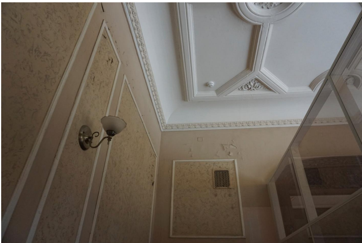
Фото 44. Интерьер помещения 9-Н (часть помещения №8) 3 этаж
