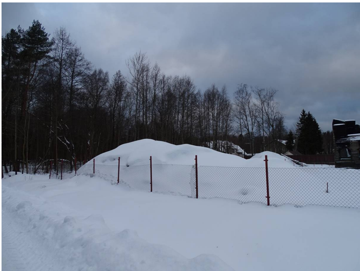
Илл. 4. Вид на территорию объекта культурного наследия «Дача (деревянная)» с Березового переулка. Съемка 14.01.2022 г. Трушковский В.Э.
