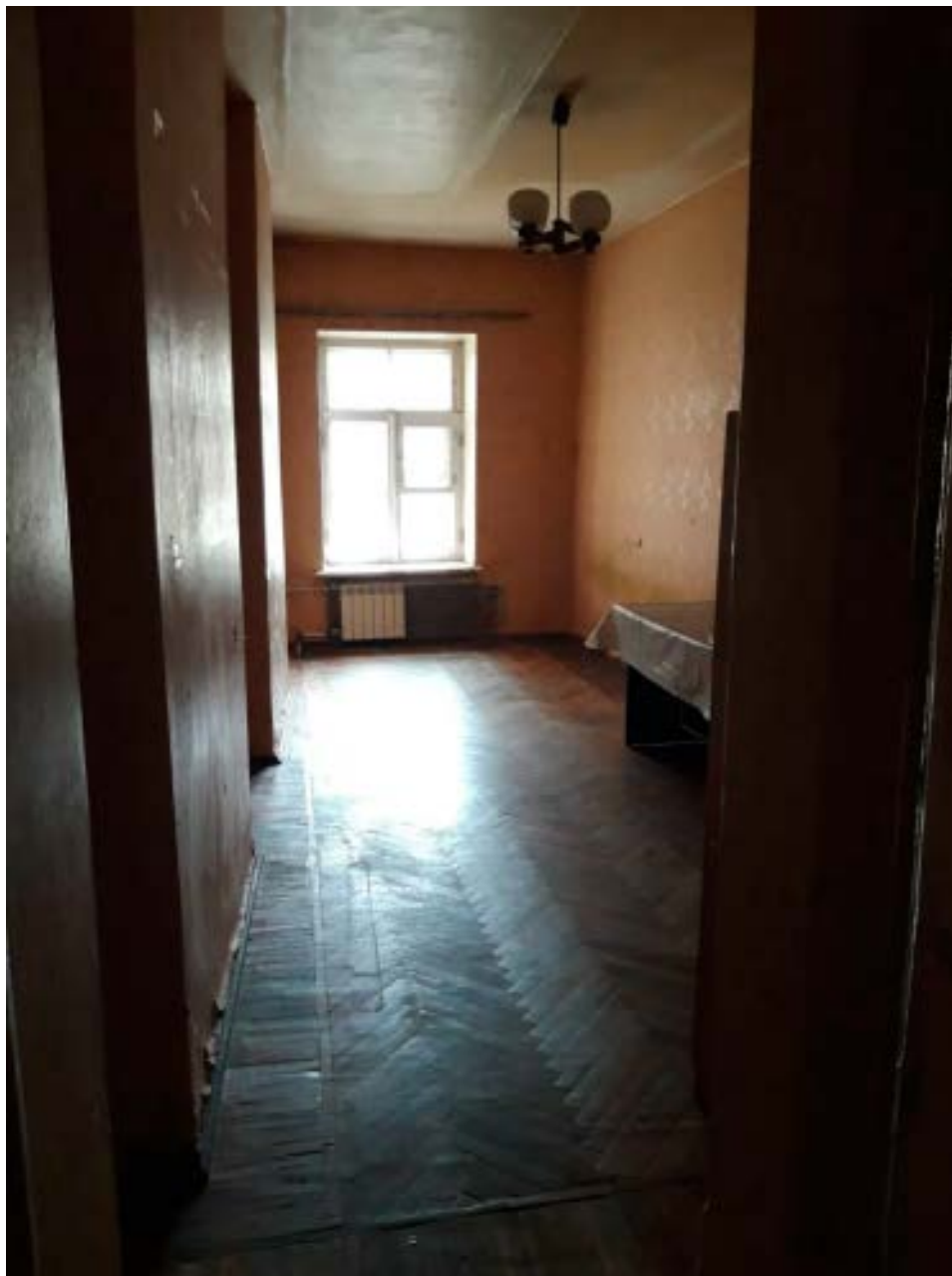
9. Помещение №2 кв. №10 в уровне 5-го этажа объекта культурного наследия регионального значения «Дом П.Д. Мальцова», расположенного по адресу: г. Санкт-Петербург, Пушкинская ул., д. 2/79, литера А. 01.06.2021.
