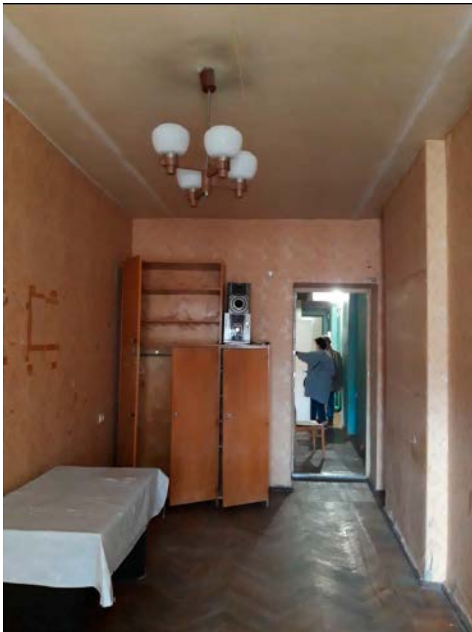
8. Помещение №2 кв. №10 в уровне 5-го этажа объекта культурного наследия регионального значения «Дом П.Д. Мальцова», расположенного по адресу: г. Санкт-Петербург, Пушкинская ул., д. 2/79, литера А. 01.06.2021.
