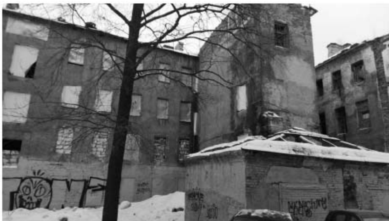
Фото №11. Юго-восточный дворовый фасад.
