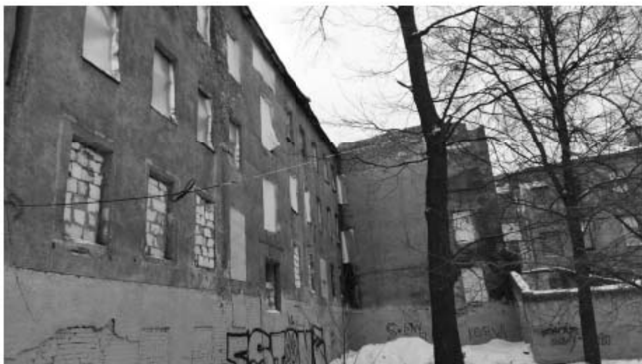
Фото №12. Юго-восточный дворовый фасад.
