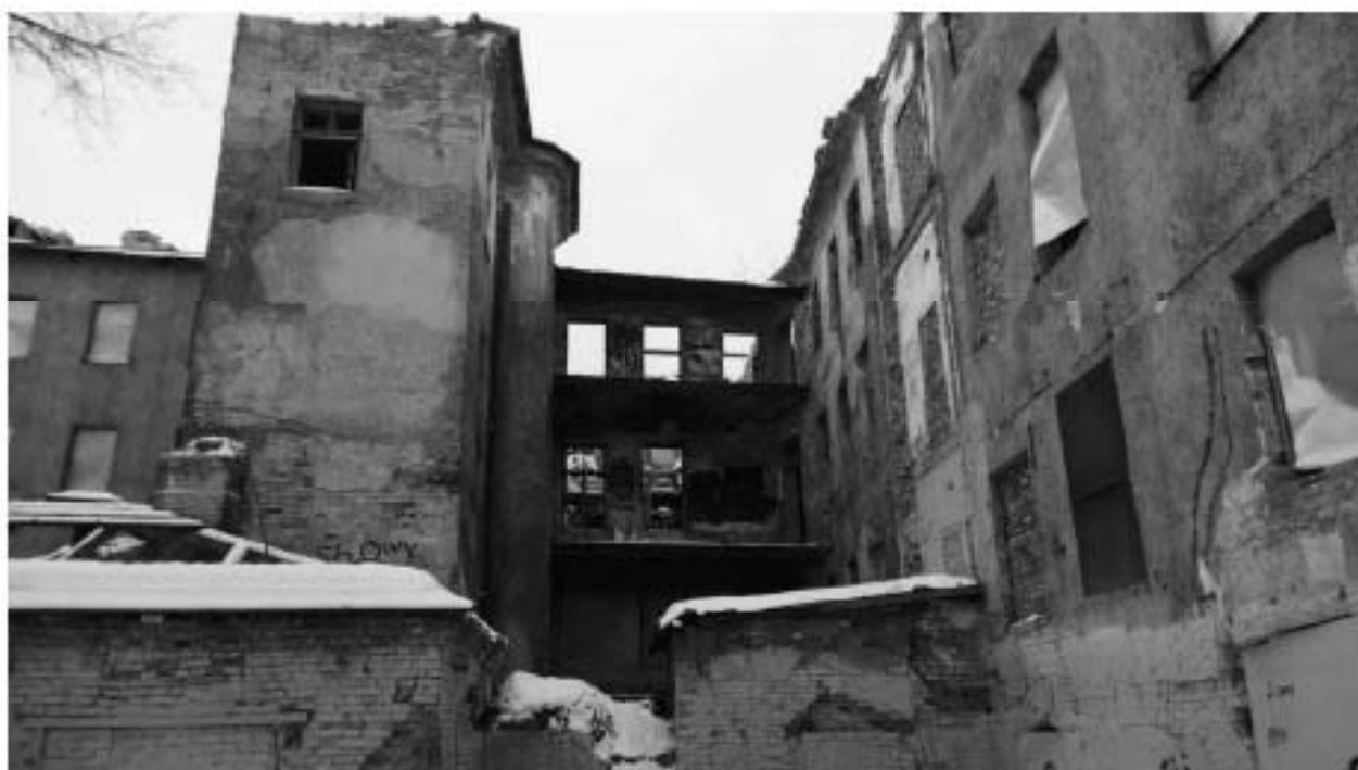
Фото №6. Юго-восточный дворовый фасад.
