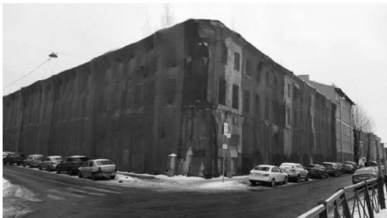
Фото №1. Лицевые фасады по улице Фокина и набережной реки Пряжки.
