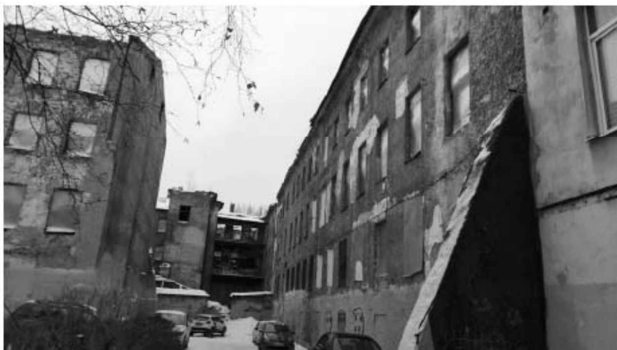
Фото №5. Юго-западный дворовый фасад.
