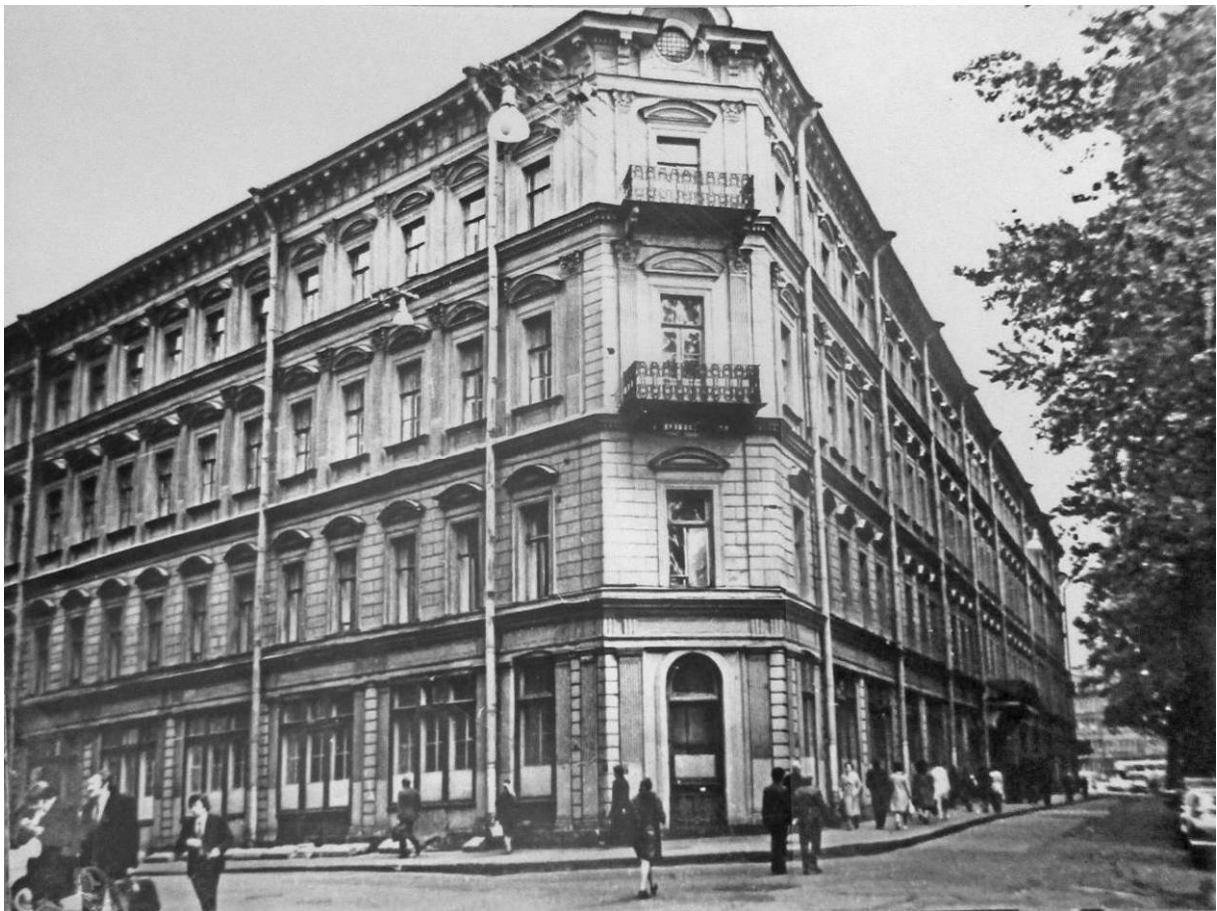
Илл. 42. Вид с угла Кирпичного пер. и наб. р. Мойки. 1976 г. Из паспорта КГИОП П.815 инв. №101 от 05.03.1982 г.
