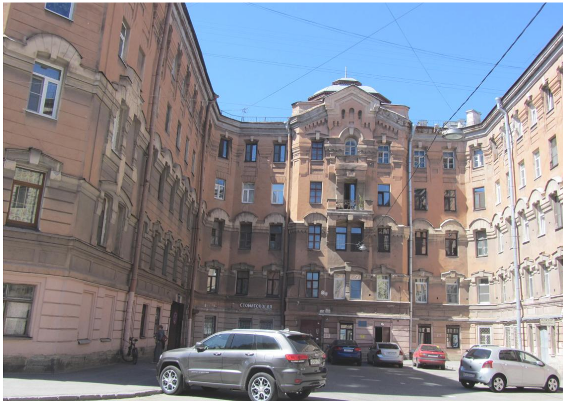
8. Выявленный объект культурного наследия "Комплекс доходных домов Н.И. Львовой (8 зданий)". Общий вид фасадов домов №9-11 по Угловому пер. от Московского пр.
