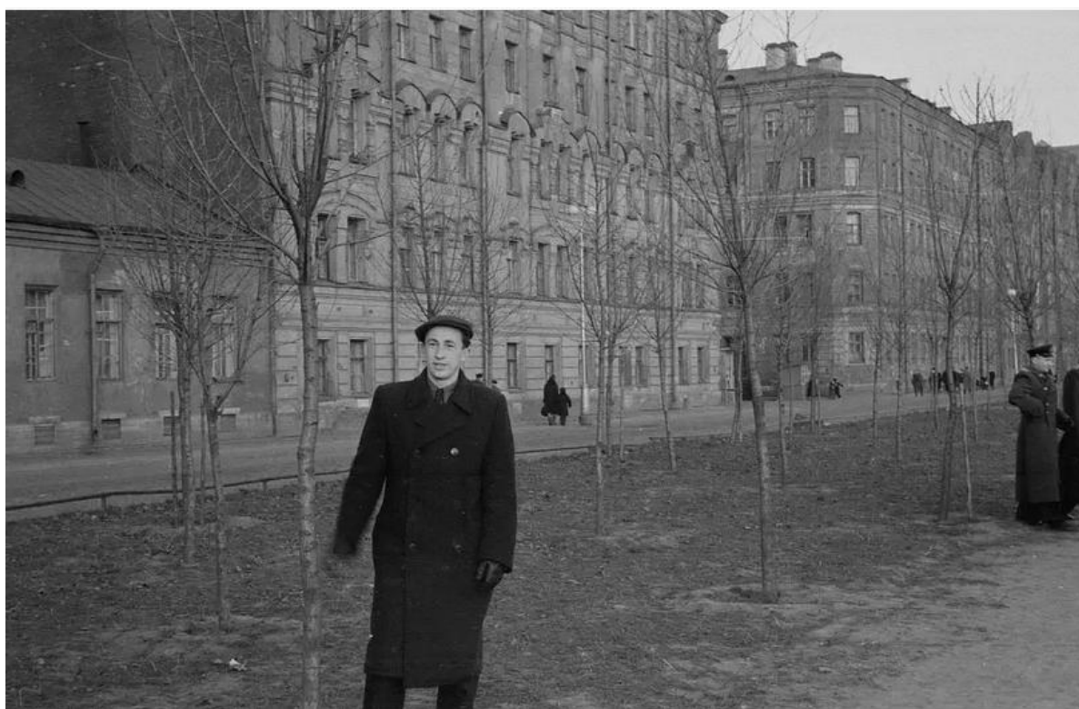
Илл. 12 На набережной Обводного канала. 1950-1953 гг. Частный архив.
