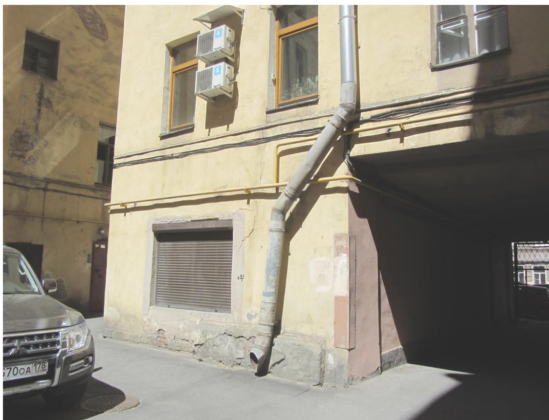
11. Выявленный объект культурного наследия "Комплекс доходных домов Н.И. Львовой (8 зданий)". Фрагмент дворового фасада дома №11.
