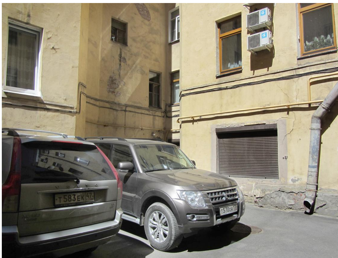
12. Выявленный объект культурного наследия "Комплекс доходных домов Н.И. Львовой (8 зданий)". Фрагмент дворового фасада дома №11.
