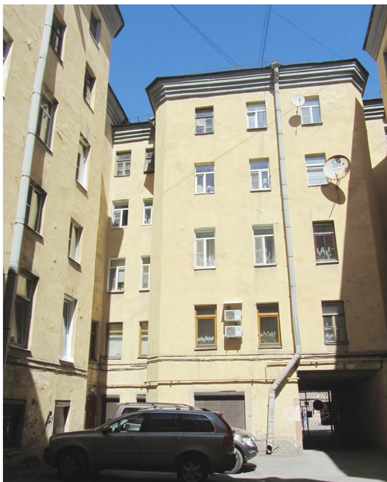
15. Выявленный объект культурного наследия "Комплекс доходных домов Н.И. Львовой (8 зданий)". Общий вид дворового фасада дома №11.
