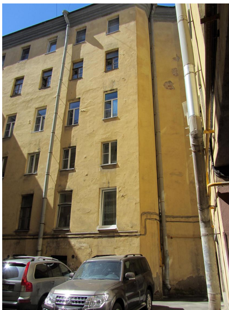
16. Выявленный объект культурного наследия "Комплекс доходных домов Н.И. Львовой (8 зданий)". Фрагмент дворового фасада дома №11.
