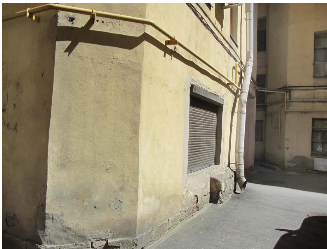
13. Выявленный объект культурного наследия "Комплекс доходных домов Н.И. Львовой (8 зданий)". Фрагмент дворового фасада дома №11.
