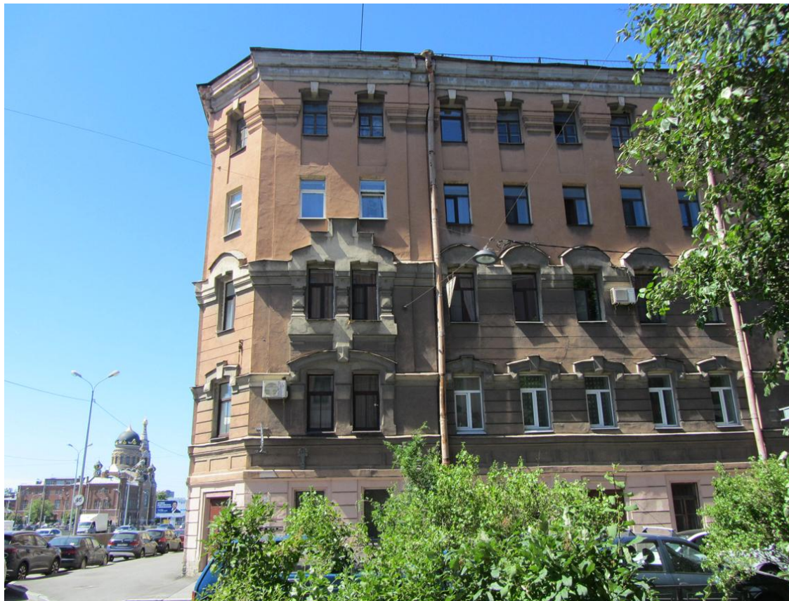
3. Выявленный объект культурного наследия "Комплекс доходных домов Н.И. Львовой (8 зданий)". Фрагмент фасада дома №11 с наб. Обводного канала.
