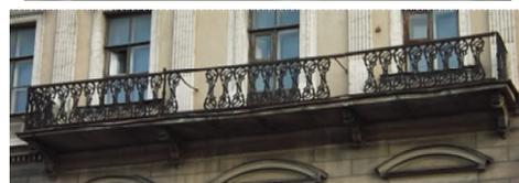
балкон на чугунных кронштейнах – местоположение (фасад на Большой Морской ул., в уровне 3-го этажей), габариты и конфигурация в плане (прямоугольный);
