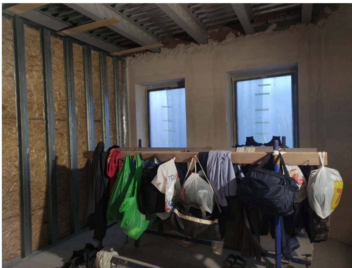
Фото 26. Интерьер квартиры № 118 объекта культурного наследия регионального значения «Дом, в котором жил с 1913 г. и умер в 1935 г. географ и путешественник П.К.Козлов (кв. 32)», ч.п. № 5
