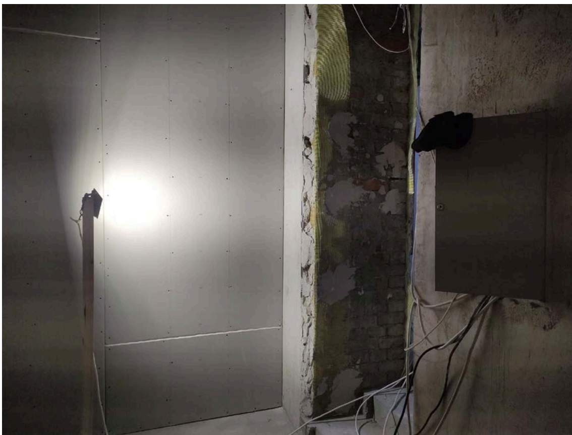
Фото 32. Интерьер квартиры № 118 объекта культурного наследия регионального значения «Дом, в котором жил с 1913 г. и умер в 1935 г. географ и путешественник П.К.Козлов (кв. 32)», ч.п. № 1
