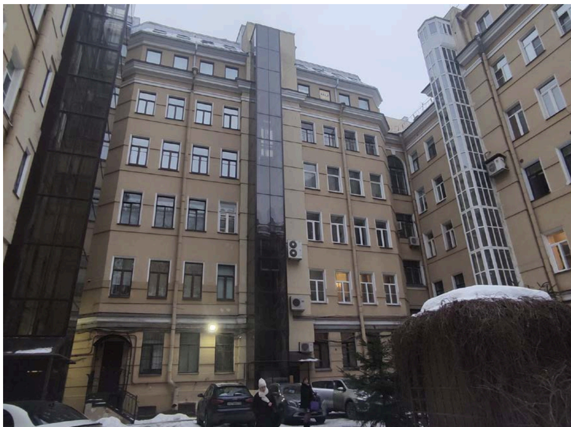
Фото 8. Фрагмент дворового фасада объекта культурного наследия регионального значения «Дом, в котором жил с 1913 г. и умер в 1935 г. географ и путешественник П.К.Козлов (кв. 32)»
