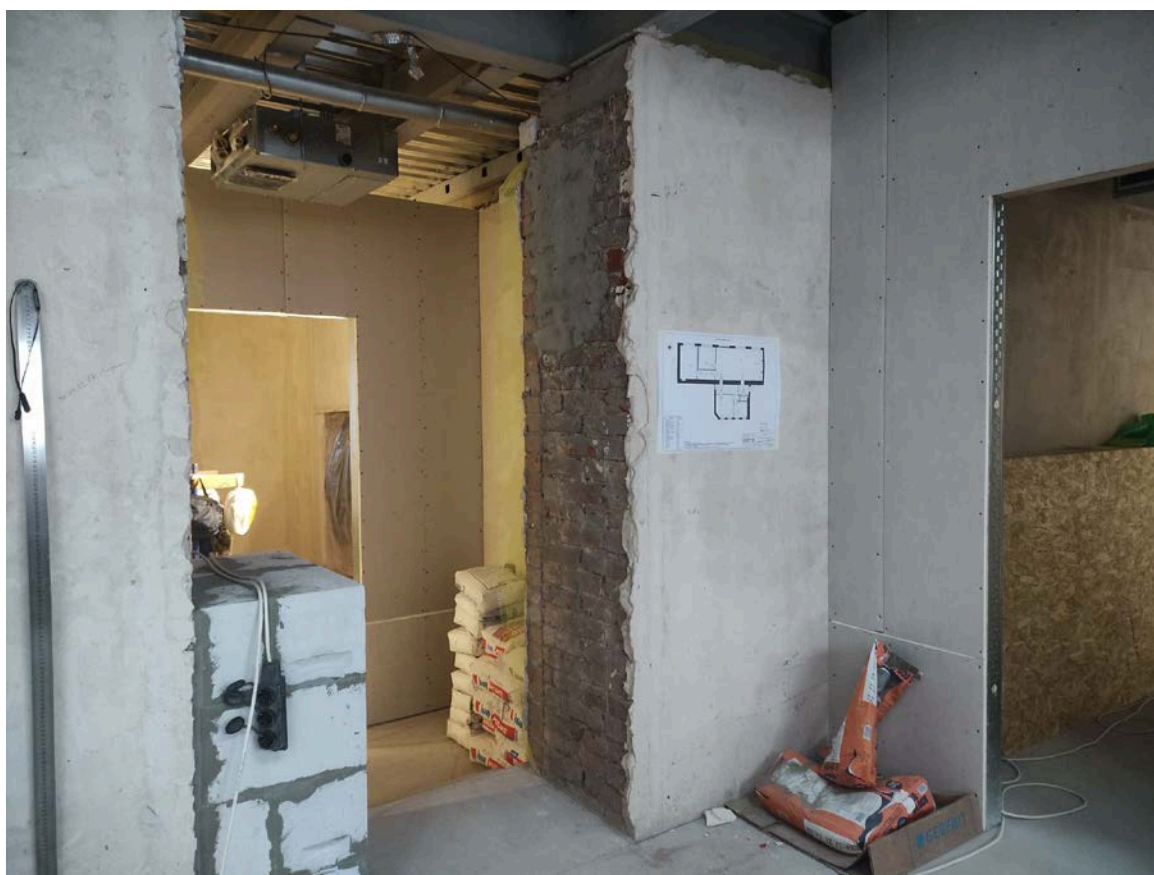
Фото 28. Интерьер квартиры № 118 объекта культурного наследия регионального значения «Дом, в котором жил с 1913 г. и умер в 1935 г. географ и путешественник П.К.Козлов (кв. 32)», ч.п. № 10
