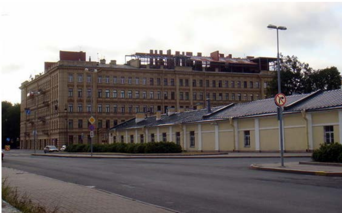
18. Надстройка жилого дома на Смольном проспекте, д. 6. Июль 2010 г. — Подле Смольного надстраивают жилой дом // Канонер – строительные новости Санкт-Петербурга [Электронный ресурс]. RL: http://kanoner.com/2010/07/27/16611 . – Дата публикации: 27/07/2010.
