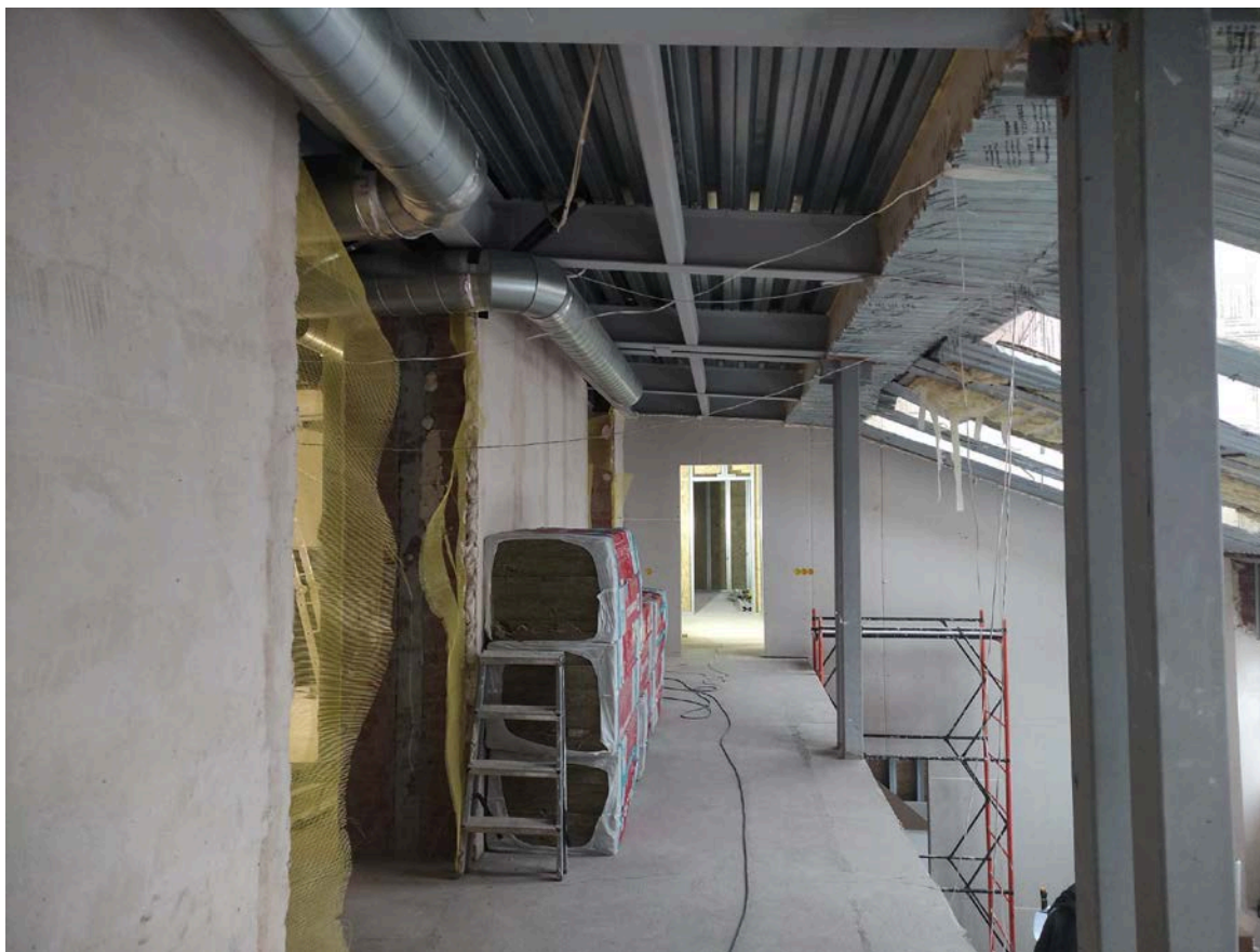
Фото 21. Интерьер квартиры № 118 объекта культурного наследия регионального значения «Дом, в котором жил с 1913 г. и умер в 1935 г. географ и путешественник П.К.Козлов (кв. 32)», ч.п. № 13
