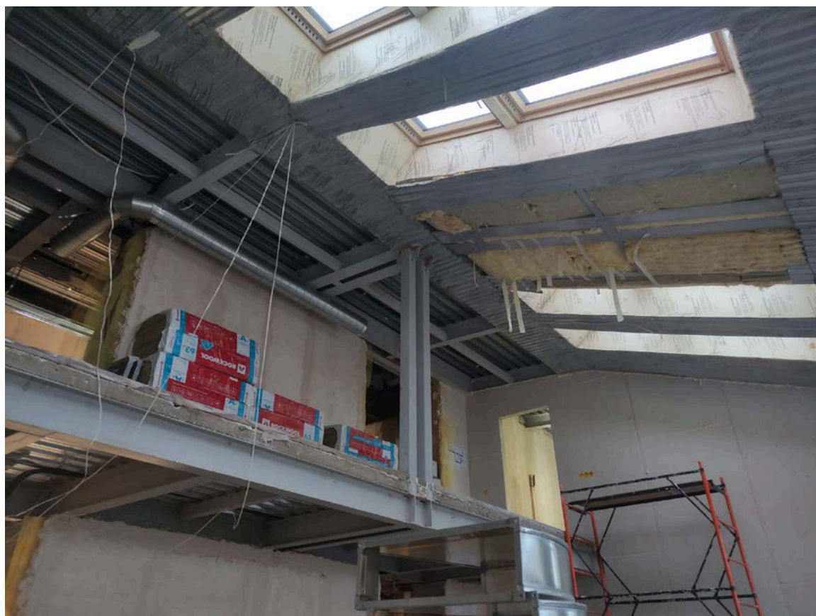
Фото 22. Интерьер квартиры № 118 объекта культурного наследия регионального значения «Дом, в котором жил с 1913 г. и умер в 1935 г. географ и путешественник П.К.Козлов (кв. 32)», ч.п. № 10
