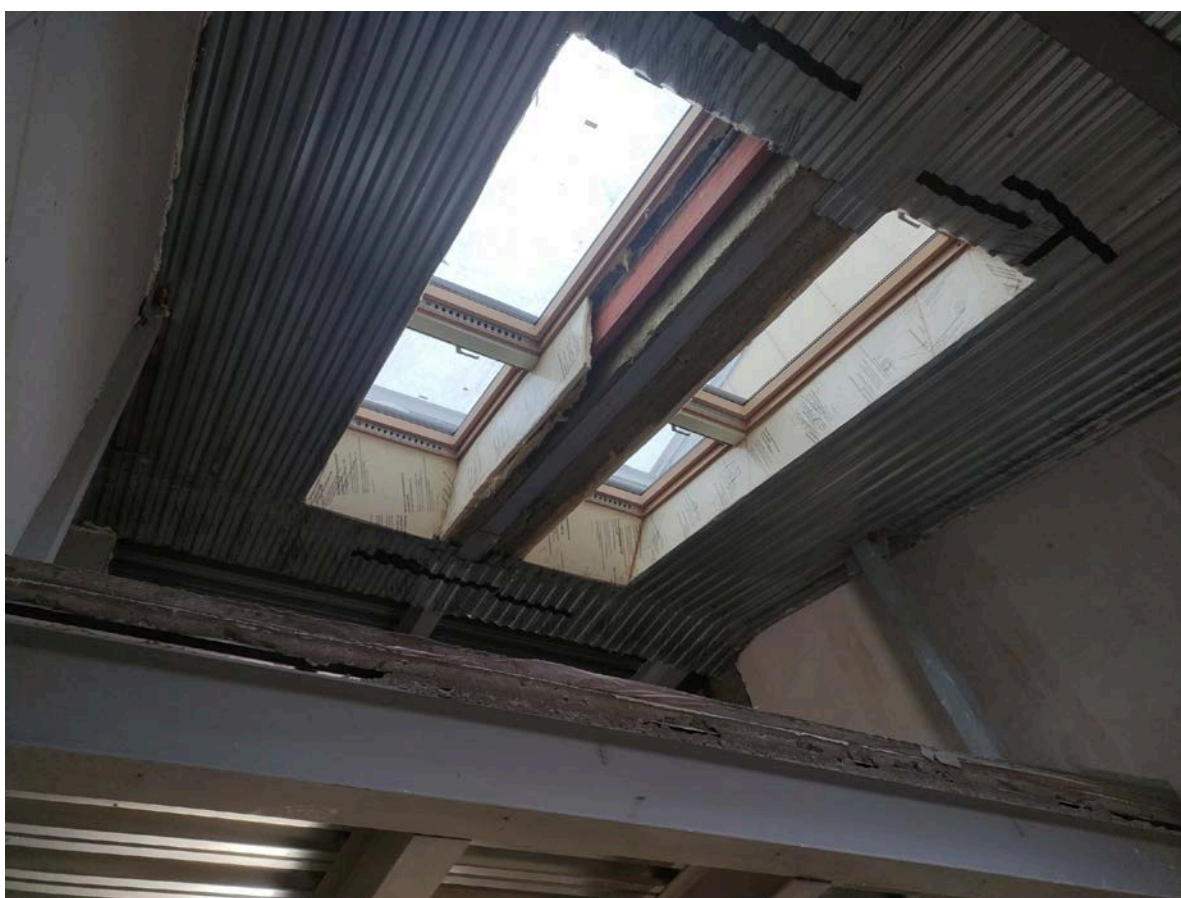
Фото 24. Интерьер квартиры № 118 объекта культурного наследия регионального значения «Дом, в котором жил с 1913 г. и умер в 1935 г. географ и путешественник П.К.Козлов (кв. 32)», ч.п. № 7
