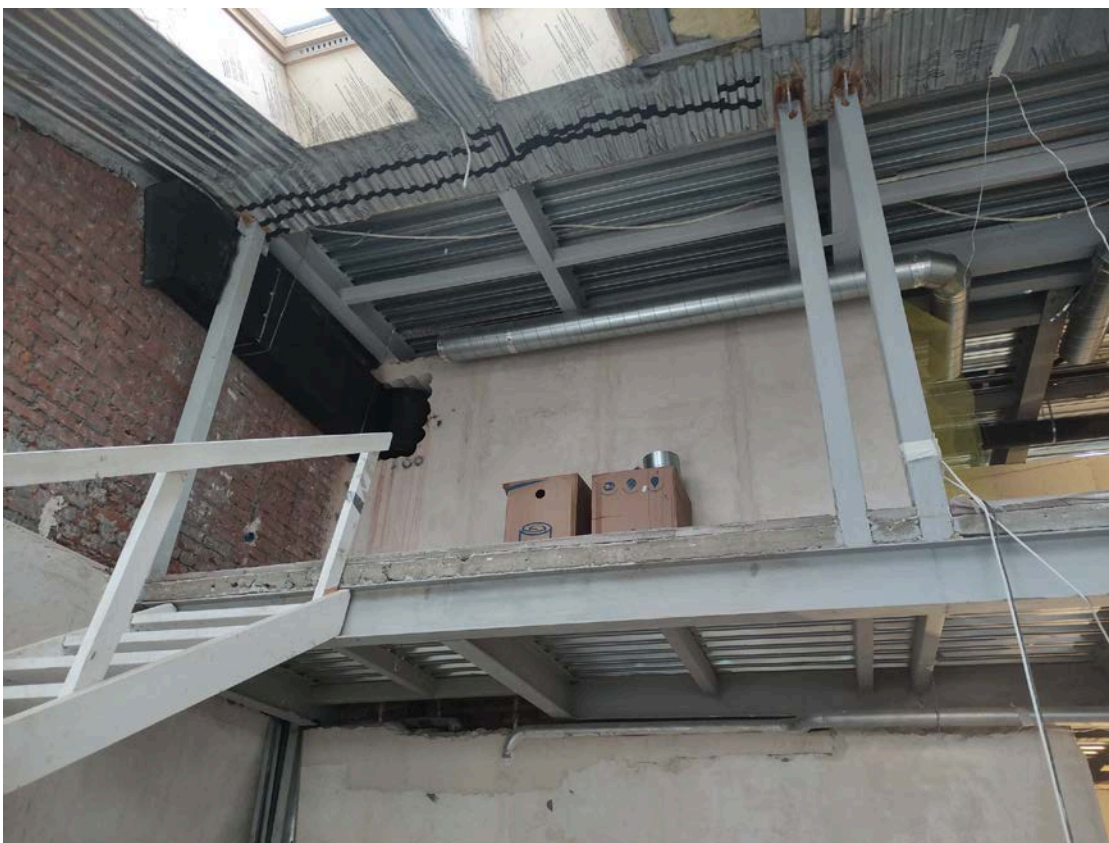
Фото 23. Интерьер квартиры № 118 объекта культурного наследия регионального значения «Дом, в котором жил с 1913 г. и умер в 1935 г. географ и путешественник П.К.Козлов (кв. 32)», ч.п. № 23
