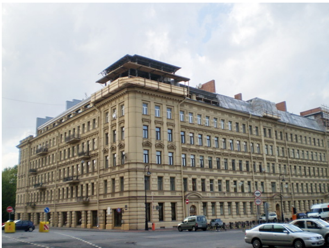
19. Дом № 6 по Смольному проспекту. Строительство мансарды. 2011 г. — Доходный дом Ведомства учреждений имп. Марии // Citywalls.ru – архитектурный сайт Петербурга [Электронный ресурс]. URL: https://www.citywalls.ru/house10282.html .
