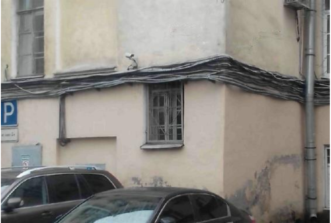
6. Корпус по Максимилиановскому переулку. Фрагмент дворового фасада. Штиглиц М.С. 06.05.2020
