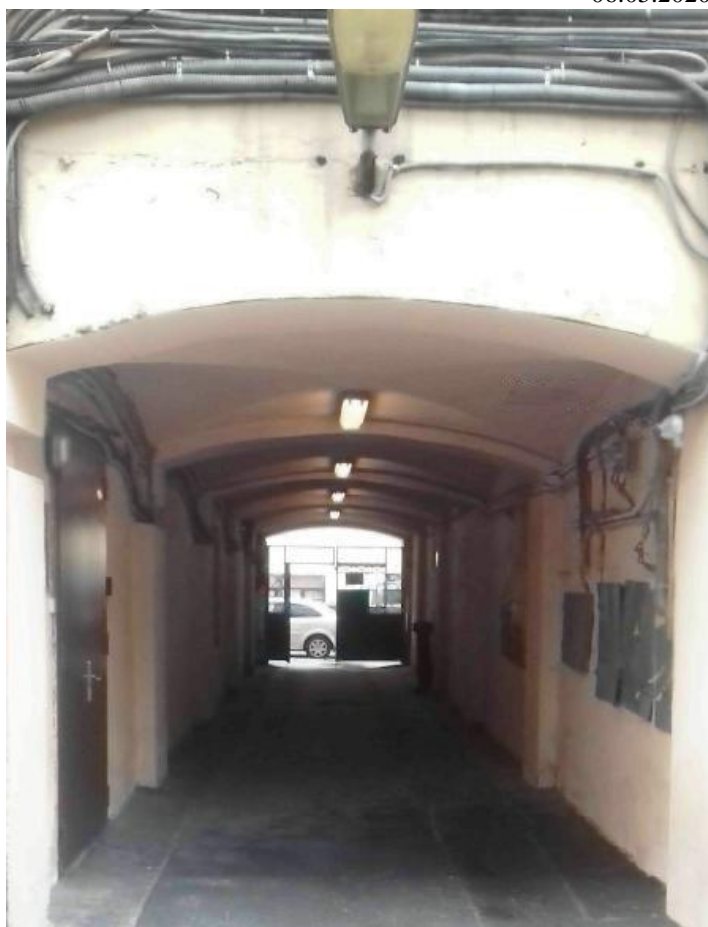
5. Корпус по Максимилиановскому переулку. Фрагмент дворового фасада. Штиглиц М.С. 06.05.2020
