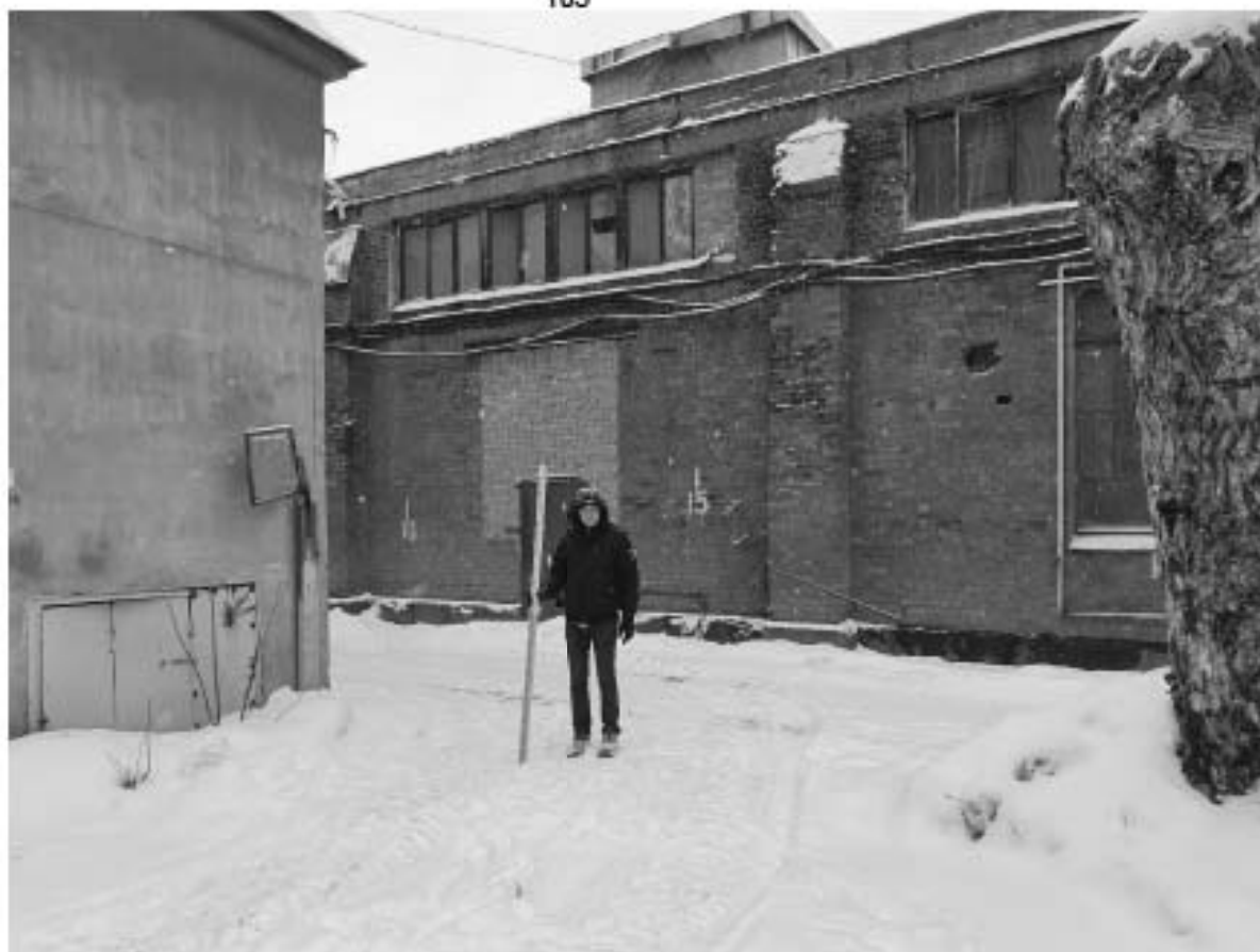
Рис. 39. СПб-2021. Петроградский район, Большая Посадская ул., д. 24/2 лит. С, лит. П. Шурф 2. Общий вид до начала работ. Вид с ЮВ
