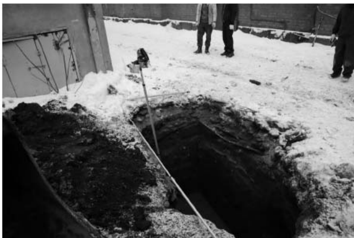
Рис. 40. СПб-2021. Петроградский район, Большая Посадская ул., д. 24/2 лит. С, лит. П. Шурф 2. Финальная фиксация по матернику. Общий вид. Вид с ЮВ
