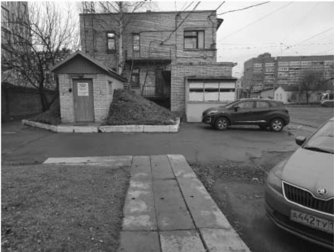
Рис. 18. СПб-2021. Петроградский район, Большая Посадская ул., д. 24/2 лит. С, лит. П. Общий вид участка обследования. Точка фотофиксации 1. Вид с юга
