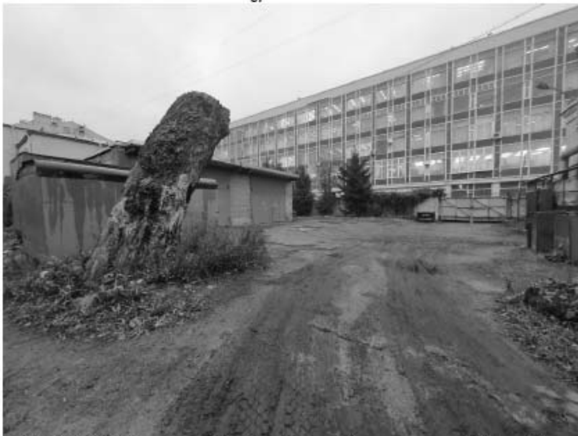
Рис. 24. СПб-2021. Петроградский район, Большая Посадская ул., д. 24/2 лит. С, лит. П. Общий вид участка обследования. Точка фотофиксации 7. Вид с востока
