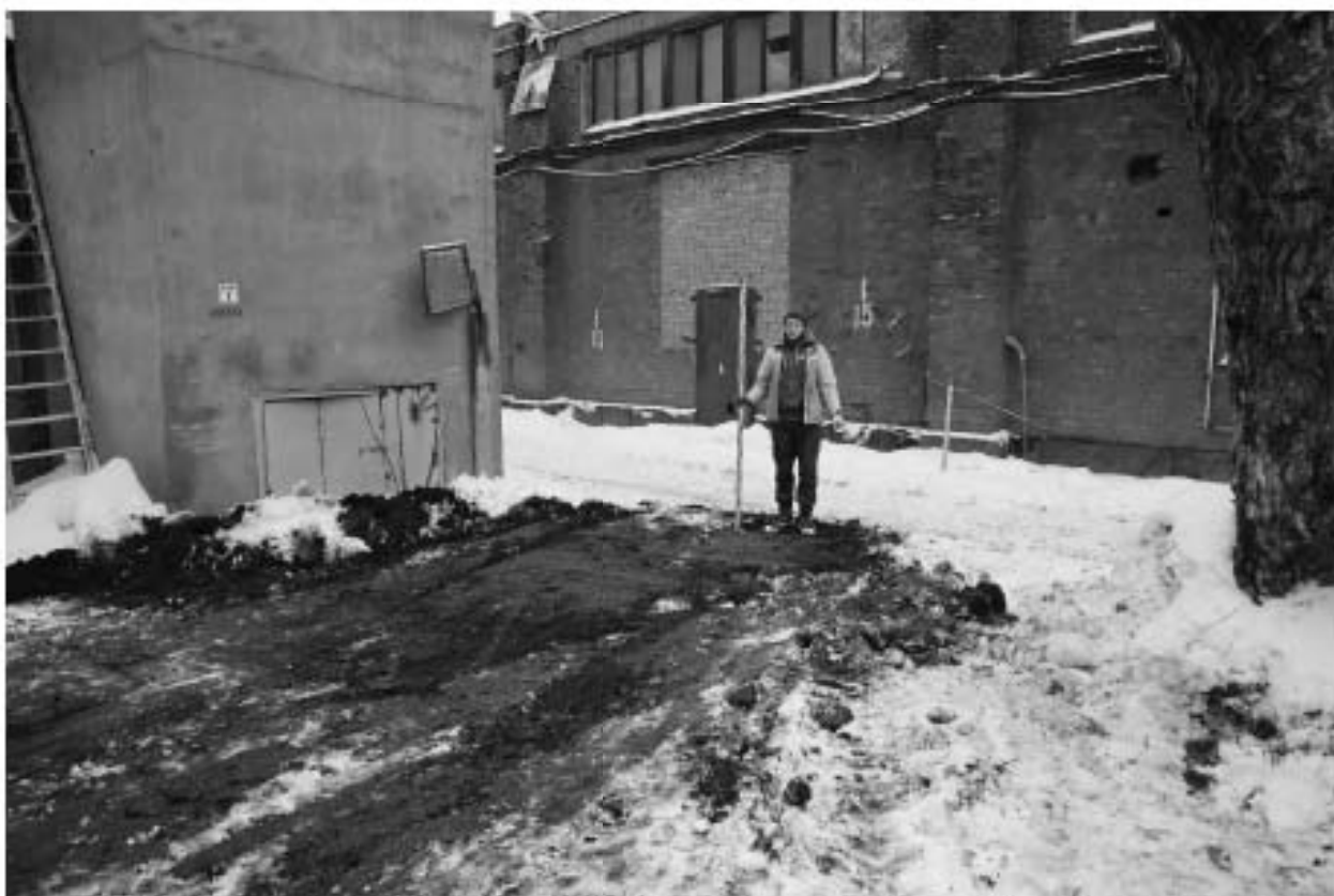
Рис. 46. СПб-2021. Петроградский район, Большая Посадская ул., д. 24/2 лит. С, лит. П. Шурф 2. Общий вид. Рекультивация. Вид с ЮВ
