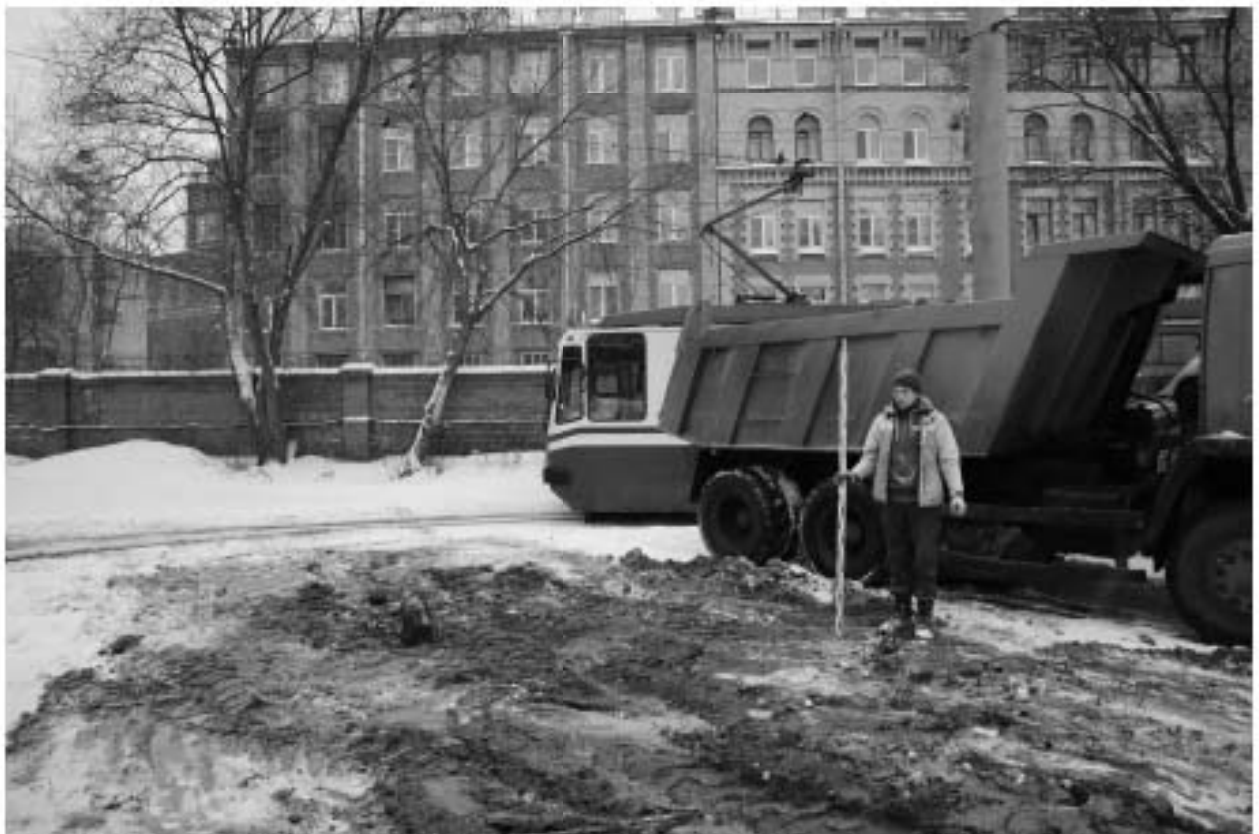
Рис. 37. СПб-2021. Петроградский район, Большая Посадская ул., д. 24/2 лит. С, лит. П. Шурф 1. Рекультивация. Вид с запада
