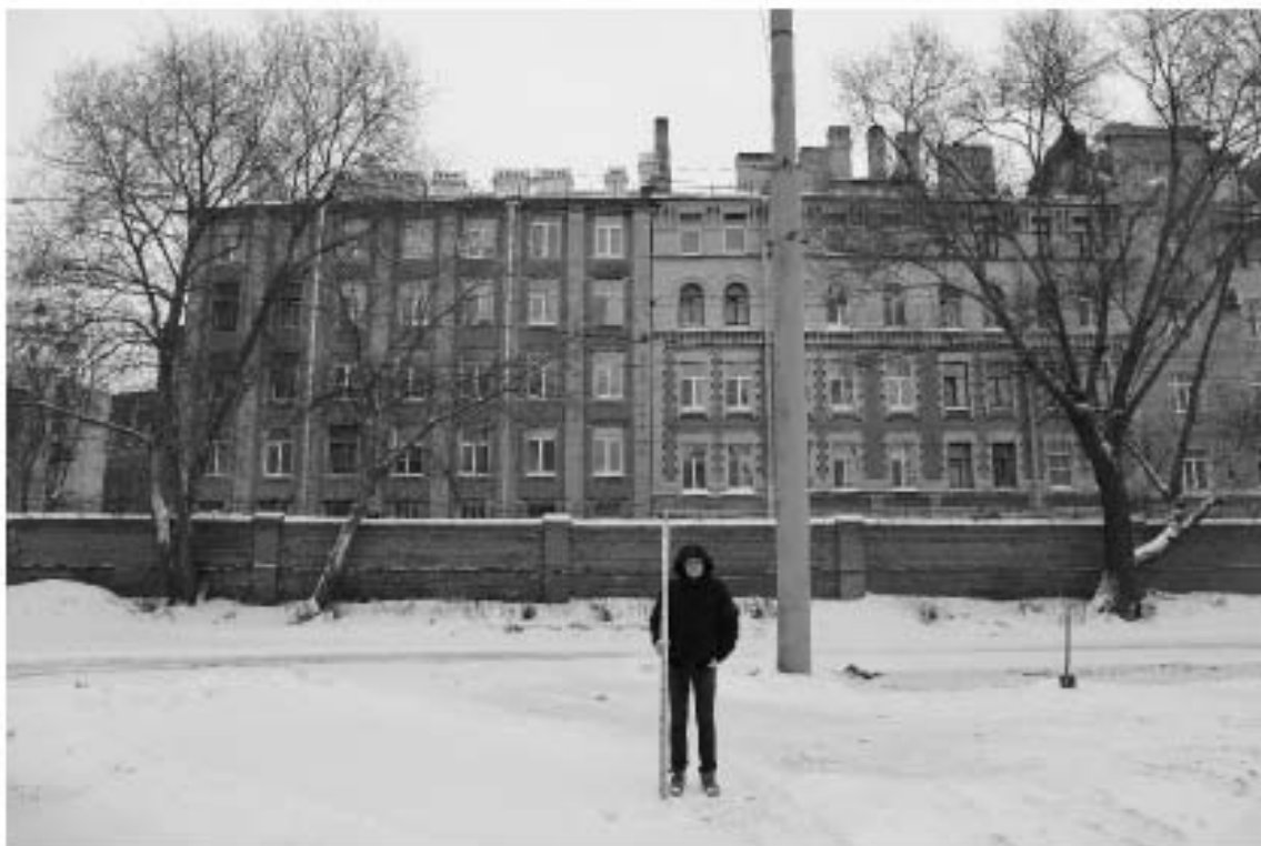
Рис. 25. СПб-2021. Петроградский район, Большая Посадская ул., д. 24/2 лит. С, лит. П. Шурф 1. Общий вид до начала работ. Вид с запада
