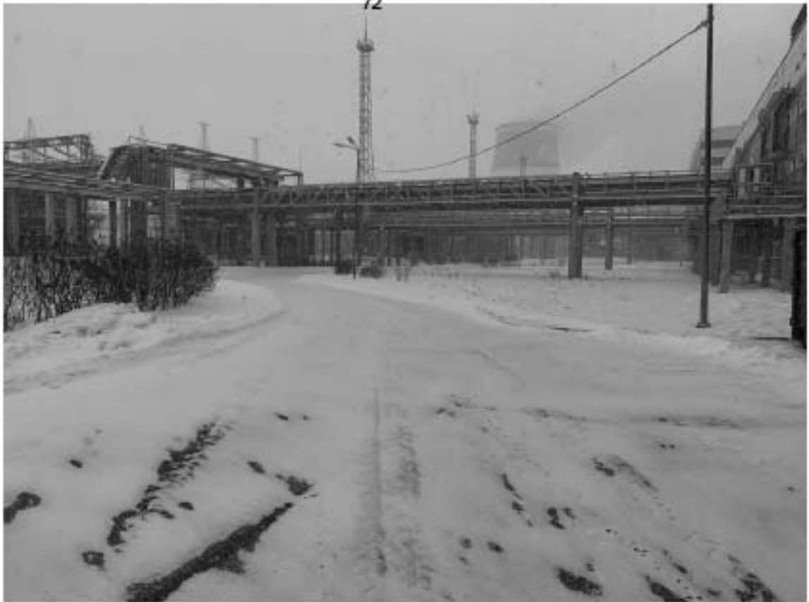
Рис. 10. Санкт-Петербург, Невский р-н, Октябрьская наб., д. 108. Точка съемки 1. Общий вид участка обследования. Вид с СЗ.
