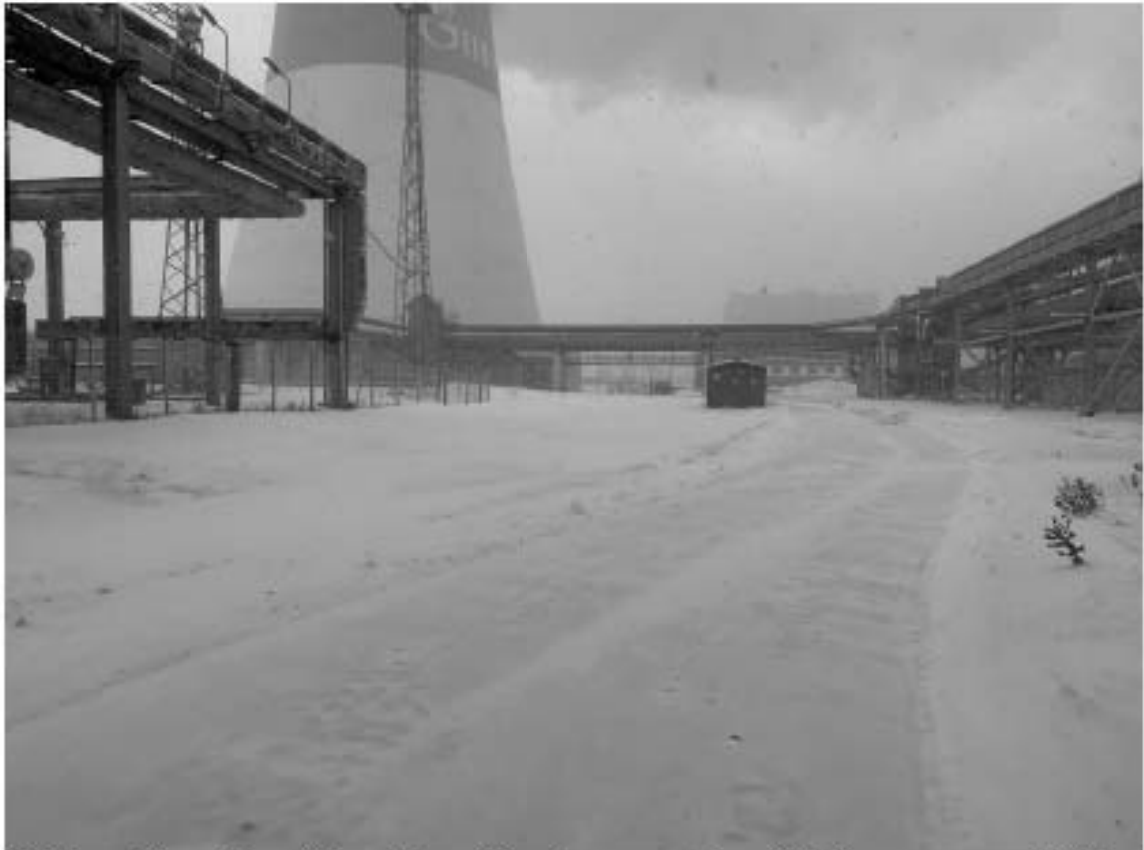
Рис. 12. Санкт-Петербург, Невский р-н, Октябрьская наб., д. 108. Точка съемки 3. Общий вид участка обследования. Вид с ССЗ.
