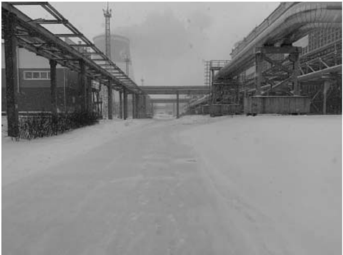
Рис. 11. Санкт-Петербург, Невский р-н, Октябрьская наб., д. 108. Точка съемки 2. Общий вид участка обследования. Вид с ССЗ.
