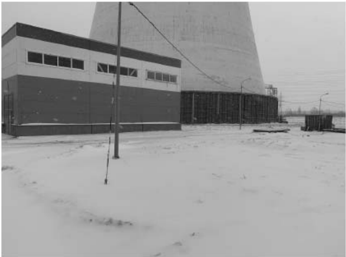
Рис. 13. Санкт-Петербург, Невский р-н, Октябрьская наб., д. 108. Точка съемки 4. Общий вид участка обследования. Вид с ЗСЗ.
