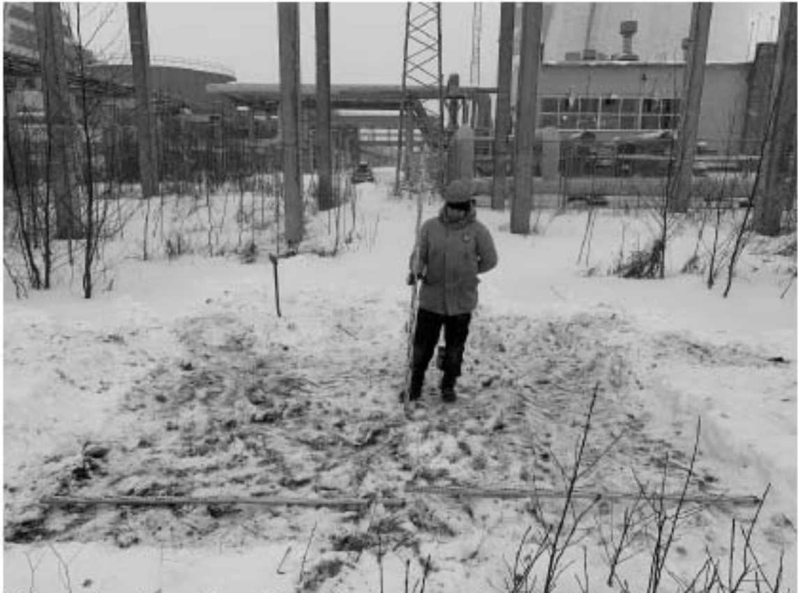
Рис. 16. Санкт-Петербург, Невский р-н, Октябрьская наб., д. 108. Месторасположение Шурфа 1. До начала работ. Вид с ЮЗ.
