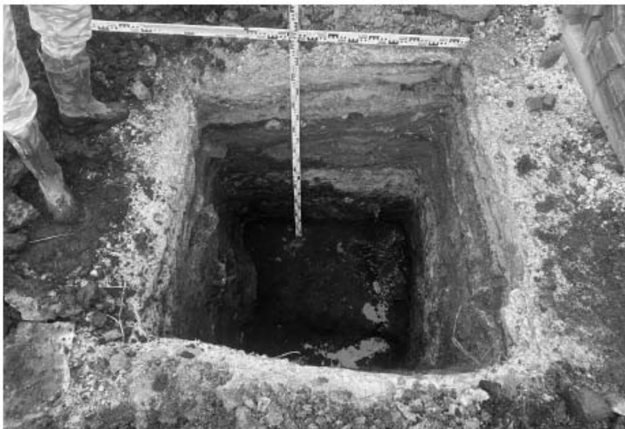
Илл. 36. г. Санкт-Петербург, Партизанская улица, дом 8, литера Е (кад.№ 78:11:0604302:1138). Шурф. Зачистка по основанию Пласта №3. Вид с юга.
