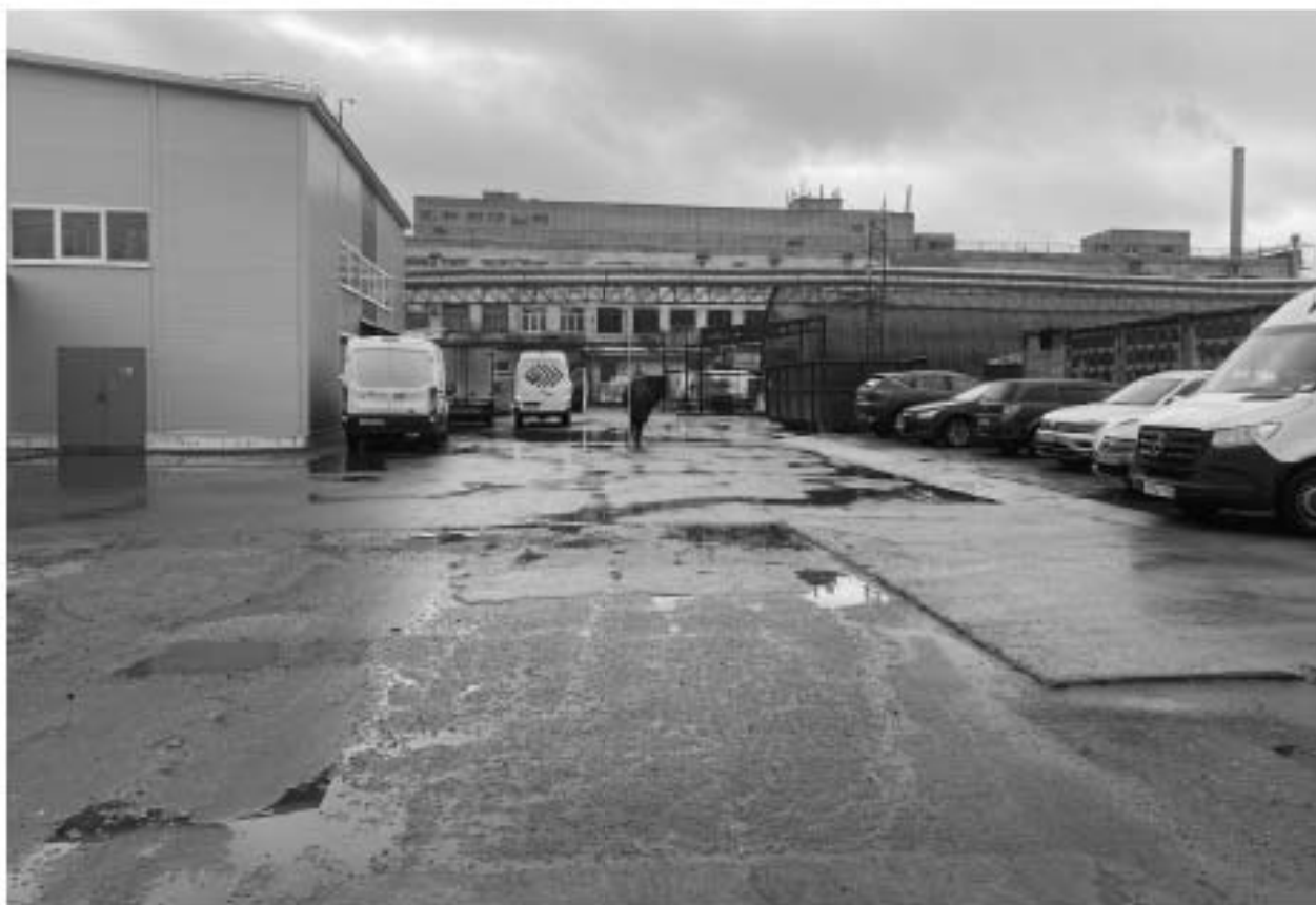
Илл. 20. г. Санкт-Петербург, Партизанская улица, дом 8, литера Е (кад.№ 78:11:0604302:1138). Точка фотофиксации №3. Общий вид восточной и южной частей обследованного участка. Вид с севера.
