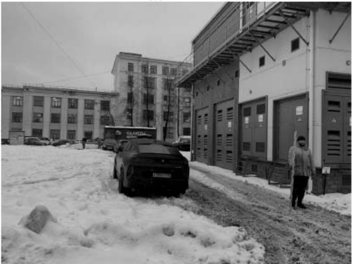
Рис. 32. Санкт-Петербург, Петроградский район, Пионерская ул., Гловская ул., Новолодожская ул. Точка съемки 2. Общий вид участка обследования. Вид с ССЗ.
