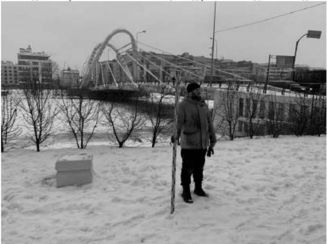
Рис. 53. Санкт-Петербург, Петроградский район, Пионерская ул., Гдовская ул., Новолодожская ул. Точка съемки 10. Общий вид участка обследования. Вид с ЮЮЗ.
