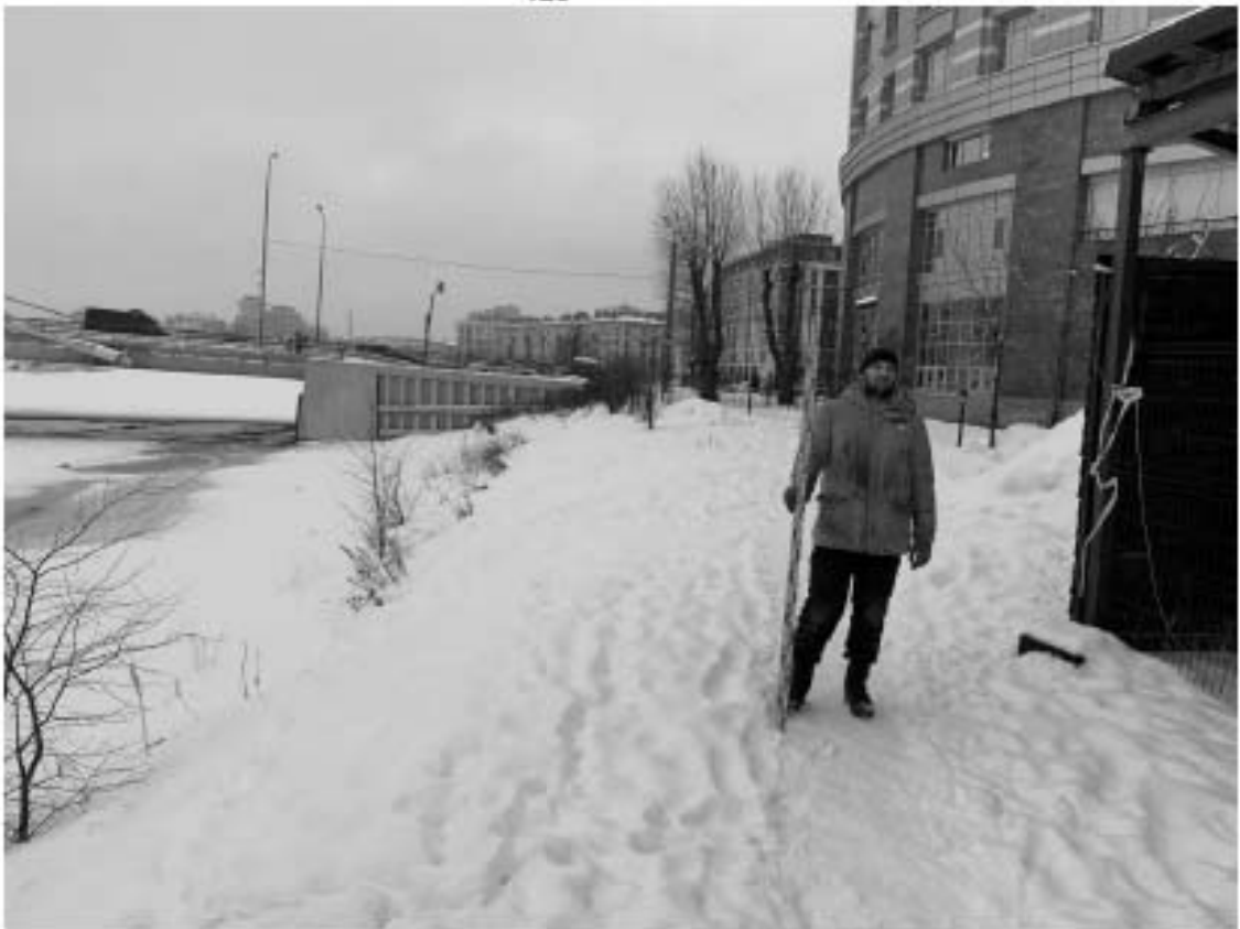
Рис. 56. Санкт-Петербург, Петроградский район, Пионерская ул., Гдовская ул., Новолодожская ул. Точка съемки 11. Общий вид участка обследования. Вид с З.
