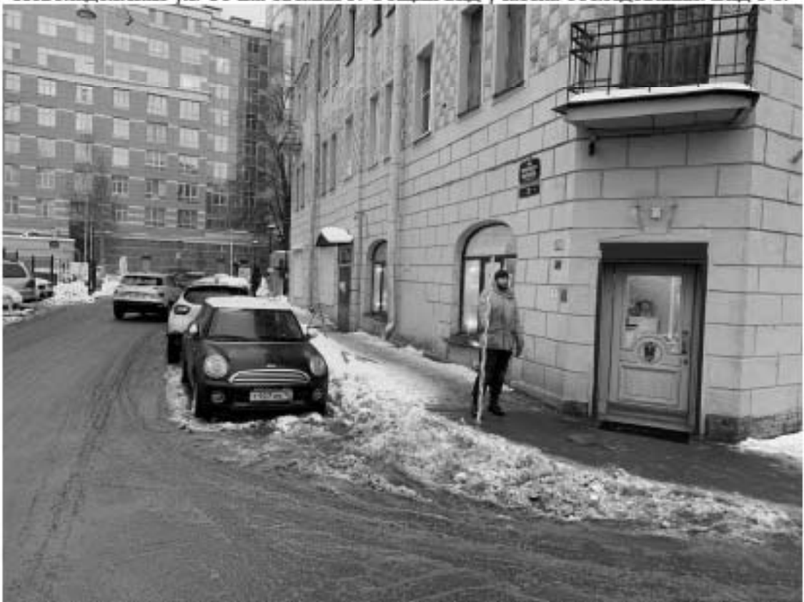
Рис. 35. Санкт-Петербург, Петроградский район, Пионерская ул., Гловская ул., Новоладожская ул. Точка съемки 3. Общий вид участка обследования. Вид с ЮЮВ.
