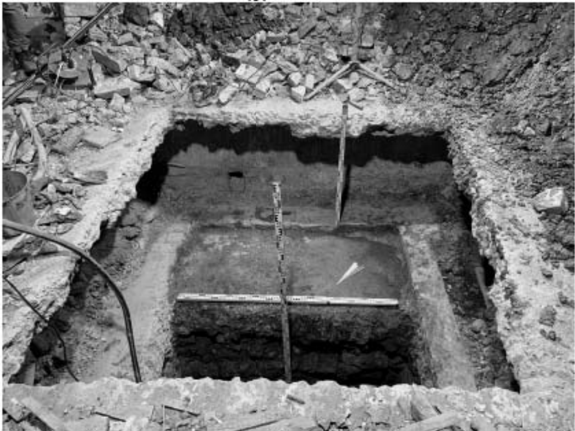
Рис. 70. Санкт-Петербург, Адмиралтейский район, Щепяной пер., д. 4-6, лит. А. Шурф 2. Финальная зачистка. Общий вид ЮВ стенки. Вид с СЗ.
