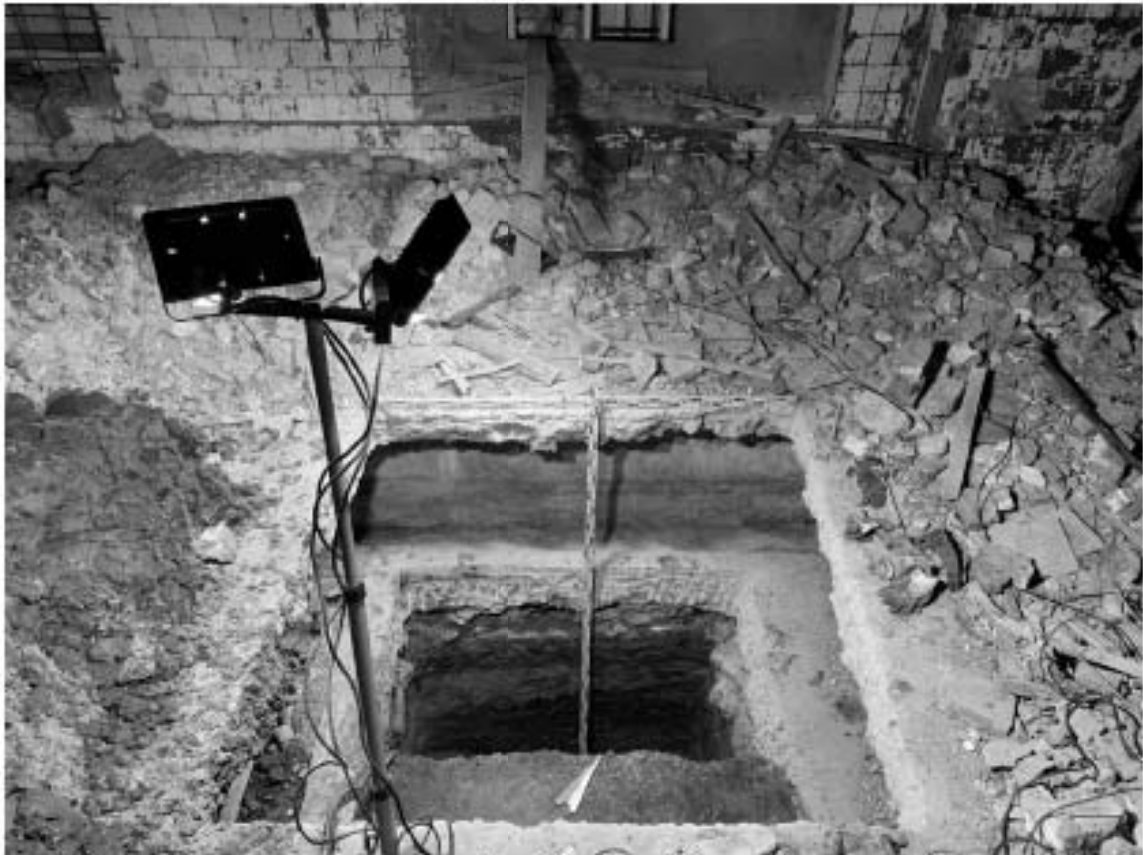
Рис. 64. Санкт-Петербург, Адмиралтейский район, Щепяной пер., д. 4-6, лит. А. Шурф 2. Финальная зачистка. Общий вид СЗ стенки. Вид с ЮВ.
