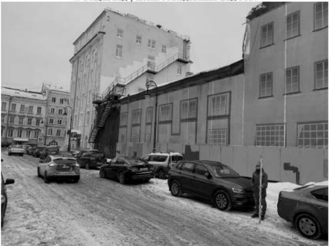
Рис. 18. Санкт-Петербург, Адмиралтейский район, Щепяной пер., д. 4-6, лит. А. Точка съемки 5. Общий вид участка обследования. Вид с ССЗ.
