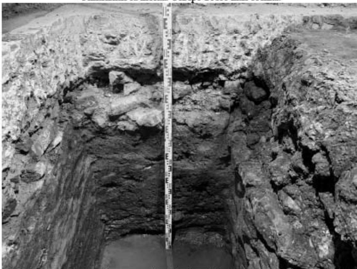
Рис. 69. Санкт-Петербург, Адмиралтейский район, Щепяной пер., д. 4-6, лит. А. Шурф 2. Финальная зачистка. Северо-восточная стенка. Нижняя часть.
