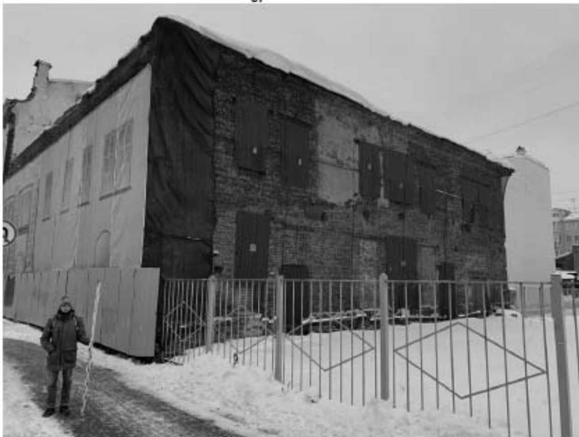
Рис. 21. Санкт-Петербург, Адмиралтейский район, Щепяной пер., д. 4-6, лит. А. Точка съемки 6. Общий вид участка обследования. Вид с ССЗ.
