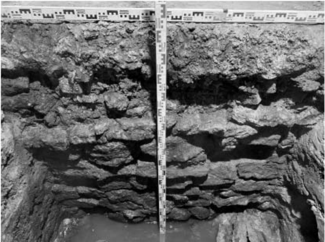
Рис. 72. Санкт-Петербург, Адмиралтейский район, Щепяной пер., д. 4-6, лит. А. Шурф 2. Финальная зачистка. Юго-восточная стенка. Нижняя часть. Выявленный фрагмент ленточного фундамента.
