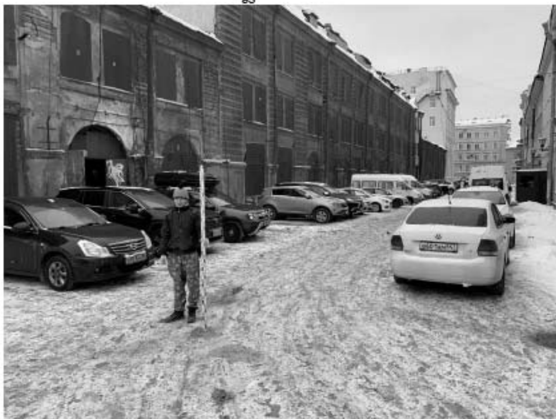
Рис. 13. Санкт-Петербург, Адмиралтейский район, Щепляной пер., д. 4-6, лит. А. Точка съемки 1. Общий вид участка обследования. Вид с Ю.
