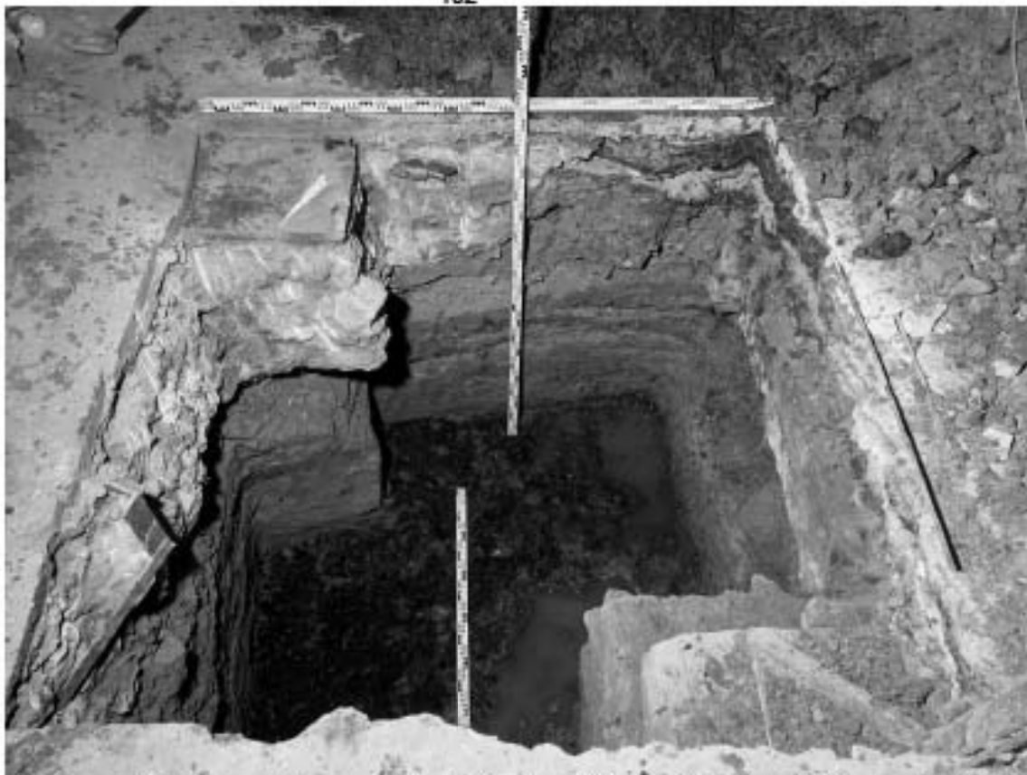
Рис. 27. Санкт-Петербург, Адмиралтейский район, Щепяной пер., д. 4-6, лит. А. Общий вид Шурфа 1. Промежуточная зачистка 2. Вид с СЗ.
