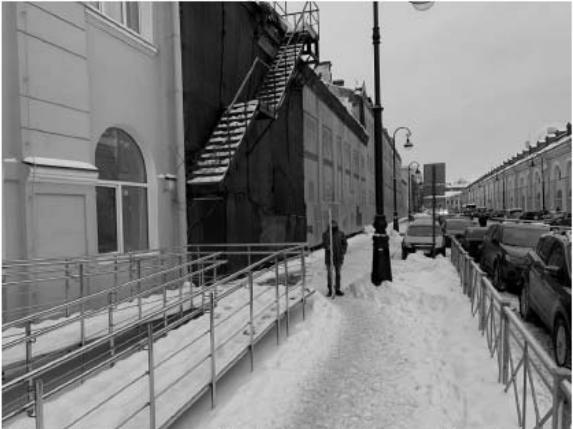
Рис. 17. Санкт-Петербург, Адмиралтейский район, Щепяной пер., д. 4-6, лит. А. Точка съемки 4. Общий вид участка обследования. Вид с Ю.
