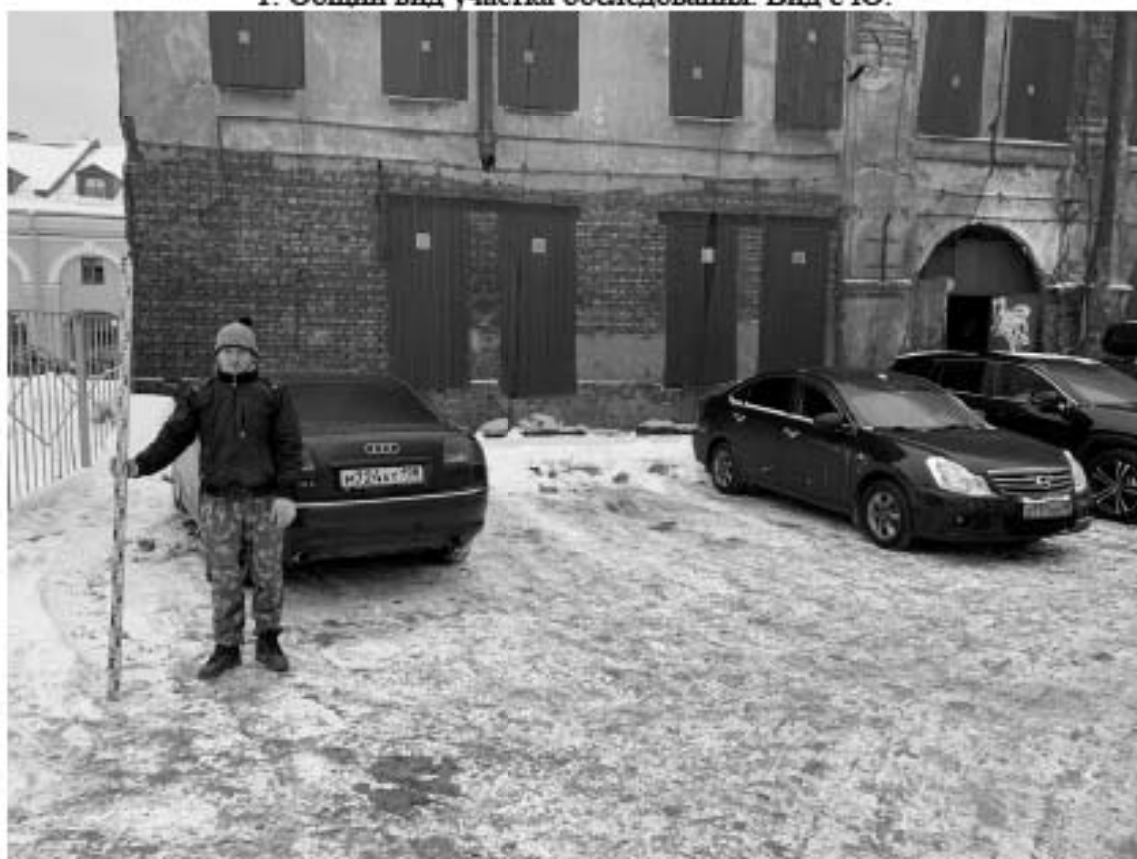
Рис. 12. Санкт-Петербург, Адмиралтейский район, Щепяной пер., д. 4-6, лит. А. Точка съемки 1. Общий вид участка обследования. Вид с Ю.
