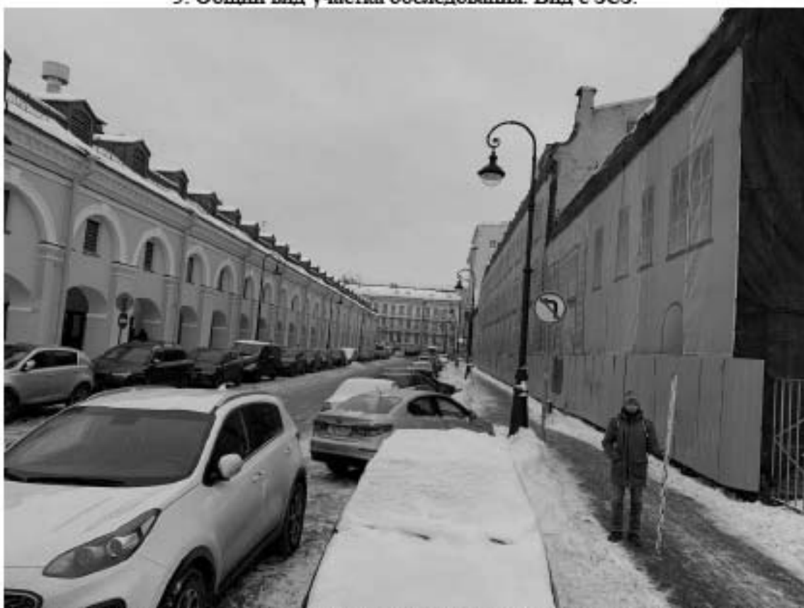
Рис. 20. Санкт-Петербург, Адмиралтейский район, Щепяной пер., д. 4-6, лит. А. Точка съемки 6. Общий вид участка обследования. Вид с СЗ.
