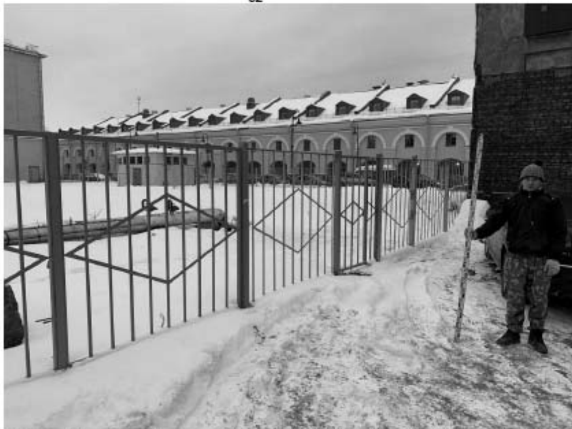
Рис. 11. Санкт-Петербург, Адмиралтейский район, Щепяной пер., д. 4-6, лит. А. Точка съемки 1. Общий вид участка обследования. Вид с Ю.
