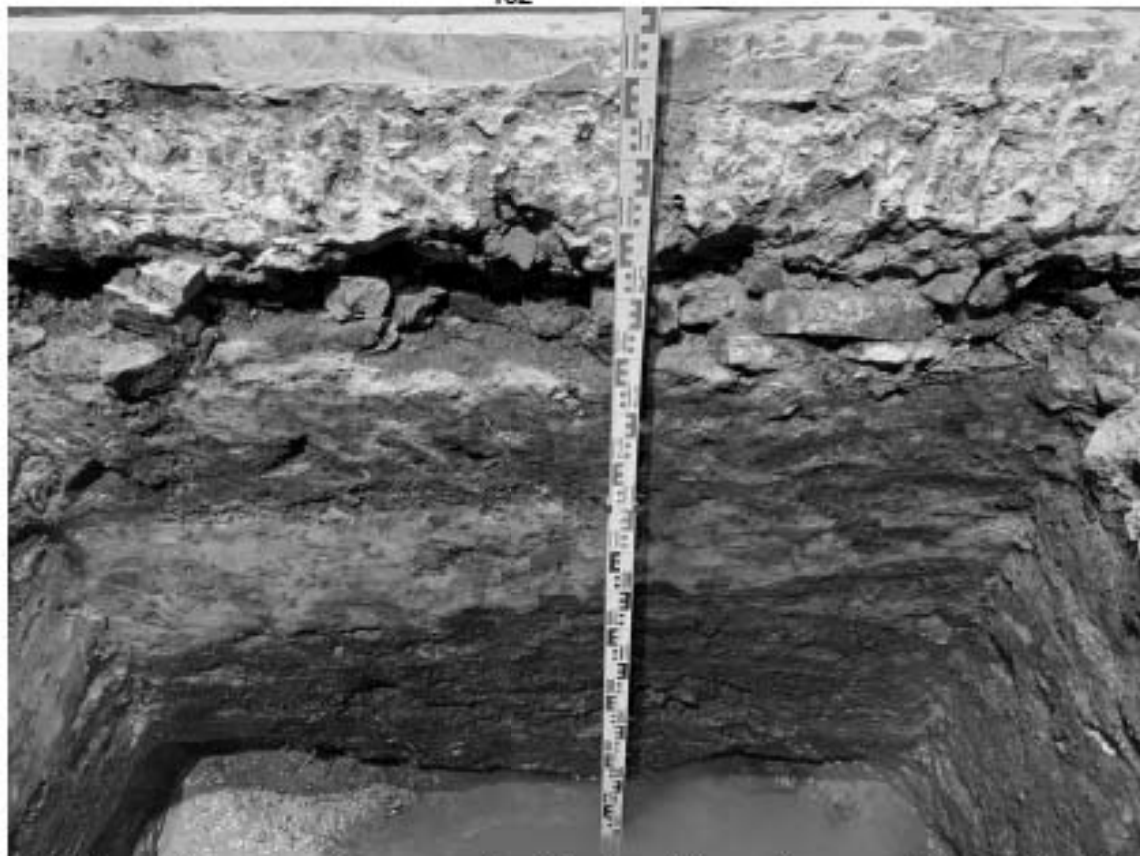
Рис. 66. Санкт-Петербург, Адмиралтейский район, Щепяной пер., д. 4-6, лит. А. Шурф 2. Финальная зачистка. Северо-западная стенка. Нижняя часть.
