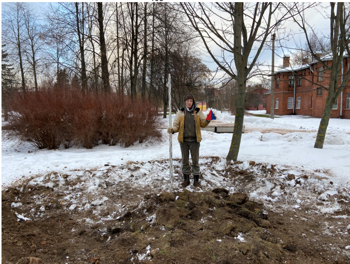
Рис. 49. Санкт-Петербург. Колпинский район. г. Колпино. Вид шурфа №1 после рекультивации. Вид на север
