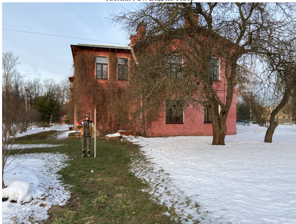
Рис. 26. Санкт-Петербург. Колпинский район. г. Колпино. Вид участка обследования. Точка съёмки №4. Вид на север
