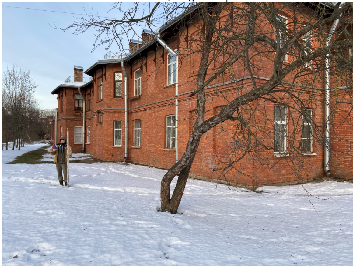
Рис. 30. Санкт-Петербург. Колпинский район. г. Колпино. Вид участка обследования. Точка съёмки №5. Вид на север
