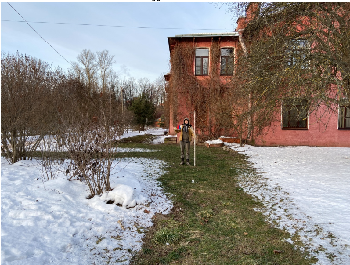
Рис. 25. Санкт-Петербург. Колпинский район. г. Колпино. Вид участка обследования. Точка съёмки №4. Вид на север
