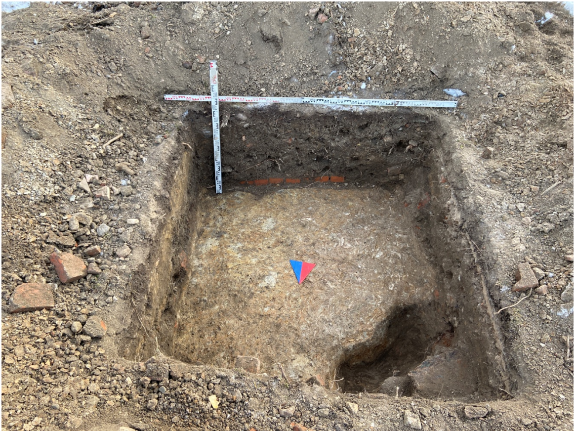
Рис. 55. Санкт-Петербург. Колпинский район. г. Колпино. Общий вид шурфа №2 на уровне материка. Вид на юг
