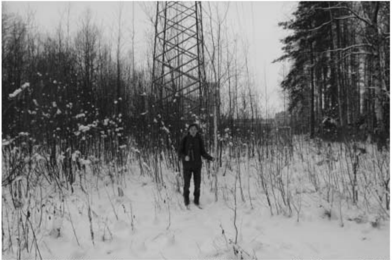
Рис. 22. ВЛ 220 кВ Ручьи–Полупроводники, КВЛ 220 кВ Парголово–Пр. Испытателей-2021. Точка фотофиксации 6, вид на север.
