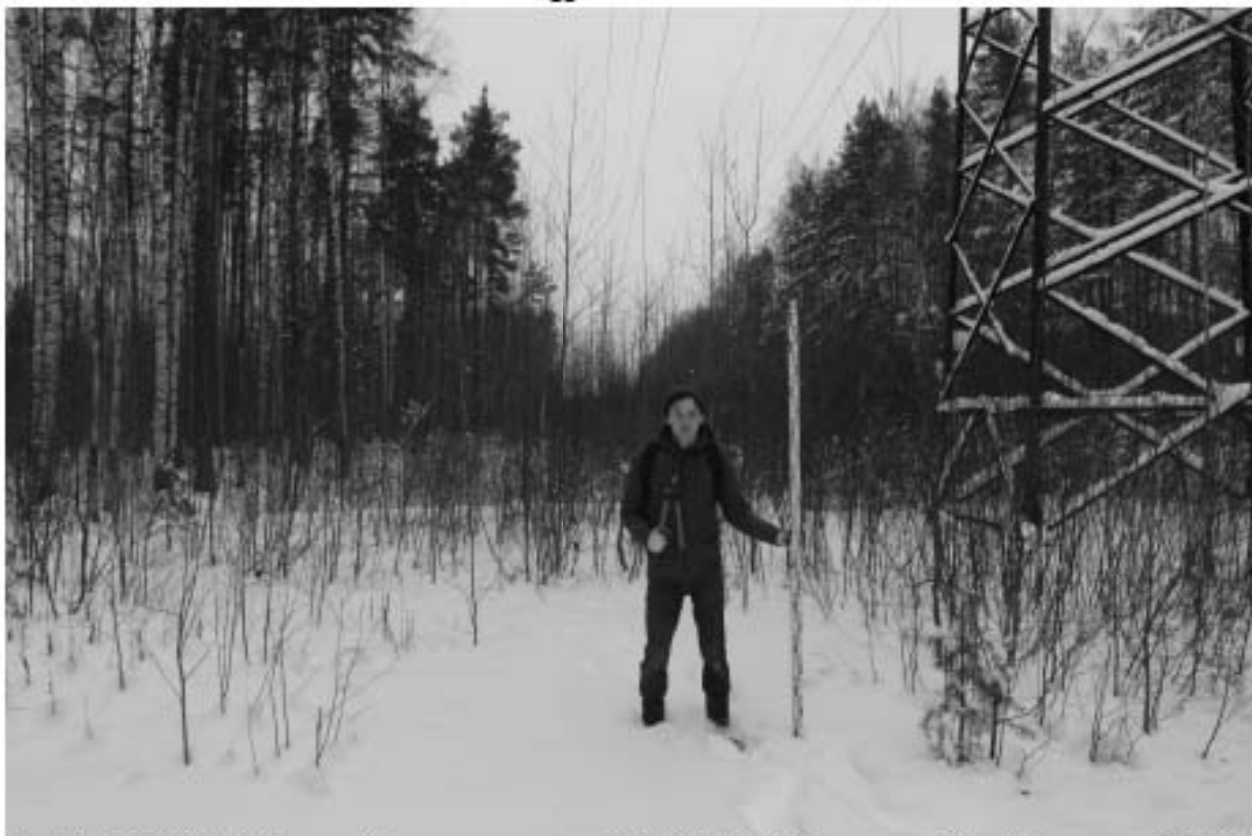
Рис. 19. ВЛ 220 кВ Ручьи–Полупроводники, КВЛ 220 кВ Парголово–Пр. Испытателей-2021. Точка фотофиксации 4, вид на север.
