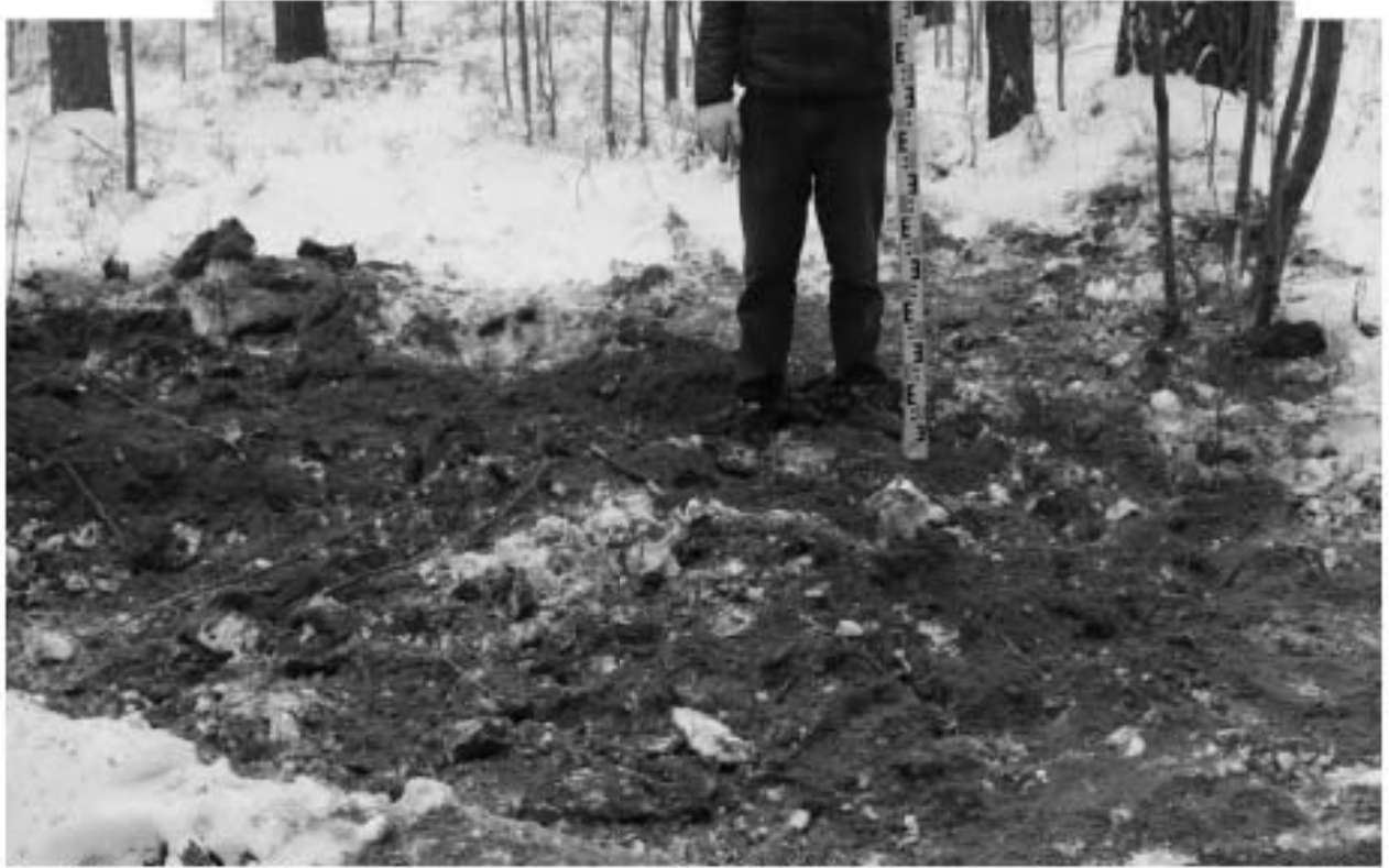
Рис. 60. ВЛ 220 кВ Ручьи–Полупроводники, КВЛ 220 кВ Парголово–Пр. Испытателей-2021. Шурф 3 после рекультивации, вид на север.
