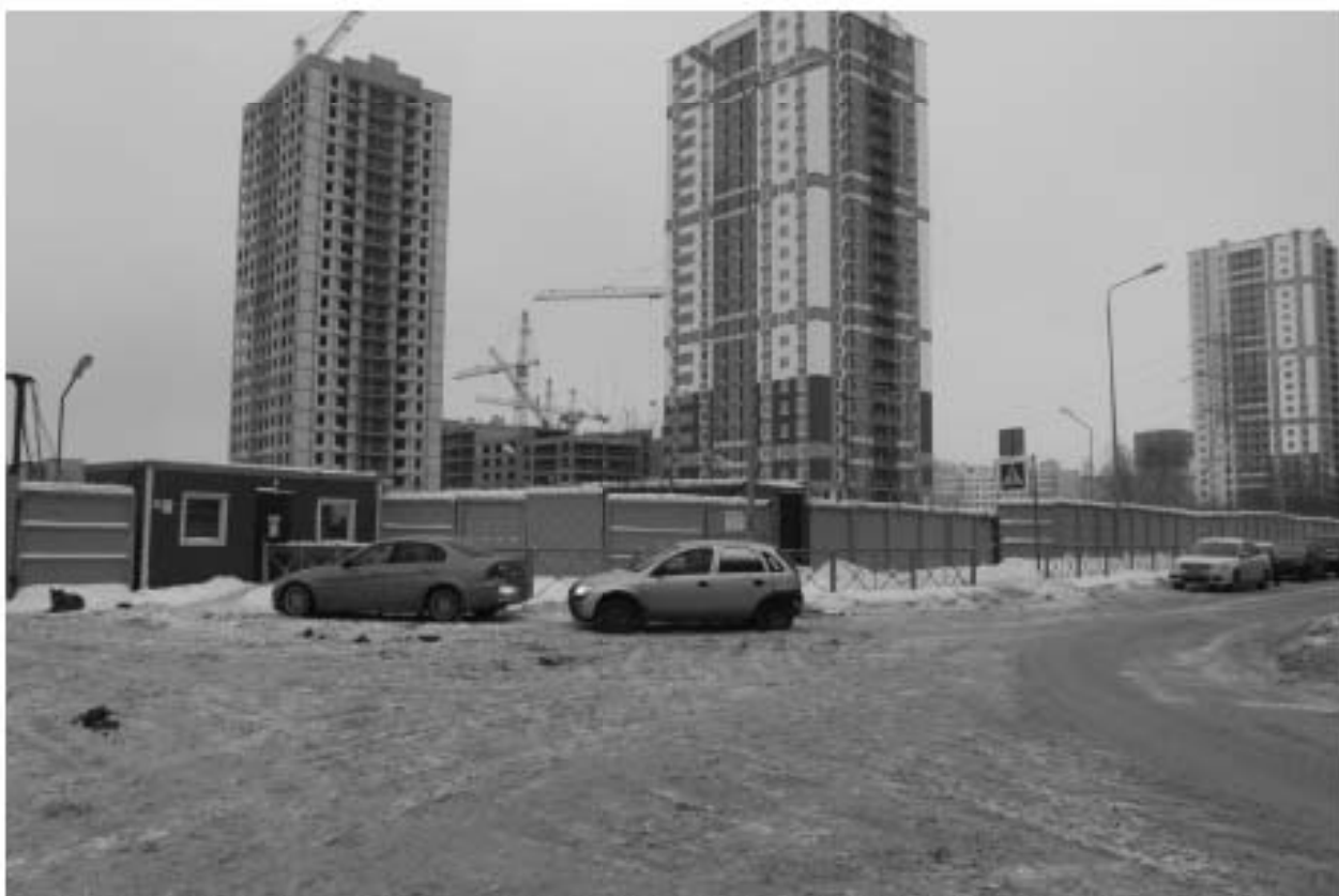
Рис. 37. ВЛ 220 кВ Ручьи–Полупроводники, КВЛ 220 кВ Парголово–Пр. Испытателей-2021. Точка фотофиксации 11, вид на юго-запад.
