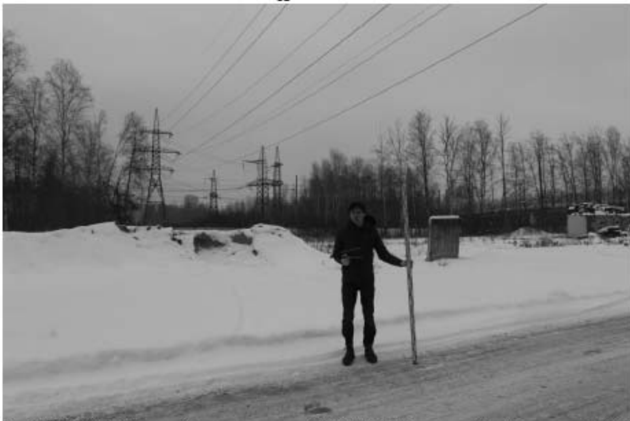
Рис. 32. ВЛ 220 кВ Ручьи–Полупроводники, КВЛ 220 кВ Парголово–Пр. Испытателей-2021. Точка фотофиксации 9, вид на восток.
