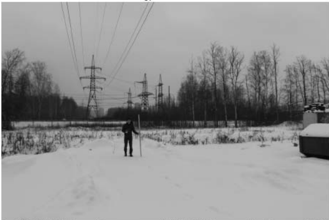
Рис. 34. ВЛ 220 кВ Ручьи–Полупроводники, КВЛ 220 кВ Парголово–Пр. Испытателей-2021. Точка фотофиксации 10, вид на восток.
