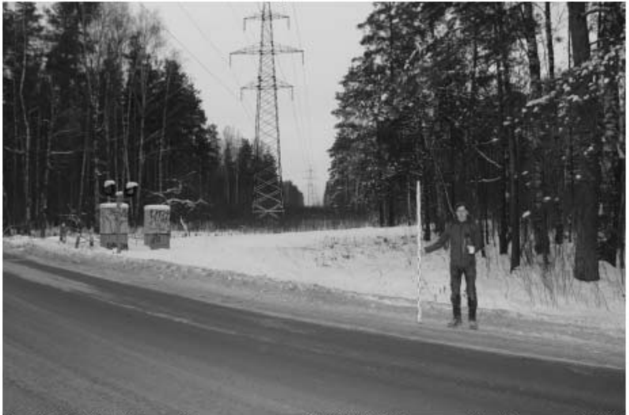
Рис. 13. ВЛ 220 кВ Ручьи–Полупроводники, КВЛ 220 кВ Парголово–Пр. Испытателей-2021. Точка фотофиксации 1, вид на север.
