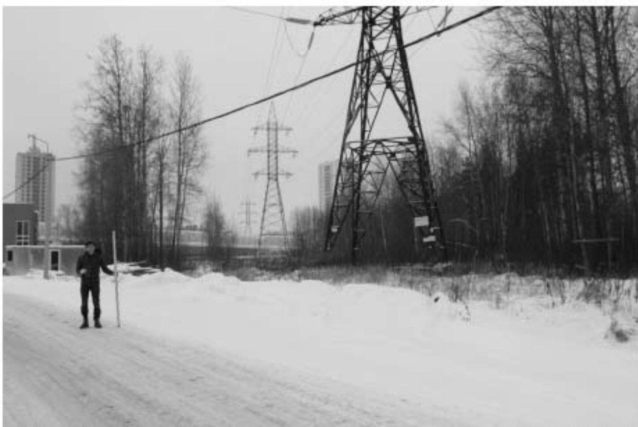
Рис. 31. ВЛ 220 кВ Ручьи–Полупроводники, КВЛ 220 кВ Парголово–Пр. Испытателей-2021. Точка фотофиксации 9, вид на юго-запад.
