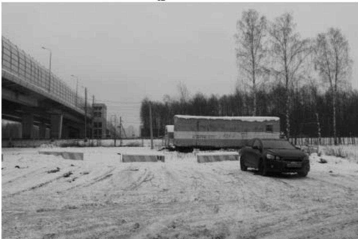
Рис. 36. ВЛ 220 кВ Ручьи–Полупроводники, КВЛ 220 кВ Парголово–Пр. Испытателей-2021. Точка фотофиксации 11, вид на северо-восток.
