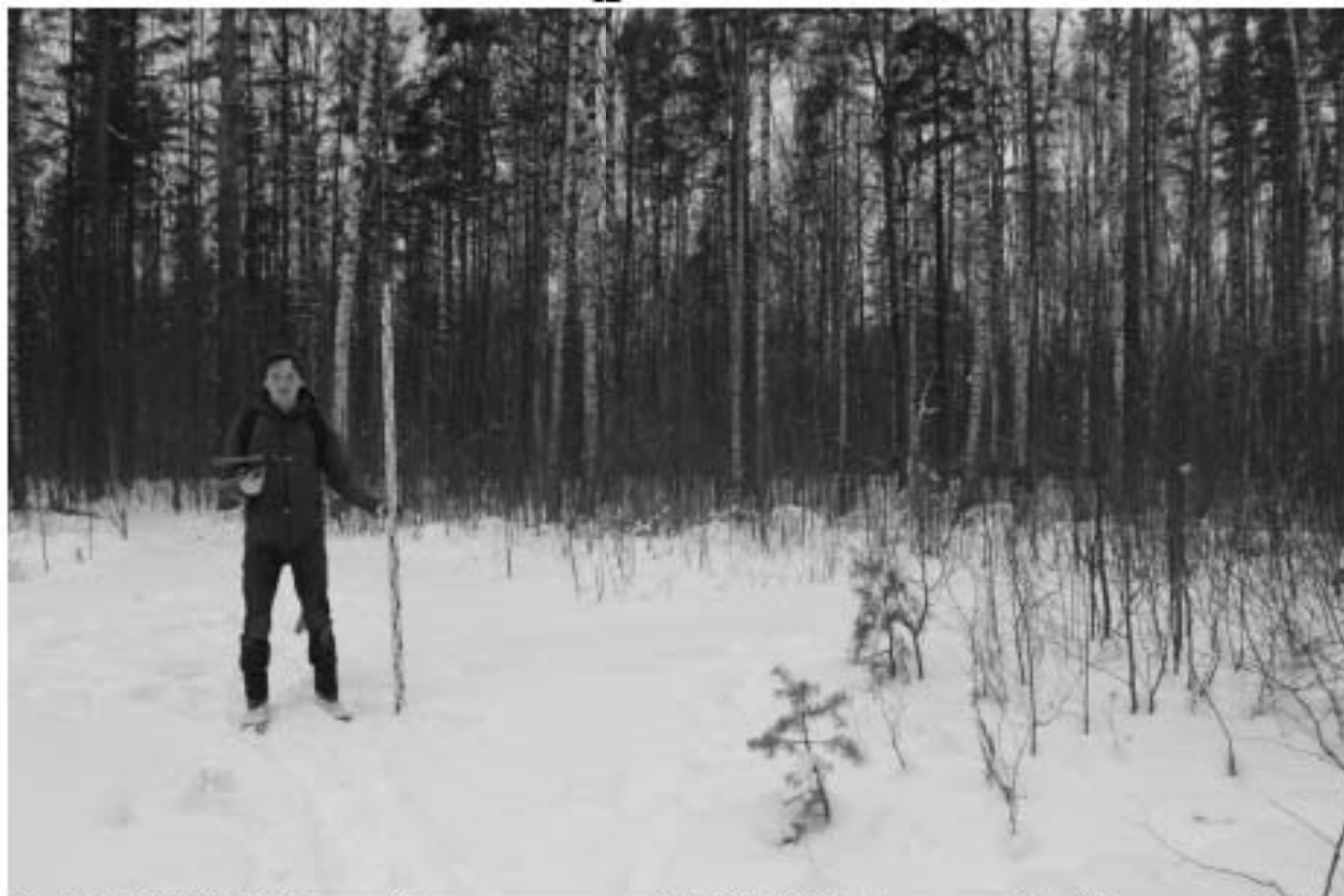
Рис. 17. ВЛ 220 кВ Ручьи–Полупроводники, КВЛ 220 кВ Парголово–Пр. Испытателей-2021. Точка фотофиксации 3, вид на запад.
