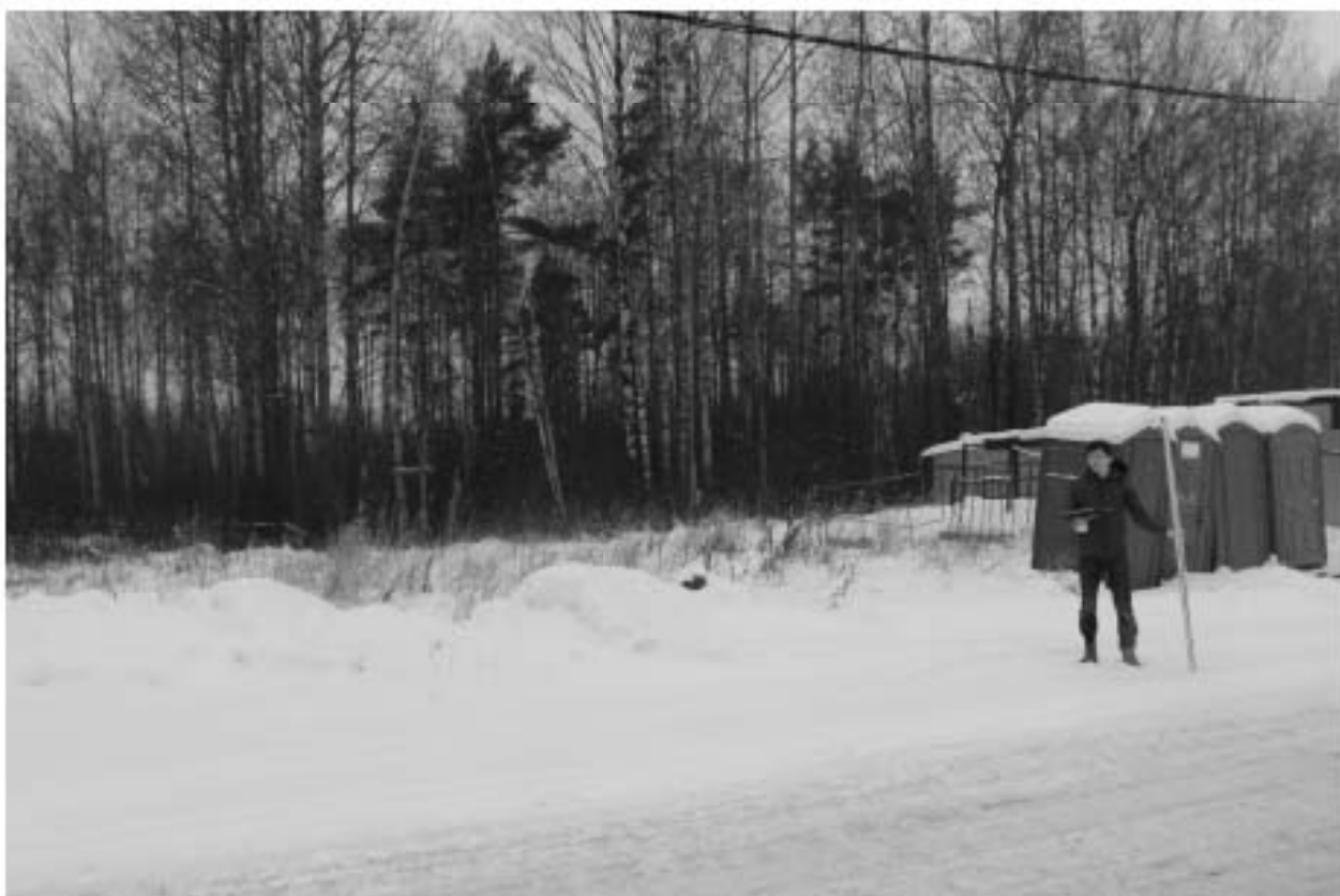
Рис. 33. ВЛ 220 кВ Ручьи–Полупроводники, КВЛ 220 кВ Парголово–Пр. Испытателей-2021. Точка фотофиксации 9, вид на запад.
