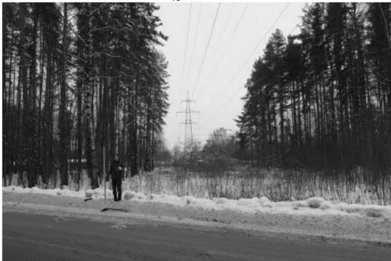
Рис. 11. ВЛ 220 кВ Ручьи–Полупроводники, КВЛ 220 кВ Парголово–Пр. Испытателей-2021. Точка фотофиксации 1, вид на юг.
