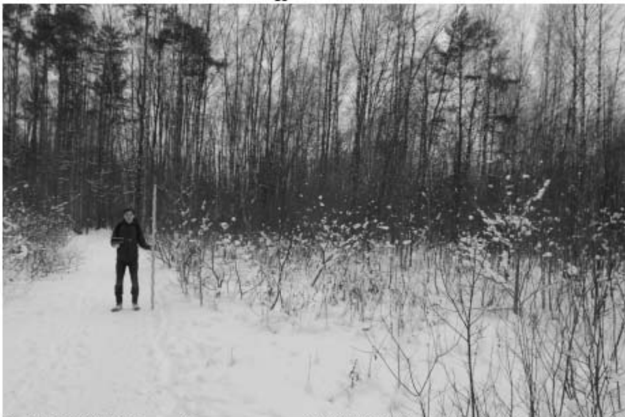
Рис. 24. ВЛ 220 кВ Ручьи–Полупроводники, КВЛ 220 кВ Парголово–Пр. Испытателей-2021. Точка фотофиксации 6, вид на запад.
