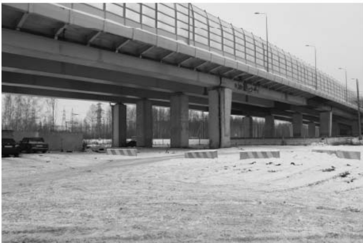
Рис. 35. ВЛ 220 кВ Ручьи–Полупроводники, КВЛ 220 кВ Парголово–Пр. Испытателей-2021. Точка фотофиксации 11, вид на запад.
