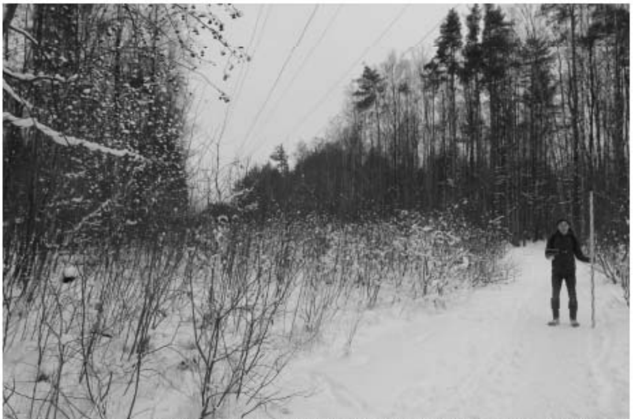
Рис. 23. ВЛ 220 кВ Ручьи–Полупроводники, КВЛ 220 кВ Парголово–Пр. Испытателей-2021. Точка фотофиксации 6, вид на юго-запад.
