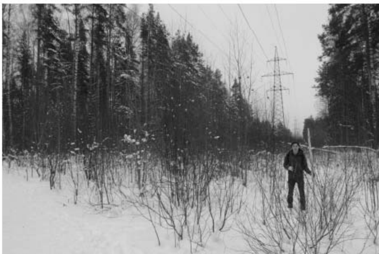
Рис. 18. ВЛ 220 кВ Ручьи–Полупроводники, КВЛ 220 кВ Парголово–Пр. Испытателей-2021. Точка фотофиксации 4, вид на юг.
