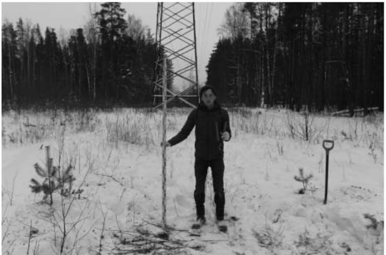
Рис. 14. ВЛ 220 кВ Ручьи–Полупроводники, КВЛ 220 кВ Парголово–Пр. Испытателей-2021. Точка фотофиксации 2, вид на юг.
