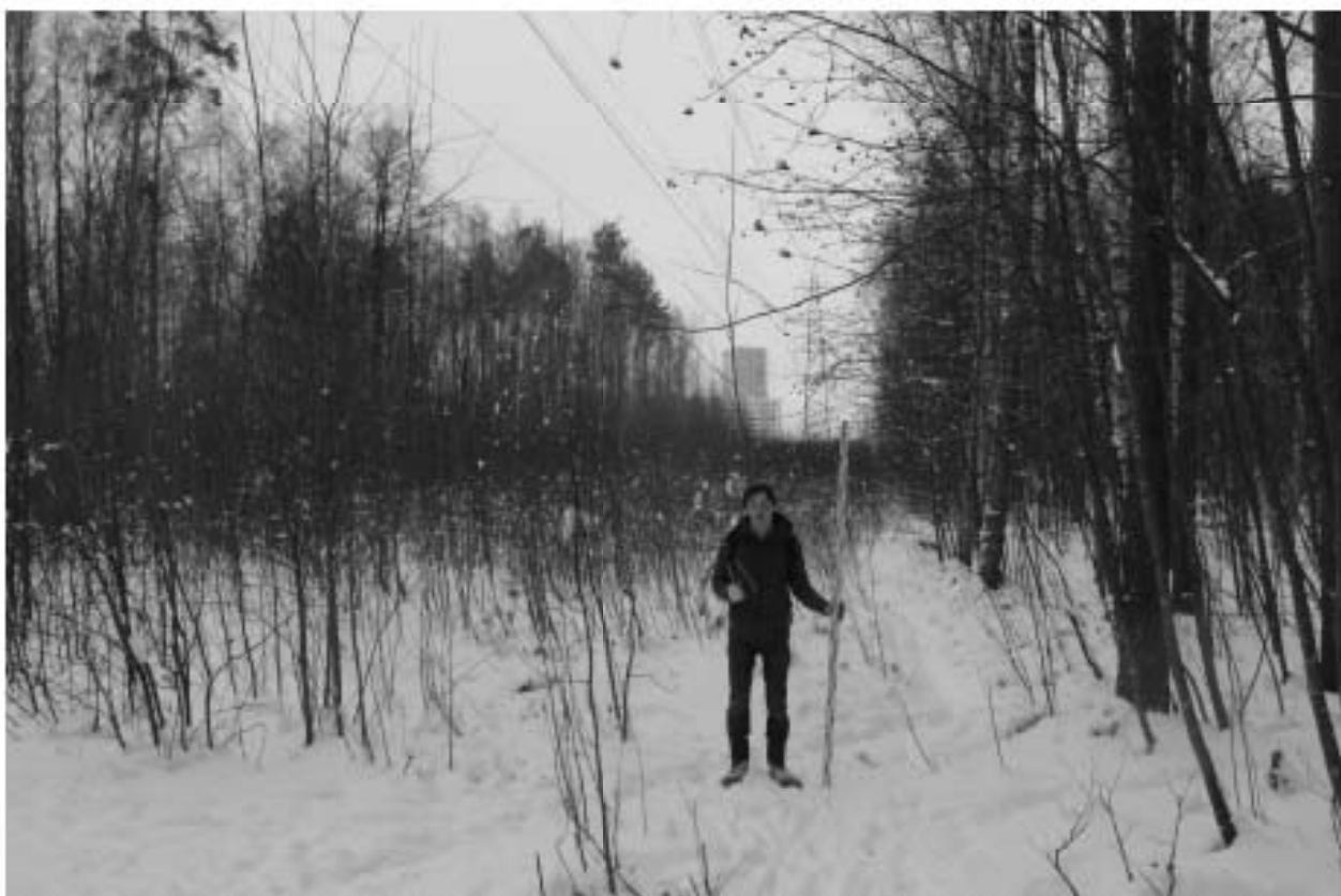
Рис. 20. ВЛ 220 кВ Ручьи–Полупроводники, КВЛ 220 кВ Парголово–Пр. Испытателей-2021. Точка фотофиксации 5, вид на север.
