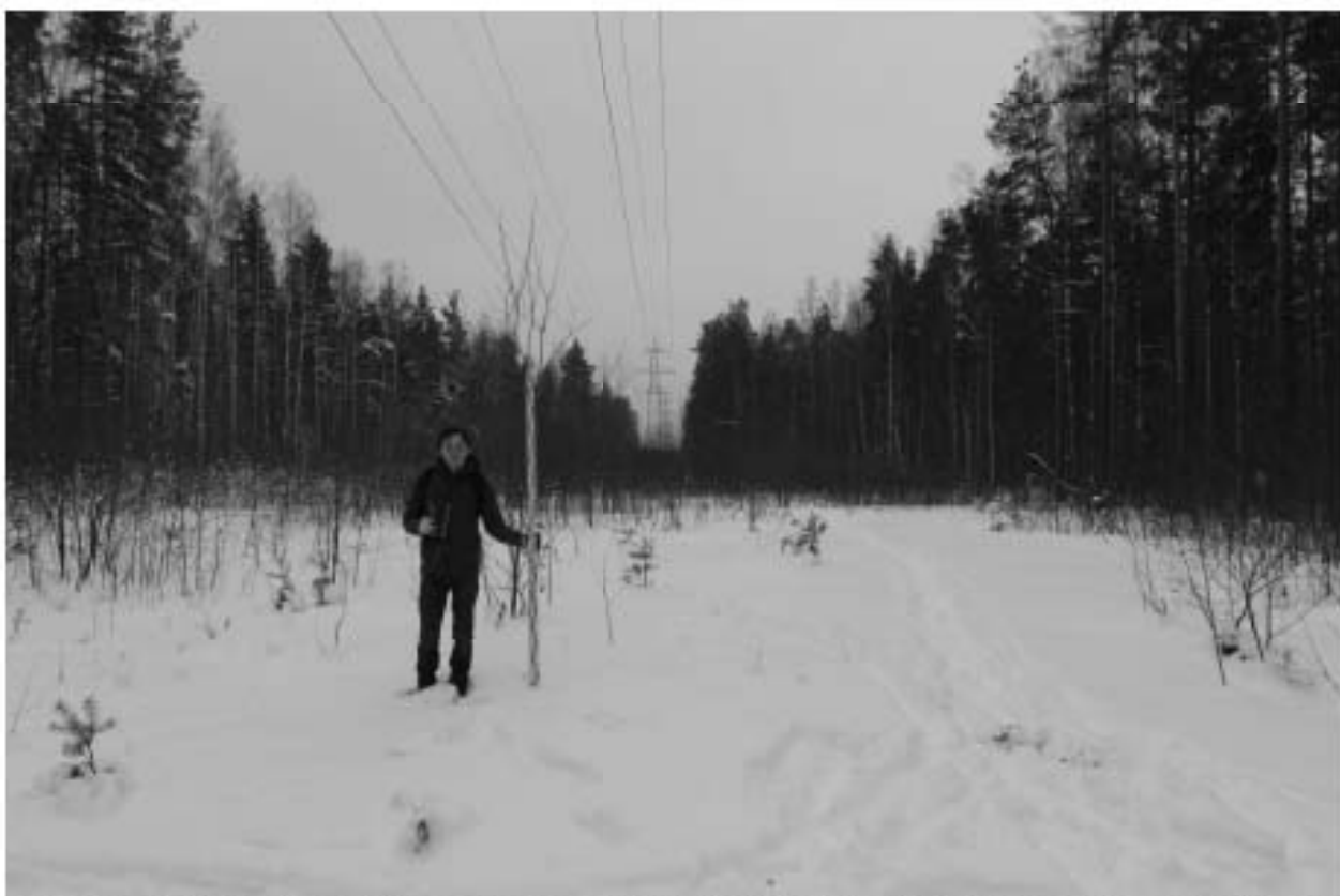
Рис. 16. ВЛ 220 кВ Ручьи–Полупроводники, КВЛ 220 кВ Парголово–Пр. Испытателей-2021. Точка фотофиксации 3, вид на юг.
