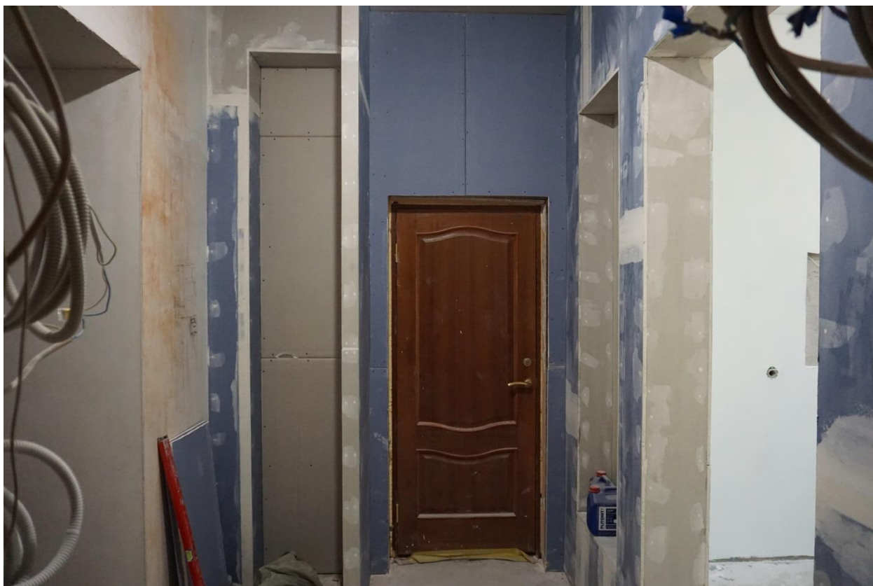
Фото 10. Бывшее помещение №1. Вид с северо-востока
