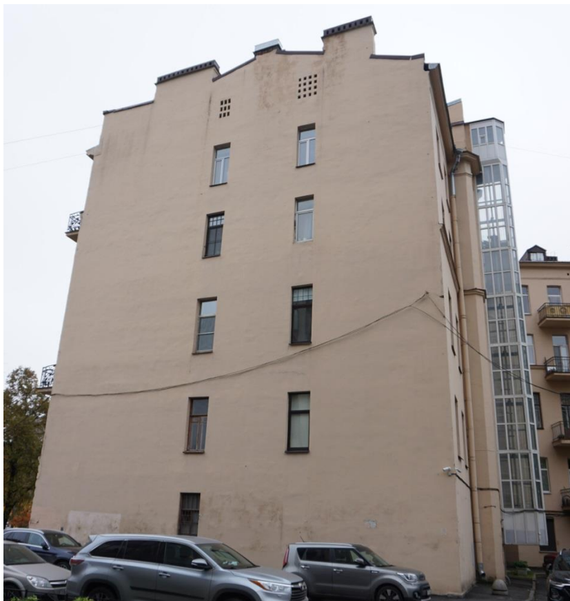
Фото 3. Вид на торцевой северо-восточный фасад с северо-востока
