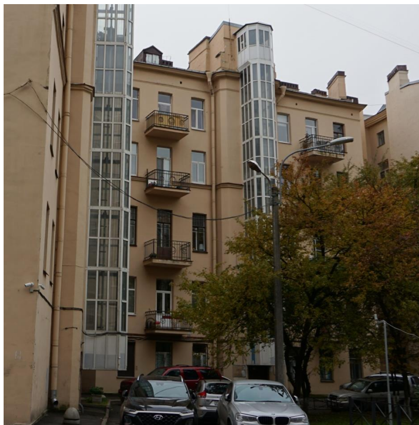
Фото 4. Вид на дворовой северо-восточный фасад с северо-востока
