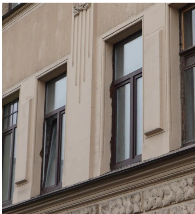
Фото 6. Оконные проемы квартиры №25 (2 шт.), выходящие на лицевой юго-восточный фасад
