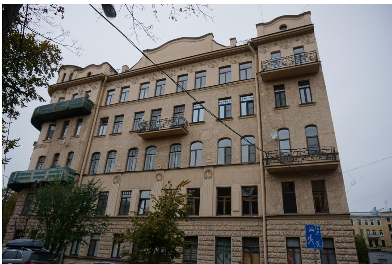
Фото 2. Вид на лицевой юго-восточный фасад с юго-востока. Окна квартиры №25 в уровне второго этажа, в осях с 6-й по 7-ю
