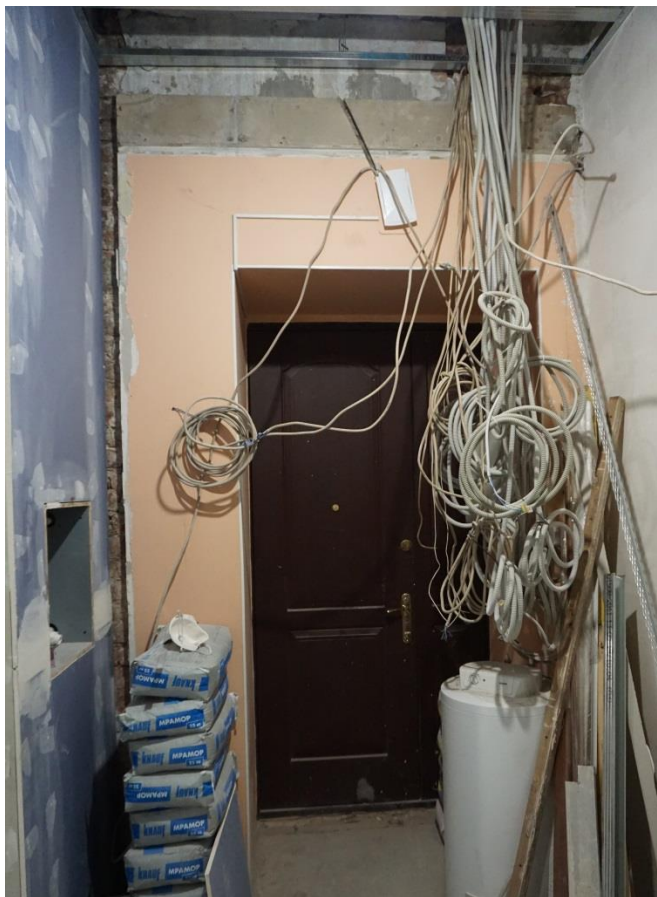
Фото 9. Вид на входной дверной проем со стороны квартиры. Бывшее помещение №1 согласно плану ПИБ. Вид с юго-запада
