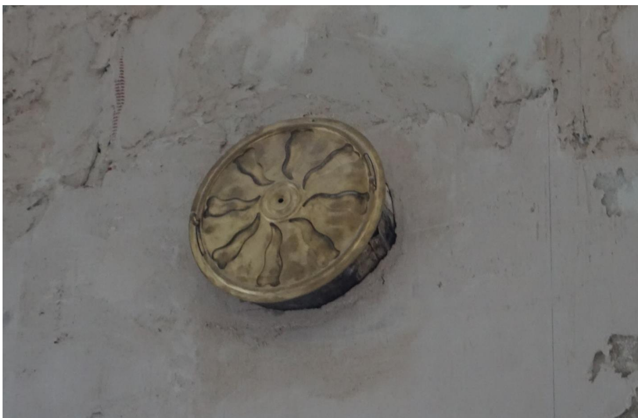
Фото 24. Дверца вентиляционного хода в бывшем помещении №7. Вид с северо-запада
