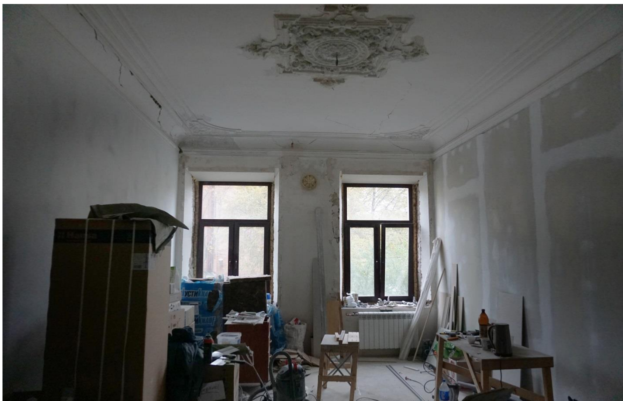
Фото 20. Бывшее помещение №7. Вид с северо-запада
