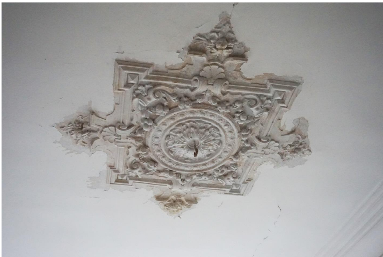
Фото 23. Лепная розетка в центральной части потолка помещения №7. Вид с северо-запада
