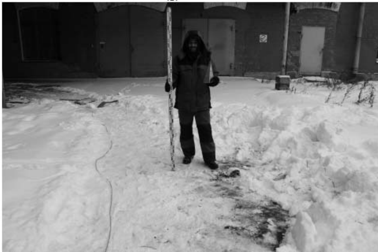
Рис. 63. Санкт-Петербург, Синопская наб. 56-58. Общий вид места закладки шурфа 2. До начала работ. Вид на С.
