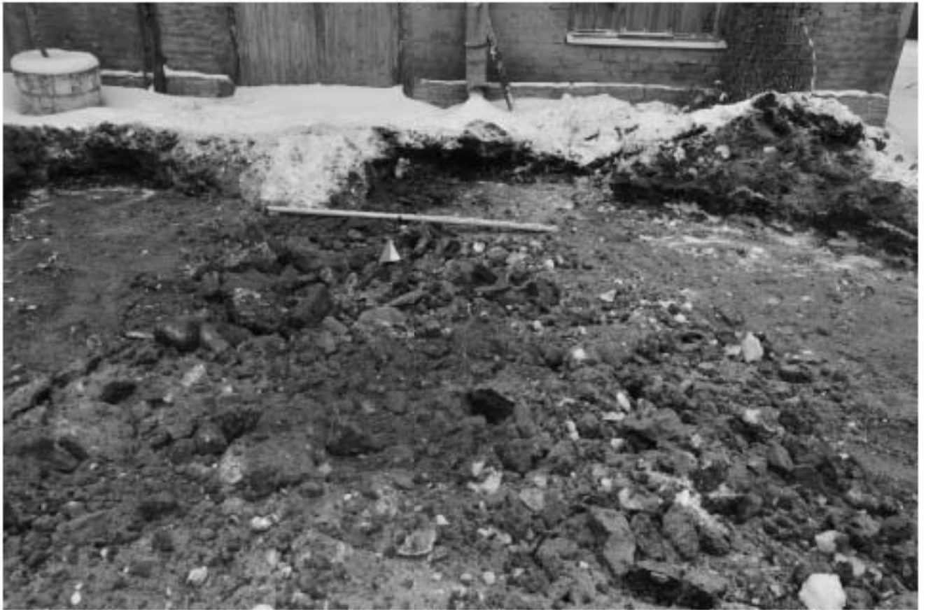
Рис. 54. Санкт-Петербург, Синопская наб. 56-58. Шурф 1. После рекультивации. Вид на С.
