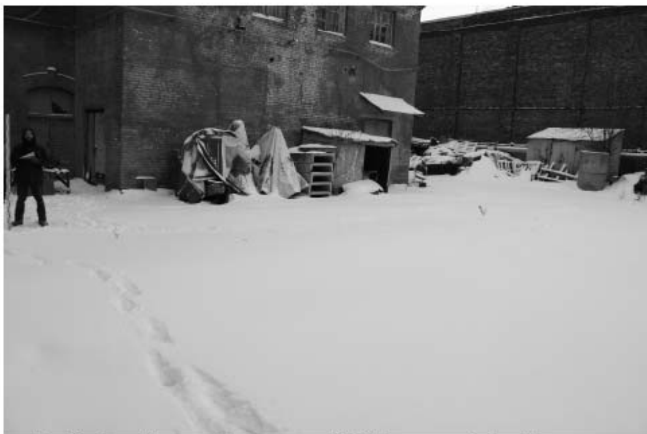
Рис. 17. Санкт-Петербург, Синопская наб. 56-58. Точка съемки 2. Общий вид участка обследования. Вид на ЮВ.
