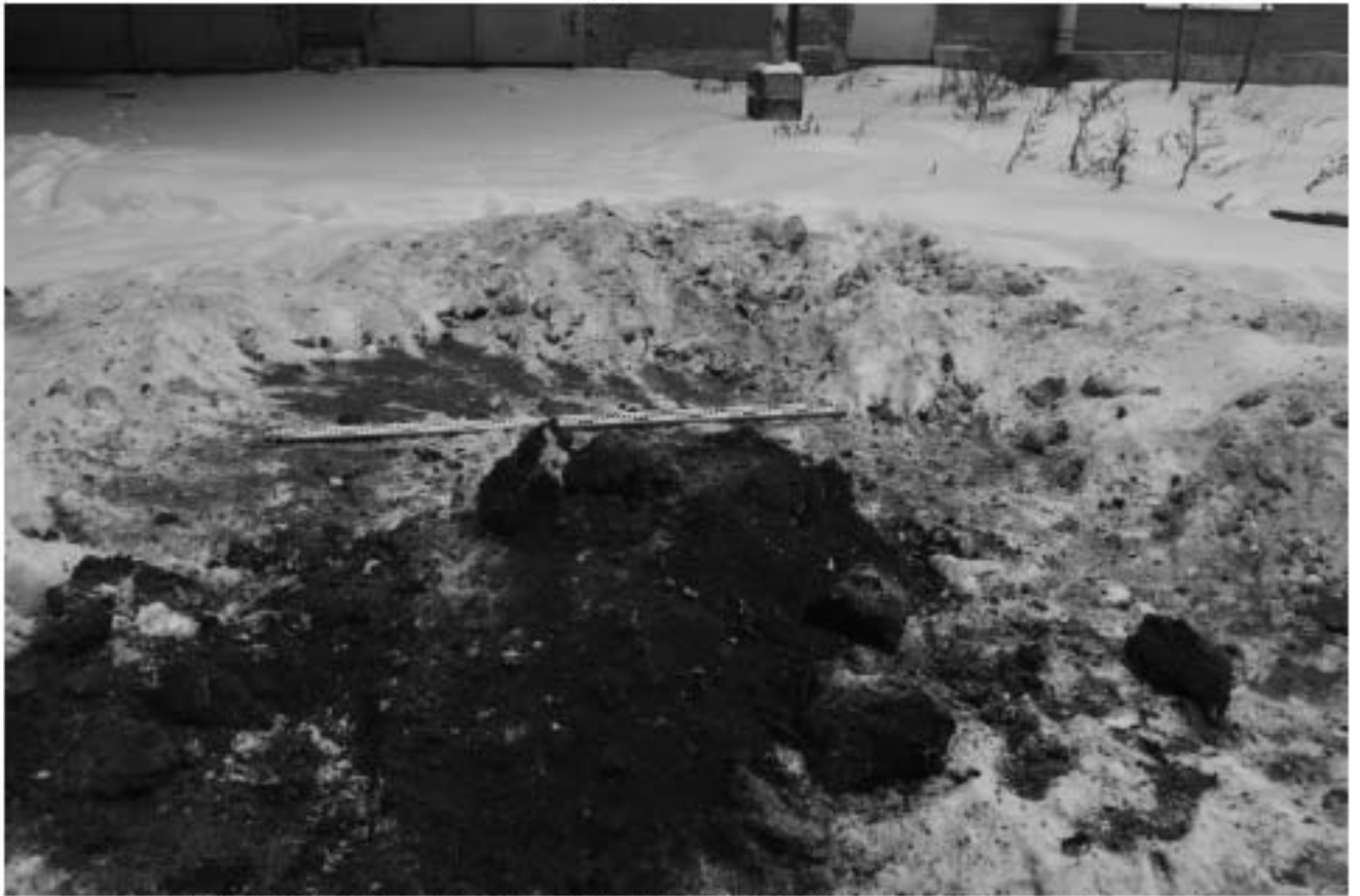
Рис. 77. Санкт-Петербург, Синопская наб. 56-58. Шурф 2. После рекультивации.
