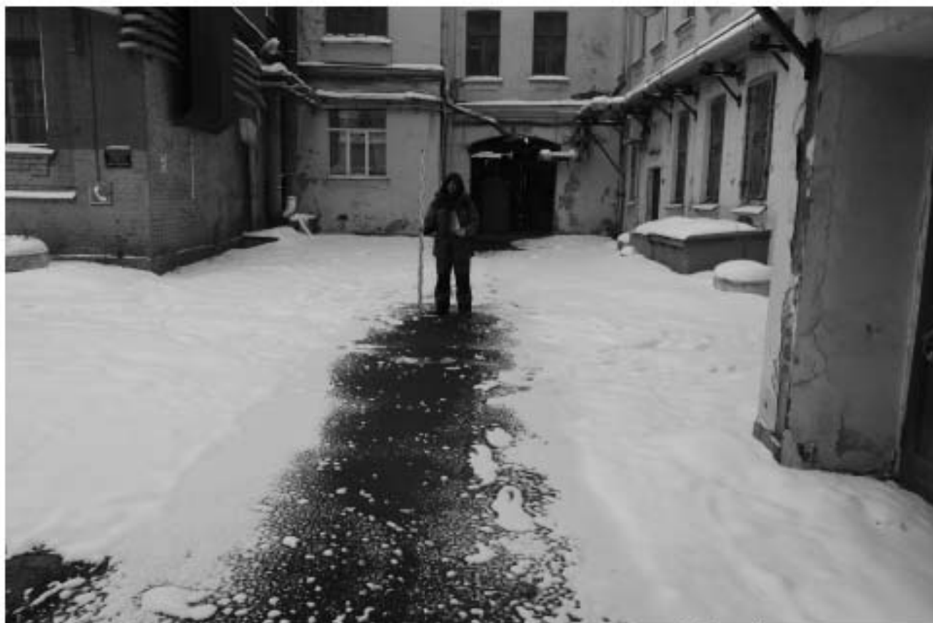
Рис. 25. Санкт-Петербург, Синопская наб. 56-58. Точка съемки 8. Общий вид участка обследования. Вид на С.
