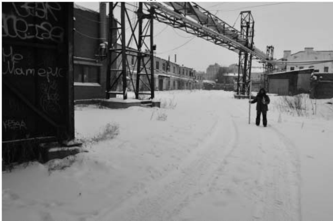
Рис. 32. Санкт-Петербург, Синопская наб. 56-58. Точка съемки 15. Общий вид участка обследования. Вид на С.
