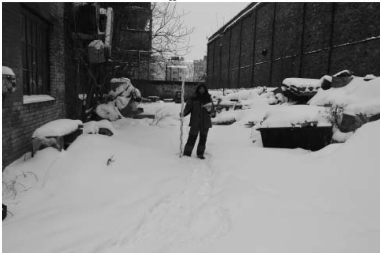
Рис. 16. Санкт-Петербург, Синопская наб. 56-58. Точка съемки 1. Общий вид участка обследования. Вид на В.
