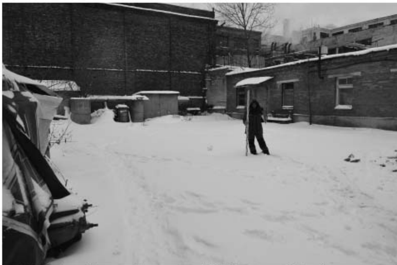
Рис. 19. Санкт-Петербург, Синопская наб. 56-58. Точка съемки 3. Общий вид участка обследования. Вид на ЮЗ.
