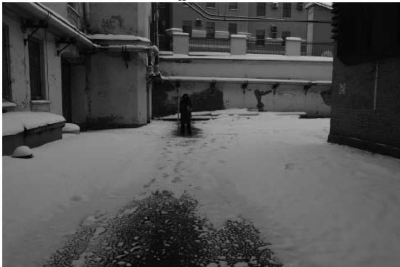
Рис. 26. Санкт-Петербург, Синопская наб. 56-58. Точка съемки 9. Общий вид участка обследования. Вид на Ю.
