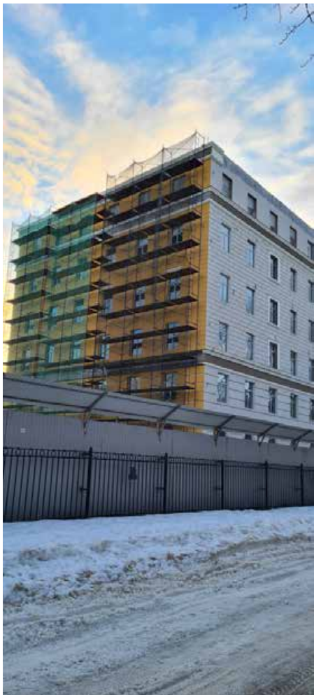
Точка фотофиксации 5. Общий вид на северо-восточный фасад нового корпуса и примыкающей территории с СВ.
