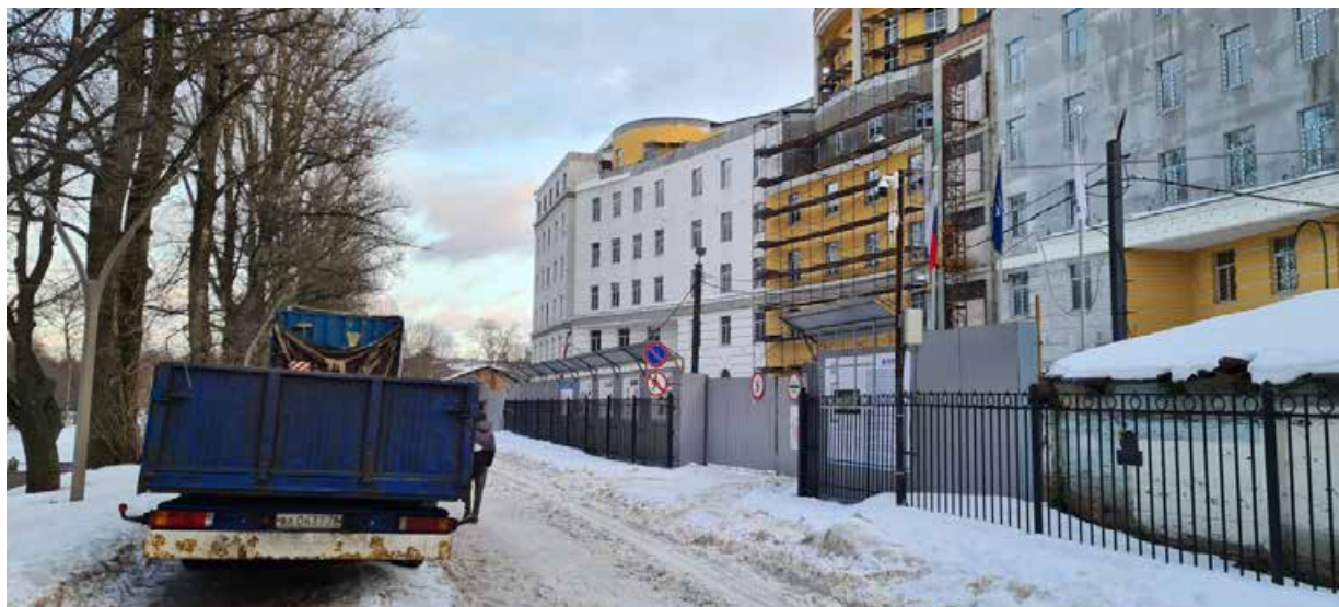
Точка фотофиксации 9. Общий вид на фрагмент северного фасада нового корпуса и примыкающей территории с СЗ.
