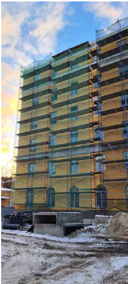
Точка фотофиксации 3. Общий вид на фрагмент северо-восточного фасада нового корпуса и примыкающей территории с СВ.
