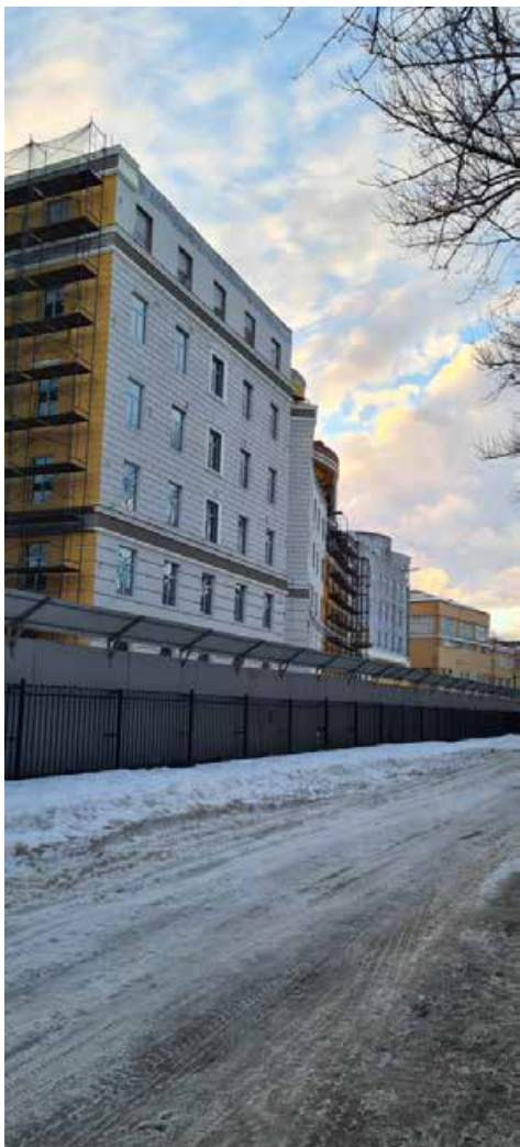
Точка фотофиксации 6. Общий вид на фрагмент северного фасада нового корпуса и примыкающей территории с СВ.
