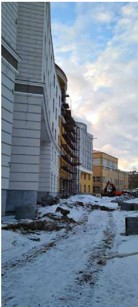
Точка фотофиксации 4. Общий вид на фрагмент северного фасада нового корпуса и примыкающей территории с СВ.
