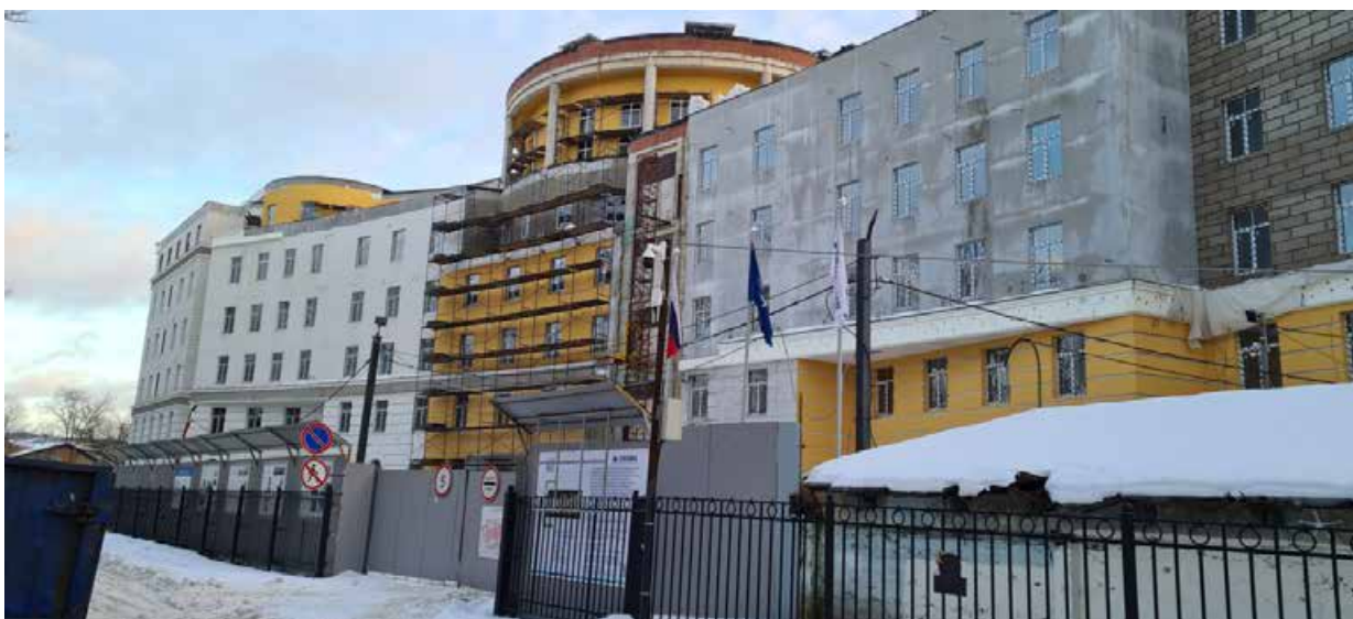
Точка фотофиксации 8. Общий вид на фрагмент северного фасада нового корпуса и примыкающей территории с СЗ.
