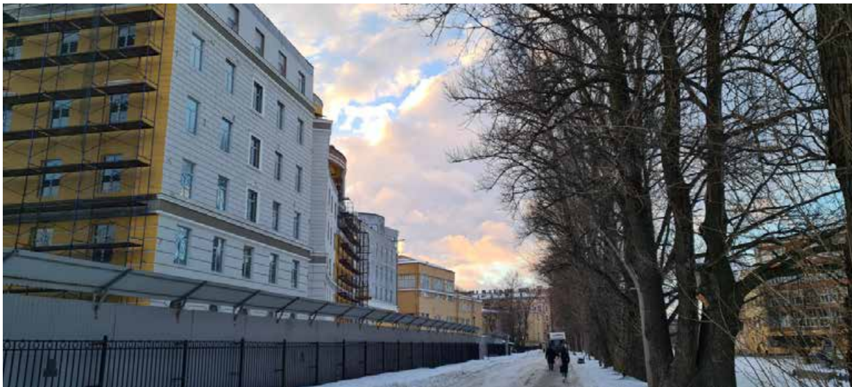
Точка фотофиксации 7. Общий вид на фрагмент северного фасада нового корпуса и примыкающей территории с СВ.
