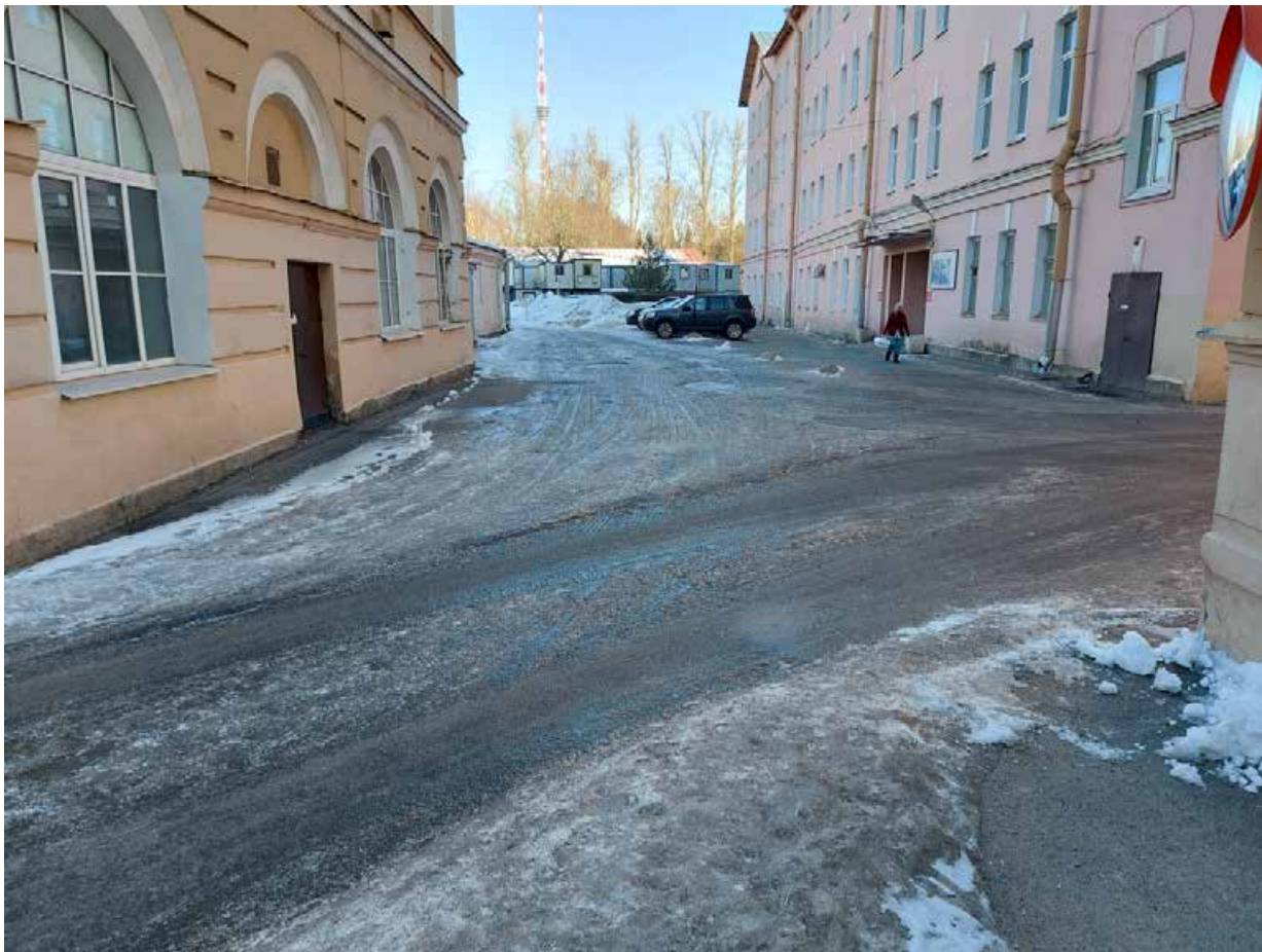
Точка фотофиксации 13. Проезд между корпусами 20 и 21, участок прокладки теплотрассы. Вид с Ю.
