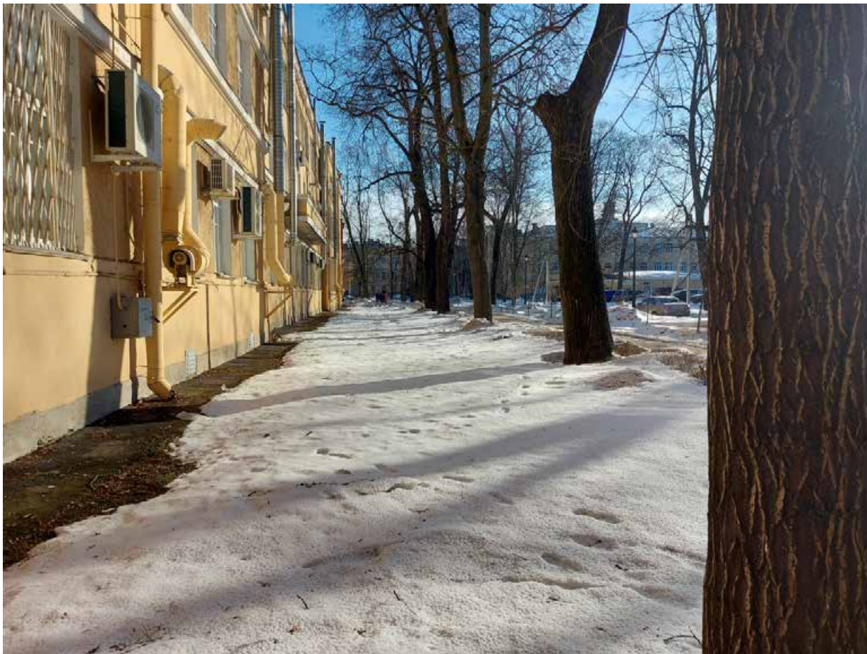
Точка фотофиксации 11. Вид на центральный участок прокладки электроснабжения с 3.
