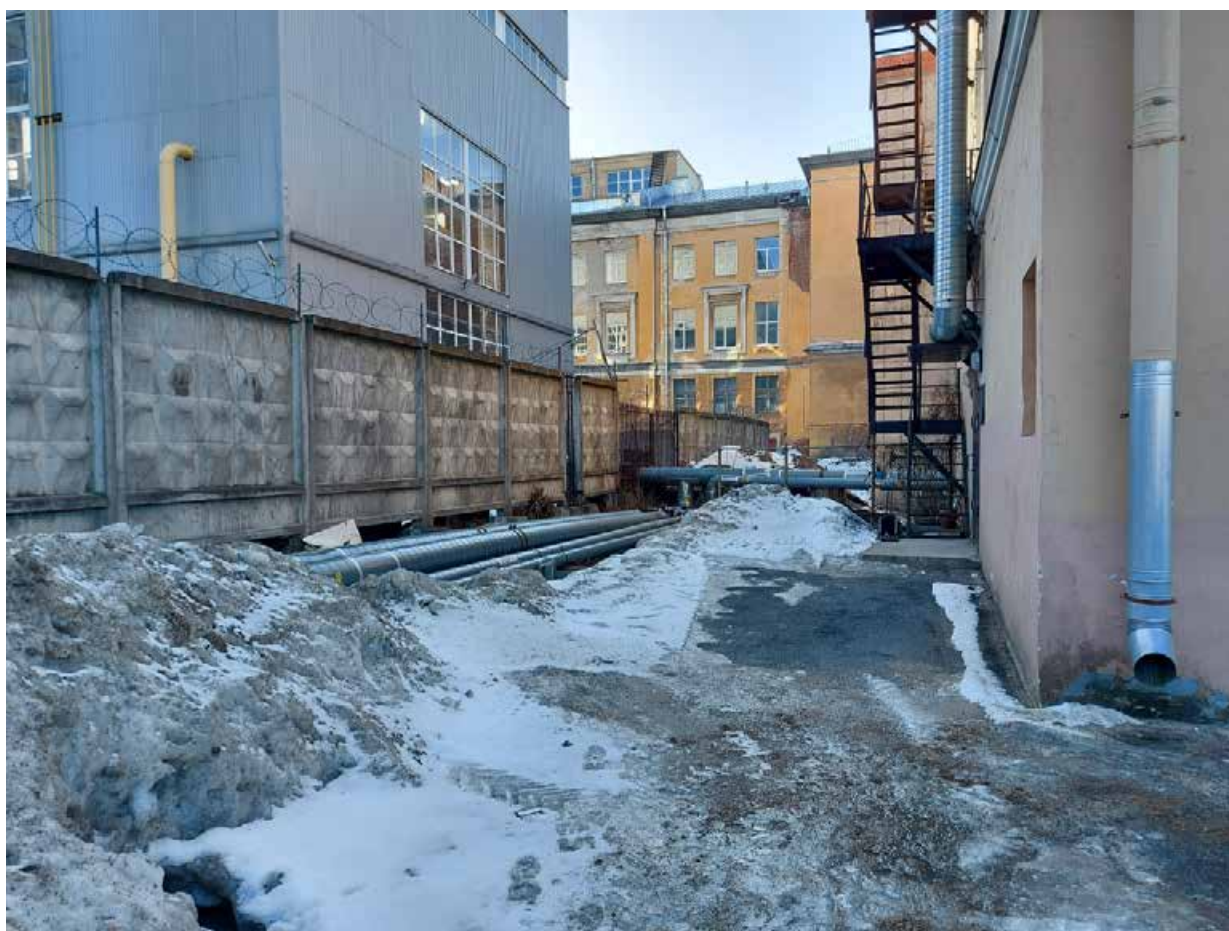
Точка фотофиксации 15. Территория к востоку от корпуса 21, участок прокладки теплотрассы. Вид с ССЗ.
