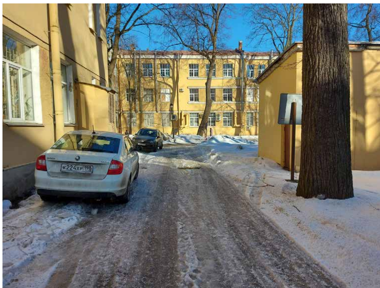
Точка фотофиксации 10. Общий вид на южный участок прокладки электроснабжения с Ю.
