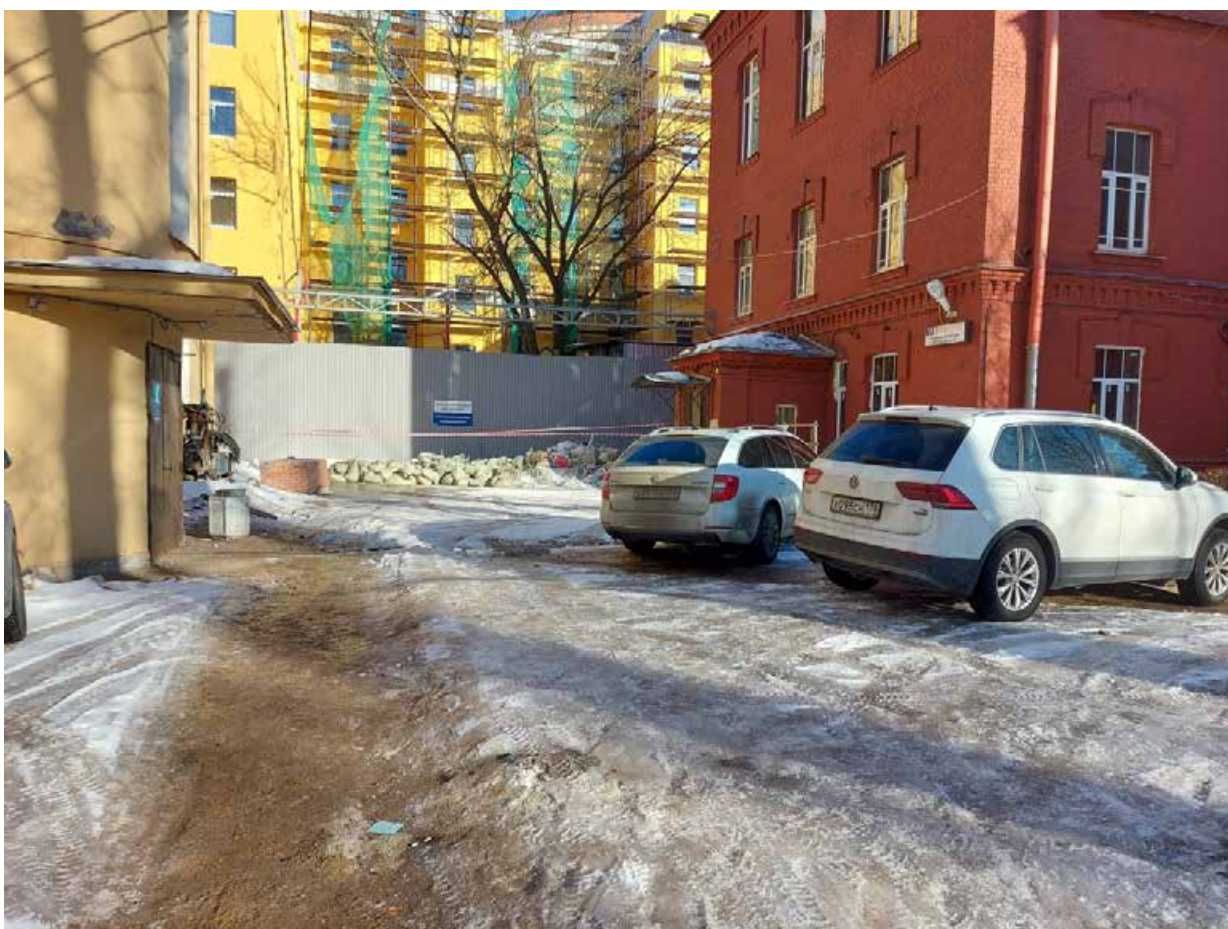
Точка фотофиксации 12. Вид на северный участок прокладки электроснабжения с Ю. На дальнем плане построенный корпус и ограждение строительной площадки.
