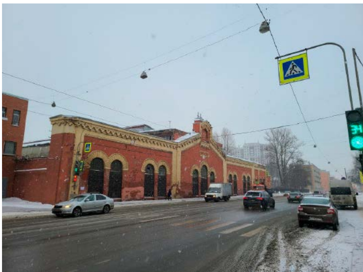
1. Юго-западный фасад объекта культурного наследия регионального значения «Прокатная и сталелитейная мастерская «Невского железодельательного, механического и корабельного завода» («Невского железопрокатного завода» П.Ф. Семянникова и В.А. Полетики)», расположенного по адресу: г. Санкт-Петербург, проспект Обуховской Обороны, дом 38, лит. В. 25.01.2022
