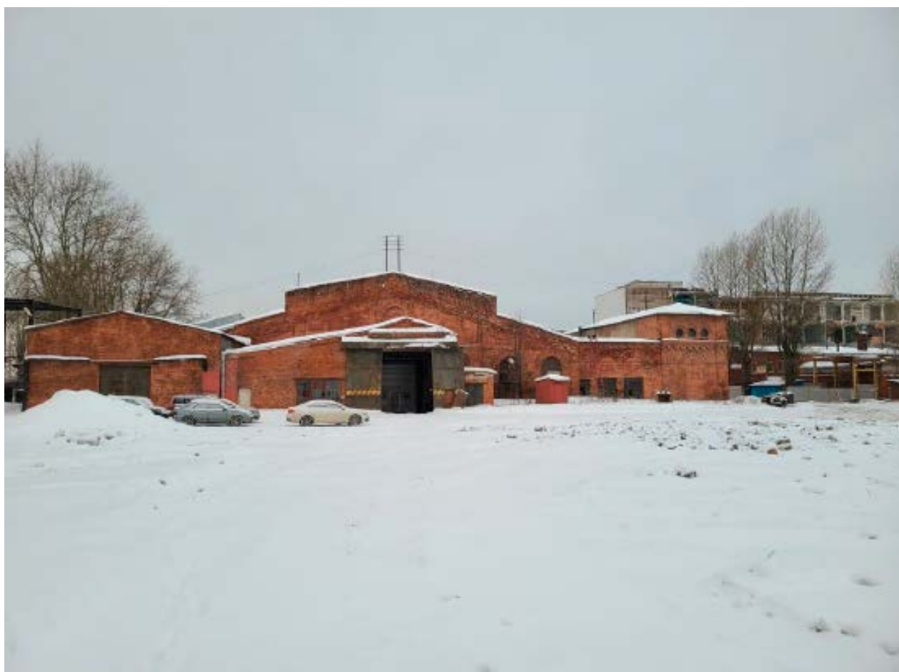
3. Вид на объект культурного наследия регионального значения «Прокатная и сталелитейная мастерская «Невского железоделательного, механического и корабельного завода» («Невского железопрокатного завода» П.Ф. Семянникова и В.А. Полетики)», расположенного по адресу: г. Санкт-Петербург, проспект Обуховской Обороны, дом 38, лит. В, от зоны производства работ. 25.01.2022
