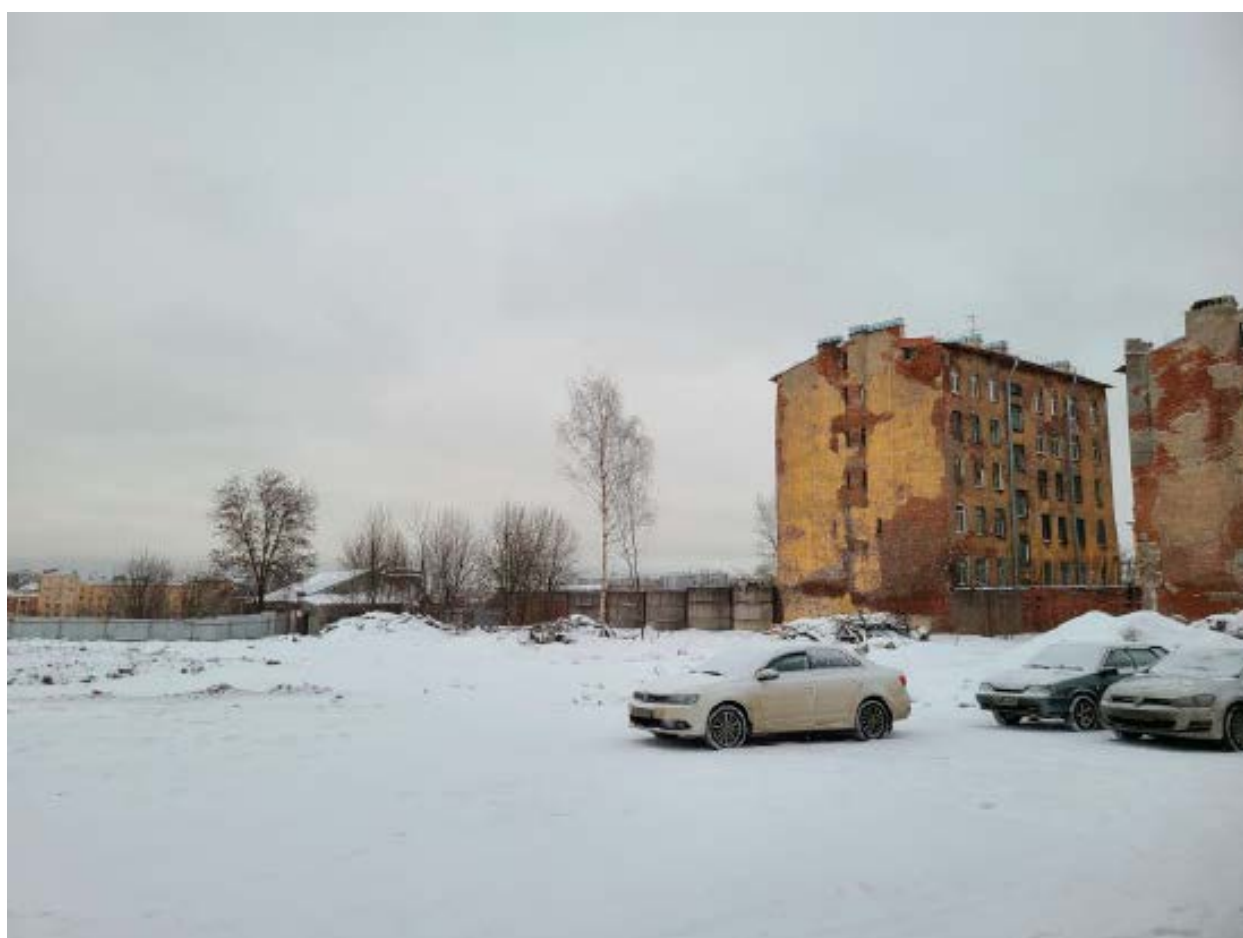
5. Вид от объекта культурного наследия регионального значения «Прокатная и сталелитейная мастерская «Невского железодельного, механического и корабельного завода» («Невского железопрокатного завода» П.Ф. Семянникова и В.А. Полетики)», расположенного по адресу: г. Санкт-Петербург, проспект Обуховской Обороны, дом 38, лит. В, на зону производства работ. 25.01.2022
