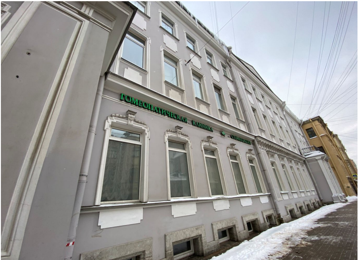
Фото 12. Вид на северный главный фасад здания «Особняк П.Ф. Семянникова» со стороны ул. Маяковской.
