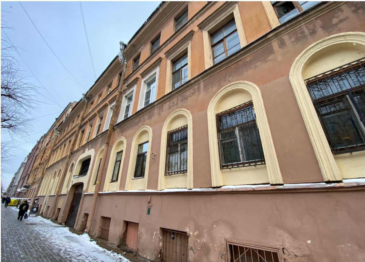
Фото 6. Вид на здание Комплекса построек Главного управления государственного коннозаводства.
