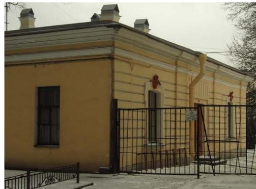
дверной проем со стороны западного фасада – местоположение, габариты, конфигурация (прямоугольная), оформление (вертикальный руст, известняковые плиты);
