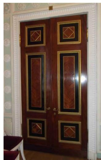
заполнение дверных проемов – конструкция (двустворчатые), материал (красное дерево), цвет, оформление (филенки в обрамлениях под черное дерево с бронзированными профилями);
