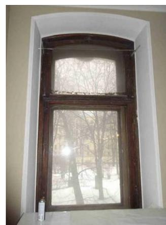
заполнение дверного проема – фрамуга с остеклением, исторический материал (дерево), рисунок расстекловки (в виде треугольных сегментов);
