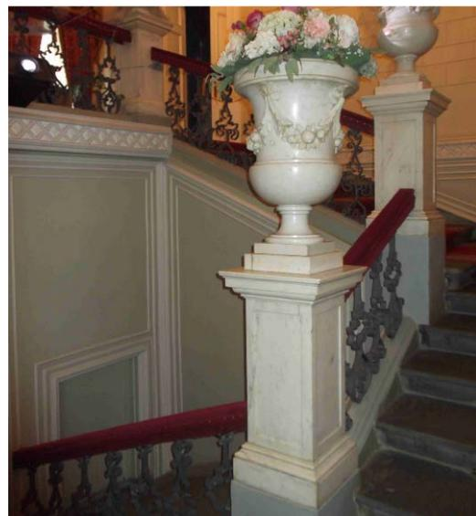
двухмаршевая известняковая лестница с забежными ступенями в центральном корпусе, на косоурах, с кованным леерным ограждением и деревянными поручнями;
