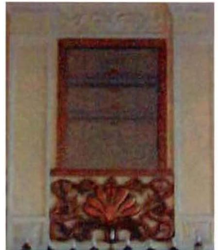
композиции с деревянным резным декором под ложными зеркальными оконными проемами на восточной и западной стенах, рисунок (пальметка с орнаментальными завитками);
