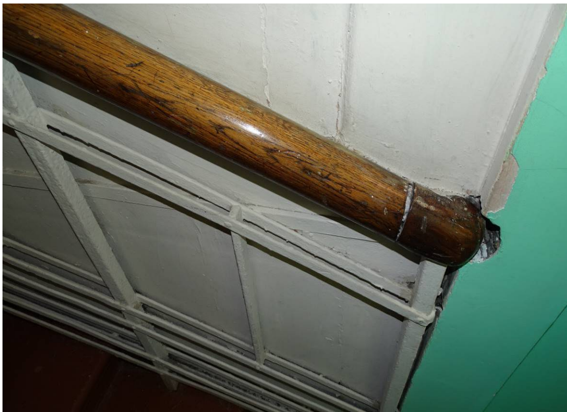
Фото 67. Выявленный объект культурного наследия «Здание Петроградской АТС» Центральная лестница. 1-й этаж. Съемка 15.11.2021 г. Трушковский В.Э.
