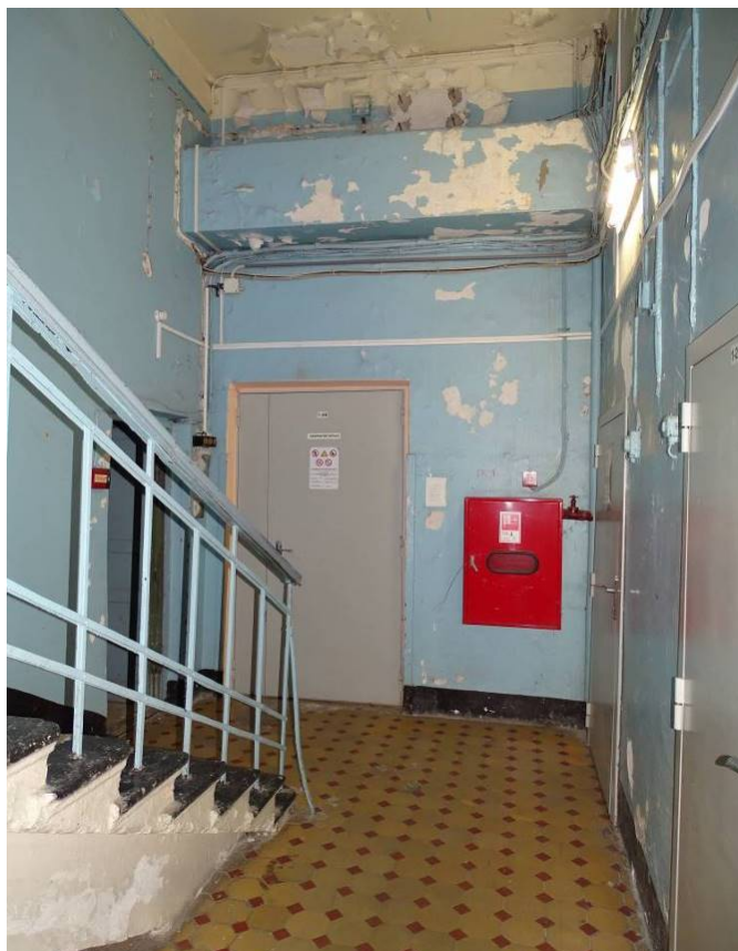
Фото 39. Выявленный объект культурного наследия «Здание Петроградской АТС» Восточная лестница. 1-й этаж. Съемка 15.11.2021 г. Трушковский В.Э.
