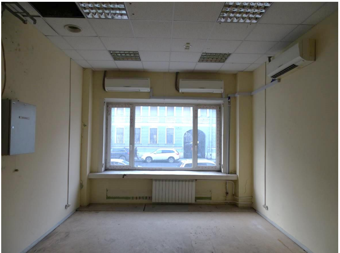
Фото 14. Выявленный объект культурного наследия «Здание Петроградской АТС» 1-й этаж. Пом. 8/254,5. Съемка 15.11.2021 г. Трушковский В.Э.
