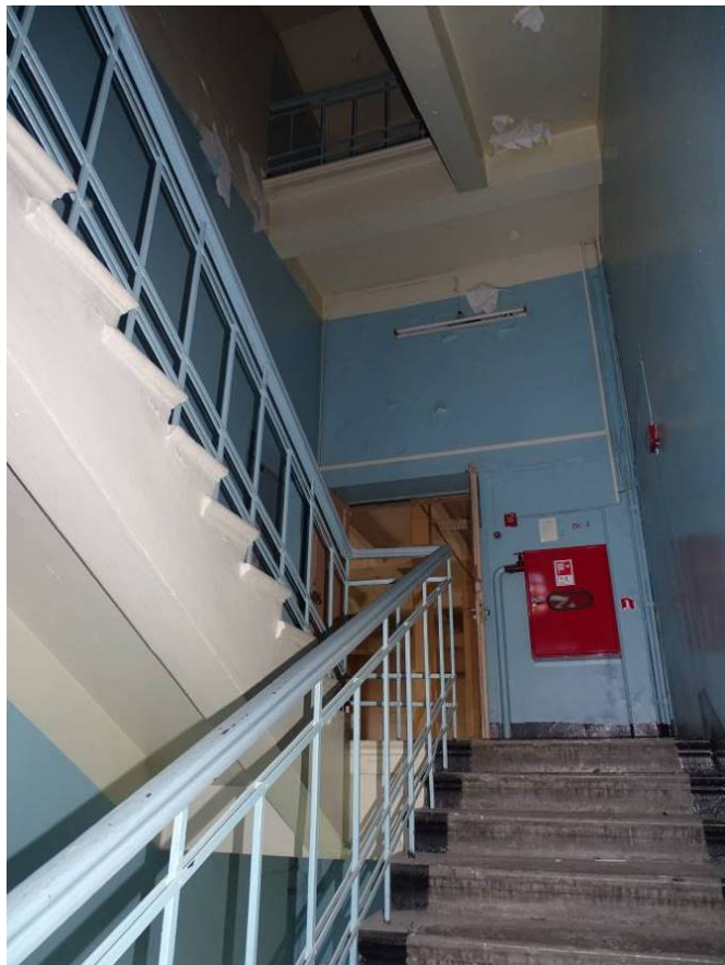
Фото 50. Выявленный объект культурного наследия «Здание Петроградской АТС» Вид на площадку 3-го этажа. Съемка 15.11.2021 г. Трушковский В.Э.
