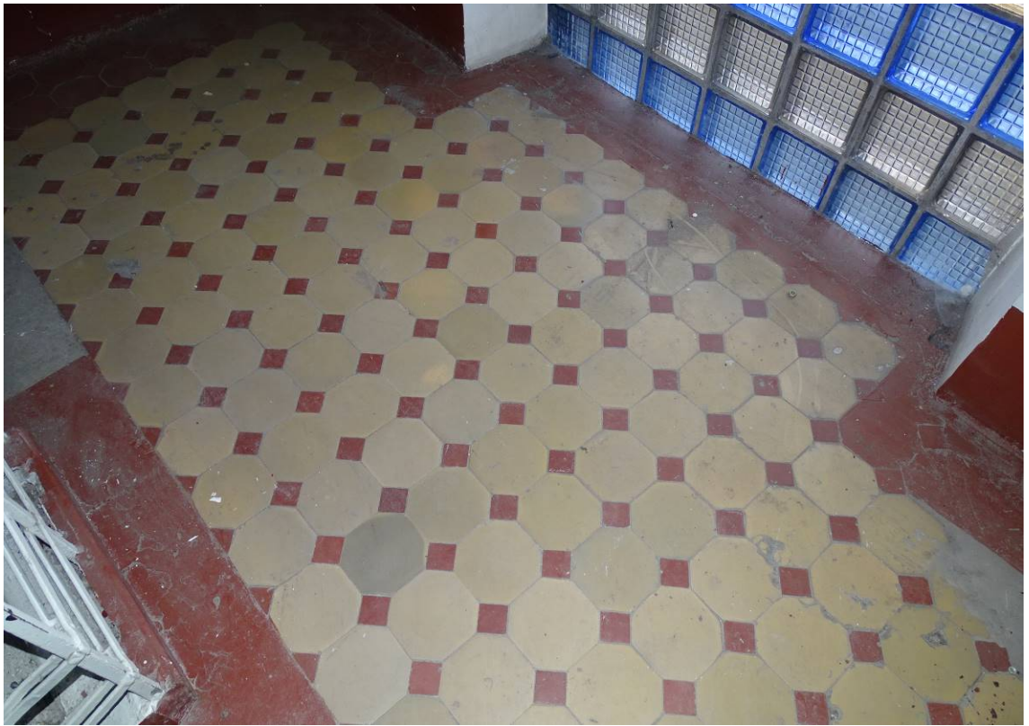
Фото 17. Выявленный объект культурного наследия «Здание Петроградской АТС» Западная лестница. Площадка между 1-м и 2-м этажом. Покрытие пола. Съемка 15.11.2021 г. Трушковский В.Э.
