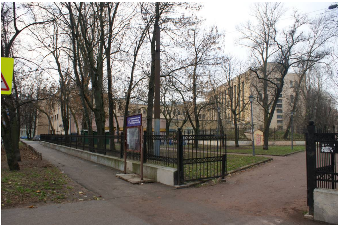
Фото 10. Выявленный объект культурного наследия «Здание Петроградской АТС» (ул. Ленина, д. 5, лит. А). Вид со стороны северо-востока. Съемка 15.11.2021 г. Трушковский В.Э.
