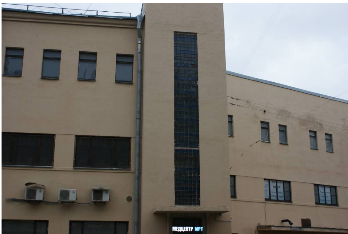
Фото 5. Выявленный объект культурного наследия «Здание Петроградской АТС» (ул. Ленина, д. 5, лит. А). Юго-восточный фасад. Фрагмент. Съемка 15.11.2021 г. Трушковский В.Э.
