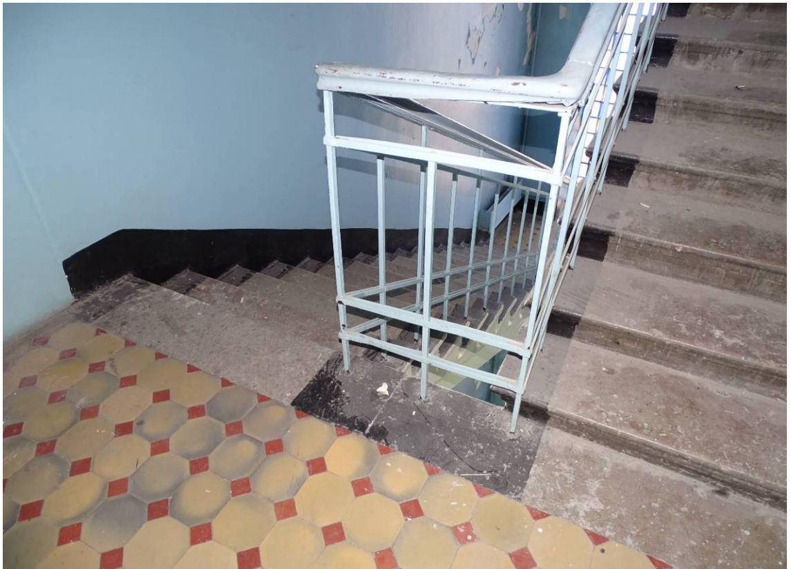
Фото 49. Выявленный объект культурного наследия «Здание Петроградской АТС» Восточная лестница. Площадка 2-го этажа. Съемка 15.11.2021 г. Трушковский В.Э.
