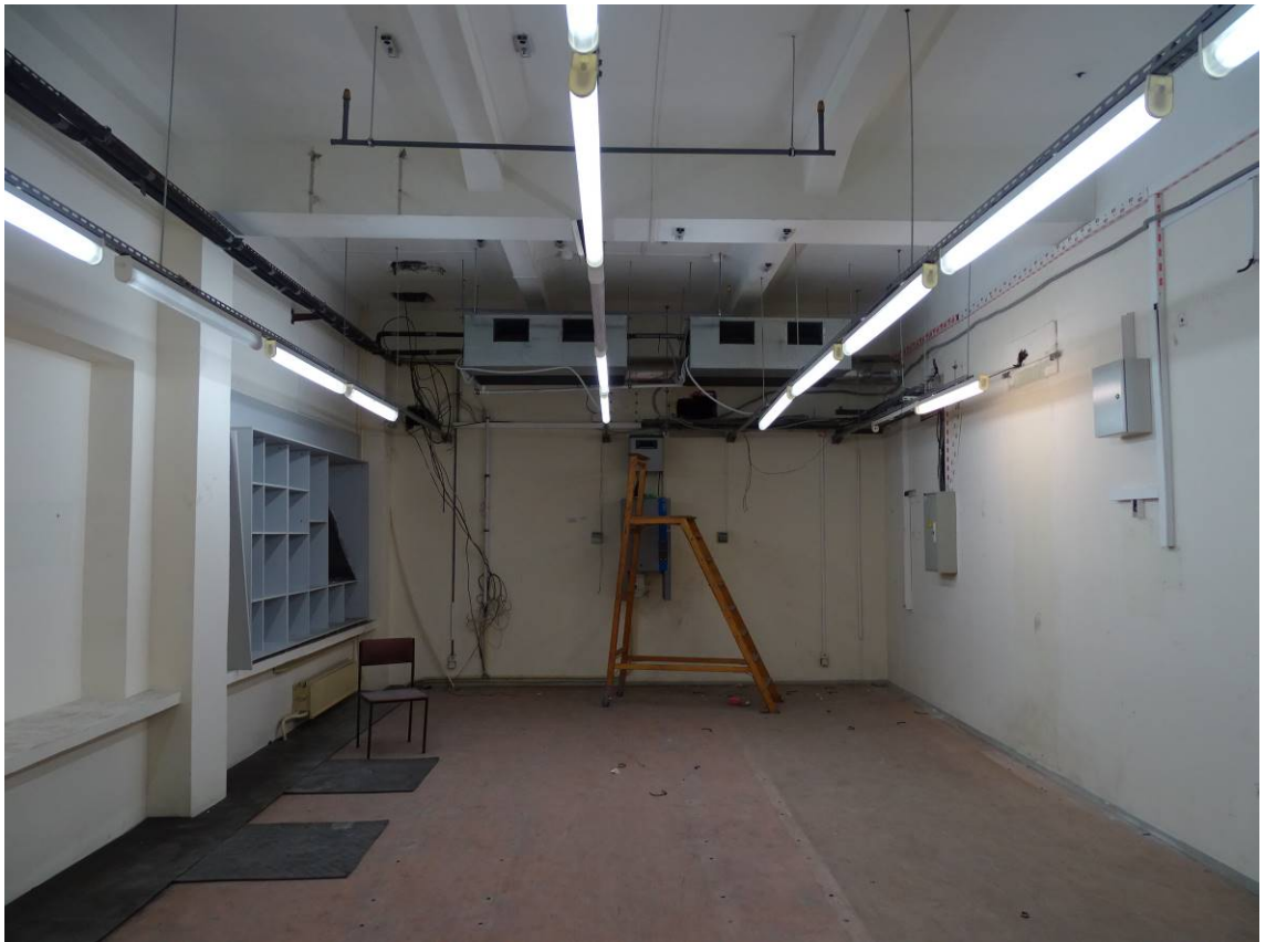
Фото 13. Выявленный объект культурного наследия «Здание Петроградской АТС» 1-й этаж. Пом. 8/254,5. Съемка 15.11.2021 г. Трушковский В.Э.
