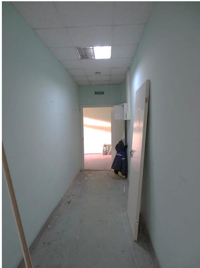
Фото 56. Выявленный объект культурного наследия «Здание Петроградской АТС» 3-й этаж. Пом. 17/22,3. Съемка 15.11.2021 г. Трушковский В.Э.
