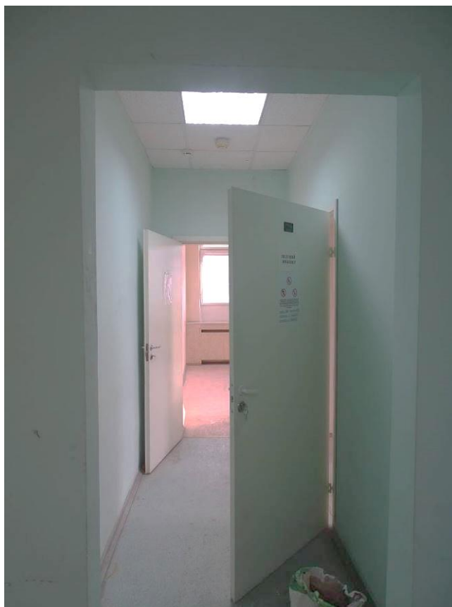
Фото 57. Выявленный объект культурного наследия «Здание Петроградской АТС» 3-й этаж. Пом. 17/22,3. Съемка 15.11.2021 г. Трушковский В.Э.
