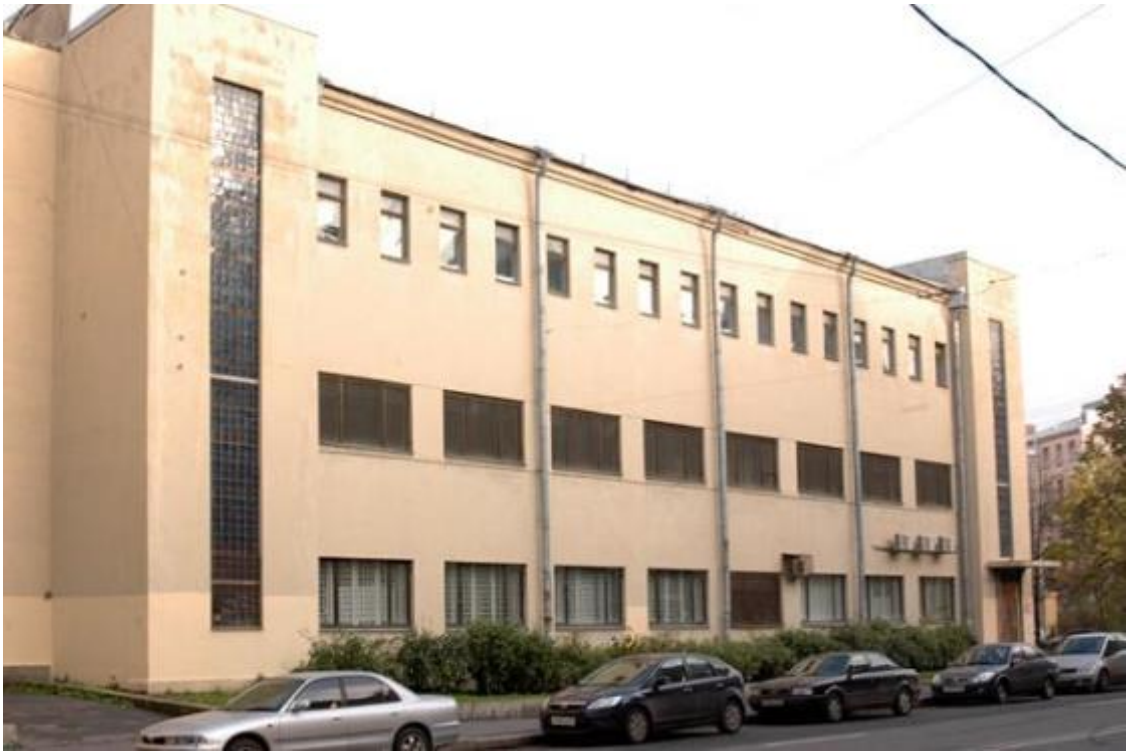
Илл. 73. Петроградская АТС, ул. Ленина, 5. 2009 г. https://p2.citywalls.ru/photo_35-36862.jpg?mt=1273625807
