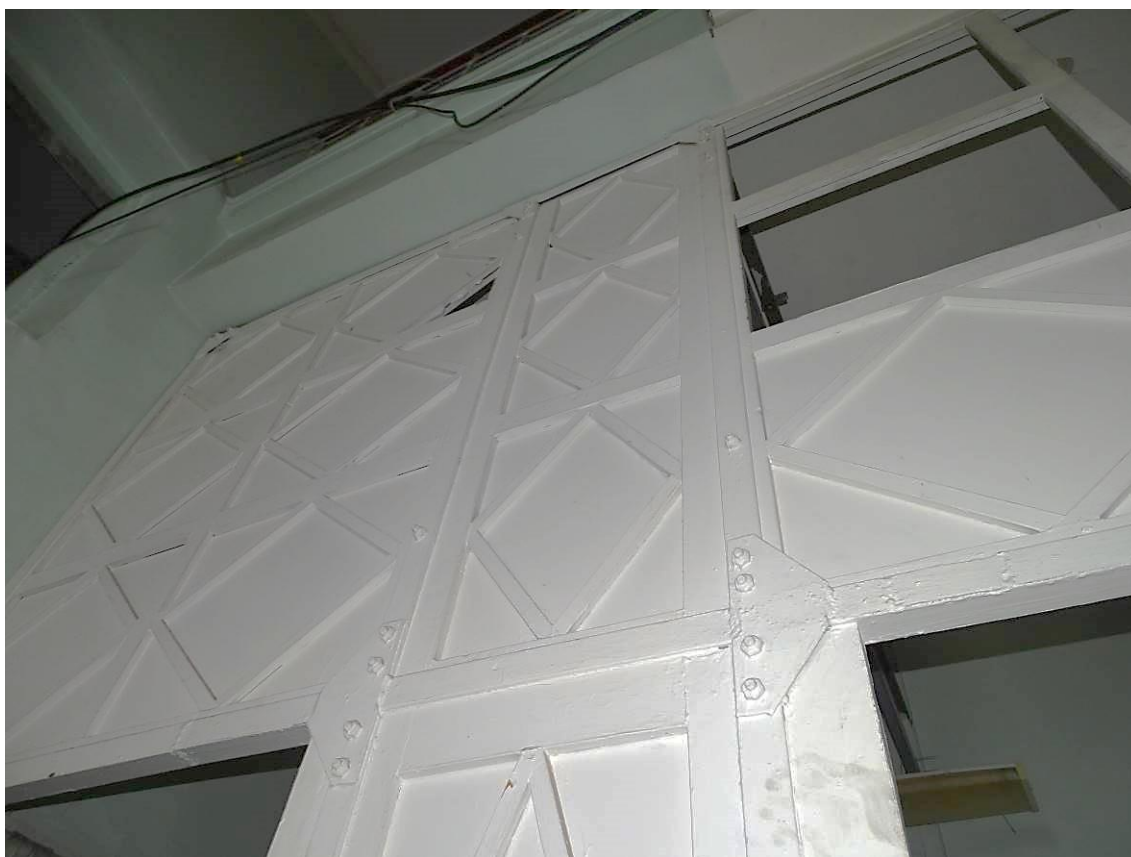
Фото 32. Выявленный объект культурного наследия «Здание Петроградской АТС» Западная лестница. 3-й этаж. Съемка 15.11.2021 г. Трушковский В.Э.
