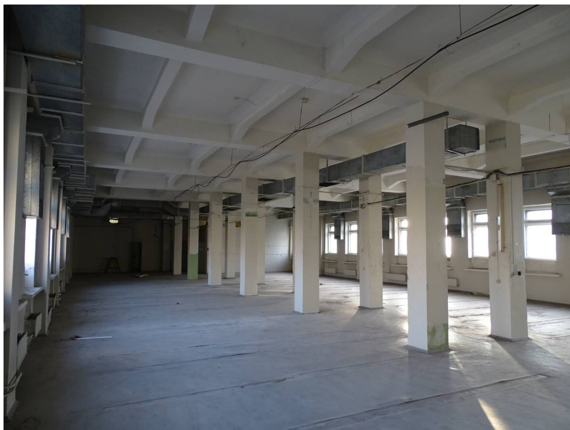
Фото 34. Выявленный объект культурного наследия «Здание Петроградской АТС» 3-й этаж. Пом. 3/413,0. Съемка 15.11.2021 г. Трушковский В.Э.
