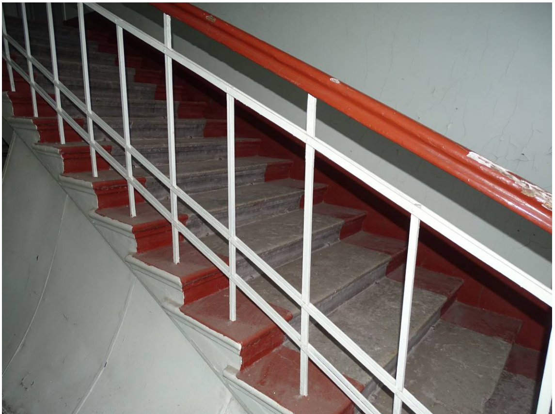
Фото 18. Выявленный объект культурного наследия «Здание Петроградской АТС» Западная лестница. Площадка между 1-м и 2-м этажом. Лестничное ограждение. Съемка 15.11.2021 г. Трушковский В.Э.
