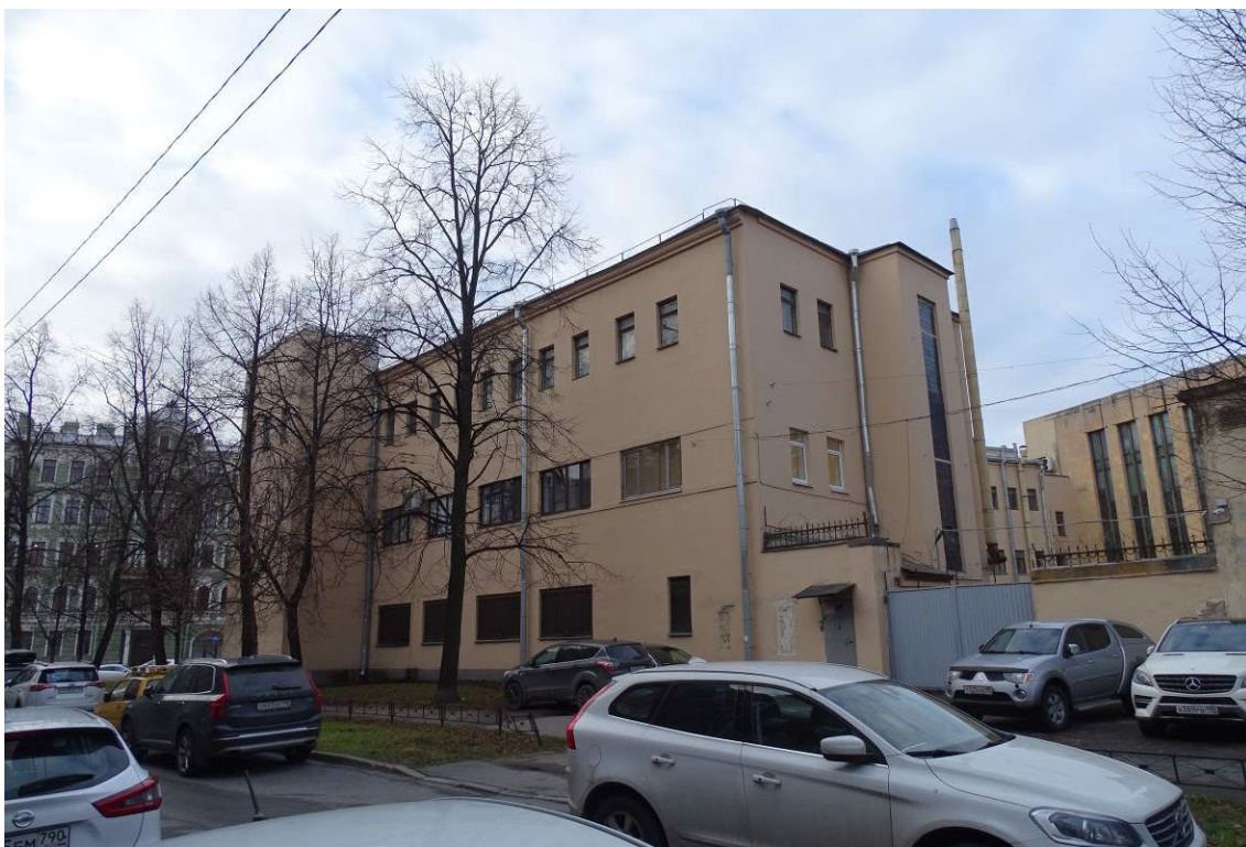
Фото 11. Выявленный объект культурного наследия «Здание Петроградской АТС» (ул. Ленина, д. 5, лит. А). Северо-восточный фасад. Съемка 15.11.2021 г. Трушковский В.Э.
