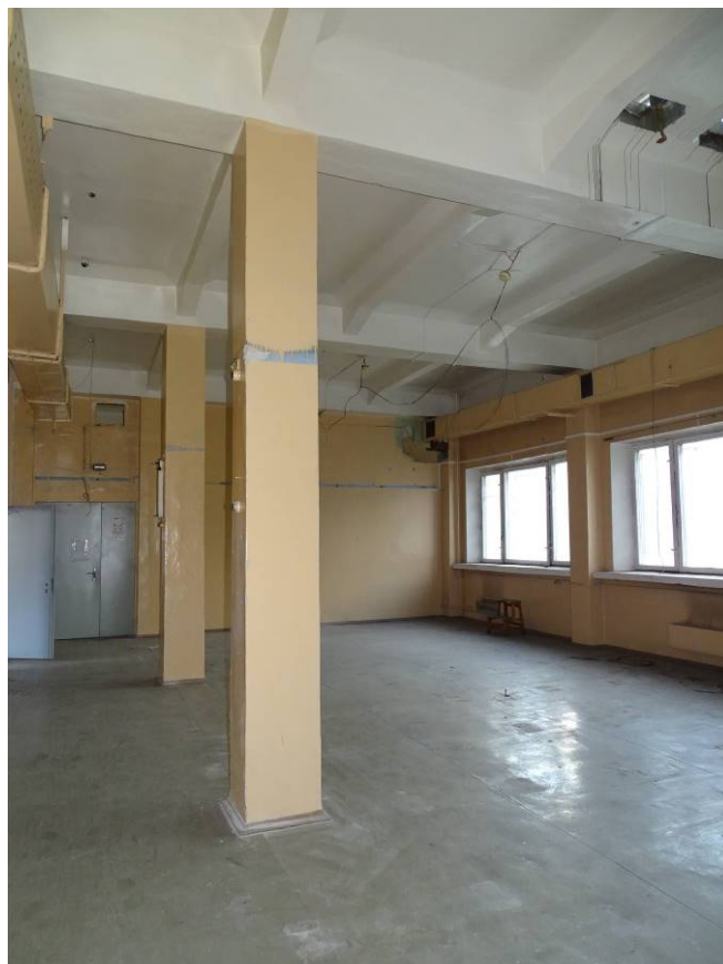
Фото 22. Выявленный объект культурного наследия «Здание Петроградской АТС» 2-й этаж. Пом. 5/184,4. Съемка 15.11.2021 г. Трушковский В.Э.
