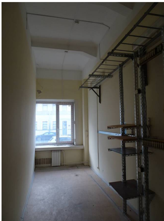
Фото 9. Выявленный объект культурного наследия «Здание Петроградской АТС» 1-й этаж. Пом. 4/69,2. Съемка 15.11.2021 г. Трушковский В.Э.
