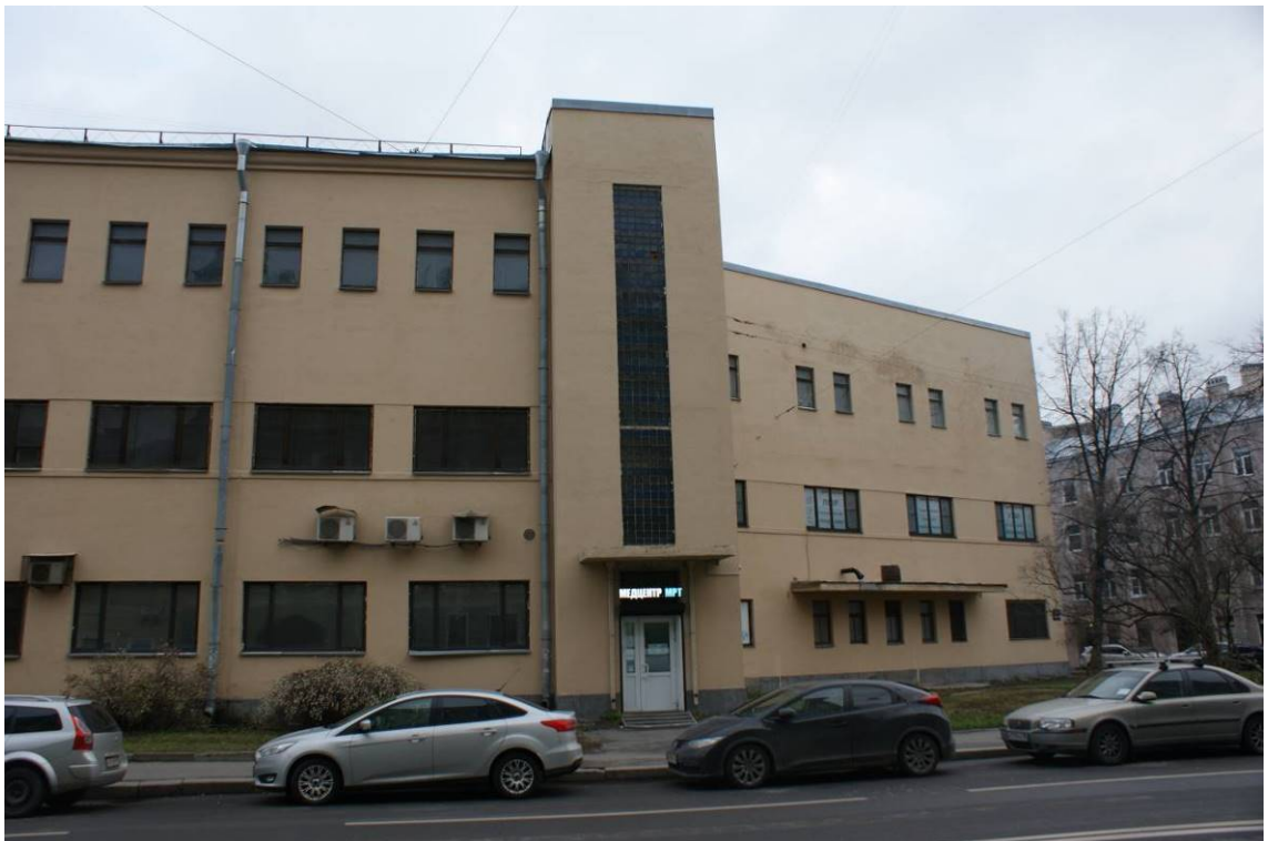
Фото 4. Выявленный объект культурного наследия «Здание Петроградской АТС» (ул. Ленина, д. 5, лит. А). Юго-восточный фасад. Фрагмент. Съемка 15.11.2021 г. Трушковский В.Э.
