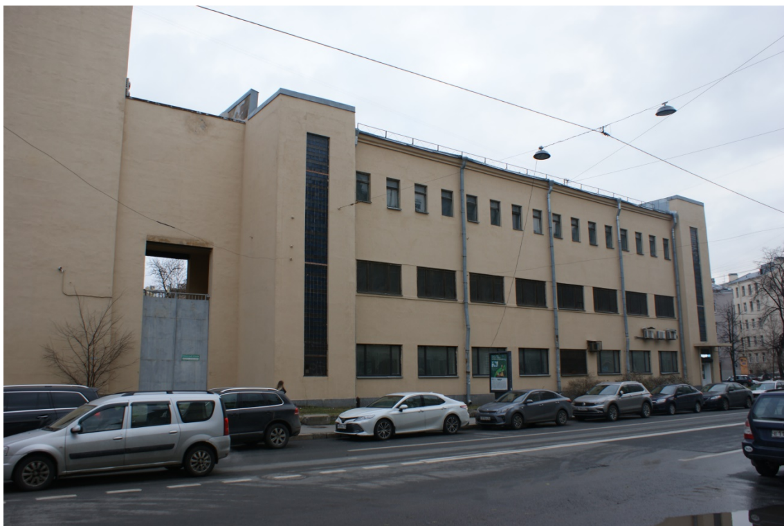
Фото 7. Выявленный объект культурного наследия «Здание Петроградской АТС» (ул. Ленина, д. 5, лит. А). Юго-восточный фасад. Фрагмент. Съемка 15.11.2021 г. Трушковский В.Э.
