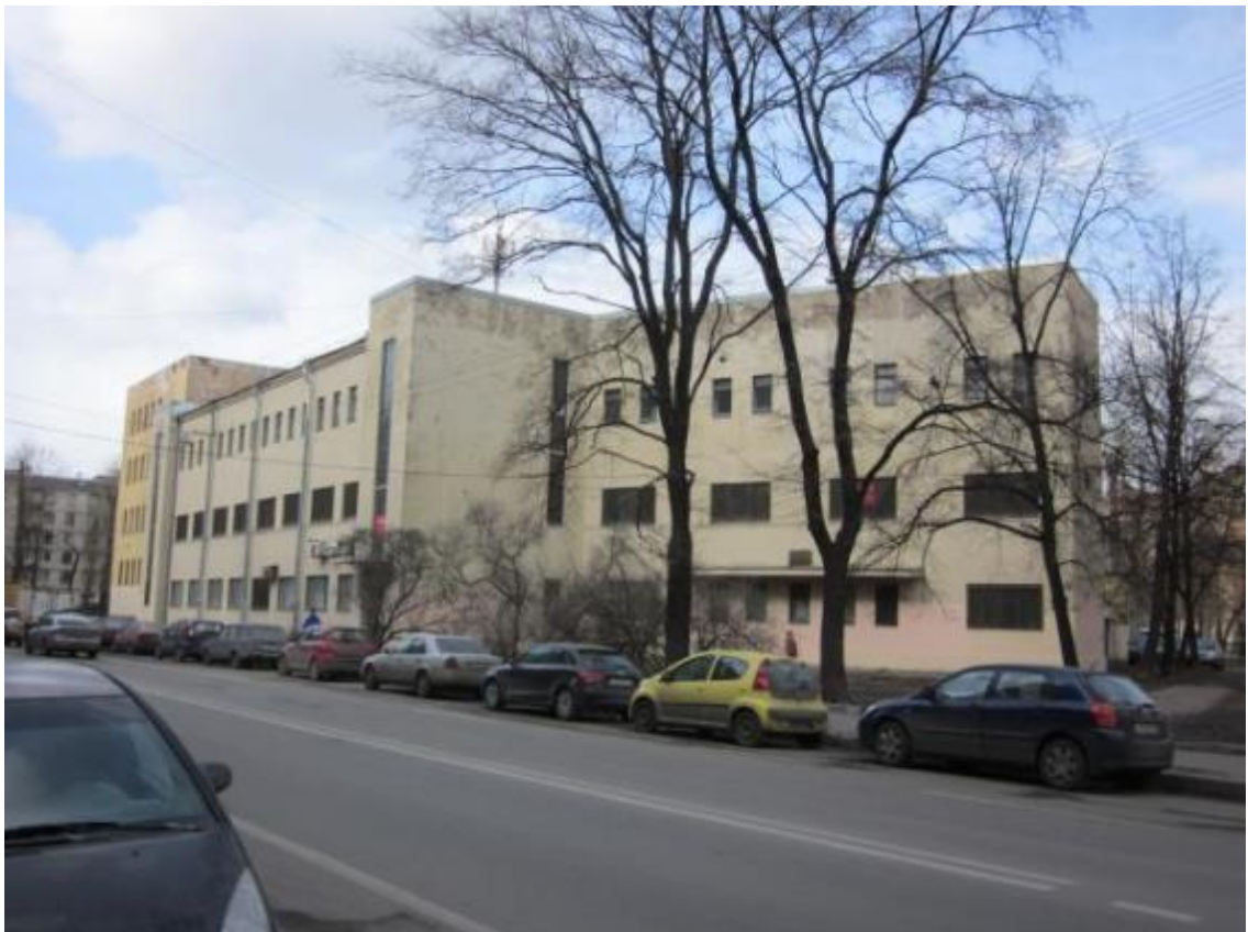
Илл. 72. Петроградская АТС, ул. Ленина, 5. 2009 г. https://p0.citywalls.ru/photo_124-127980.jpg?mt=1339514324
