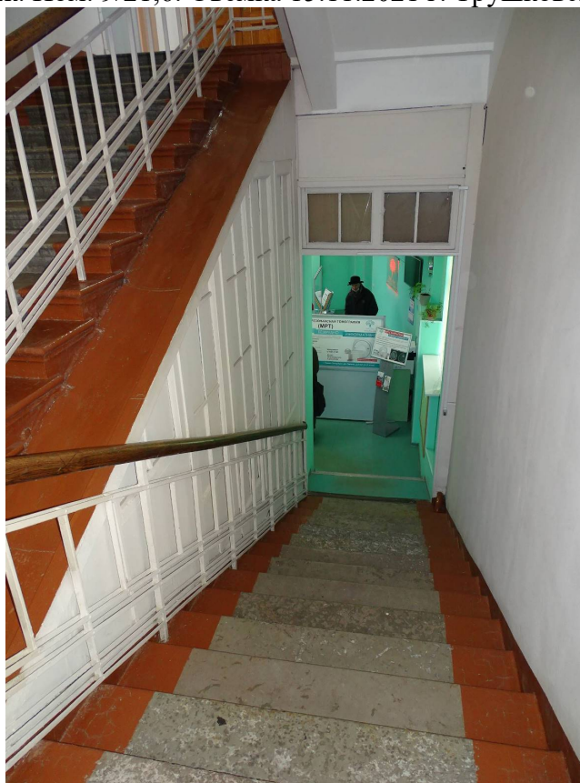
Фото 65. Выявленный объект культурного наследия «Здание Петроградской АТС» Центральная лестница. 1-й этаж. Съемка 15.11.2021 г. Трушковский В.Э.
