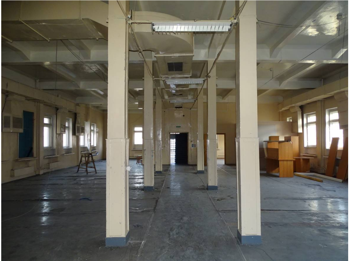
Фото 55. Выявленный объект культурного наследия «Здание Петроградской АТС» 3-й этаж. Пом. 18/291,7. Съемка 15.11.2021 г. Трушковский В.Э.
