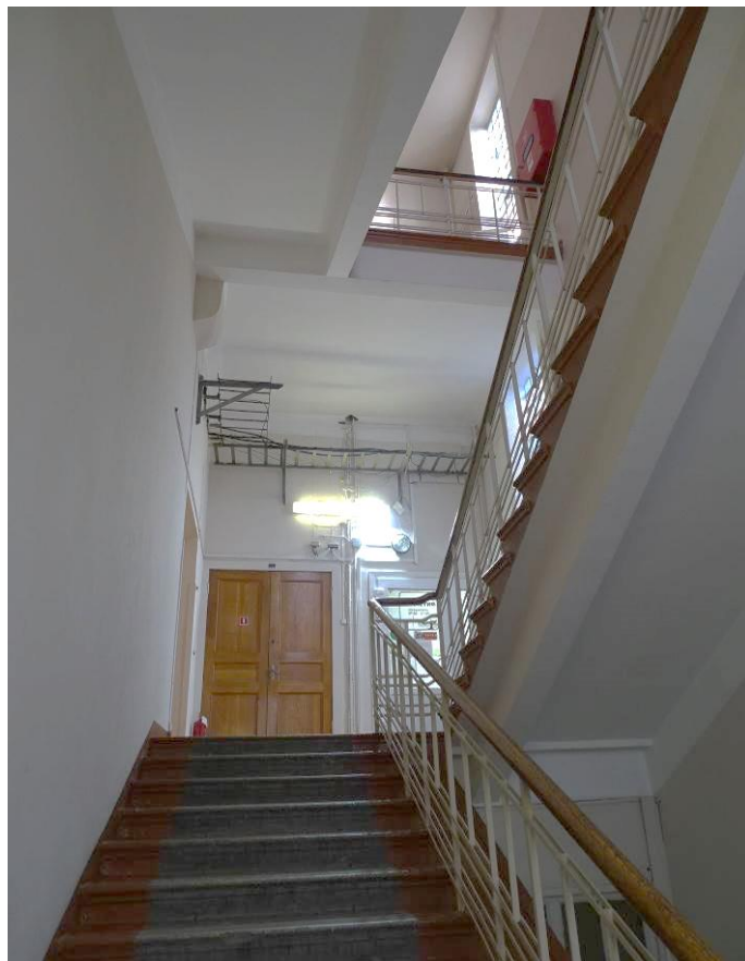
Фото 69. Выявленный объект культурного наследия «Здание Петроградской АТС» Центральная лестница. Площадка 2-го этажа. Съемка 15.11.2021 г. Трушковский В.Э.
