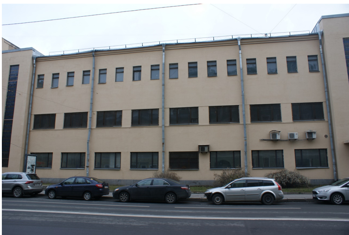
Фото 6. Выявленный объект культурного наследия «Здание Петроградской АТС» (ул. Ленина, д. 5, лит. А). Юго-восточный фасад. Фрагмент. Съемка 15.11.2021 г. Трушковский В.Э.
