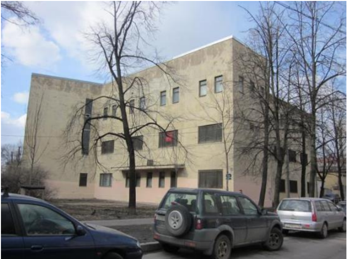
Илл. 74. Петроградская АТС. Вид с ул. Ленина Старый корпус. https://p3.citywalls.ru/photo_124-127979.jpg?mt=1339514305
