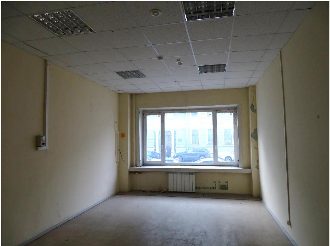
Фото 15. Выявленный объект культурного наследия «Здание Петроградской АТС» 1-й этаж. Пом. 8/254,5. Съемка 15.11.2021 г. Трушковский В.Э.
