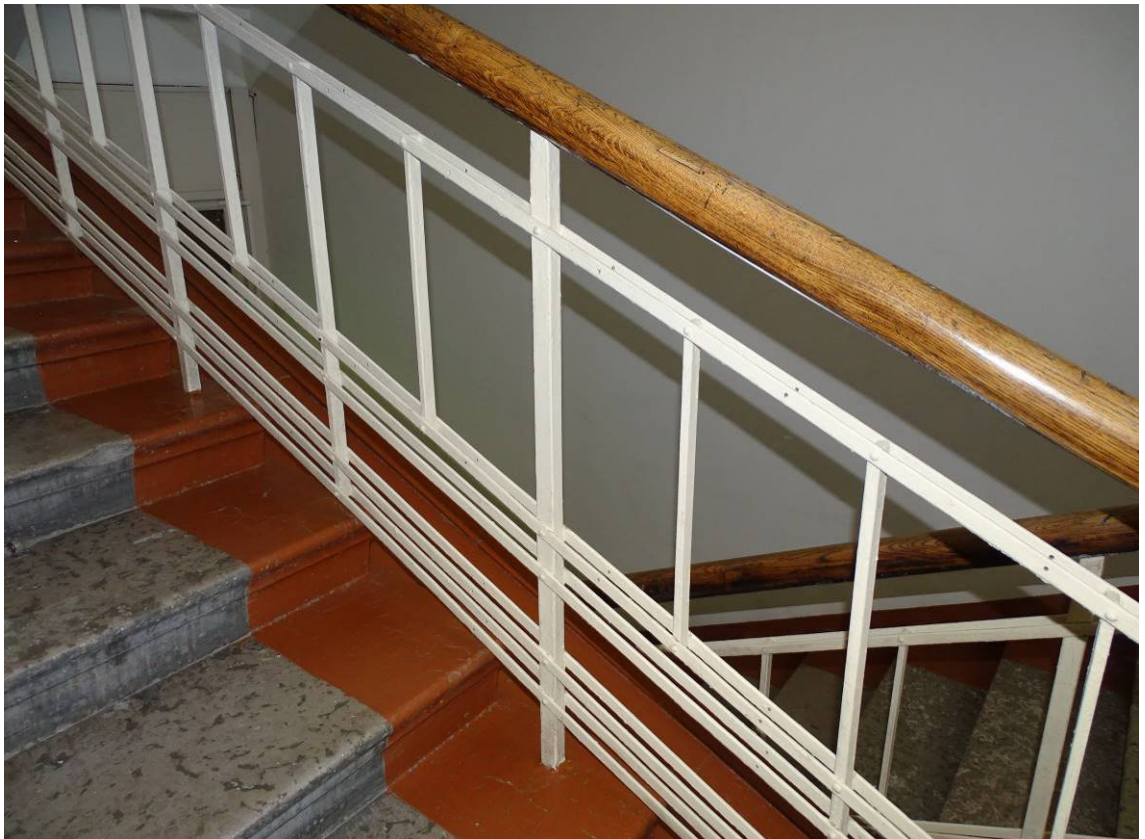
Фото 70. Выявленный объект культурного наследия «Здание Петроградской АТС» Центральная лестница. Лестничное ограждение. Съемка 15.11.2021 г. Трушковский В.Э.
