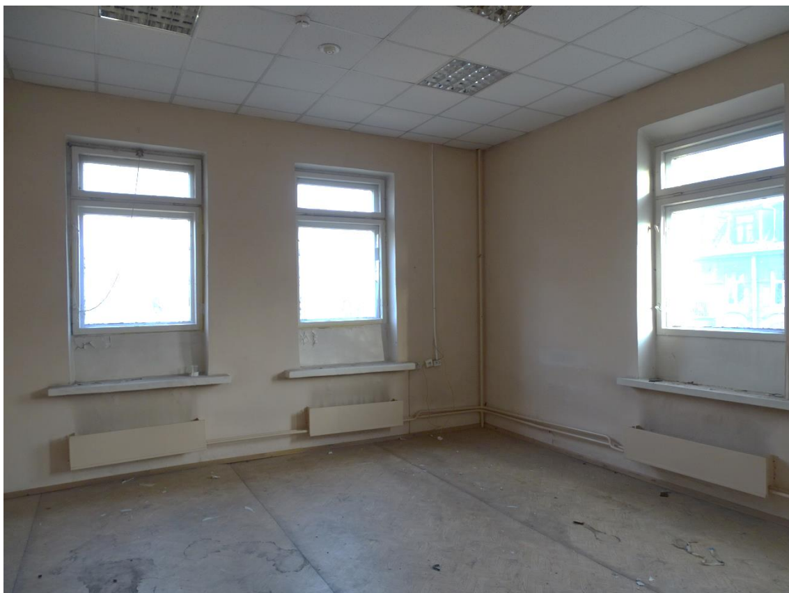
Фото 53. Выявленный объект культурного наследия «Здание Петроградской АТС» 3-й этаж. Пом. 18/291,7. Съемка 15.11.2021 г. Трушковский В.Э.
