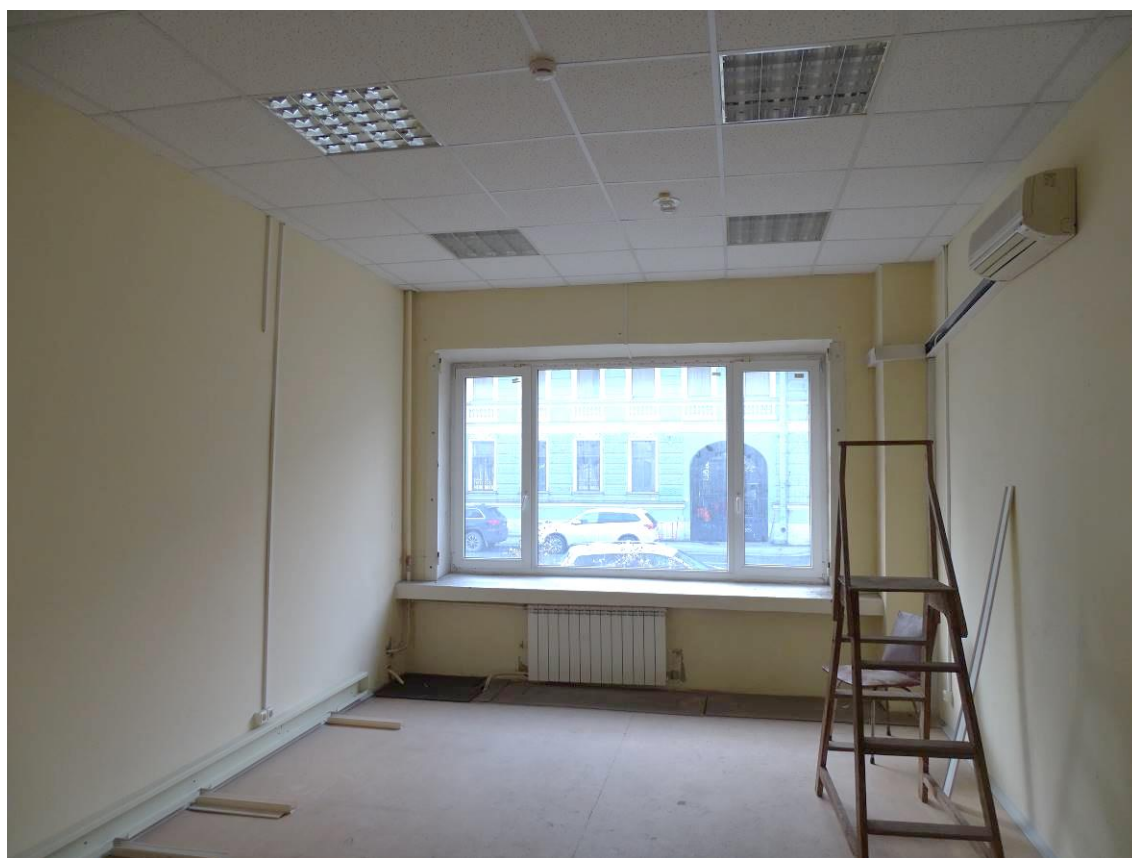
Фото 12. Выявленный объект культурного наследия «Здание Петроградской АТС» 1-й этаж. Пом. 8/254,5. Съемка 15.11.2021 г. Трушковский В.Э.
