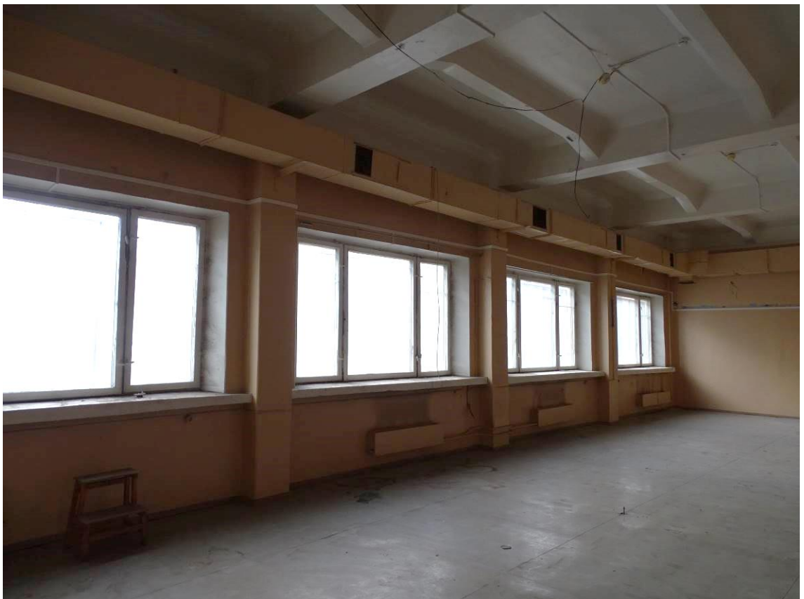
Фото 24. Выявленный объект культурного наследия «Здание Петроградской АТС» 2-й этаж. Пом. 5/184,4. Съемка 15.11.2021 г. Трушковский В.Э.
