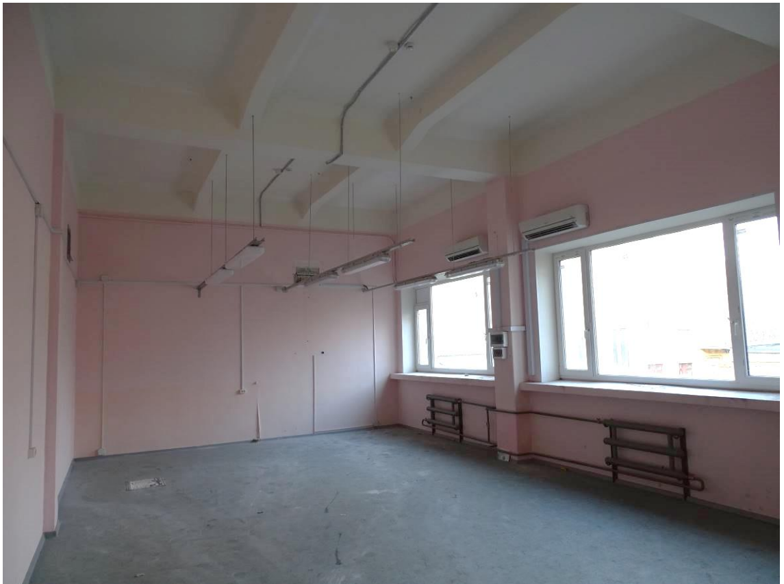
Фото 25. Выявленный объект культурного наследия «Здание Петроградской АТС» 2-й этаж. Пом. 5/184,4. Съемка 15.11.2021 г. Трушковский В.Э.
