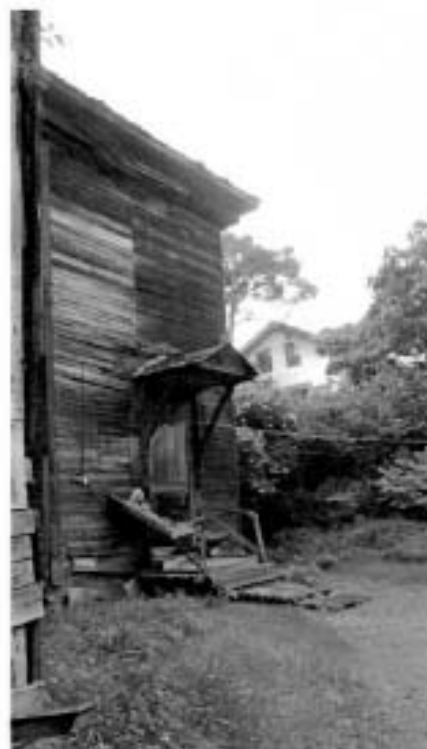
Фото 4. Фрагмент южного фасада
