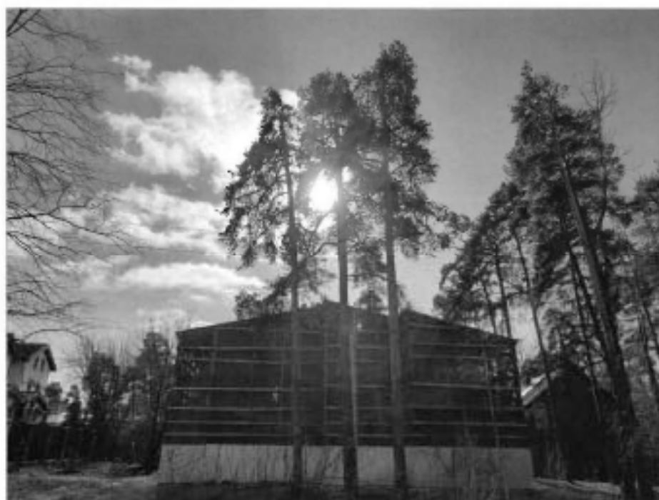
1. Общий вид со стороны северного фасада
