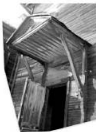
Фото 9. Фрагмент южного фасада. Козырек над крыльцом
