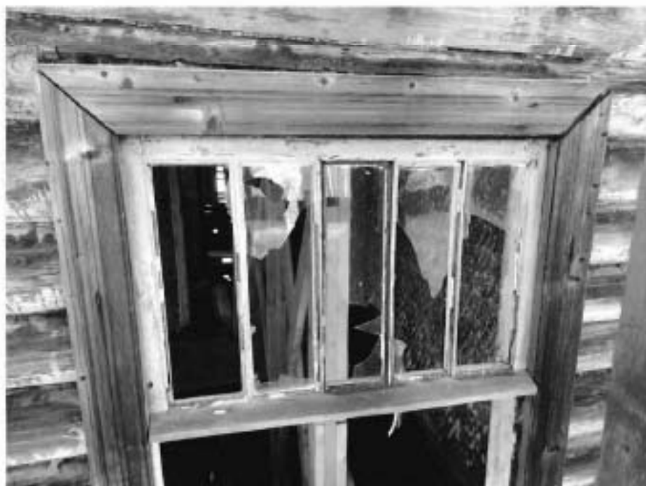
3. Историческая расстекловка оконных проемов
