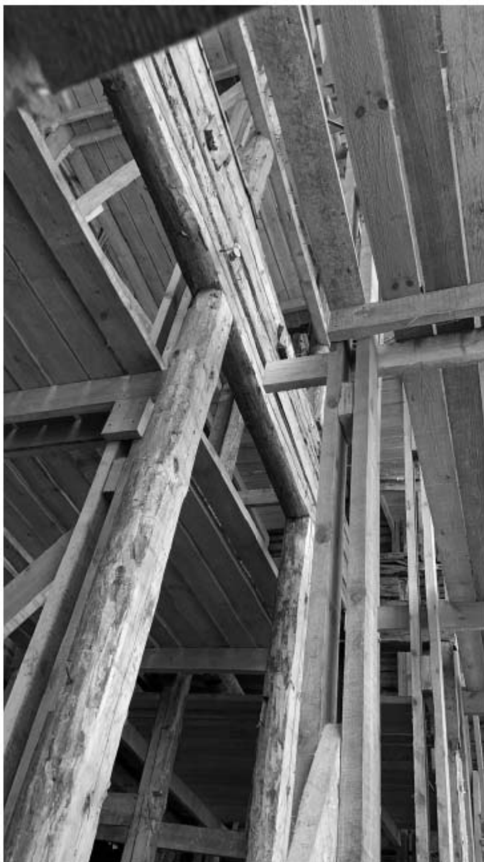
Фото 13. Вид с северо-западного угла здания под защитным сооружением. Фасад Н-А. Фото 1.07.2021 г.
