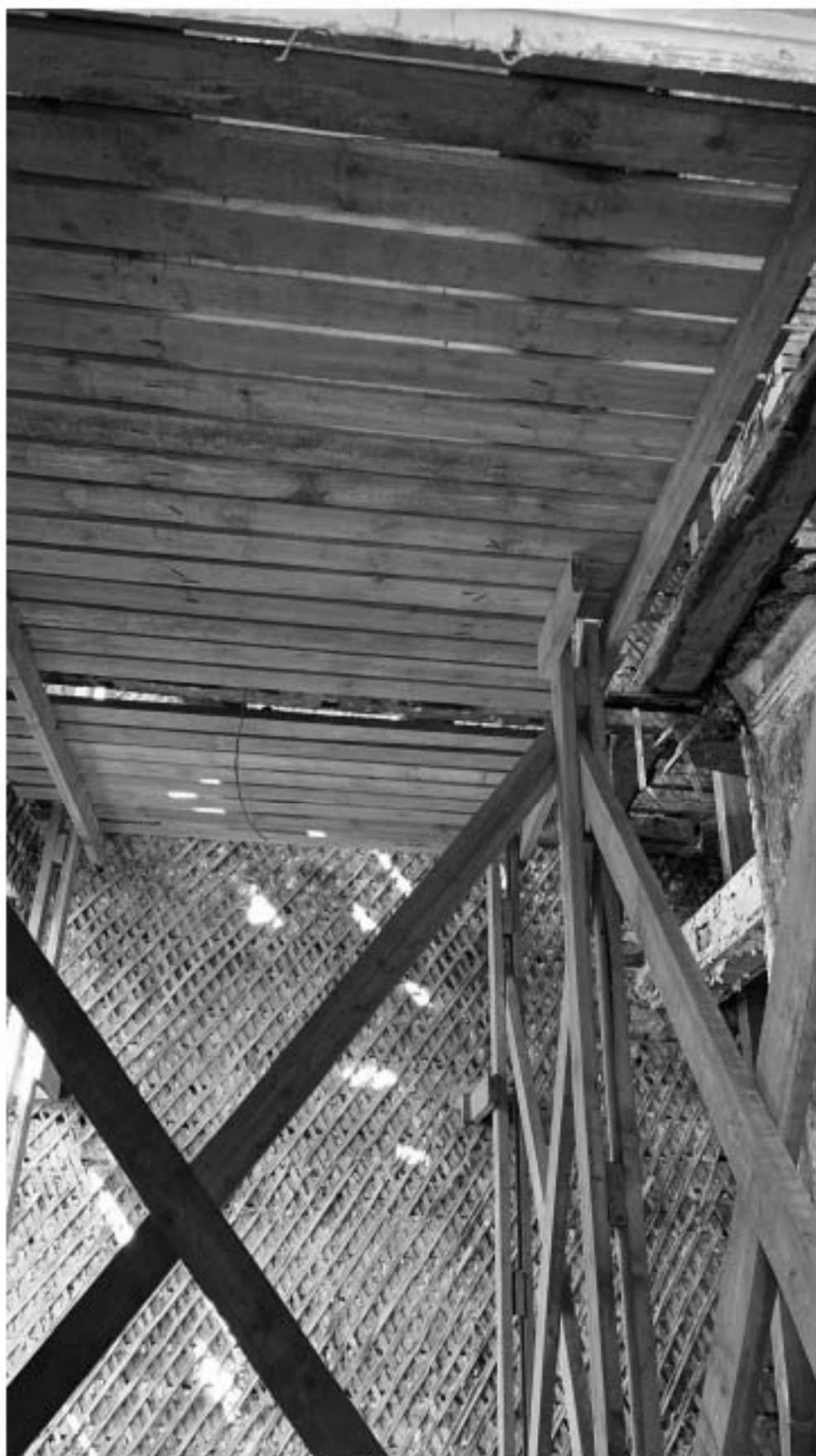
Фото 14. Вид на башню здания в осях 3-4;А-В под защитным сооружением. Фото 1.07.2021 г.
