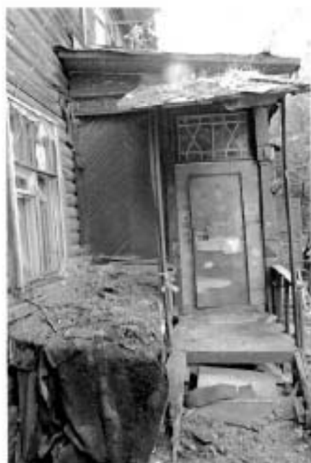
Фото 8. Крыльцо западного фасада
