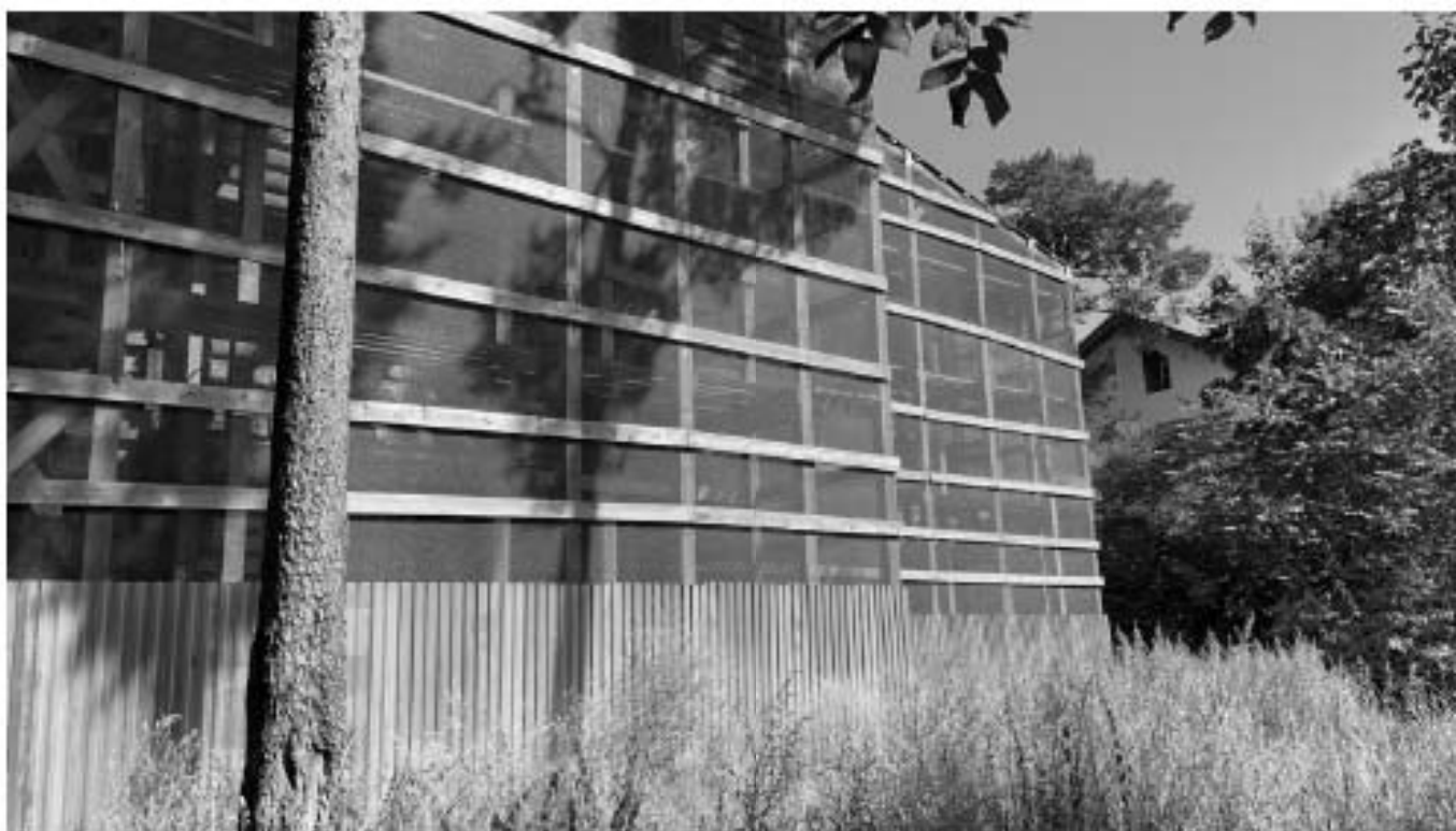
Фото 5. Вид на юго-восточный угол здания в защитном сооружении. Фасад А-Н. Фото 1.07.2021 г.
