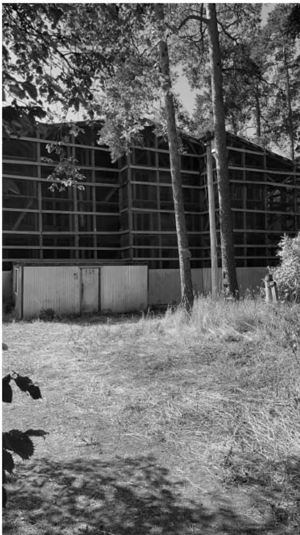
Фото 2. Вид с северной стороны здания в защитном сооружении. Фасад 1-9. Фото 1.07.2021 г.
