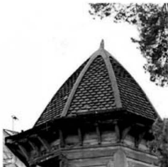
Фото 5. Фрагмент северного фасада. Крыша.
