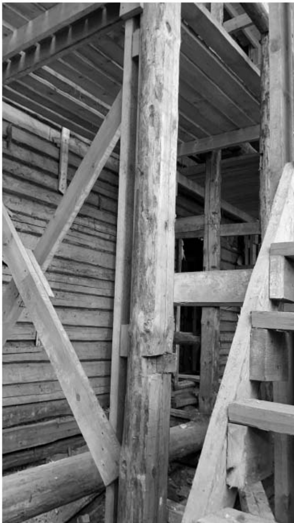
Фото 11. Вид с западной стороны здания под защитным сооружением. Фасад Н-А. Фото 1.07.2021 г.
