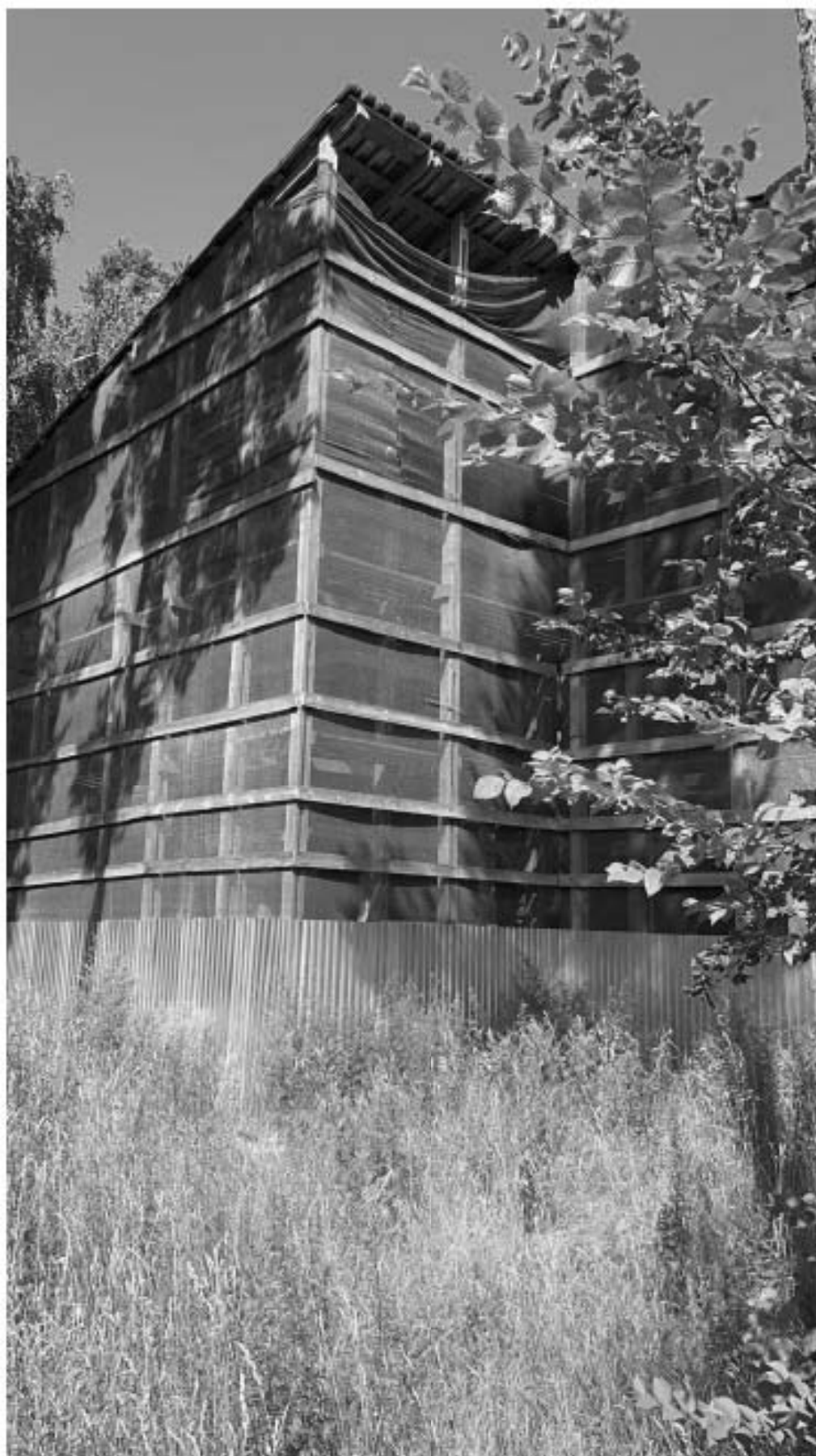
Фото 8. Вид на юго-западный угол здания в защитном сооружении. Фасад 9-1. Фото 1.07.2021 г.
