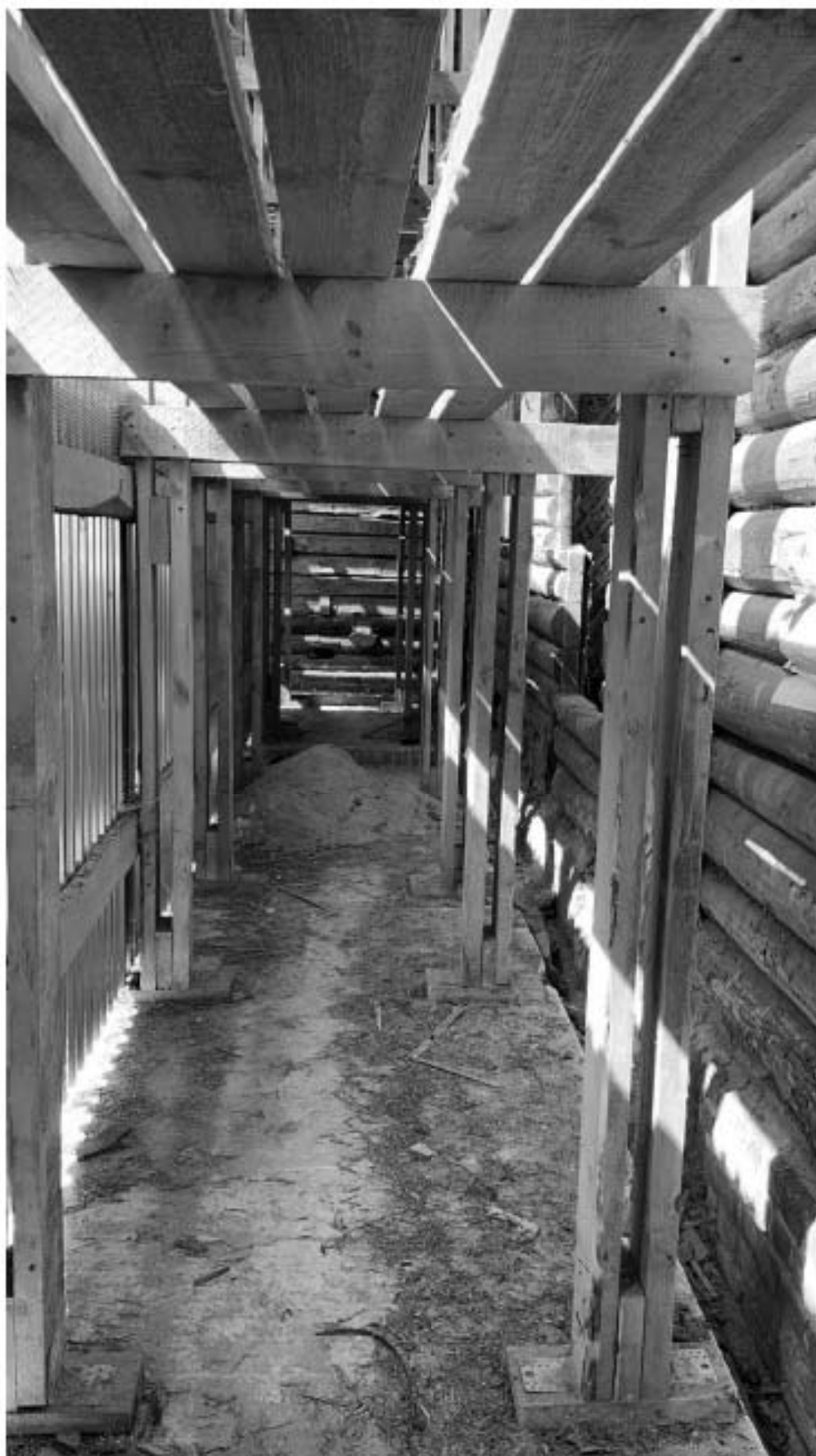
Фото 10. Вид на юго-западный угол здания в защитном сооружении. Фасад Н-А. Фото 1.07.2021 г.
