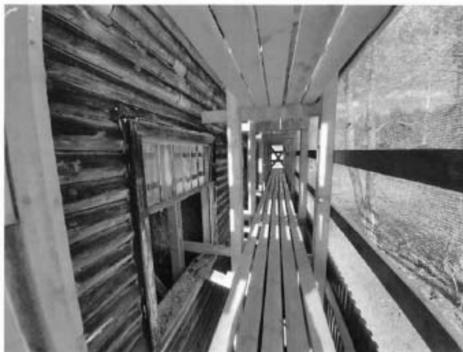
2. Вид на западный фасад со строительных лесов
