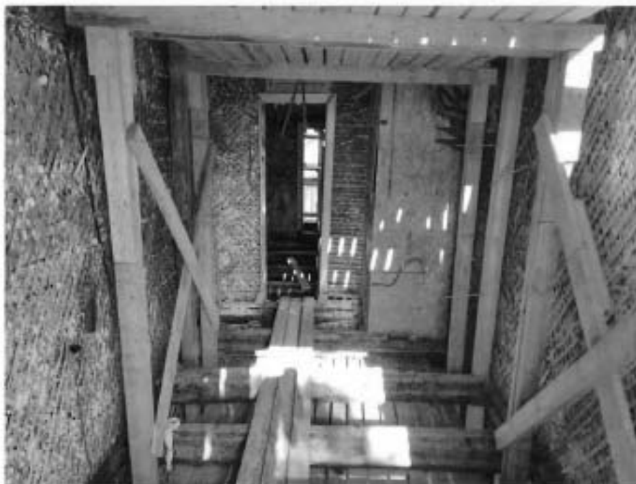
4. Вид на внутренние конструкции
