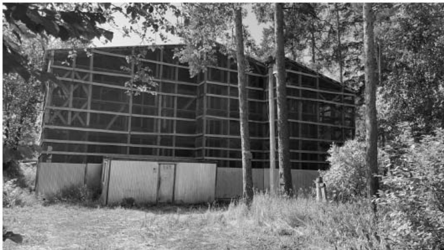
Фото 1. Общий вид здания в защитном сооружении с северной стороны. Фото 1.07.2021 г.
