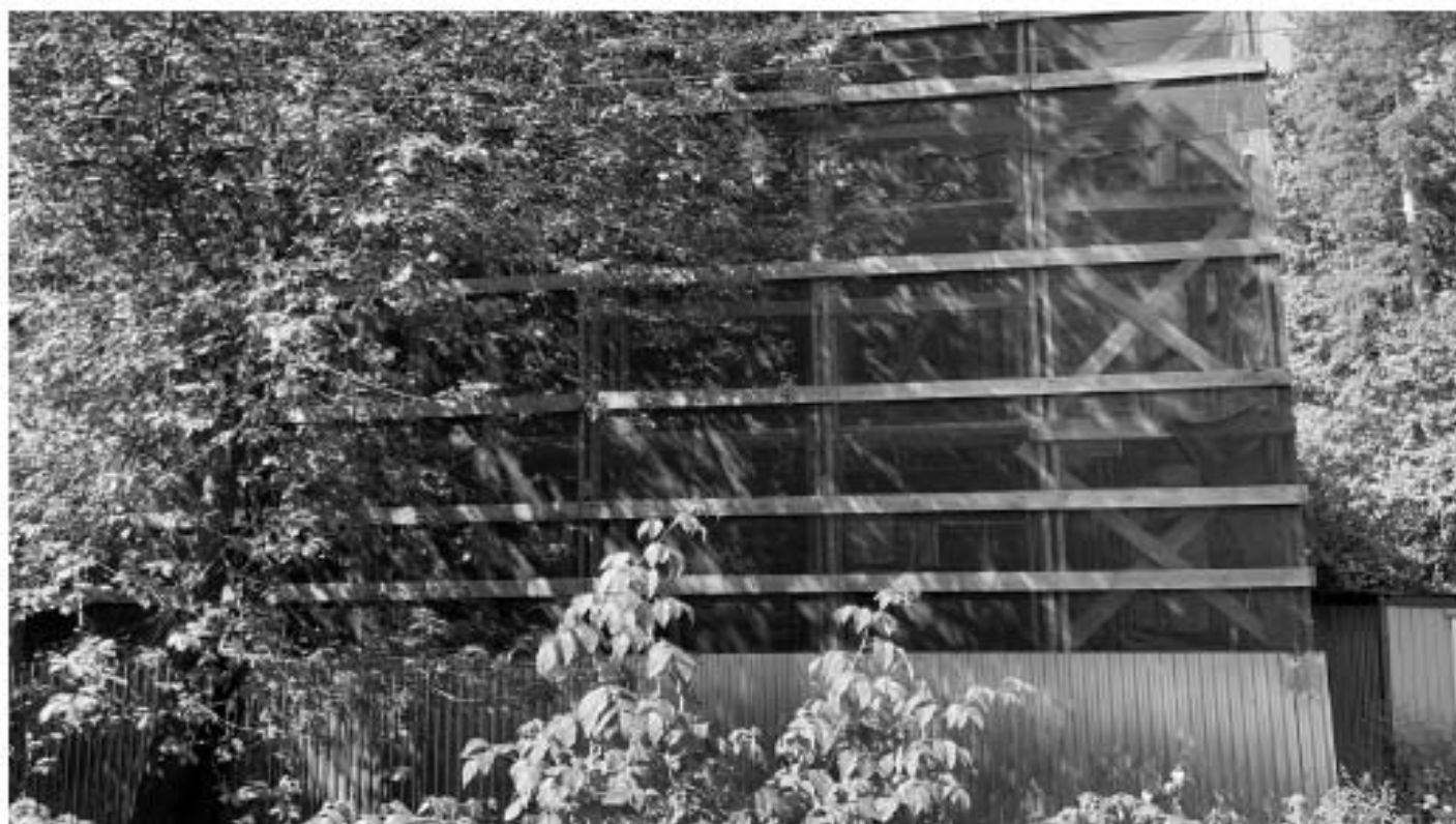
Фото 9. Вид с южной стороны здания в защитном сооружении. Фасад 9-1. Фото 1.07.2021 г.
