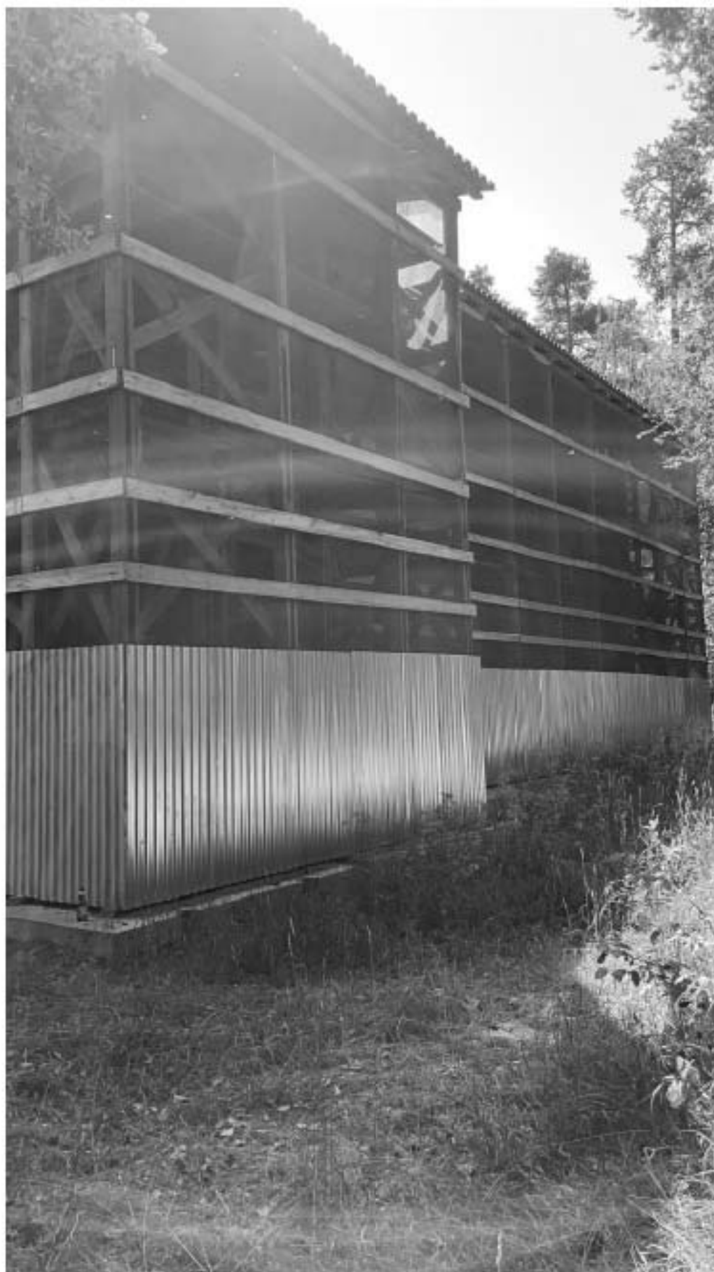
Фото 3. Вид с северо-восточного угла здания в защитном сооружении. Фасад А-Н. Фото 1.07.2021 г.
