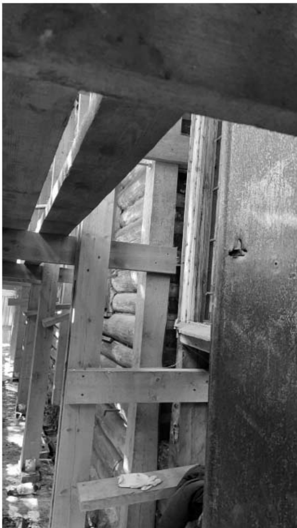
Фото 12. Вид с северо-западной стороны здания под защитным сооружением. Фасад Н-А. Фото 1.07.2021 г.
