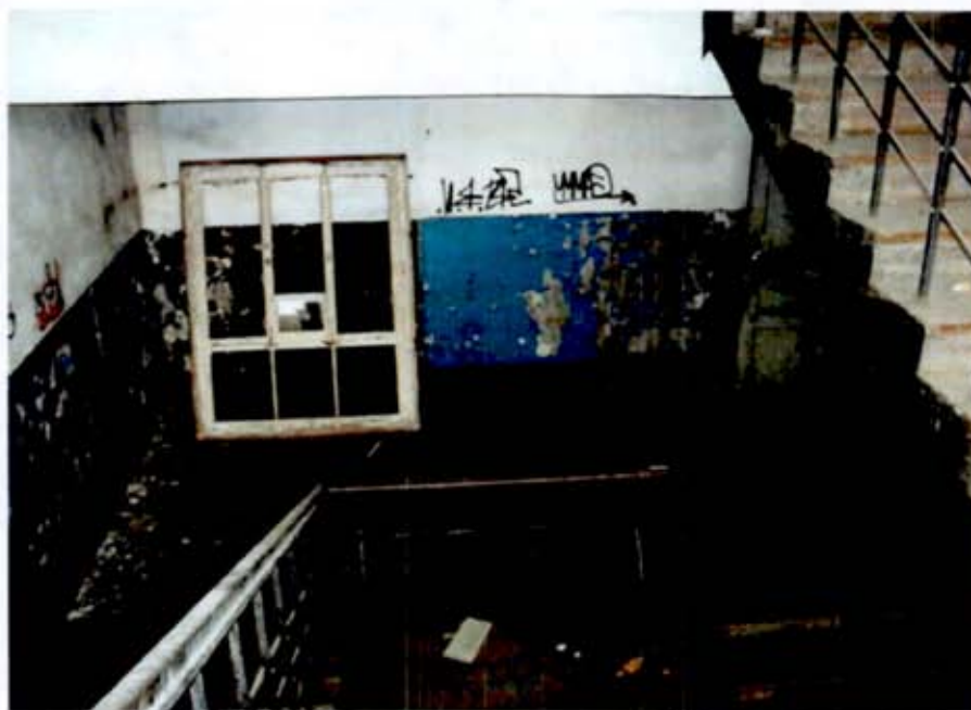
Фото 16. Центральная лестница в южной части здания.
