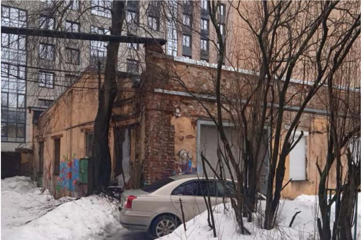
Фото 6. Здание литера Ц, общий вид со двора.
