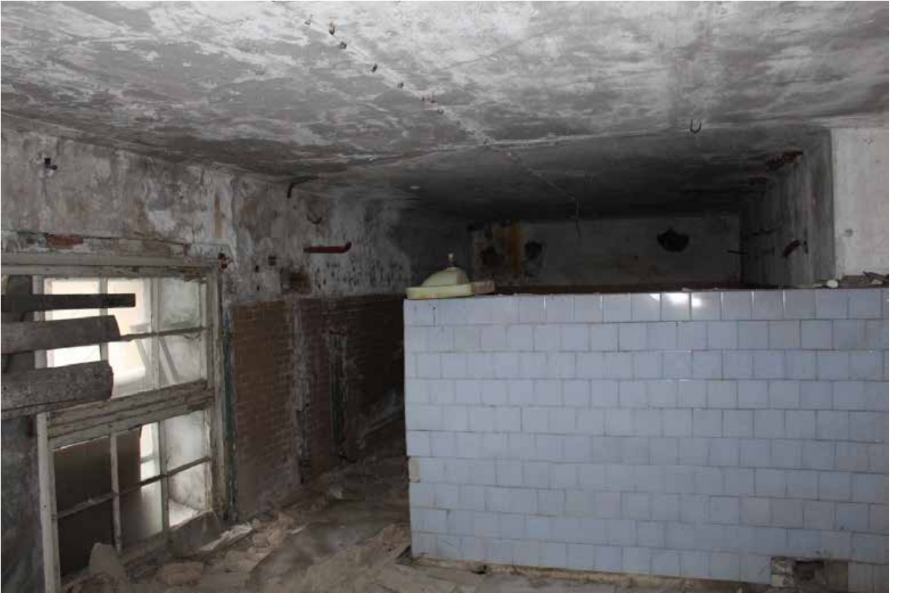
Фото 23. Помещение санузла в переходном блоке.
