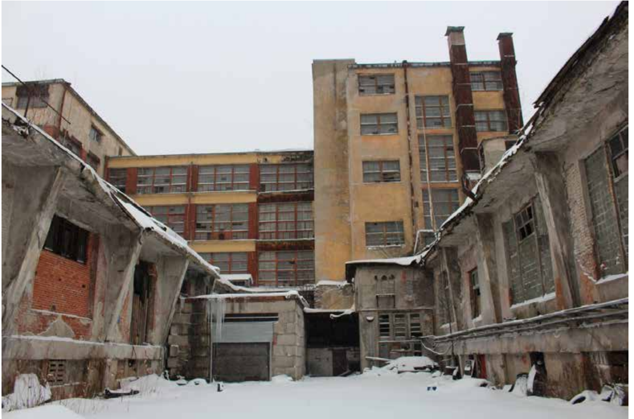
Фото 12. Вид дворового фасада с северо-запада.
