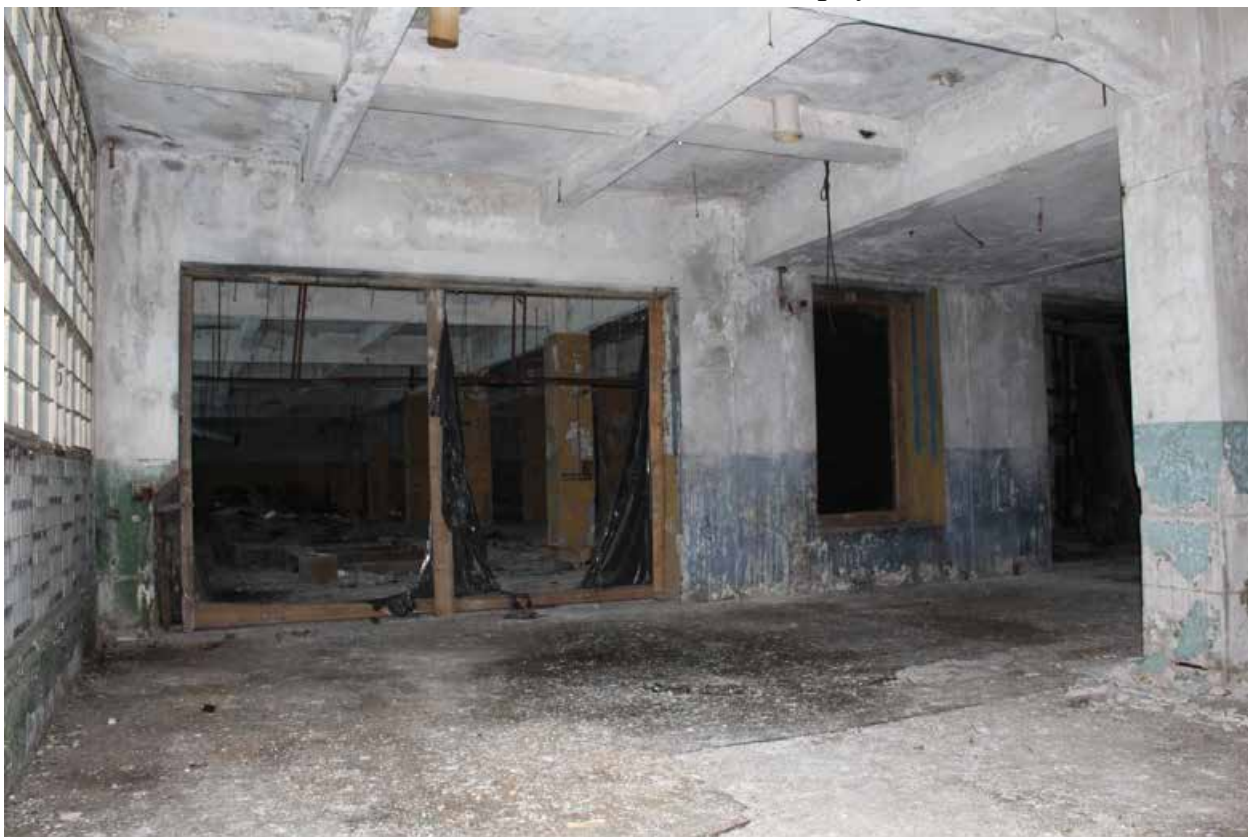
Фото 13. Вид на северо-запад, 1 этаж.
