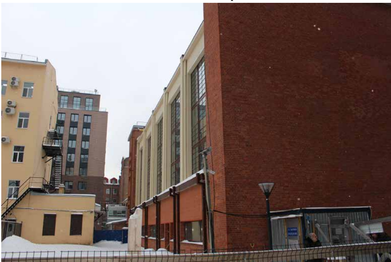
Фото 5. Вид вдоль юго-восточного фасада.
