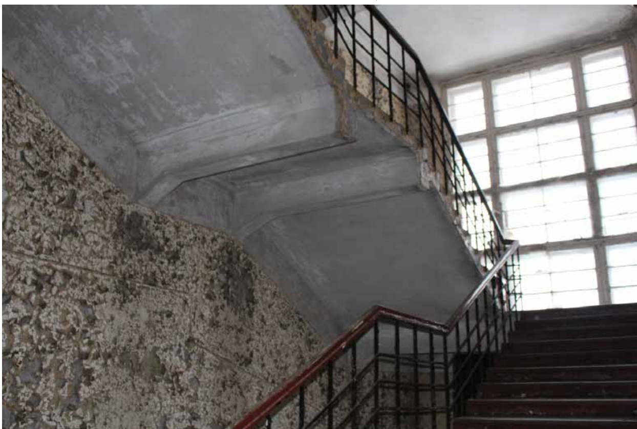
Фото 23. Вид на междуэтажную площадку Л-2, 4 этаж.
