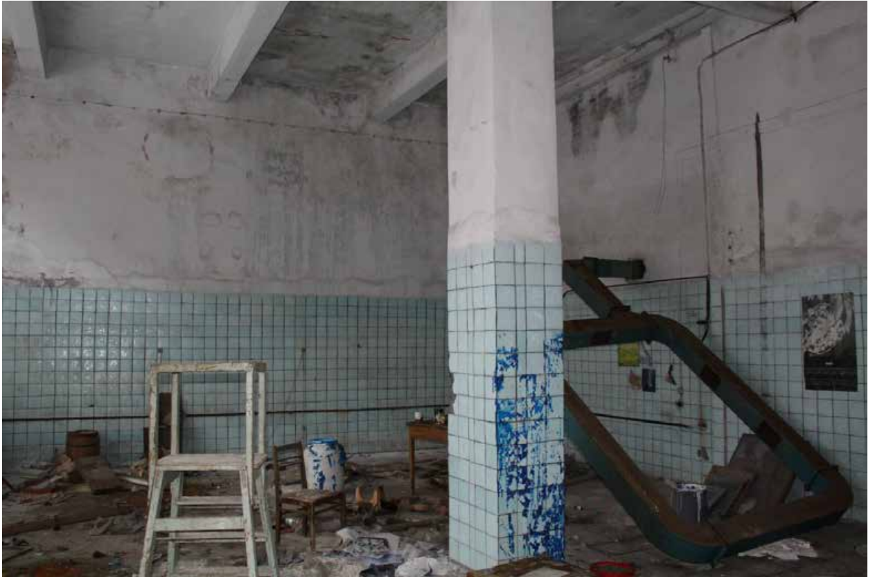
Фото 17. Помещение в переходном блоке.
