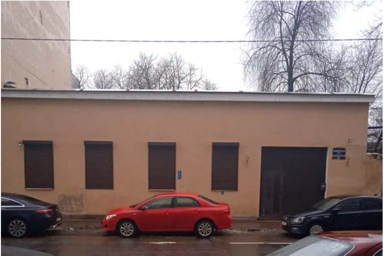
Фото 5. Здание литера Ц, лицевой фасад.
