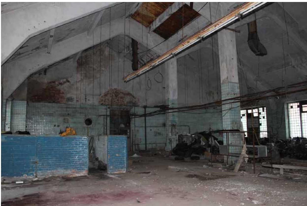
Фото 19. Примыкание чулочного цеха к корпусу.
