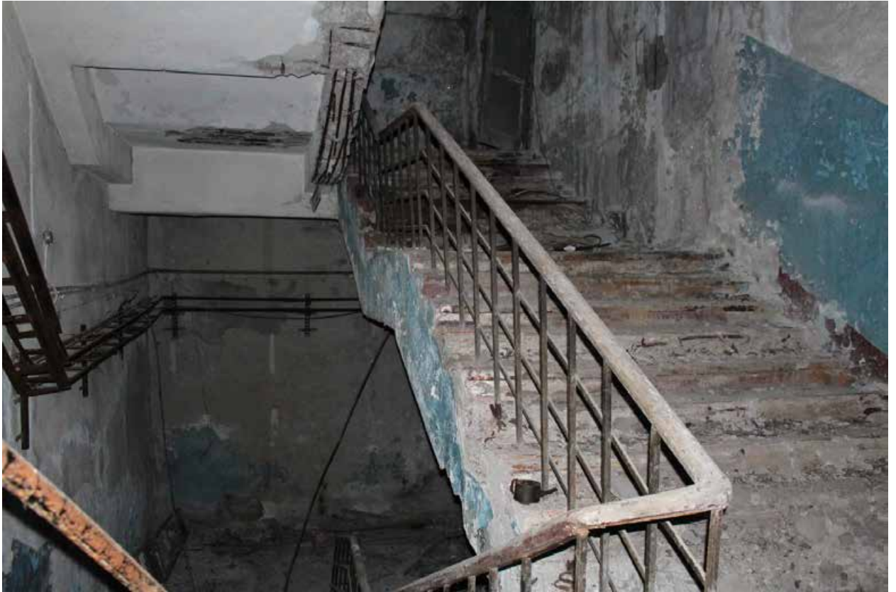
Фото 21. Лестница на 1 этаже.
