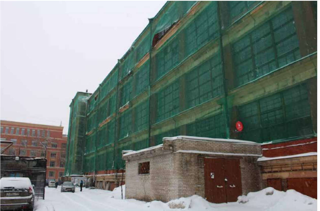
Фото 5. Юго-западная часть лицевого фасада.
