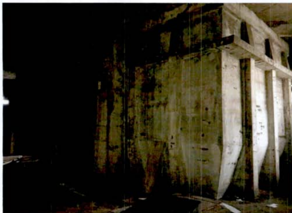
Фото 15. Железобетонный бак в бывш. отделение водоподготовки.
