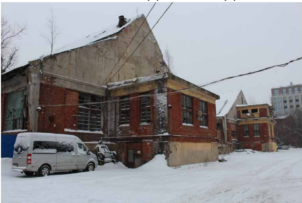
Фото 7. Вид на северные части отбельного и красильного корпусов.
