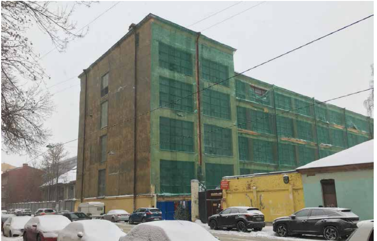
Фото 1. Общий вид с юго-востока.
