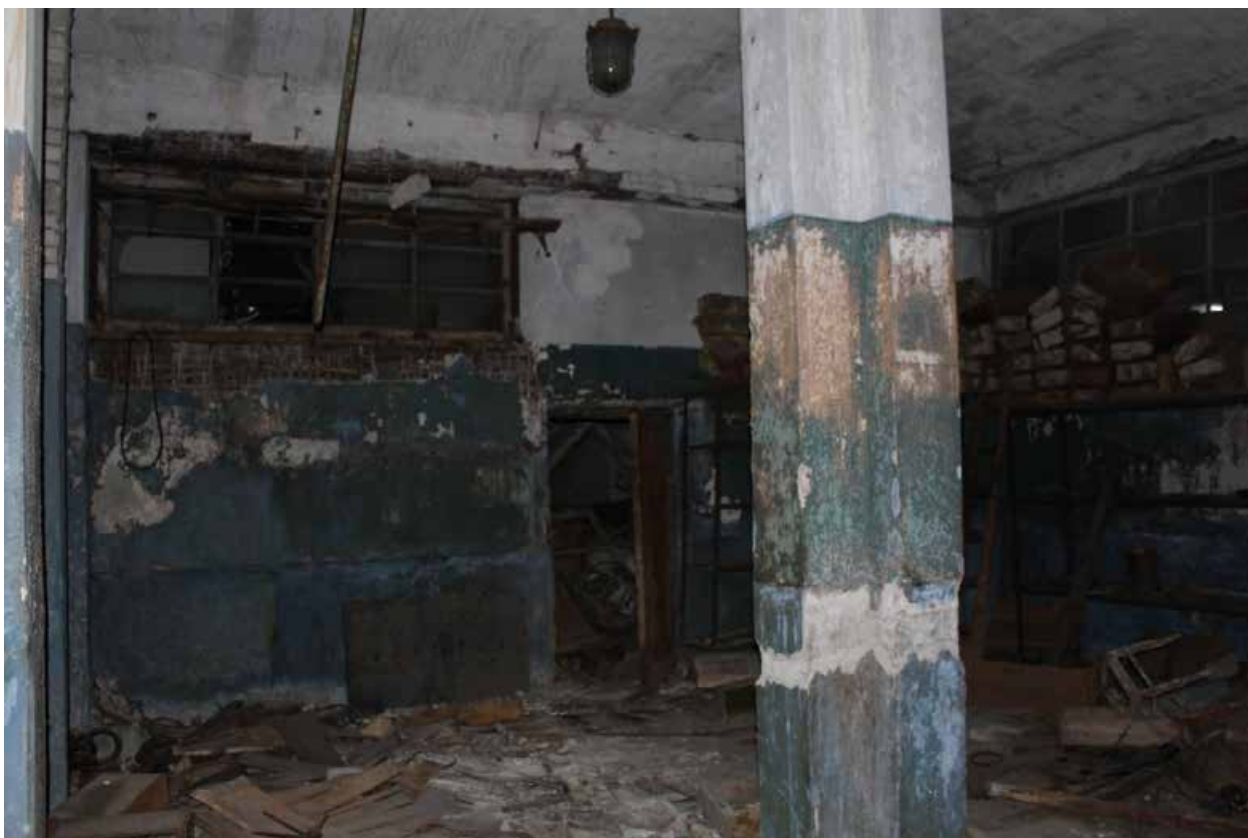
Фото 28. Помещение 4 пом. 39-Н, 5 этаж.
