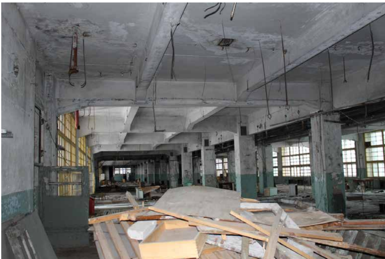
Фото 24. Вид на юго-восток, 4 этаж.
