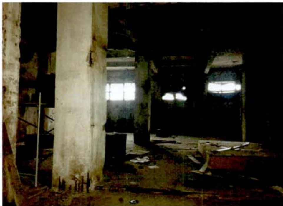
Фото 14. Бывш. отделение водоподготовки.
