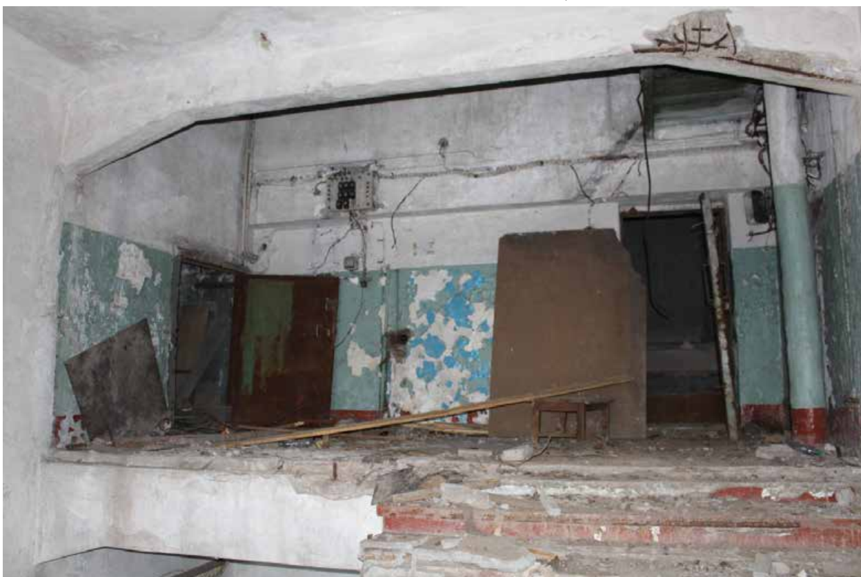
Фото 29. Площадка 5 этажа, Л-3.
