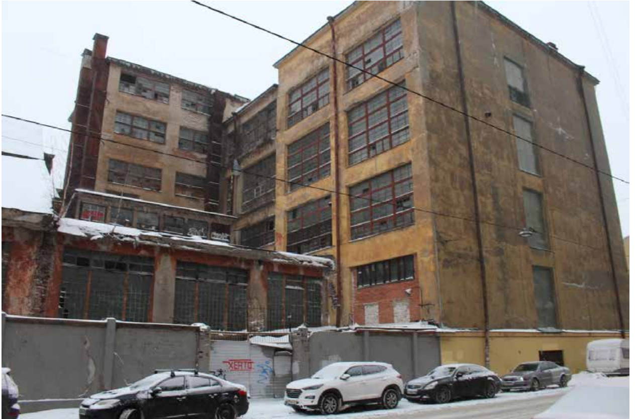
Фото 2. Вид переходного блока и четырехэтажного корпуса по Пионерской ул.
