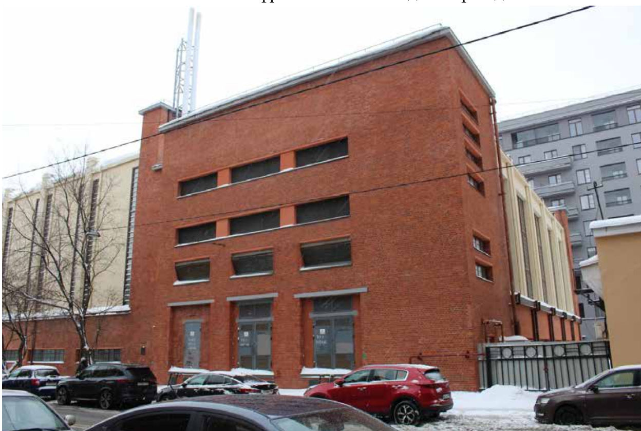
Фото 9. Вид с юга.
