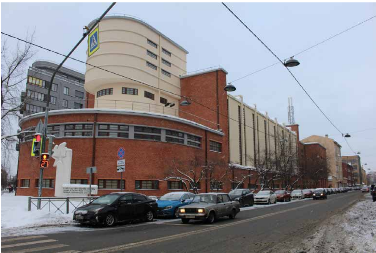
Фото 6. Общий вид с запада по Пионерской ул.
