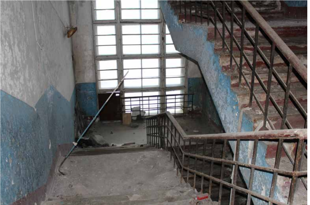
Фото 35. Лестница на третьем этаже.
