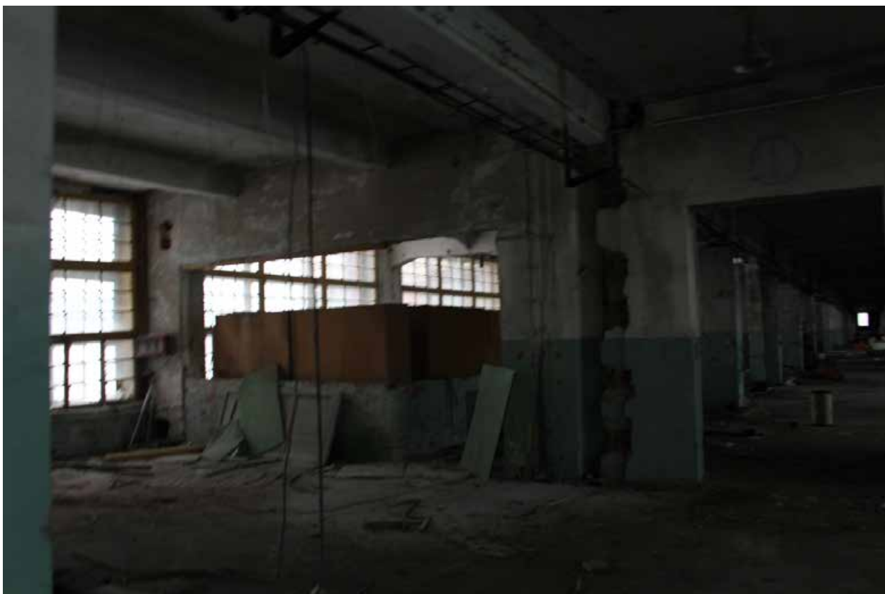
Фото 37. Проемы в стене, примыкающей к объекту культурного наследия.
