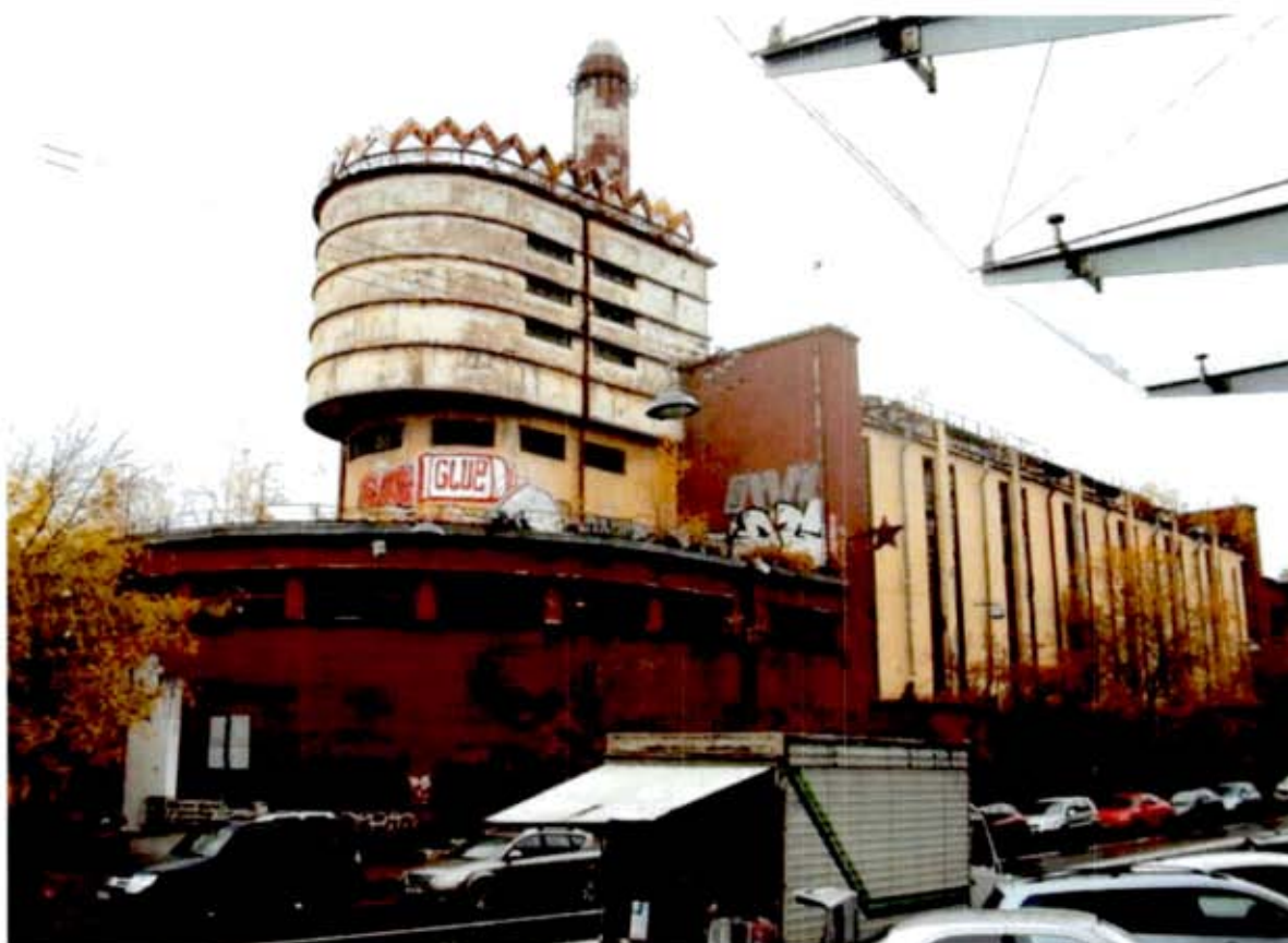
Фото 1. Полуциркульный северо-западный фасад и юго-западный фасад.
