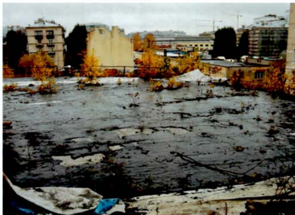
Фото 18. Кровля северо-западной части здания.
