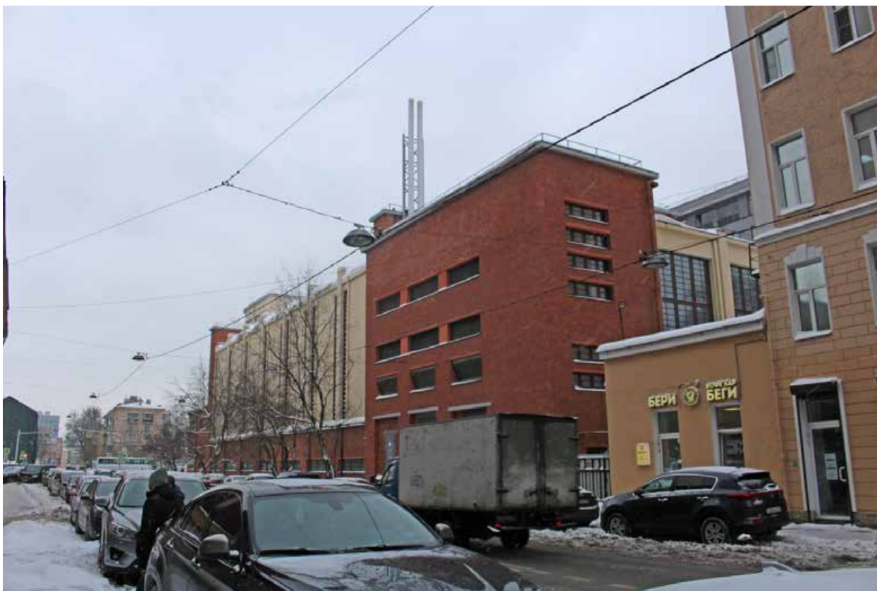
Фото 10. Общий вид с юго-востока.
