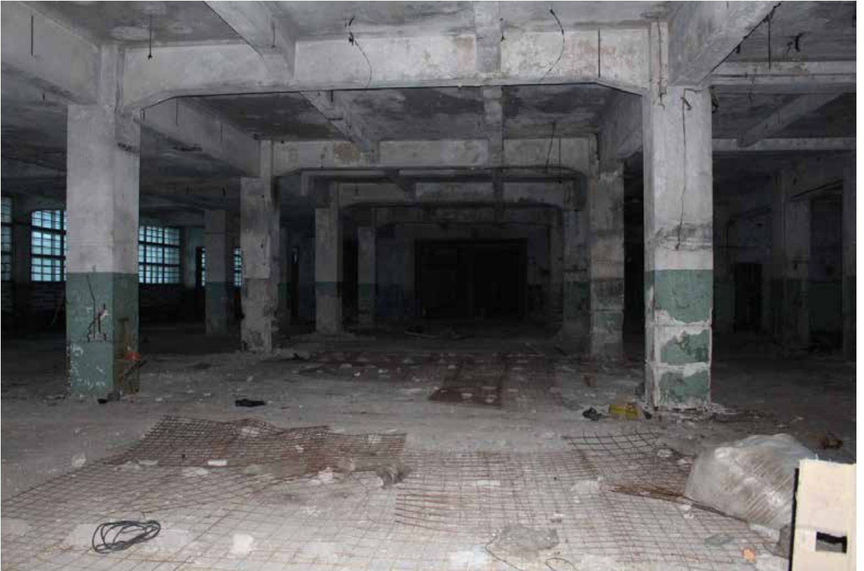
Фото 10. Вид на запад, центральная часть, 1 этаж.
