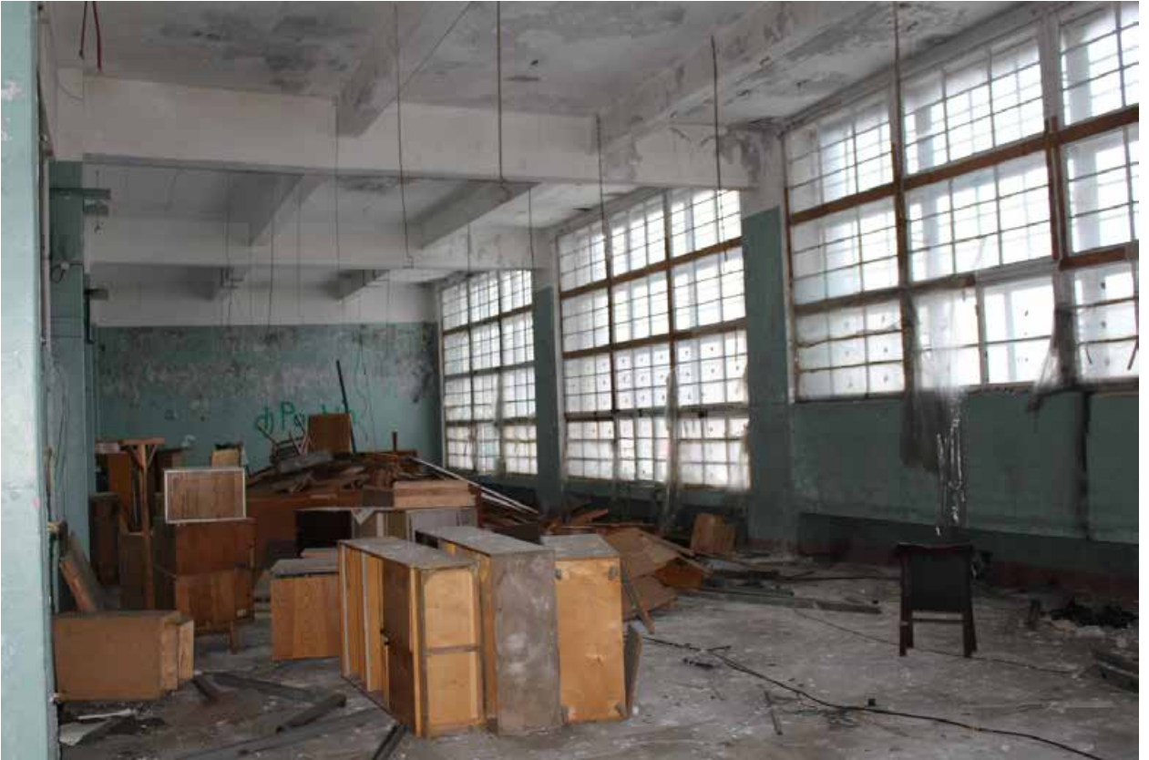
Фото 33. Помещение на северо-западе, 3 этаж.
