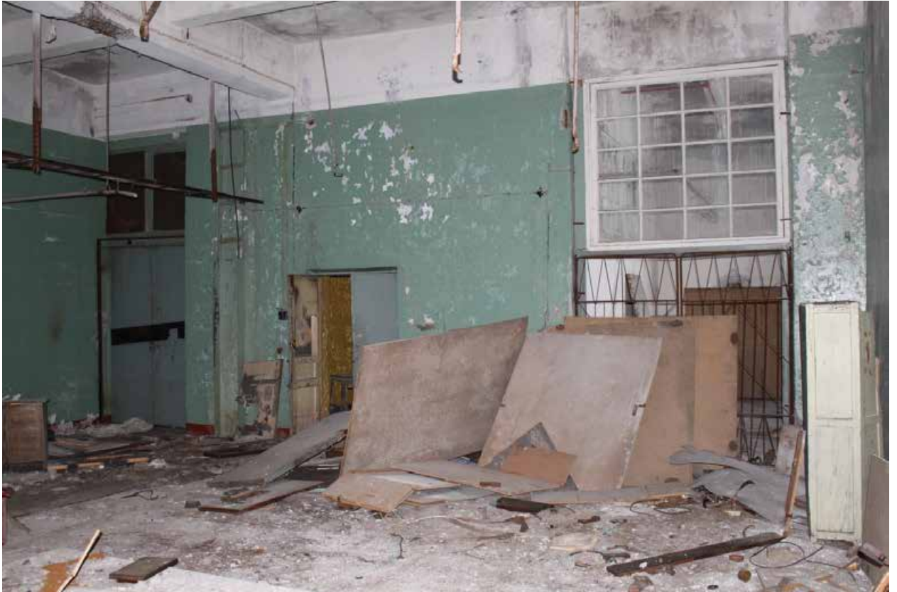
Фото 29. Вход и лифт, 3 этаж.
