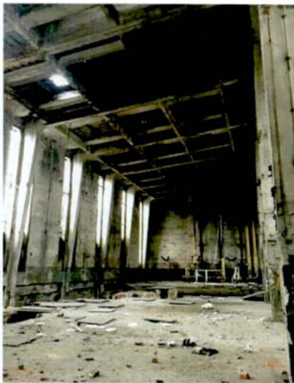
Фото 7. Бывш. котельный зал.
