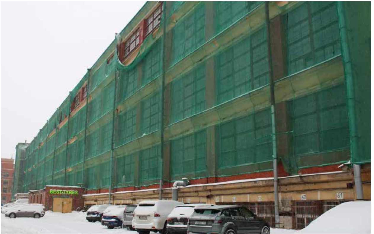
Фото 2. Вид вдоль южного фасада, с востока.
