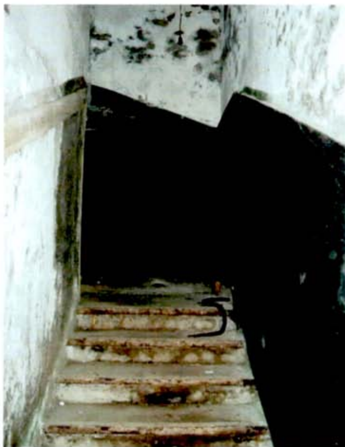
Фото 17. Лестница в северной части здания.
