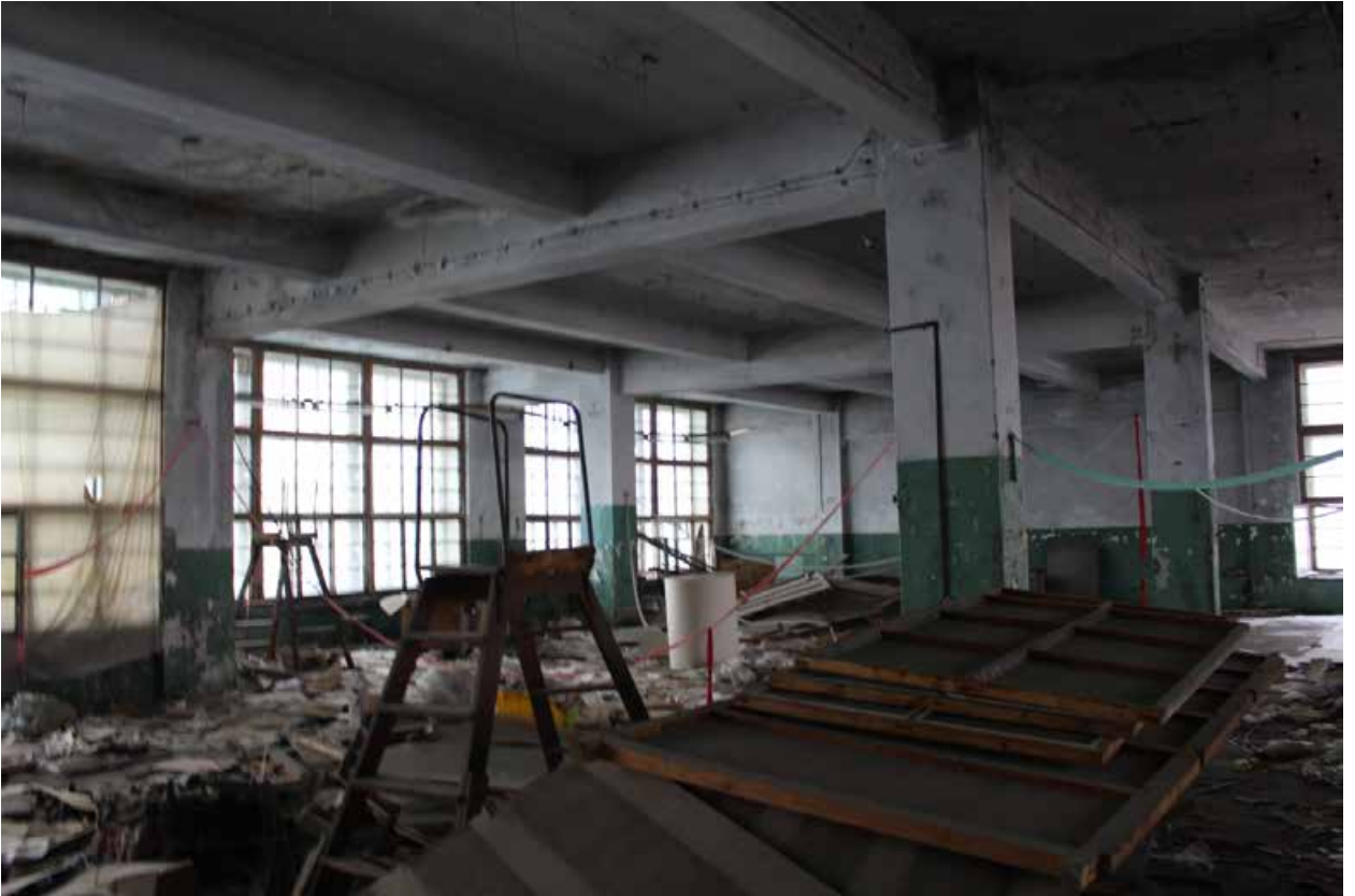
Фото 39. Помещение на юге, 4 этаж.
