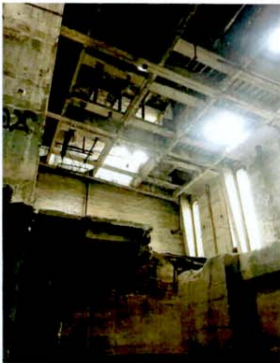
Фото 9. Бывш. котельный зал.
