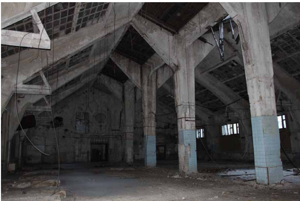
Фото 15. Общий вид красильного корпуса, 1 этаж.
