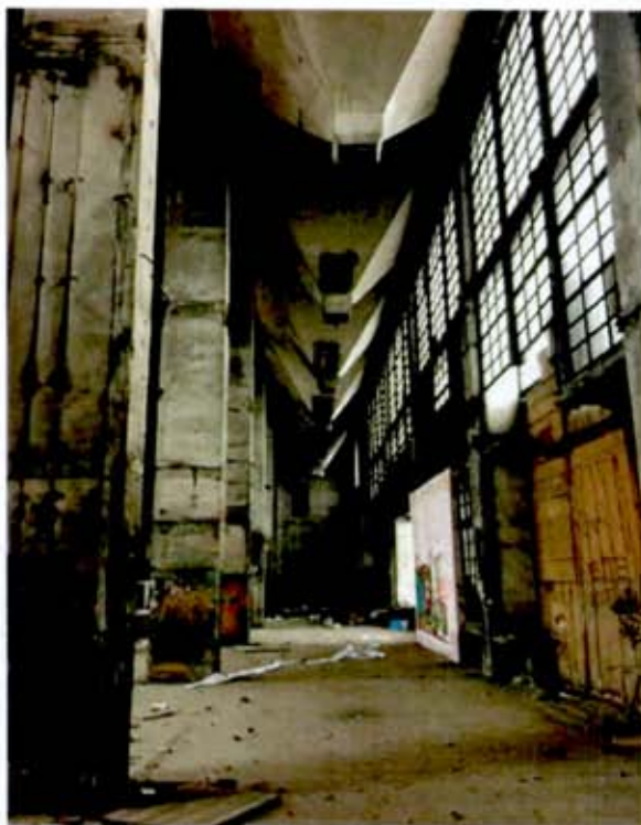
Фото 8. Бывш. котельный зал.
