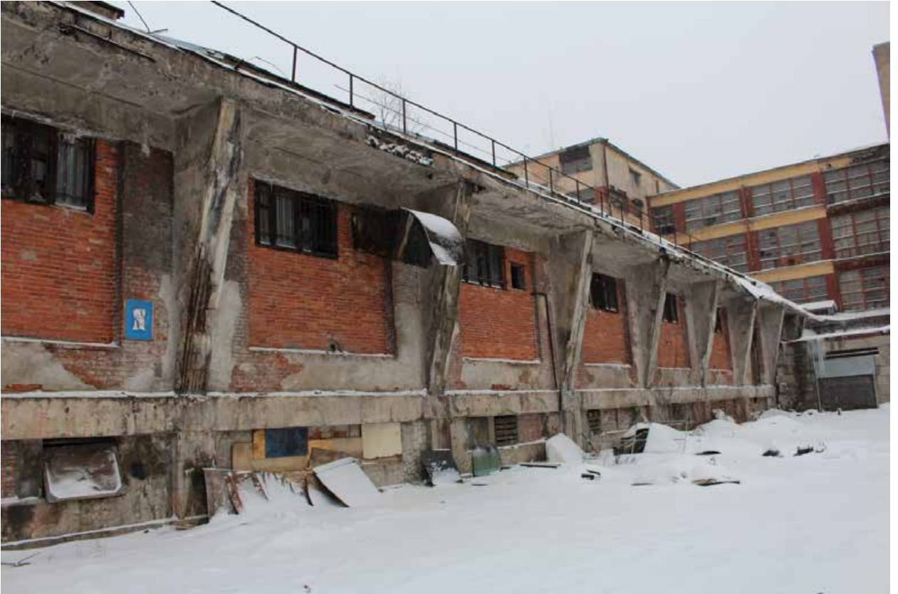
Фото 10. Западный фасад красильного корпуса.
