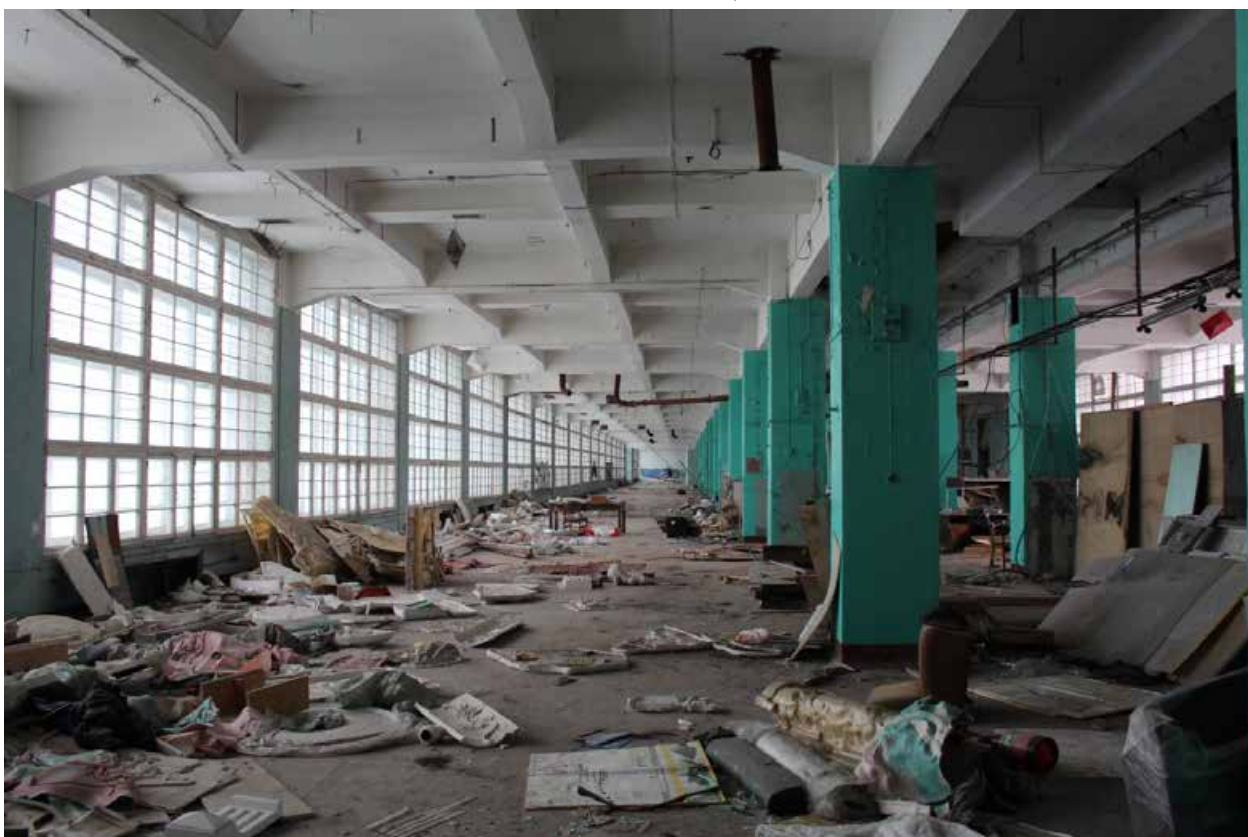
Фото 17.Общий вид, 2 этаж.
