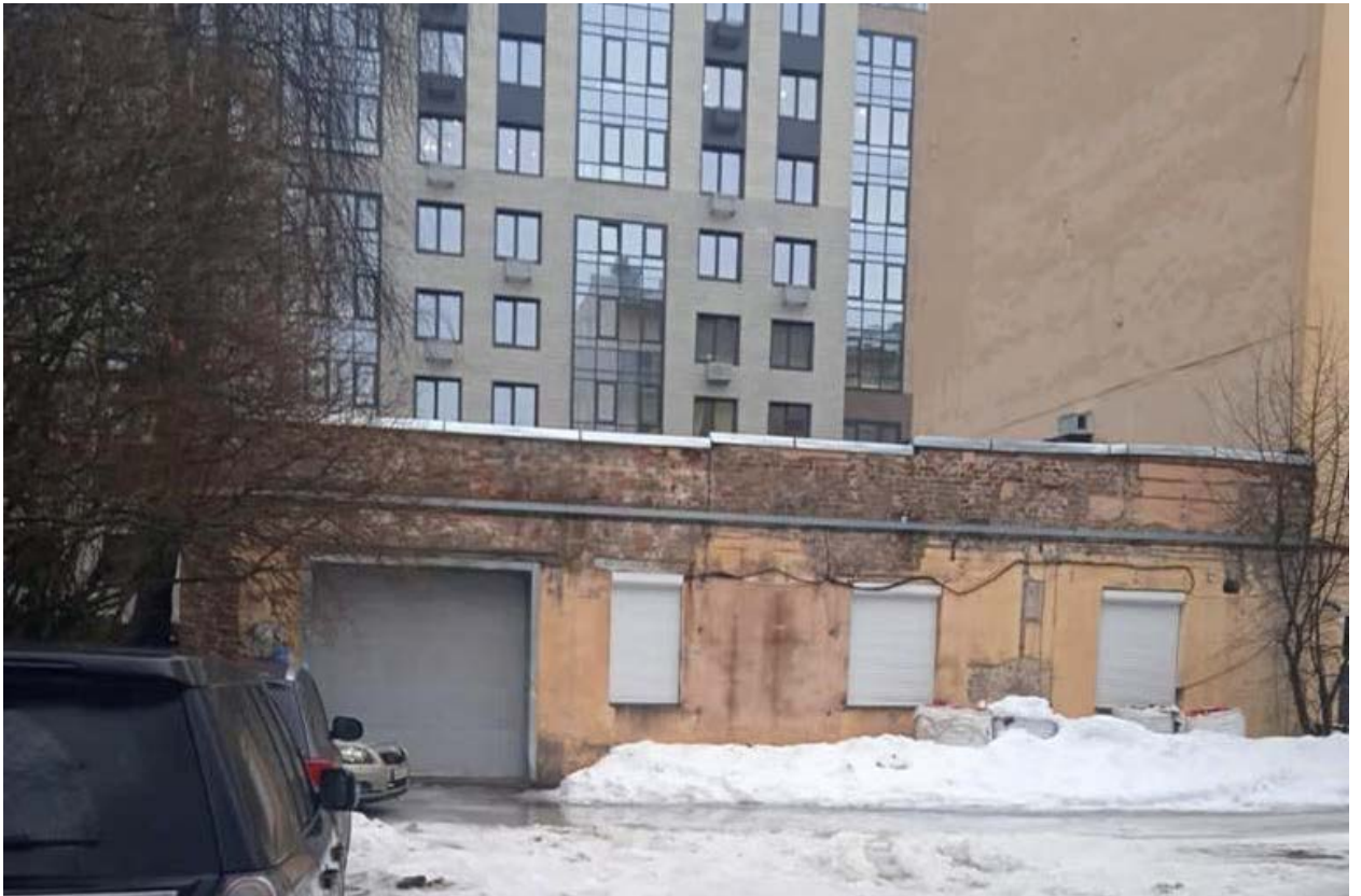
Фото 7. Здание литера Ц, дворовой фасад.
