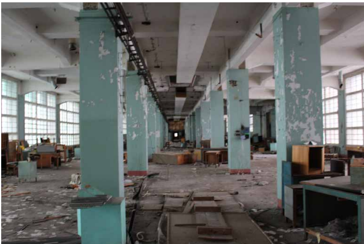
Фото 20. Общий вид с востока, 3 этаж.
