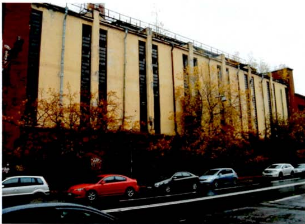
Фото 2. Фрагмент юго-западный фасад.
