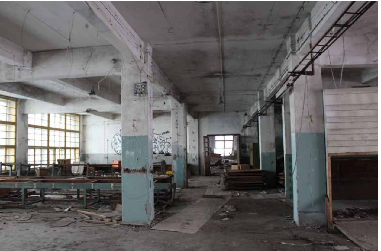
Фото 36. Общий вид 4 этажа.
