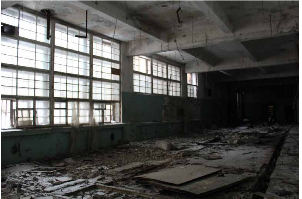
Фото 26. Вид на помещение на 2 этаже.
