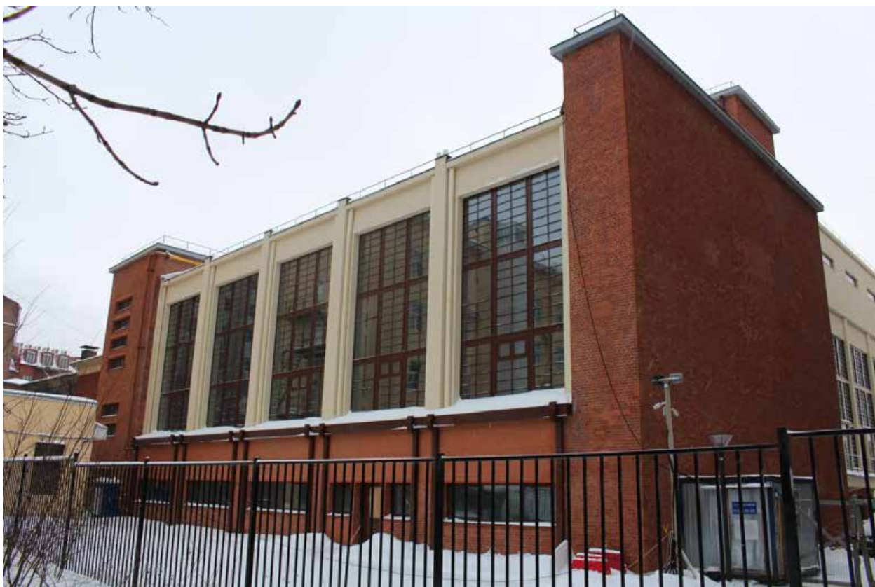
Фото 4. Общий вид с северо-востока.
