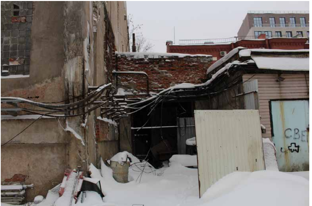
Фото 11. Поздние пристройки с севера.
