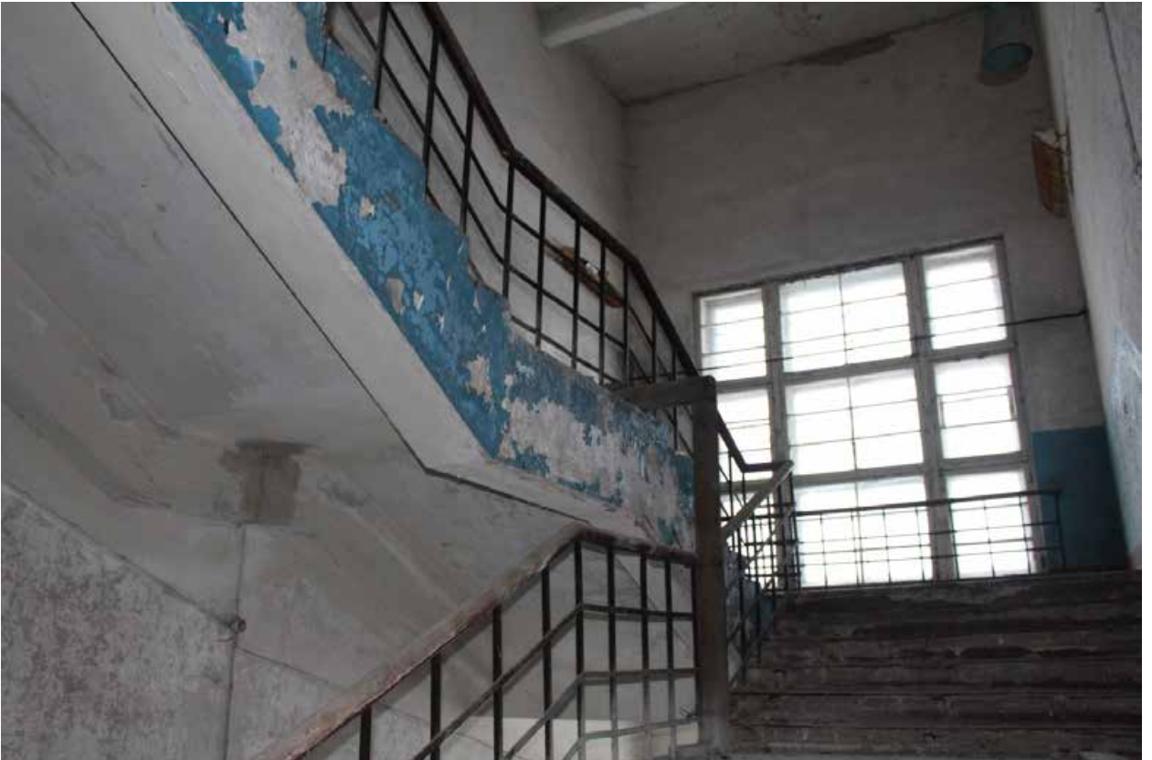
Фото 42. Междуэтажная площадка 4-5 этажи.
