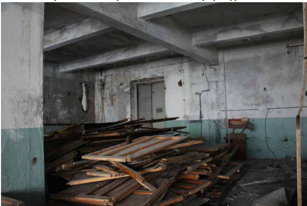
Фото 38. Вход на лестницу, 4 этаж.
