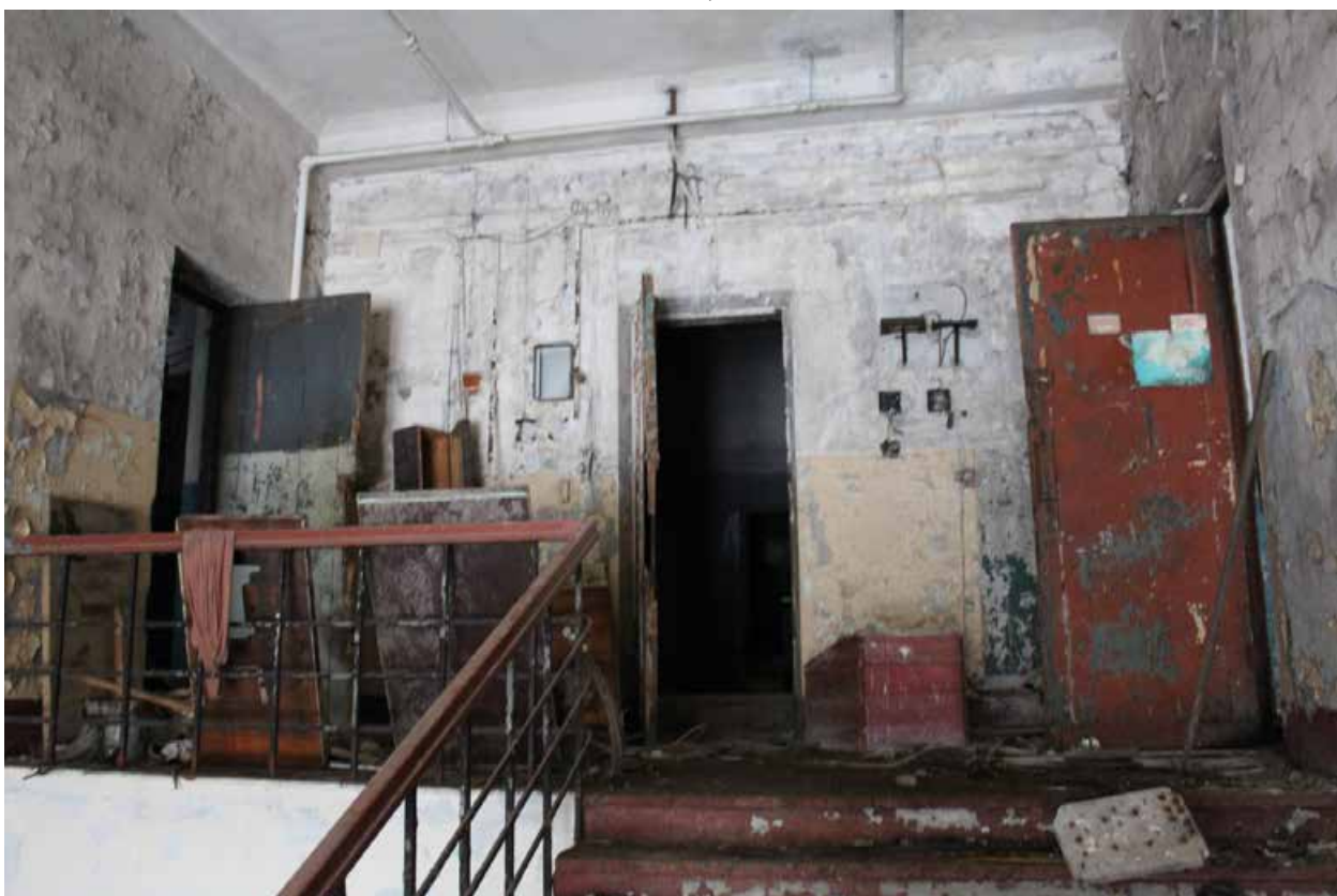
Фото 27. Площадка 5 этажа, Л-2.
