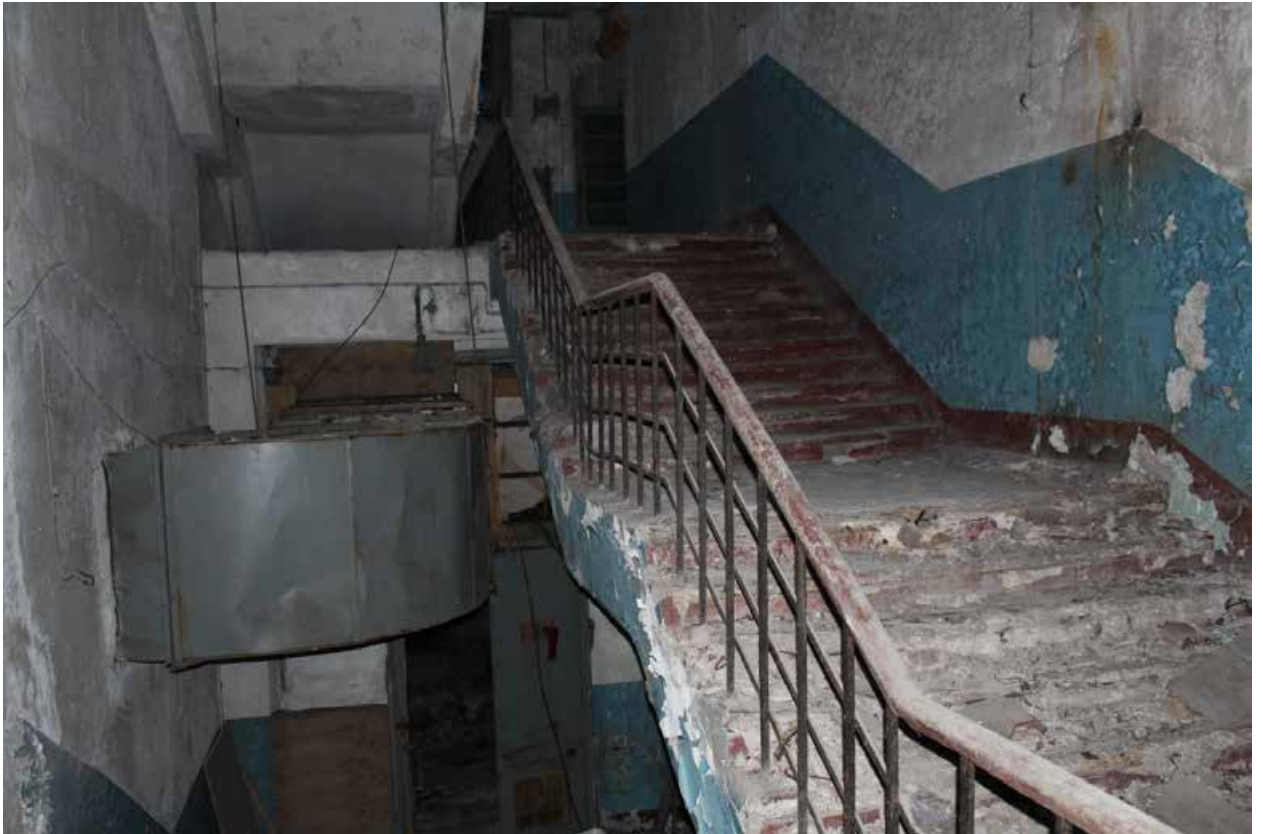
Фото 22. Вид с лестницы на цокольный этаж.
