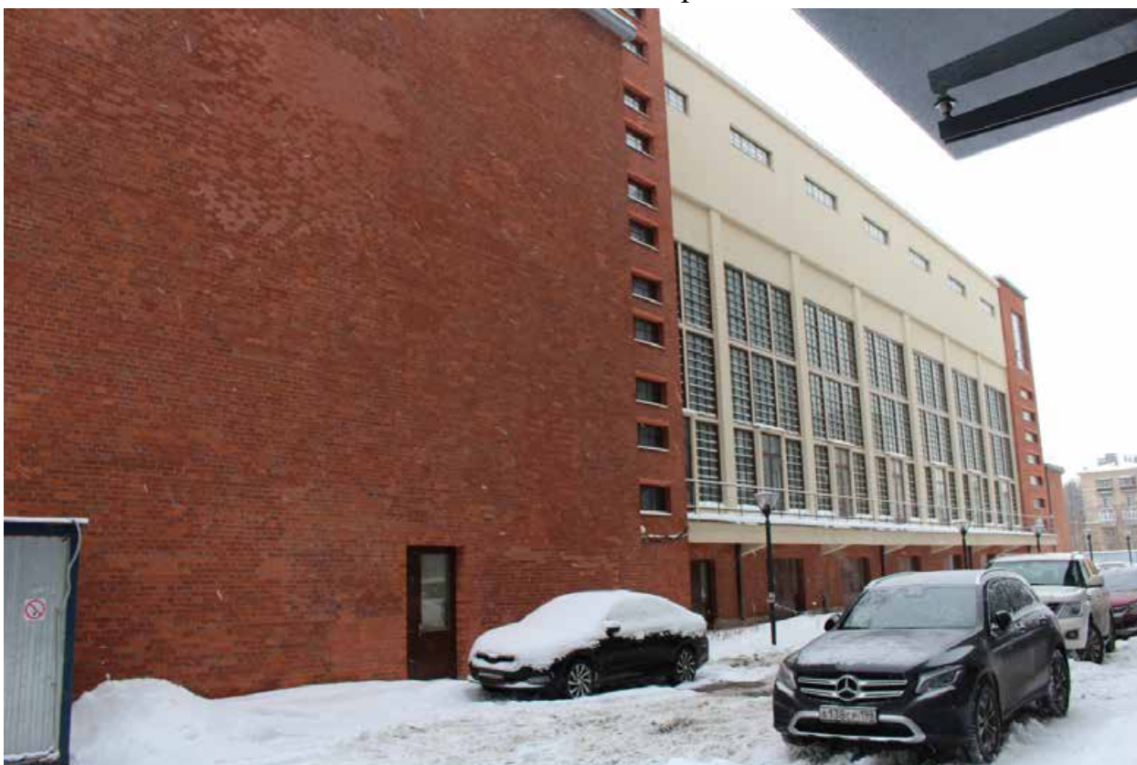
Фото 3. Вид северо-восточного фасада.
