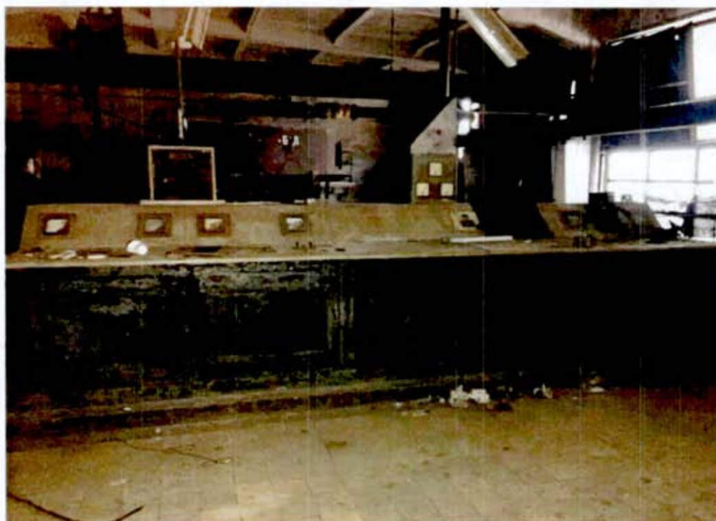
Фото 12. Пульт управления в бывш. турбинном зале.
