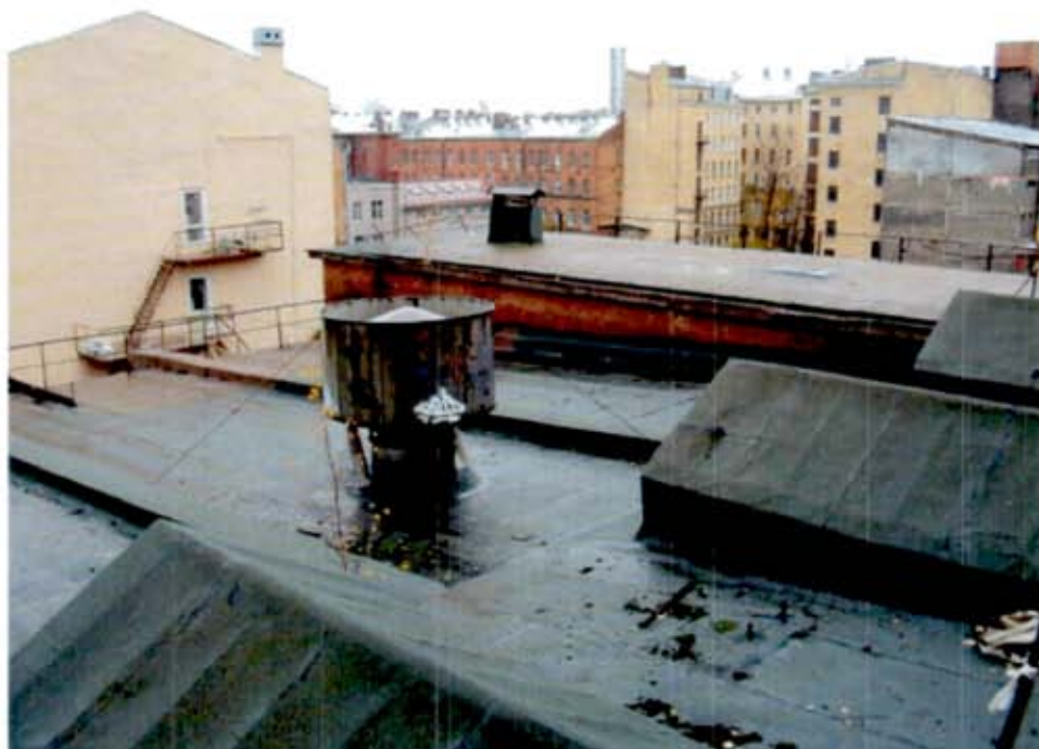
Фото 19. Кровля юго-восточной части здания.
