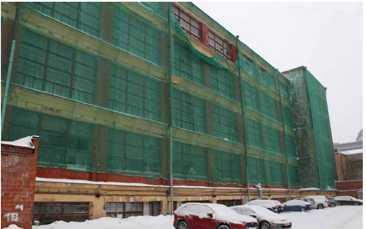
Фото 3. Вид вдоль южного фасада, на восток.
