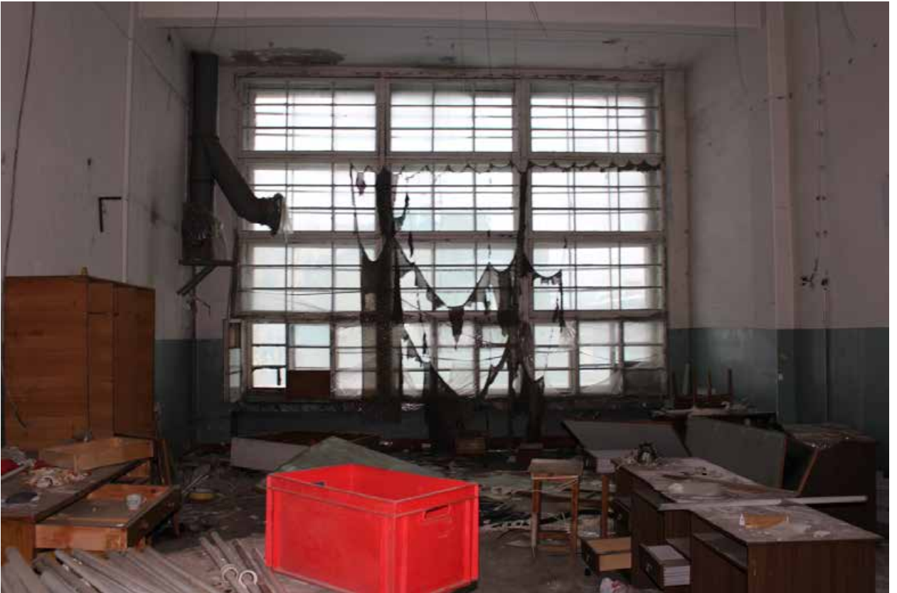
Фото 34. Помещение на юге, 3 этаж.
