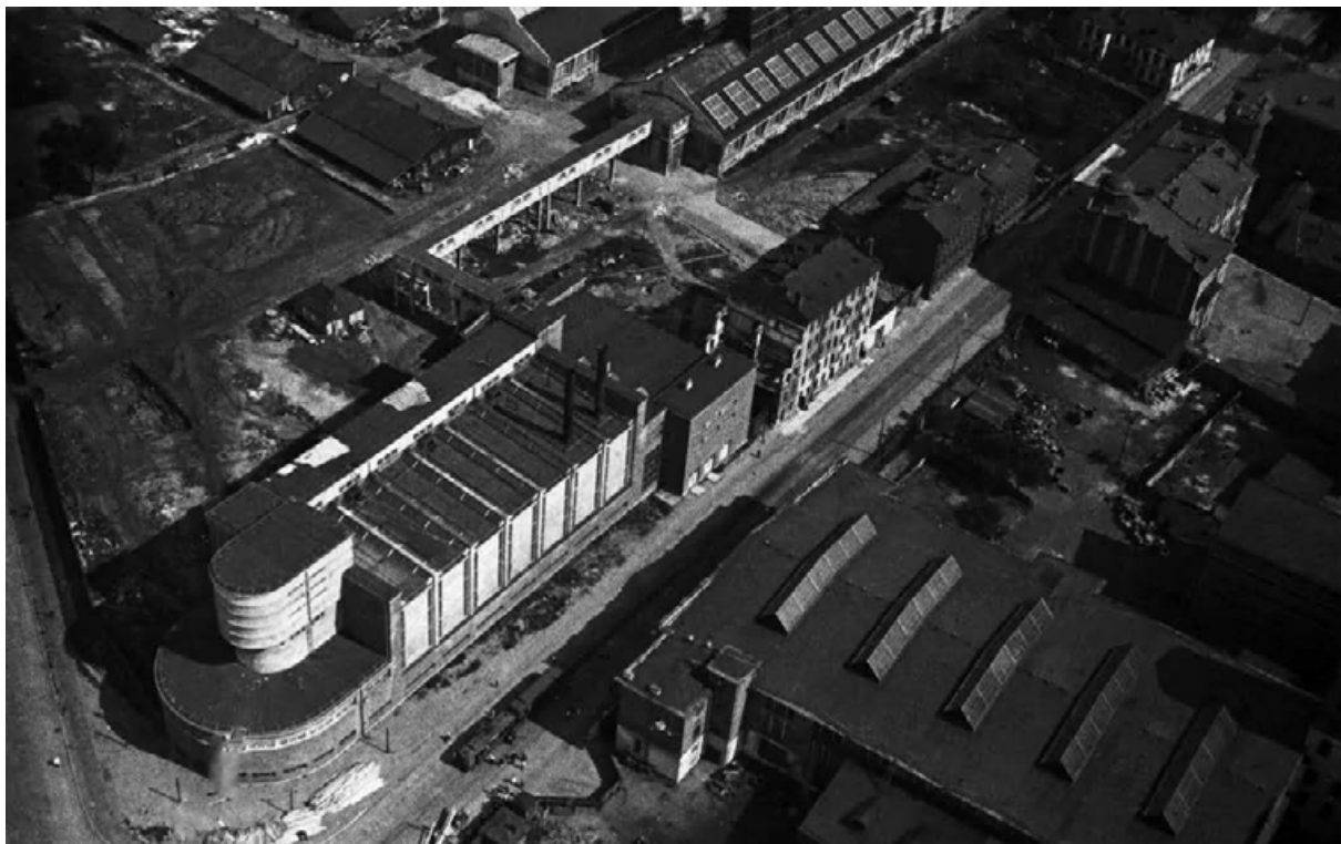
Илл. 26. Новые корпуса и силовая станция чулочно-трикотажной фабрики «Красное Знамя». 1931 г. Серия «Ленинград с аэроплана» для журнала «СССР на стройке». Электронный портал Pastvu.com.
