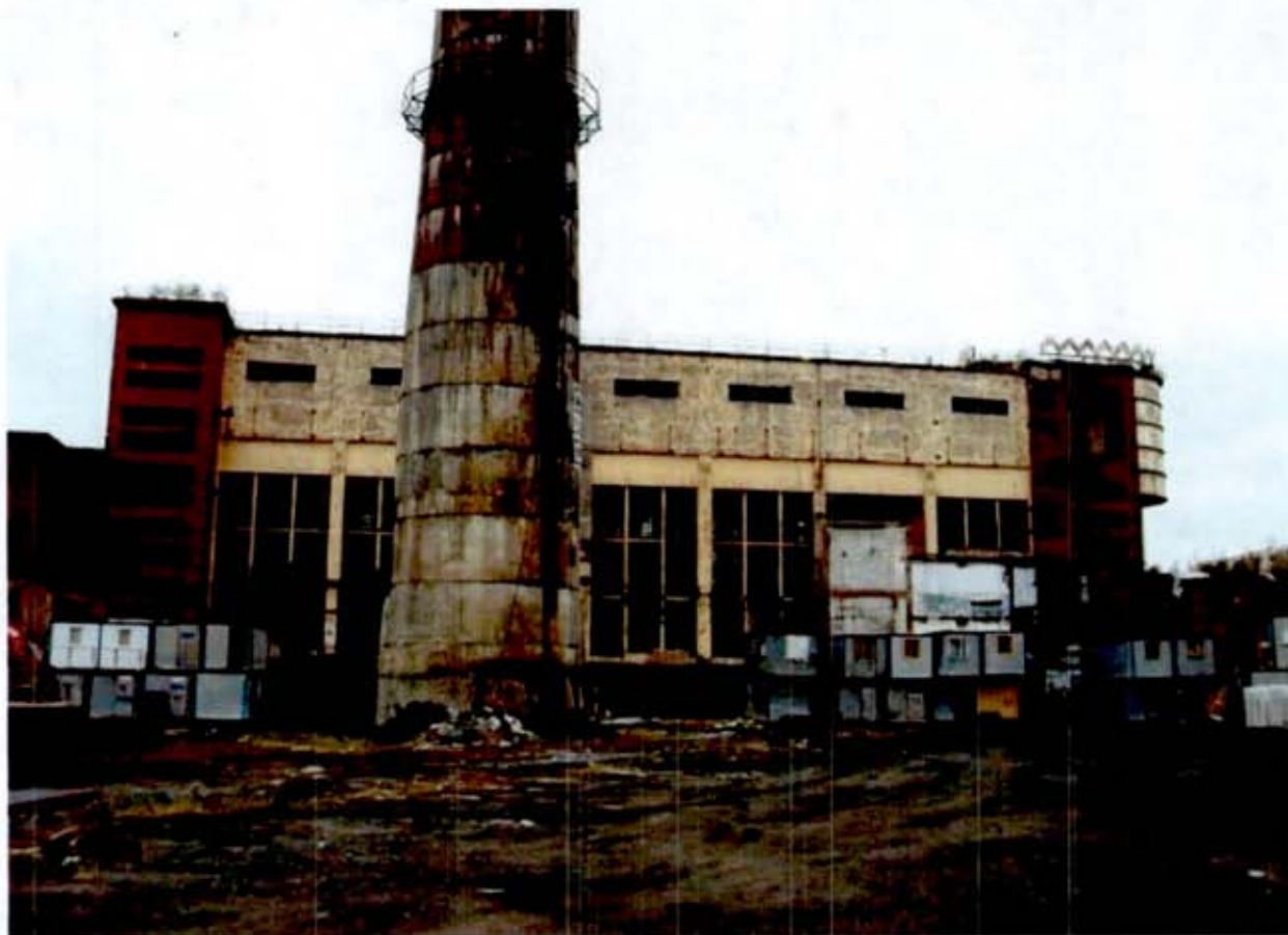
Фото 5. Фрагмент Северо-восточного фасада.
