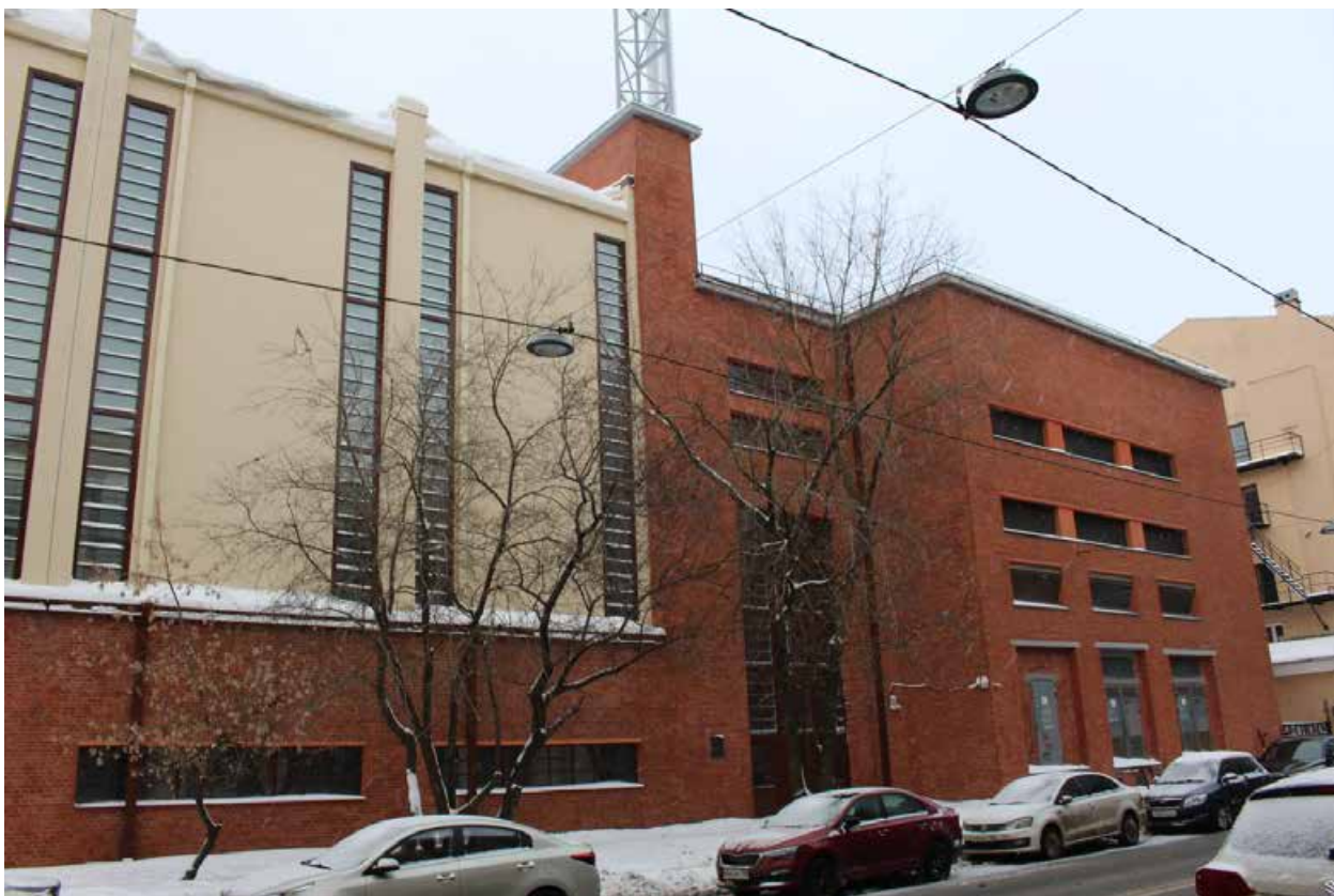
Фото 8. Южный фрагмент юго-западного фасада.
