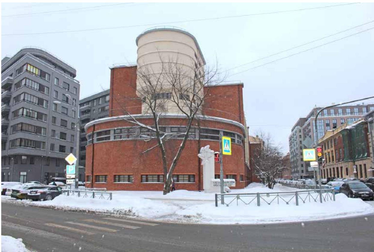
Фото 2. Общий вид с северо-запада.
