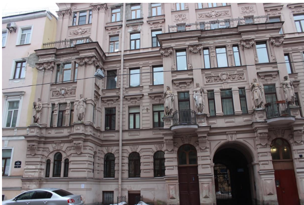
2. Здание по адресу: Санкт-Петербург, улица Чехова, д.3, Лит. А. Фрагмент лицевого фасада
