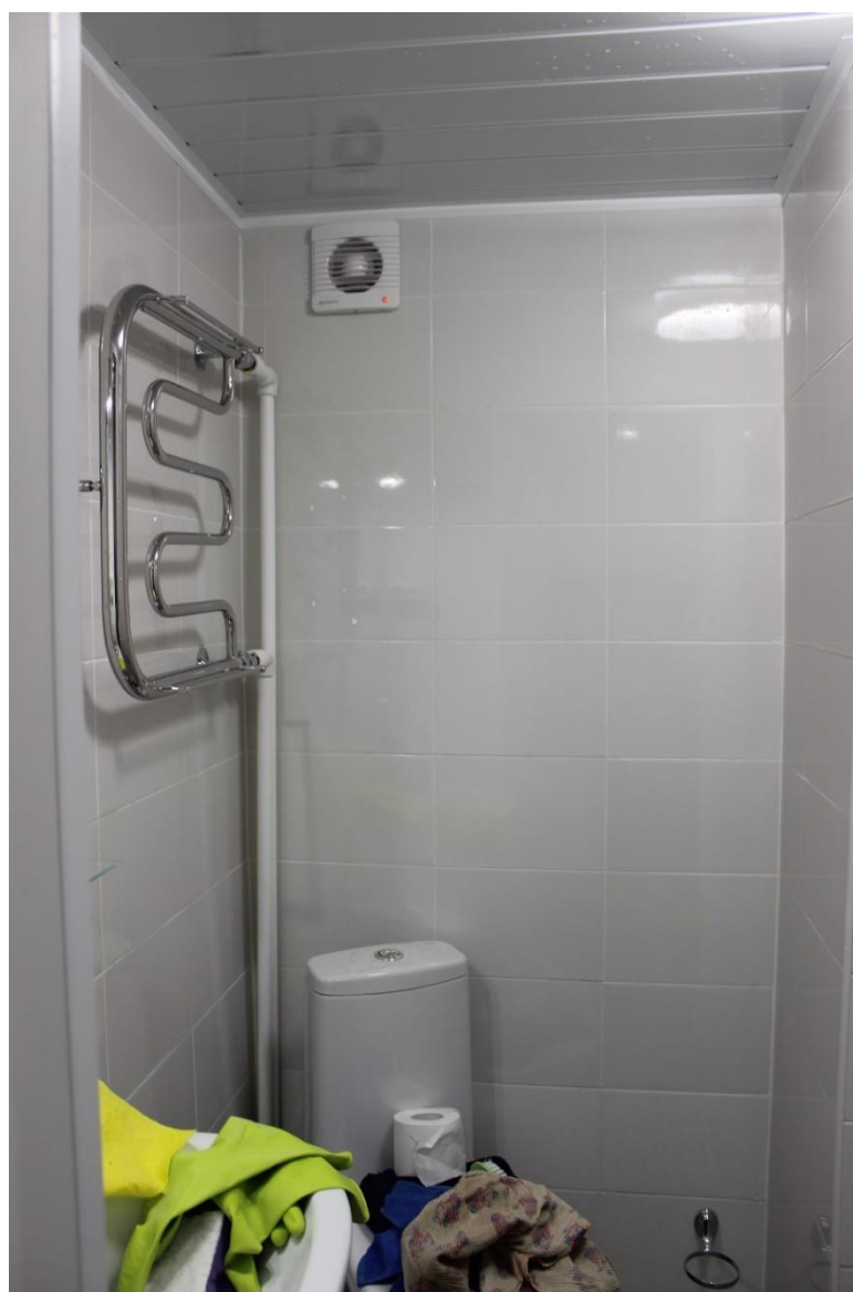
23. Здание по адресу: Санкт-Петербург, улица Чехова, д.3, Лит. А. Санузел в квартире №6
