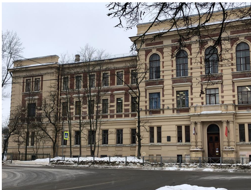
2. Объект культурного наследия регионального значения «Реальное училище с садом и оградой», входящий в состав «Комплекс домов по ул. Пролеткульта», расположенный по адресу: Санкт-Петербург, г. Пушкин, Госпитальная улица, дом 24, литера А. Юго-восточный (главный) фасад. Вид со стороны Госпитальной улицы. Фрагмент.
