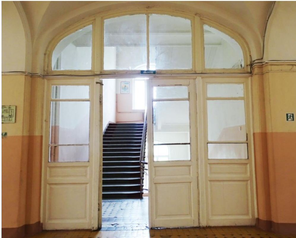
37. Объект культурного наследия регионального значения «Реальное училище с садом и оградой», входящий в состав «Комплекс домов по ул. Пролеткульта», расположенный по адресу: Санкт-Петербург, г. Пушкин, Госпитальная улица, дом 24, литера А. Второй этаж. Коридор (помещения №62). Фрагмент интерьера.
