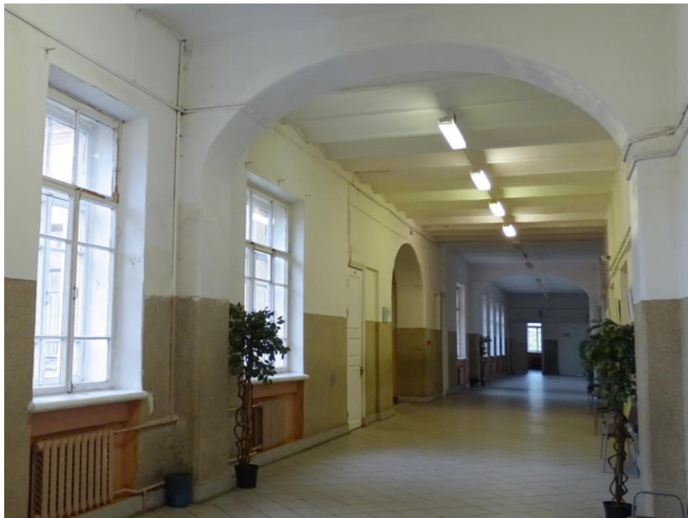
46. Объект культурного наследия регионального значения «Реальное училище с садом и оградой», входящий в состав «Комплекс домов по ул. Пролеткульта», расположенный по адресу: Санкт-Петербург, г. Пушкин, Госпитальная улица, дом 24, литера А. Коридор на третьем этаже здания (помещение 100). Общий вид.
