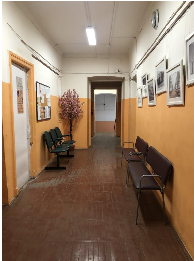
32. Объект культурного наследия регионального значения «Реальное училище с садом и оградой», входящий в состав «Комплекс домов по ул. Пролеткульта», расположенный по адресу: Санкт-Петербург, г. Пушкин, Госпитальная улица, дом 24, литера А. Юго-западная часть здания. Первый этаж. Коридор (помещение №17). Фрагмент интерьера.
