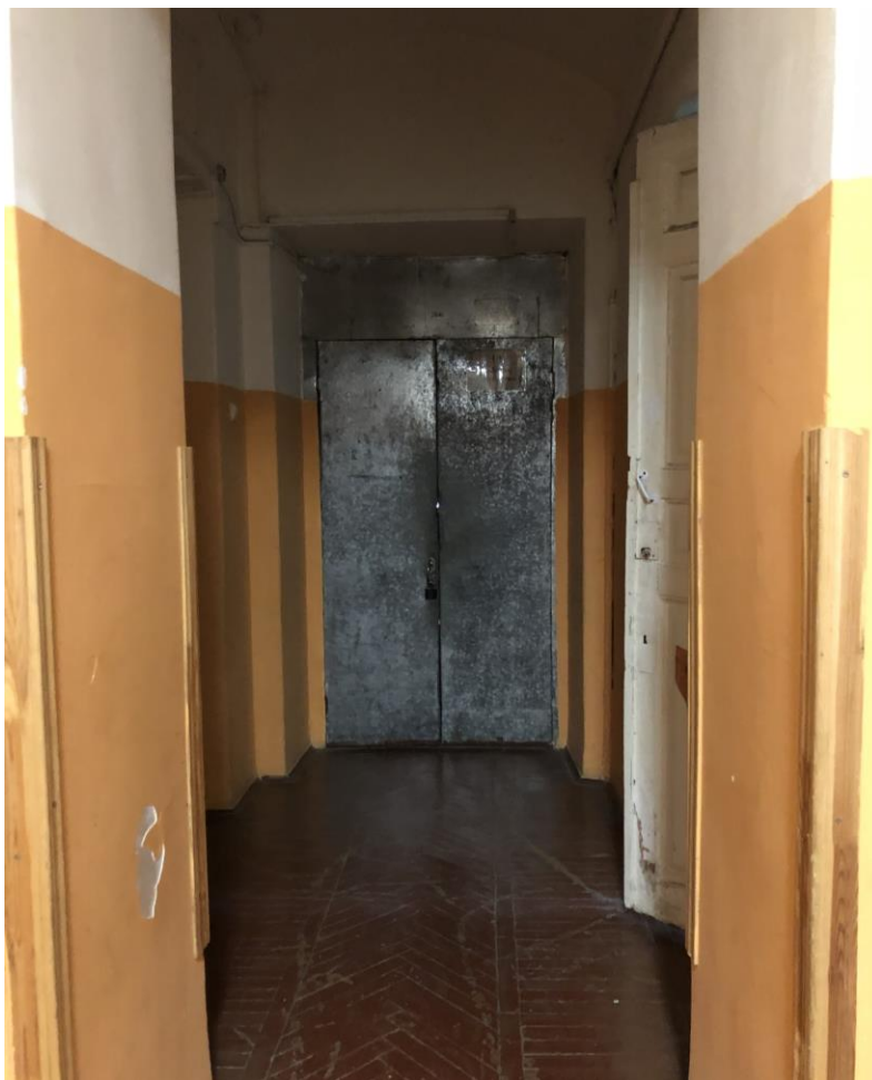
33. Объект культурного наследия регионального значения «Реальное училище с садом и оградой», входящий в состав «Комплекс домов по ул. Пролеткульта», расположенный по адресу: Санкт-Петербург, г. Пушкин, Госпитальная улица, дом 24, литера А. Юго-западная часть здания. Первый этаж. Коридор (помещение №17). Фрагмент интерьера.
