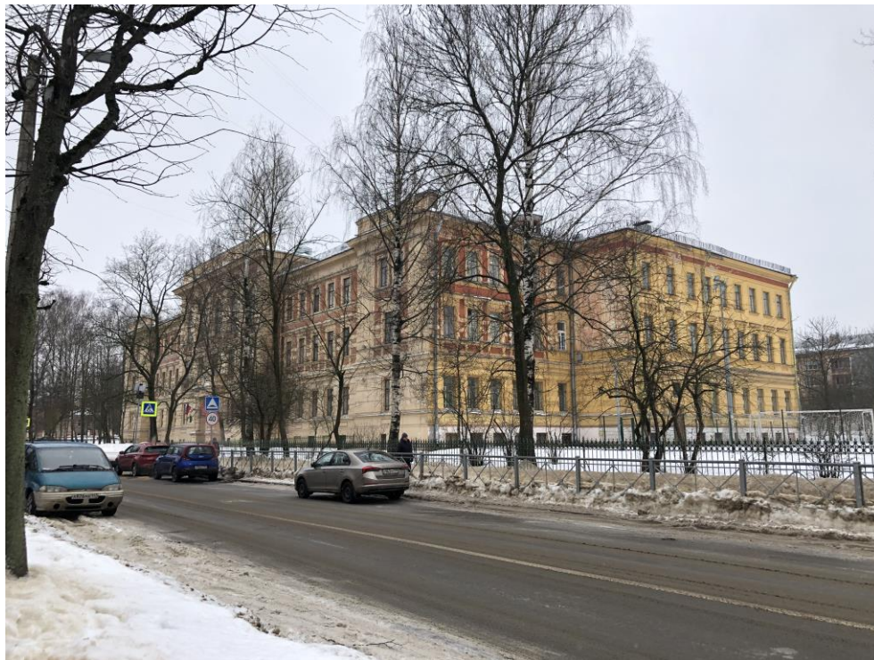
6. Объект культурного наследия регионального значения «Реальное училище с садом и оградой», входящий в состав «Комплекс домов по ул. Пролеткульта», расположенный по адресу: Санкт-Петербург, г. Пушкин, Госпитальная улица, дом 24, литера А. Общий вид со стороны Госпитальной улицы.
