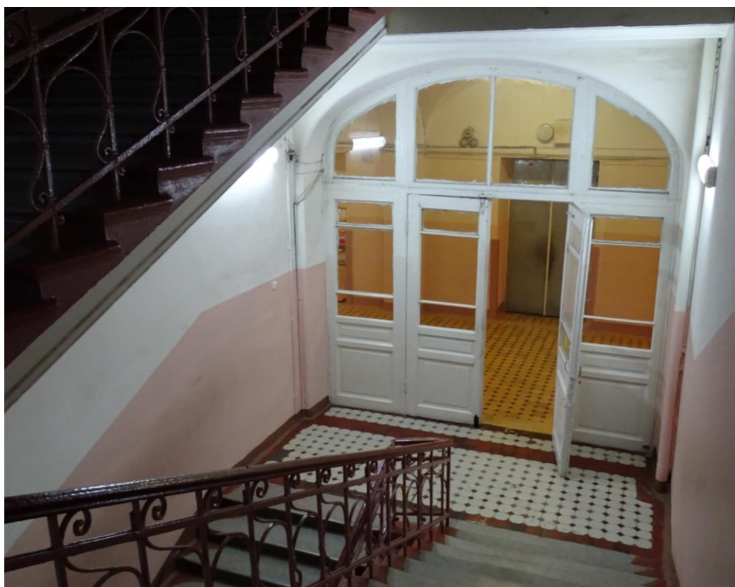
28. Объект культурного наследия регионального значения «Реальное училище с садом и оградой», входящий в состав «Комплекс домов по ул. Пролеткульта», расположенный по адресу: Санкт-Петербург, г. Пушкин, Госпитальная улица, дом 24, литера А. Общий вид интерьера помещения №65 в уровне второго этажа.
