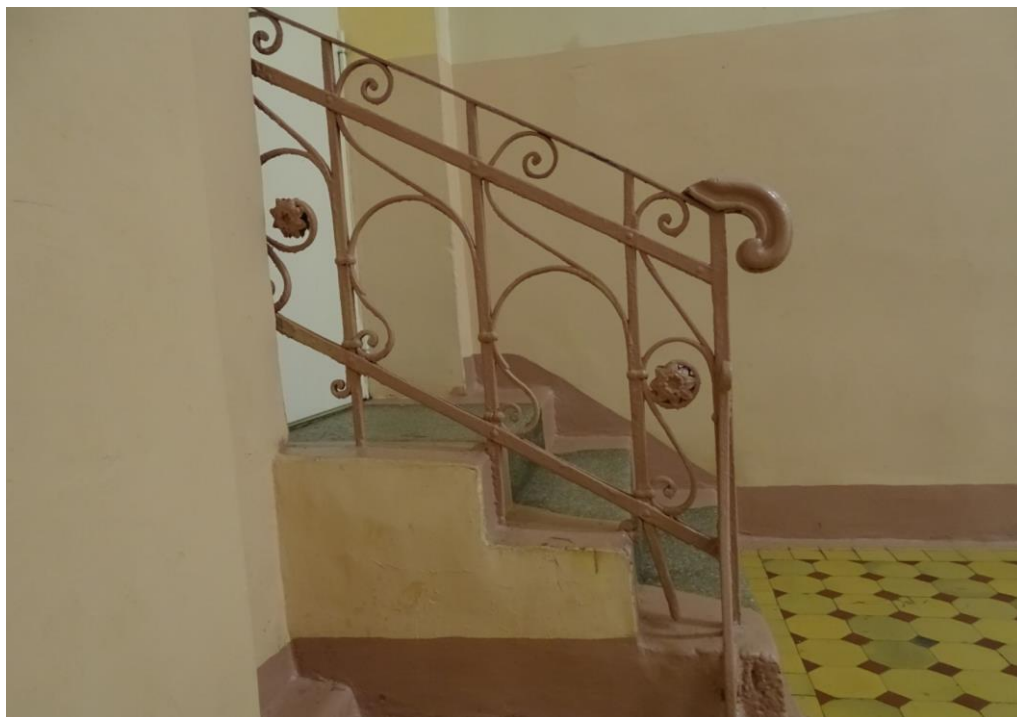
38. Объект культурного наследия регионального значения «Реальное училище с садом и оградой», входящий в состав «Комплекс домов по ул. Пролеткульта», расположенный по адресу: Санкт-Петербург, г. Пушкин, Госпитальная улица, дом 24, литера А. Второй этаж. Коридор (помещения №62). Фрагмент интерьера.
