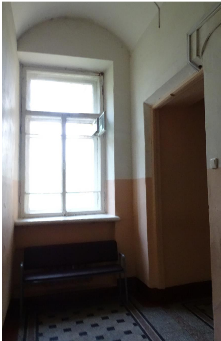
48. Объект культурного наследия регионального значения «Реальное училище с садом и оградой», входящий в состав «Комплекс домов по ул. Пролеткульта», расположенный по адресу: Санкт-Петербург, г. Пушкин, Госпитальная улица, дом 24, литера А. Коридор третьего этажа левого крыла здания (помещение 93). Фрагмент интерьера.
