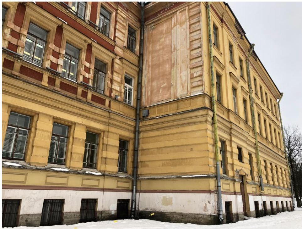
8. Объект культурного наследия регионального значения «Реальное училище с садом и оградой», входящий в состав «Комплекс домов по ул. Пролеткульта», расположенный по адресу: Санкт-Петербург, г. Пушкин, Госпитальная улица, дом 24, литера А. Северо-восточный боковой фасад. Вид со стороны Госпитальной улицы.
