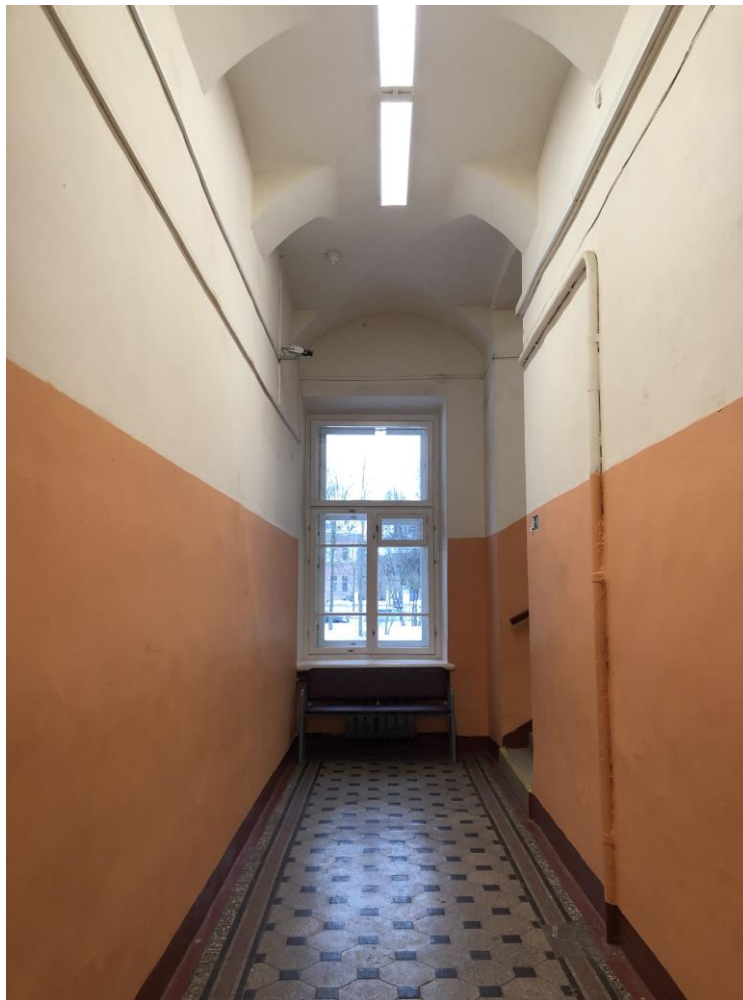
31. Объект культурного наследия регионального значения «Реальное училище с садом и оградой», входящий в состав «Комплекс домов по ул. Пролеткульта», расположенный по адресу: Санкт-Петербург, г. Пушкин, Госпитальная улица, дом 24, литера А. Юго-западная часть здания. Коридор первого этажа левого крыла здания (помещение 10). Фрагмент интерьера.
