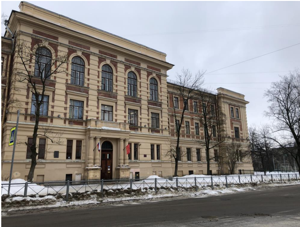
3. Объект культурного наследия регионального значения «Реальное училище с садом и оградой», входящий в состав «Комплекс домов по ул. Пролеткульта», расположенный по адресу: Санкт-Петербург, г. Пушкин, Госпитальная улица, дом 24, литера А. Юго-восточный (главный) фасад. Вид со стороны Госпитальной улицы.
