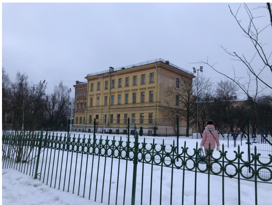
7. Объект культурного наследия регионального значения «Реальное училище с садом и оградой», входящий в состав «Комплекс домов по ул. Пролеткульта», расположенный по адресу: Санкт-Петербург, г. Пушкин, Госпитальная улица, дом 24, литера А. Вид на северно-восточный боковой и северо-западный дворовый фасады со стороны Пушкинской улицы. Фрагмент ограды.
