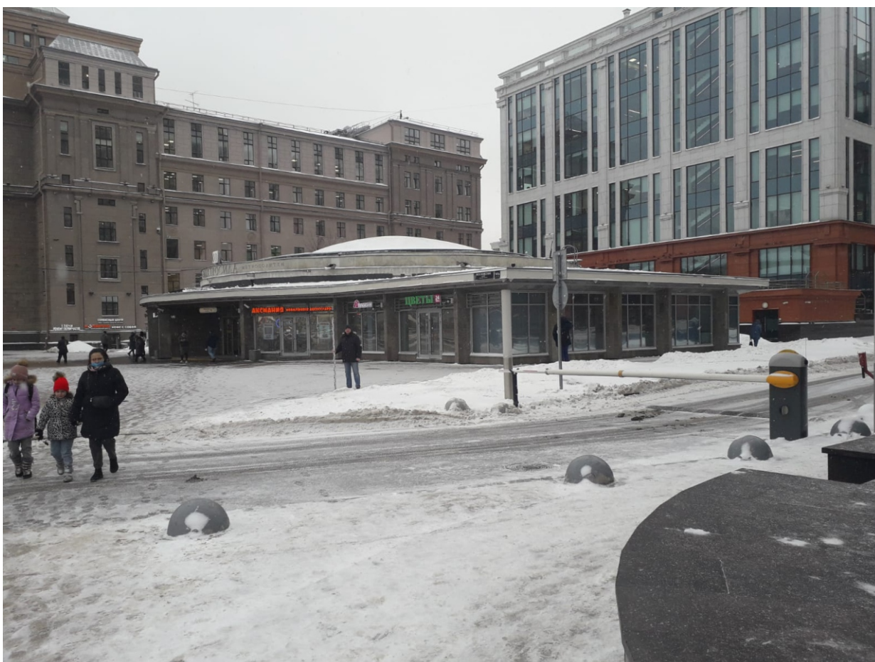
Точка фотофиксации 1. Общий вид на станцию метро «Электросила» с СВ.
