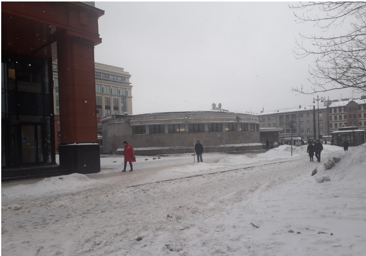
Точка фотофиксации 5. Общий вид на станцию метро «Электросила» и прилегающую территорию с ЮЗ.
