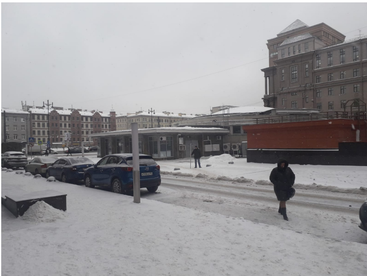
Точка фотофиксации 6. Общий вид на станцию метро «Электросила» и прилегающую территорию с СЗ.
