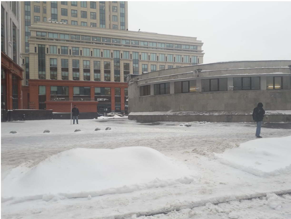
Точка фотофиксации 4. Общий вид на станцию метро «Электросила» и прилегающую территорию с ЮЗ.
