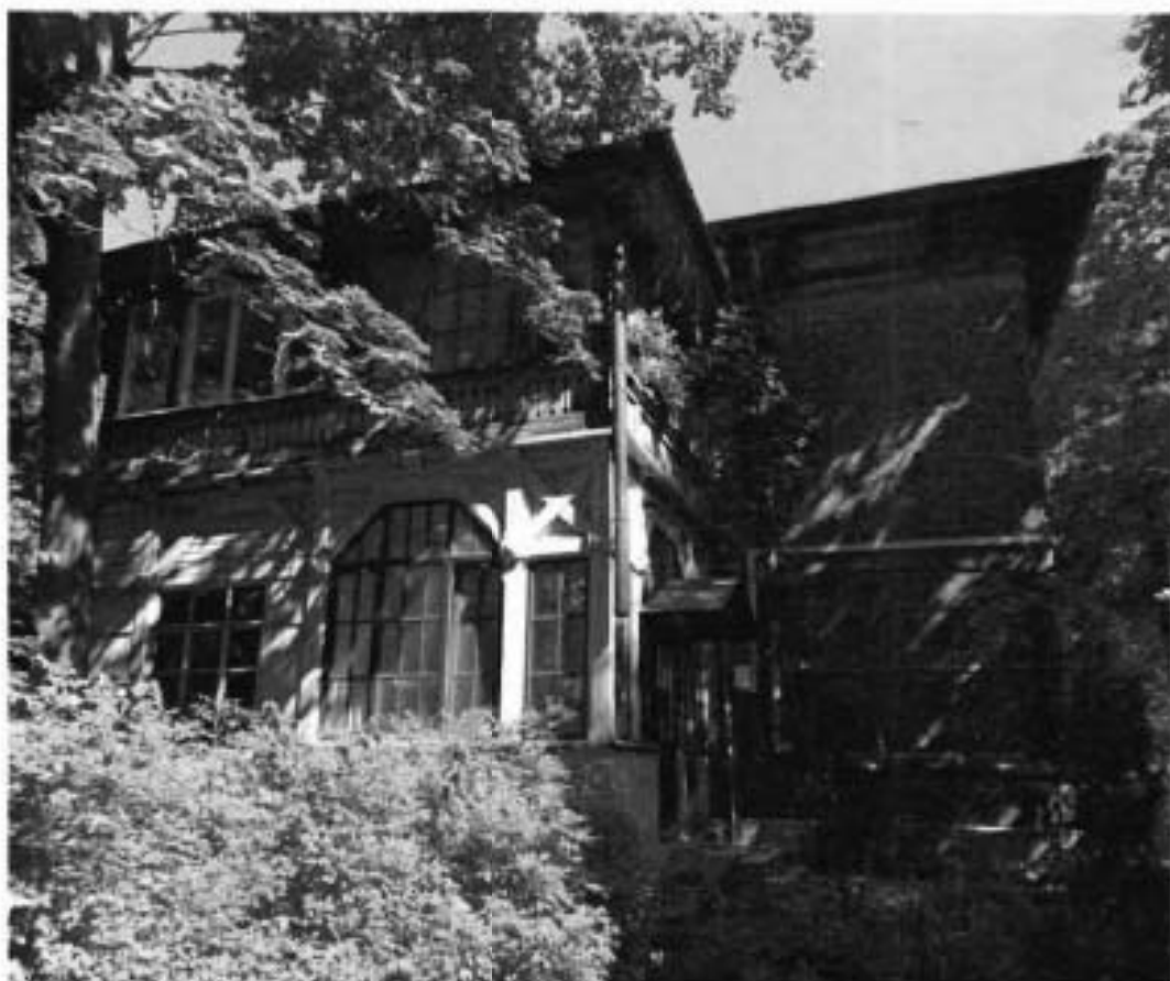
2. Южный фасад здания.
