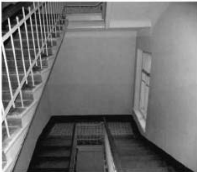
14. Напольное покрытие лестничных маршей.
