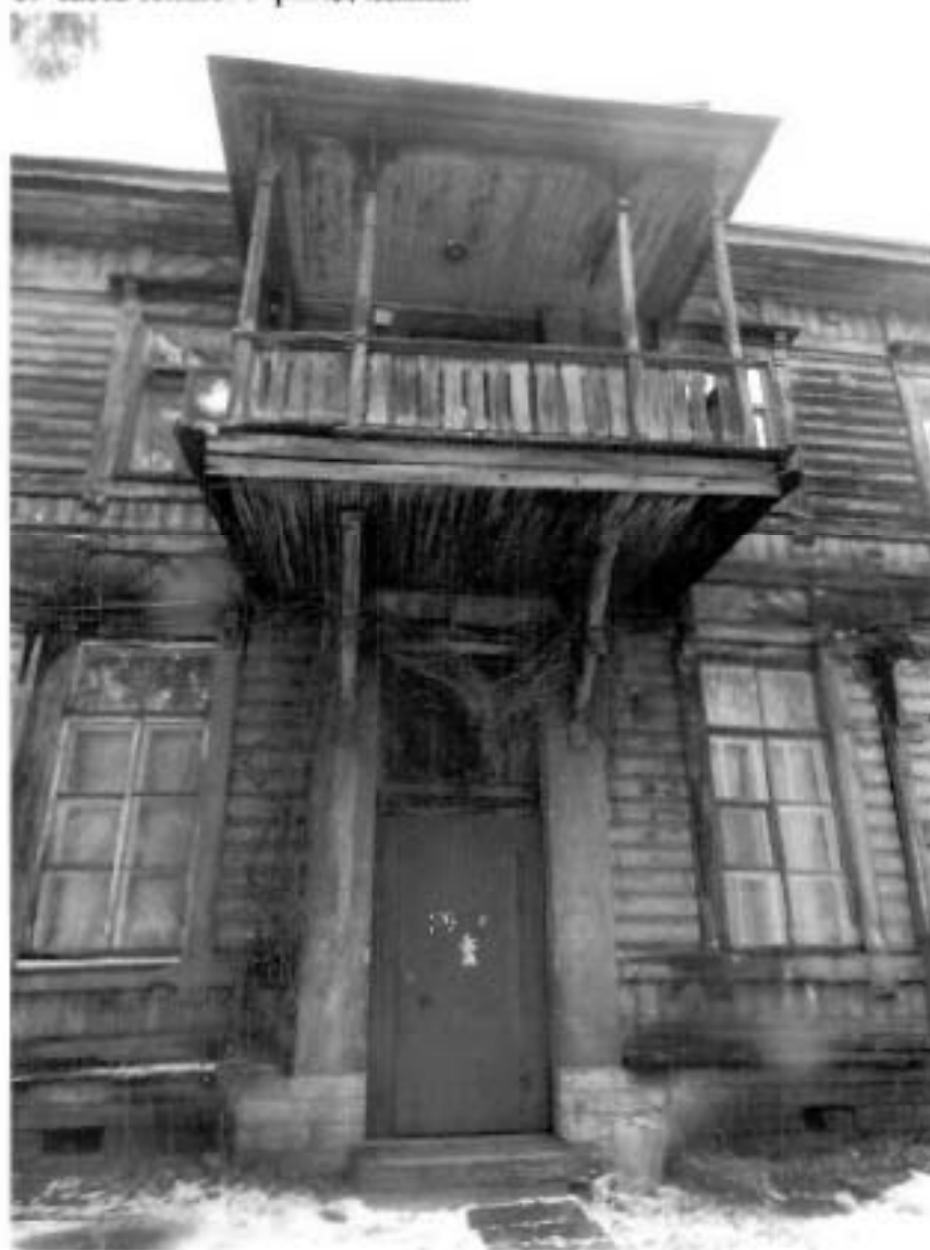
1. Часть южного фасад здания.
