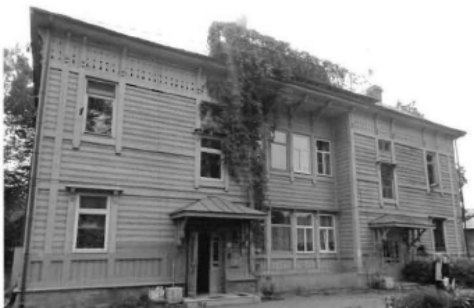
1. Западный фасад здания.
