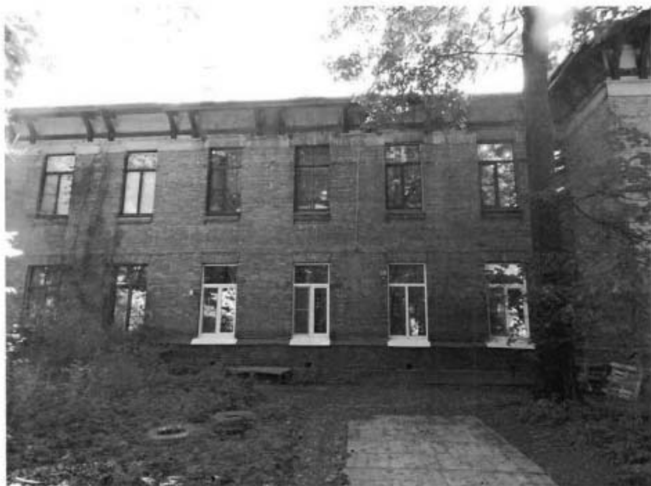
5. Западный фасад здания (фрагмент).
