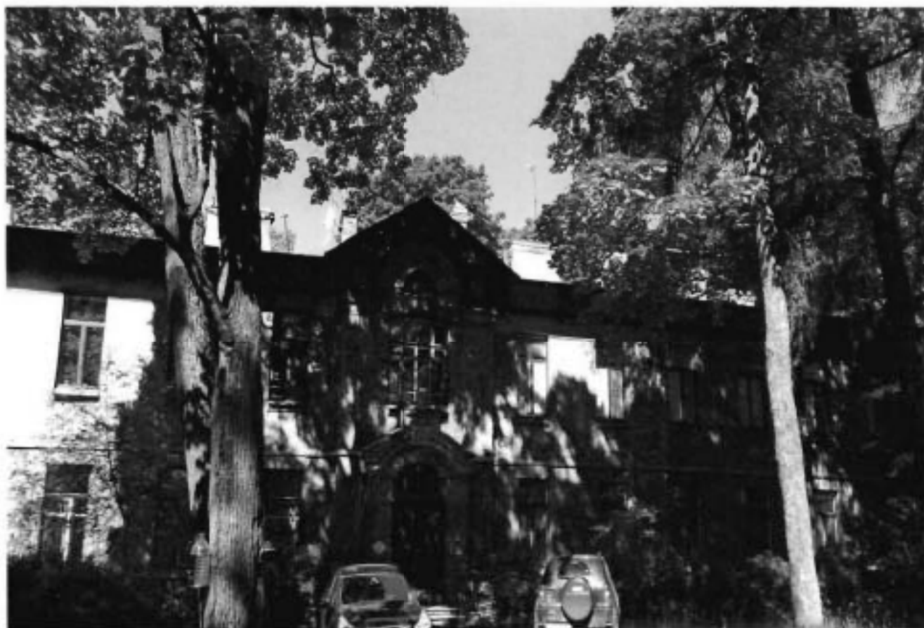
1. Восточный фасад здания (фрагмент).
