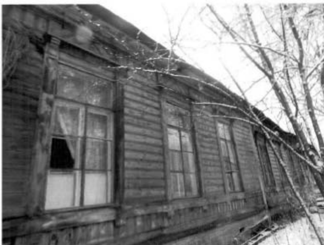
2. Часть южного фасада здания.
