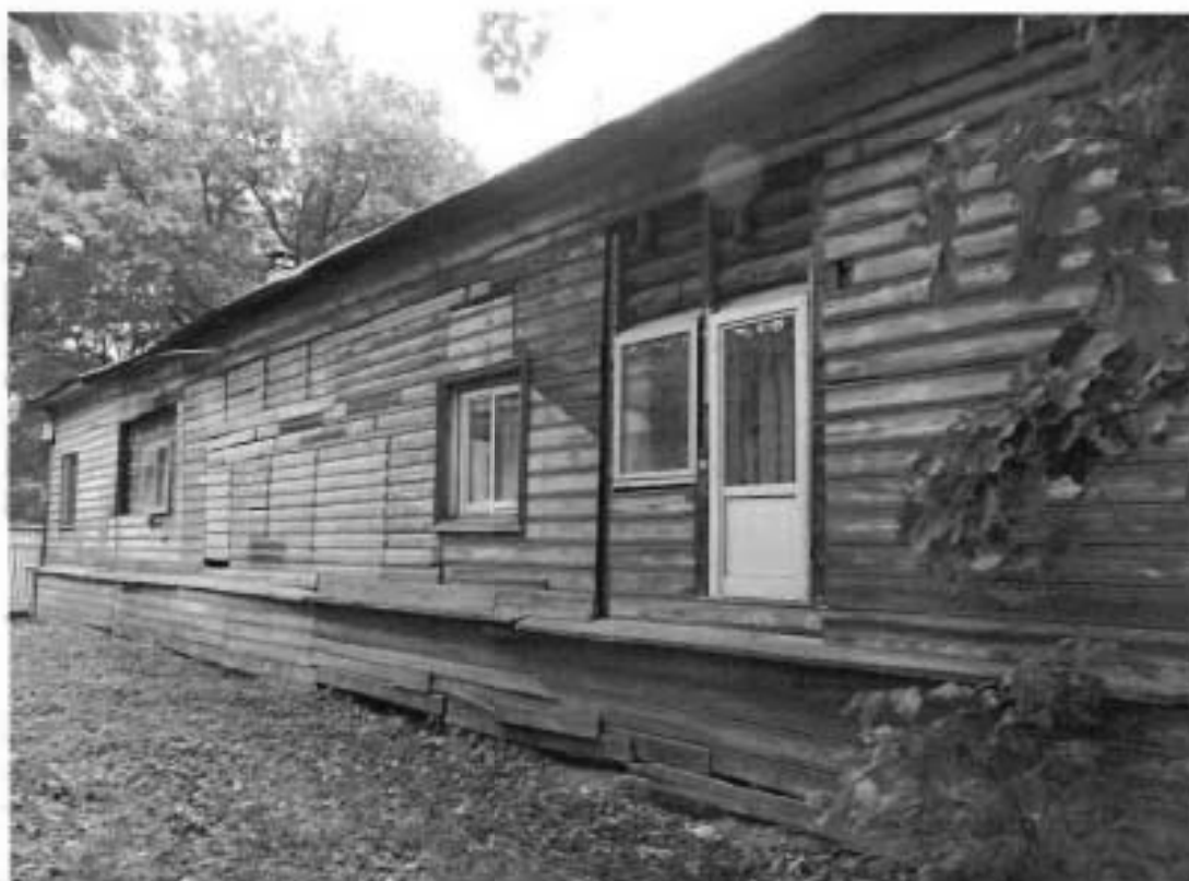
4. Северный фасад здания.
