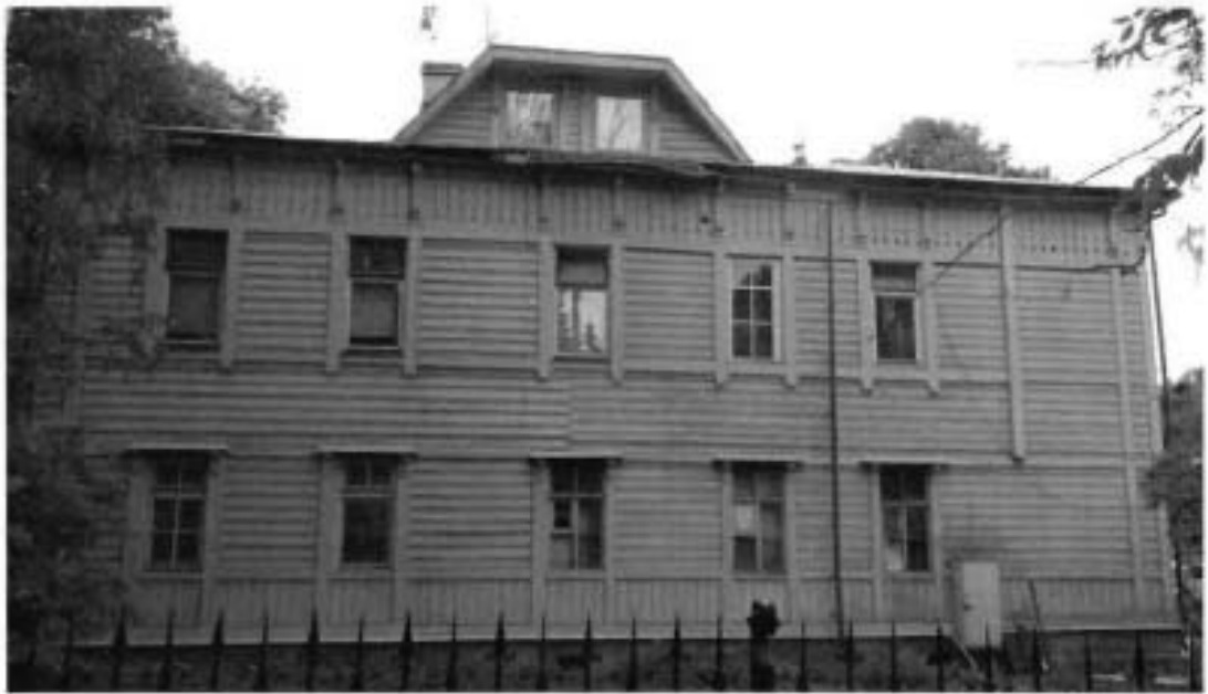
3. Северный фасад здания.
