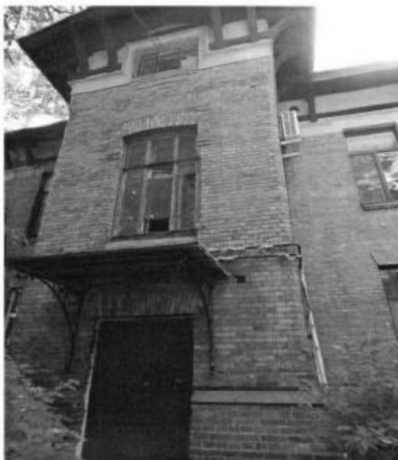
4. Западный фасад здания (фрагмент).
