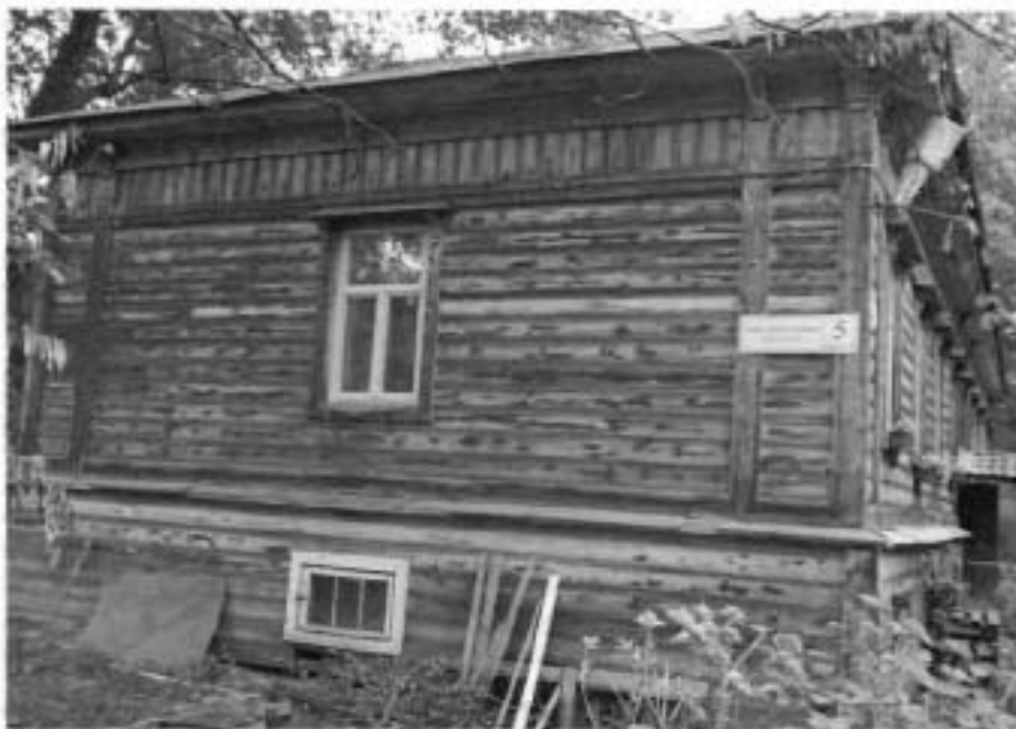
3. Западный фасад здания.
