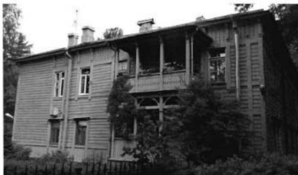
2. Южный фасад здания.
