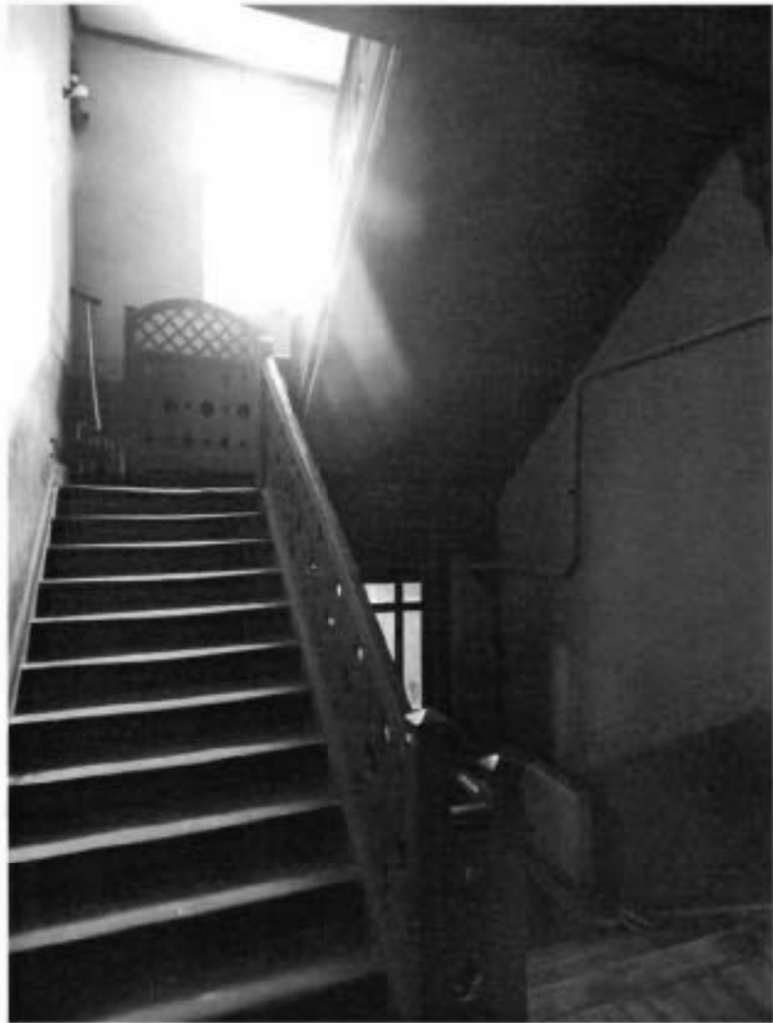
5. Фрагмент деревянной лестницы.
