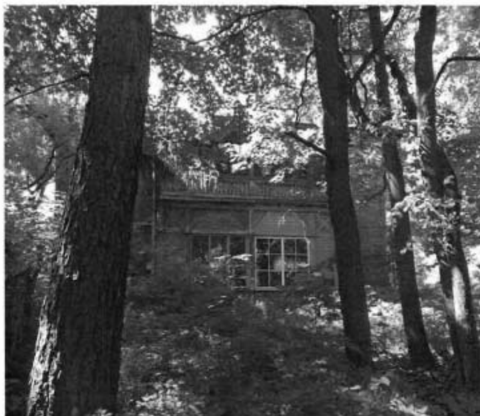
3. Северный фасад здания.
