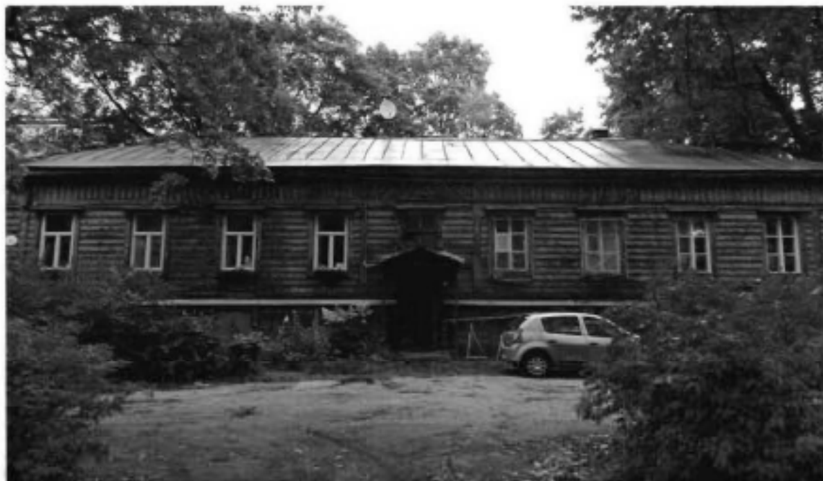
1. Южный фасад здания.
