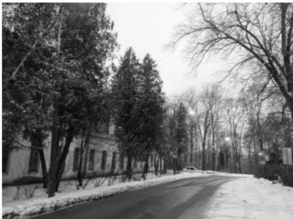
Фото 11. Вид на Институтский переулок, ОКН федерального значения «Корпус глиняный» (слева) входящий в состав ОКН федерального значения «Институт Лесной (Академия лесотехническая)»
