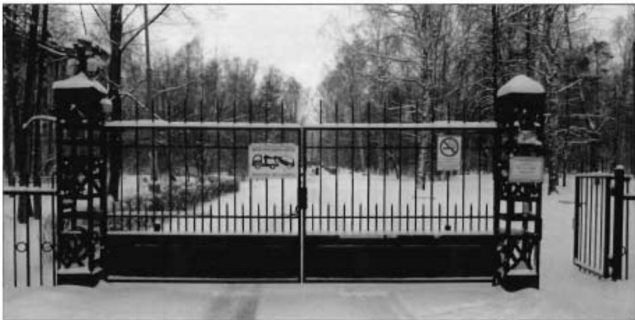
3. Часть объекта культурного наследия: ворота со стороны ул. Фаворского (первый западный проезд). Вид с юга.
