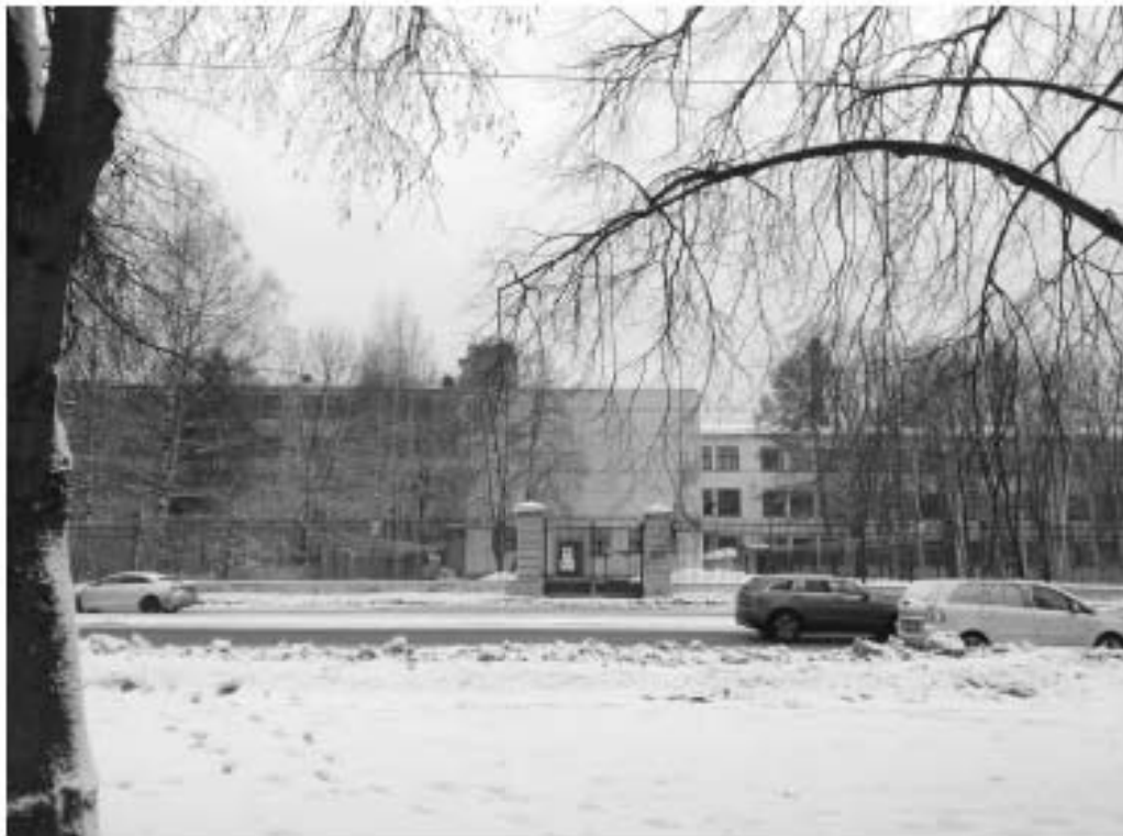
Фото 3. Территория проведения работ по реконструкции электрических сетей и устройств наружного освещения объекта: Политехническая ул. от пл. Мужества до Тихорешского пр. Вид с ул. Политехнической на ОКН регионального значения «Здание фабрично-заводской школы». Направление съемки запад.
