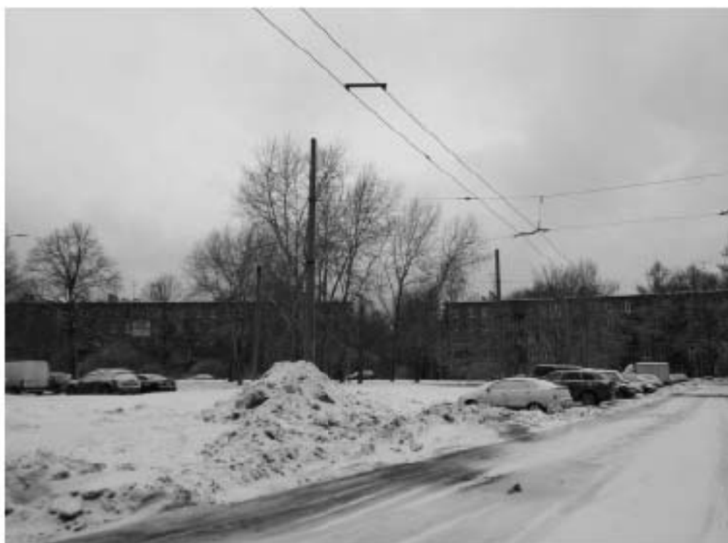
Фото 10. Территория проведения работ по реконструкции электрических сетей и устройств наружного освещения объекта: Политехническая ул. от пл. Мужества до Тихорецкого пр. Вид на зону производства работ. Направление съемки северо-запад.
