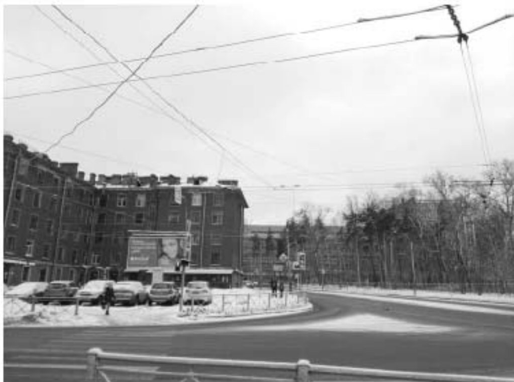
Фото 9. Территория проведения работ по реконструкции электрических сетей и устройств наружного освещения объекта: Политехническая ул. от пл. Мужества до Тихорецкого пр. Вид на ул. Политехническую и на ОКН федерального значения «Корпус жилой для служащих» входящий в состав ОКН федерального значения «Институт Санкт-Петербургский Политехнический императора Петра Великого». Направление съемки юго-запад.
