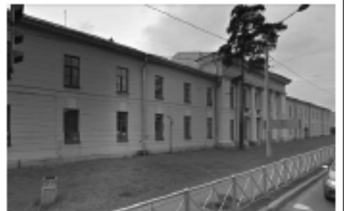
северный фасад северного крыла
