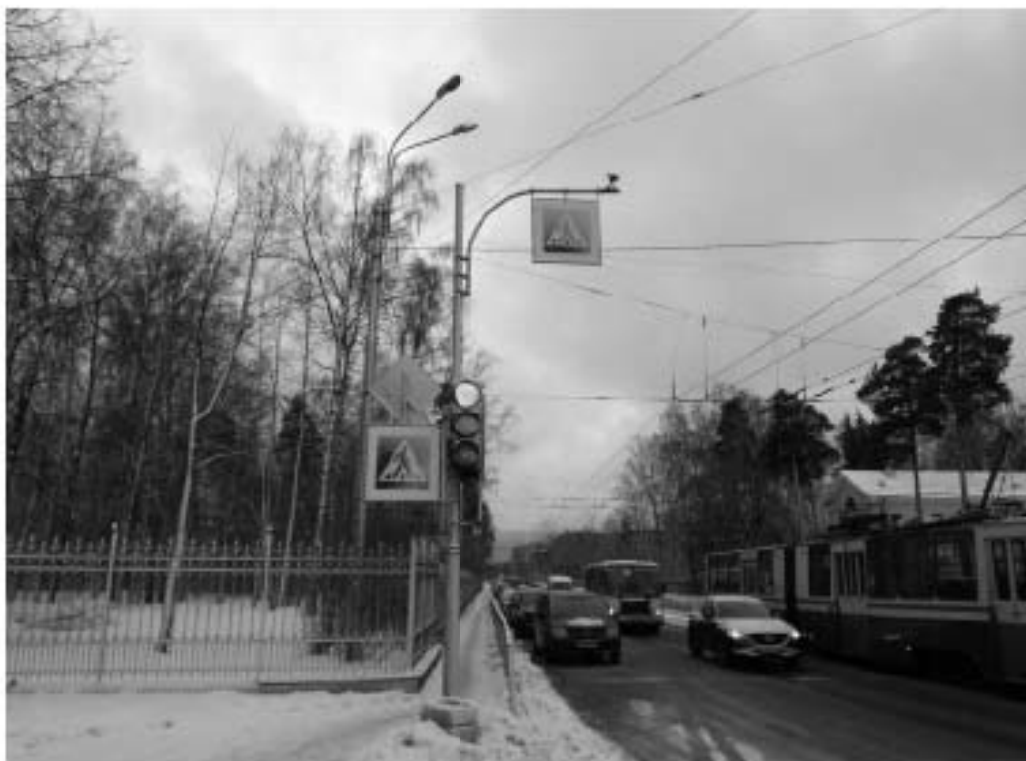
Фото 6. Территория проведения работ по реконструкции электрических сетей и устройств наружного освещения объекта: Политехническая ул. от пл. Мужества до Тихорешского пр. Вид с ул. Политехнической на выявленный ОКН «Главный корпус Физико-технологического института РАН им. А.Ф. Иоффе (с курдонером, садом, оградой)» и ОКН федерального значения «Парк», входящий в состав ОКН федерального значения «Институт Санкт-Петербургский Политехнический императора Петра Великого». Направление съемки юг.
