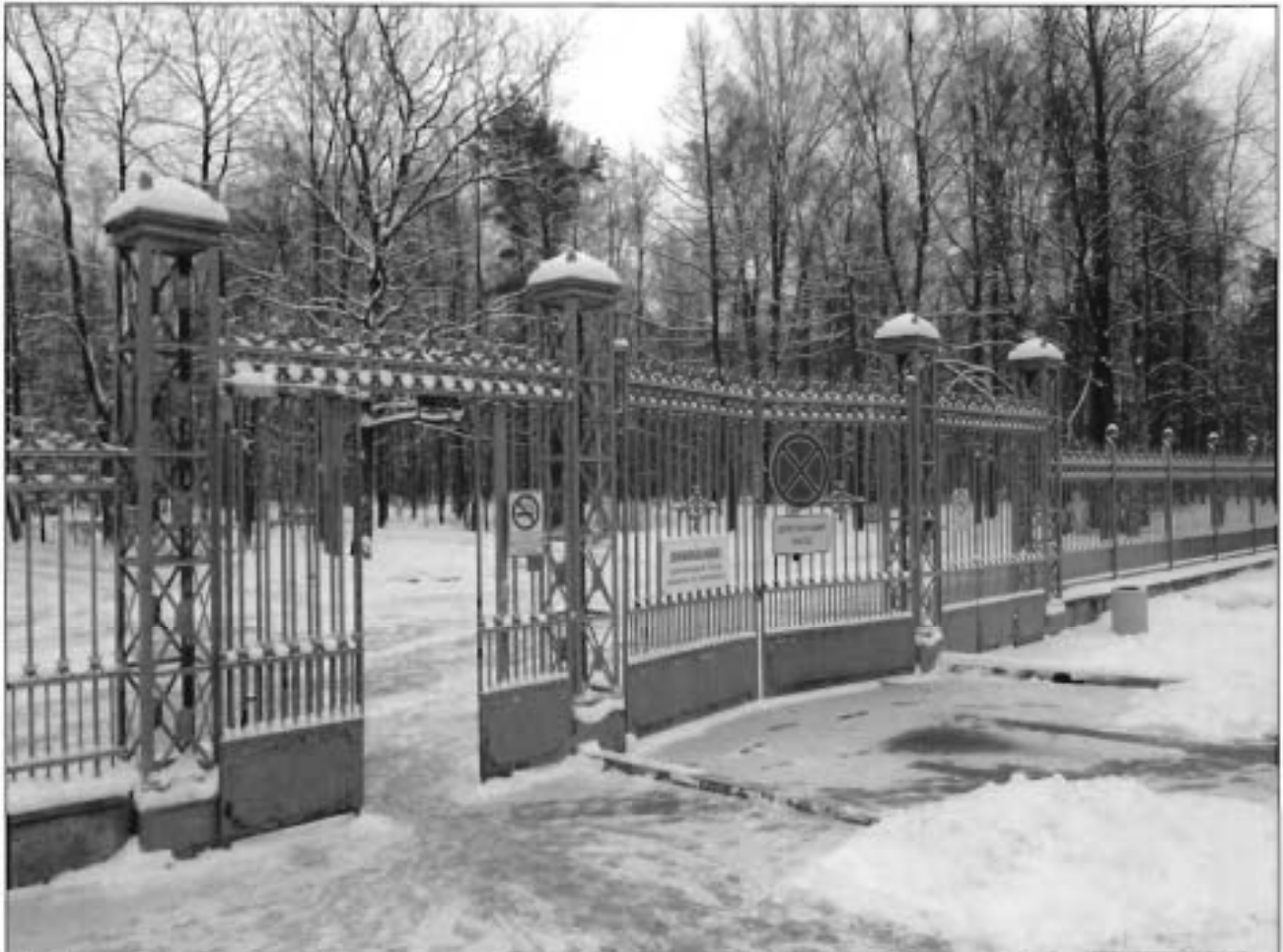
1. Часть объекта культурного наследия: ворота и калитки со стороны ул. Политехнической (в створе ул. Курчатова). Вид с северо-запада.
