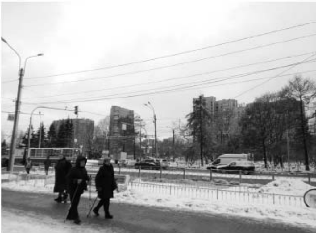
Фото 20. Территория проведения работ по реконструкции электрических сетей и устройств наружного освещения объекта: Политехническая ул. от пл. Мужества до Тихорецкого пр. Вид от пл. Мужества на Политехническую ул. Направление съемки запад.
