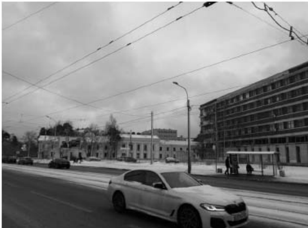
Фото 7. Территория проведения работ по реконструкции электрических сетей и устройств наружного освещения объекта: Политехническая ул. от пл. Мужества до Тихорецкого пр. Вид на ул. Политехническую и на выявленный ОКН «Главный корпус Физико-технологического института РАН им. А. Ф. Иоффе (с курдонером, садом, оградой)». Направление съемки юго-запад.
