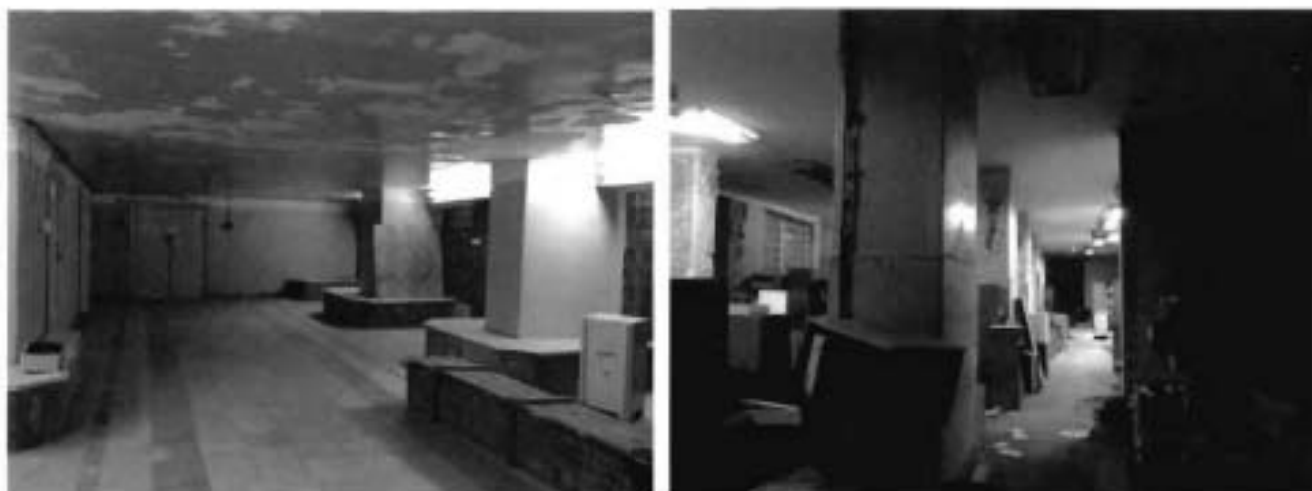
11, 12. Часть подвальных помещений.
