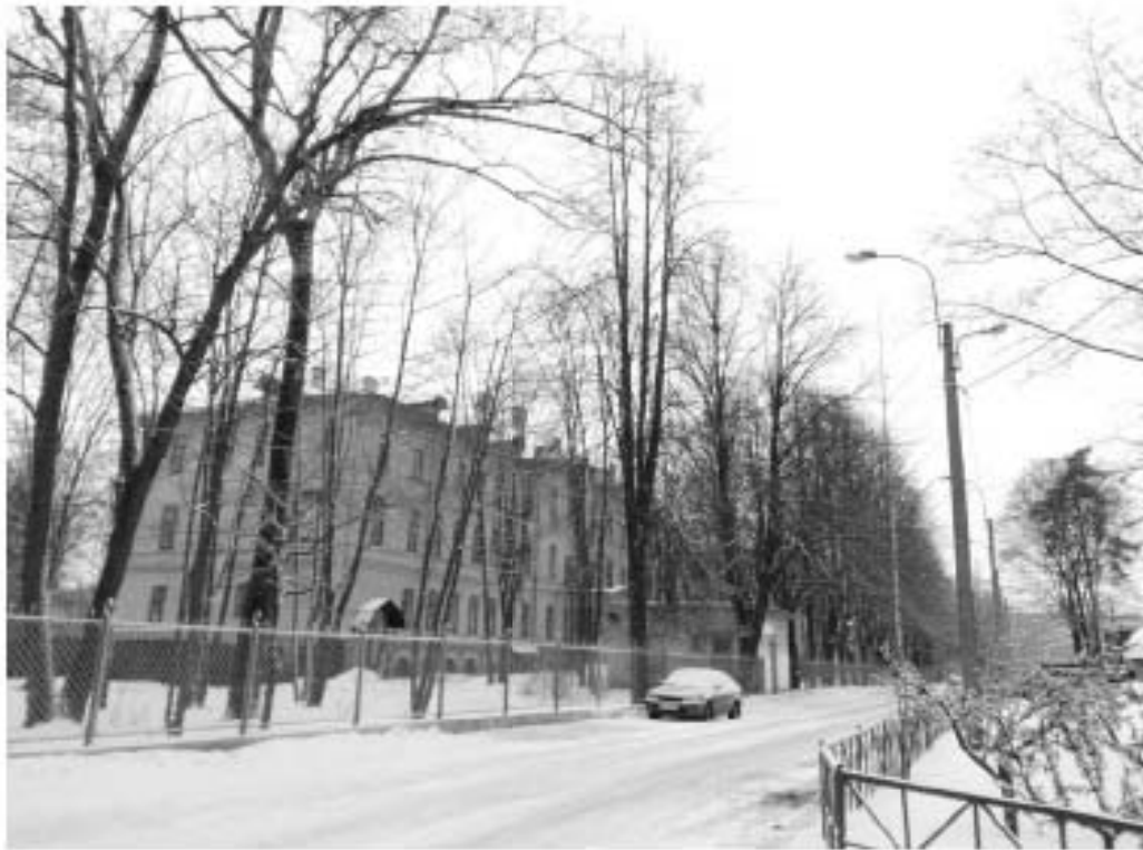
Фото 13. Территория проведения работ по реконструкции электрических сетей и устройств наружного освещения объекта: Политехническая ул. от пл. Мужества до Тихорецкого пр. Вид на ОКН регионального значения «Еленинская женская раковая больница им. А.Г. и Е.И. Елисеевых». Направление съемки северо-запад.
