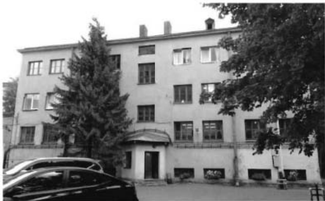
4. Фрагмент западного фасада объекта культурного наследия.
