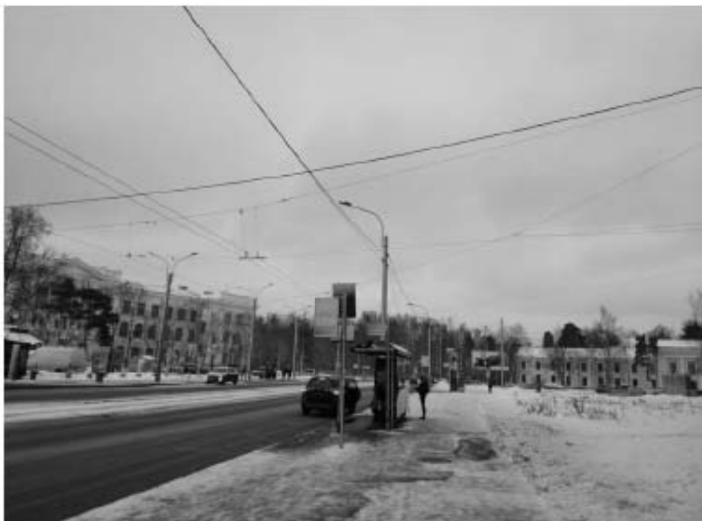
Фото 14. Территория проведения работ по реконструкции электрических сетей и устройств наружного освещения объекта: Политехническая ул. от пл. Мужества до Тихорецкого пр. Вид с ул. Политехнической на выявленный ОКН «Главный корпус Физико-технологического института РАН им. А.Ф. Иоффе (с курдонером, садом, оградой)» и ОКН федерального значения «Главное здание» и «Парк», входящие в состав ОКН федерального значения «Институт Санкт-Петербургский Политехнический императора Петра Великого». Направление съемки юг.
