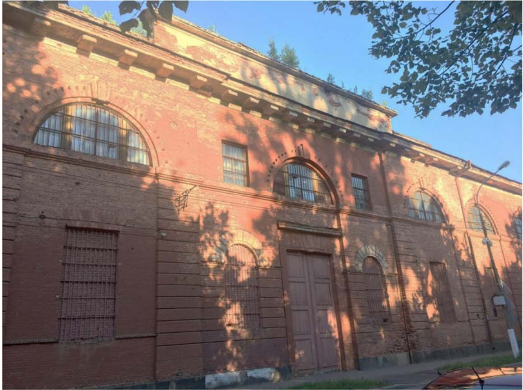
Илл. 9. Объект культурного наследия федерального значения «Арсенал», г. Кронштадт, ул. Макаровская, д. 2, лит А, Щ. Вид на фасад по пер. Арсенальному. Направление съемки юго-восток.
