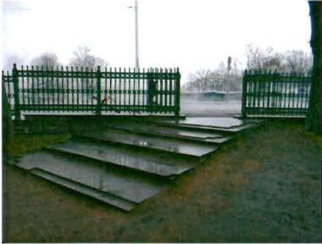
3. Угловые ворота на пересечении ул. Макаровской и Петровского канала.
