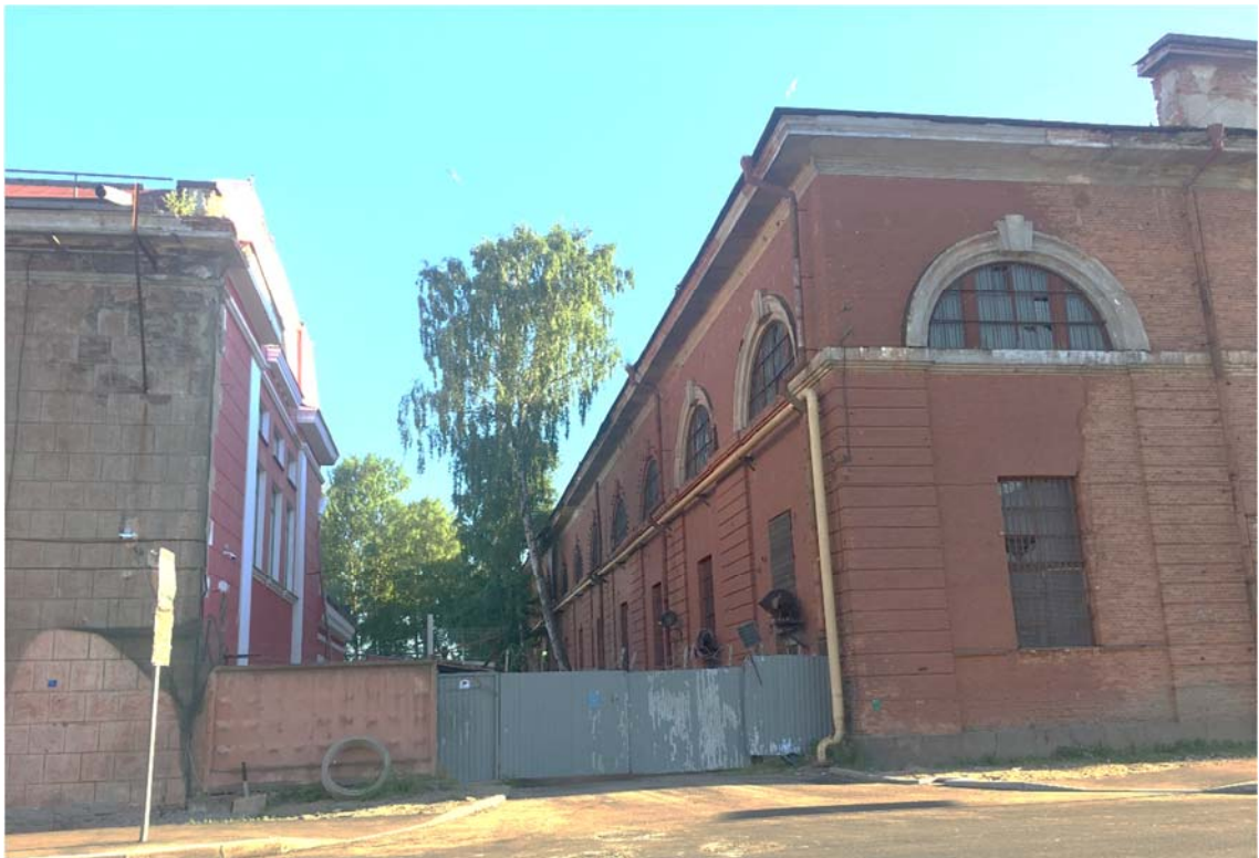
Илл. 4. Объект культурного наследия федерального значения «Арсенал», г. Кронштадт, ул. Макаровская, д. 2, лит А, Щ. Вид на фасад, выходящий на дворовую территорию с ул. Макаровской. Направление съемки юго-запад.
