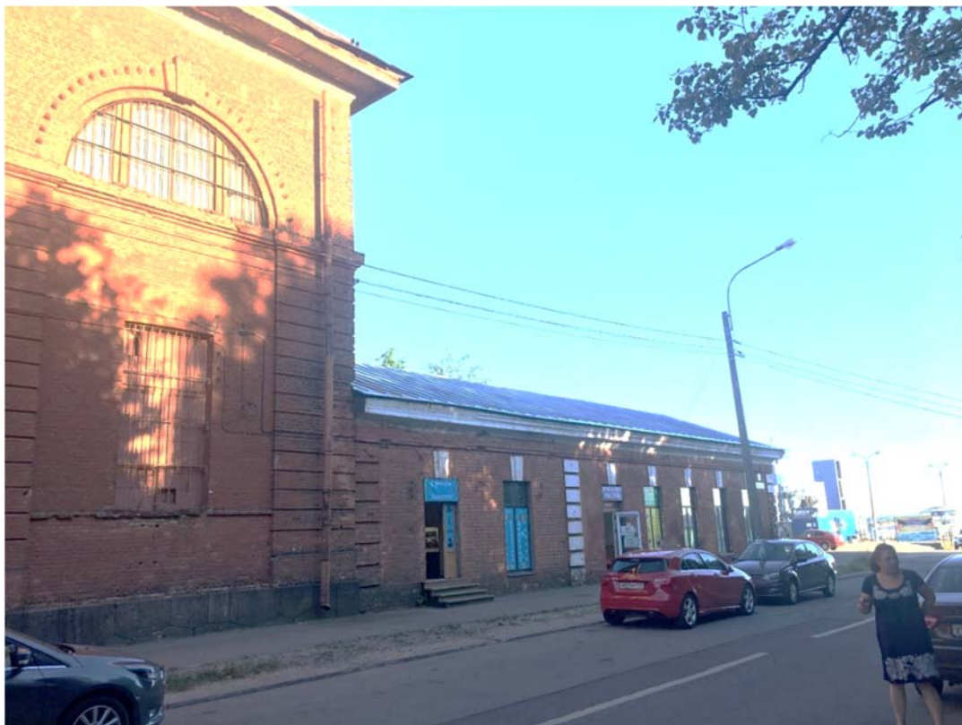
Илл. 11. Объект культурного наследия федерального значения «Арсенал», г. Кронштадт, ул. Макаровская, д. 2, лит А, Щ. Вид на фасад по пер. Арсенальному. Направление съемки юго-запад.
