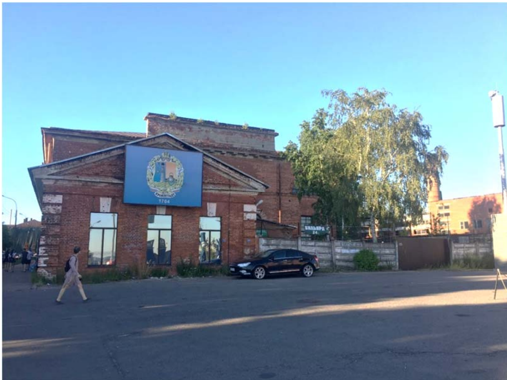
Илл. 14. Объект культурного наследия федерального значения «Арсенал», г. Кронштадт, ул. Макаровская, д. 2, лит А, Щ. Вид на фасад по со стороны набережной. Направление съемки север.
