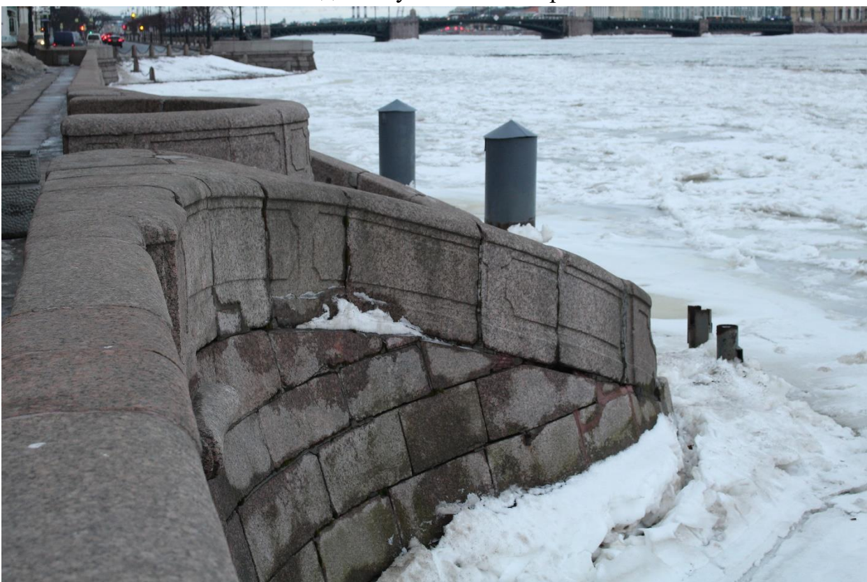
Фото 4. Вид на спуск № 6 с северо-востока.
