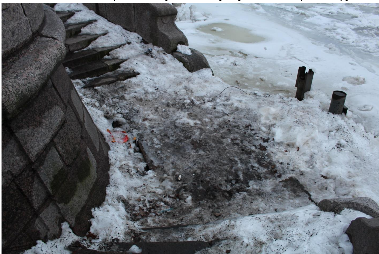
Фото 8. Вид на нижнюю площадку спуска № 6.
