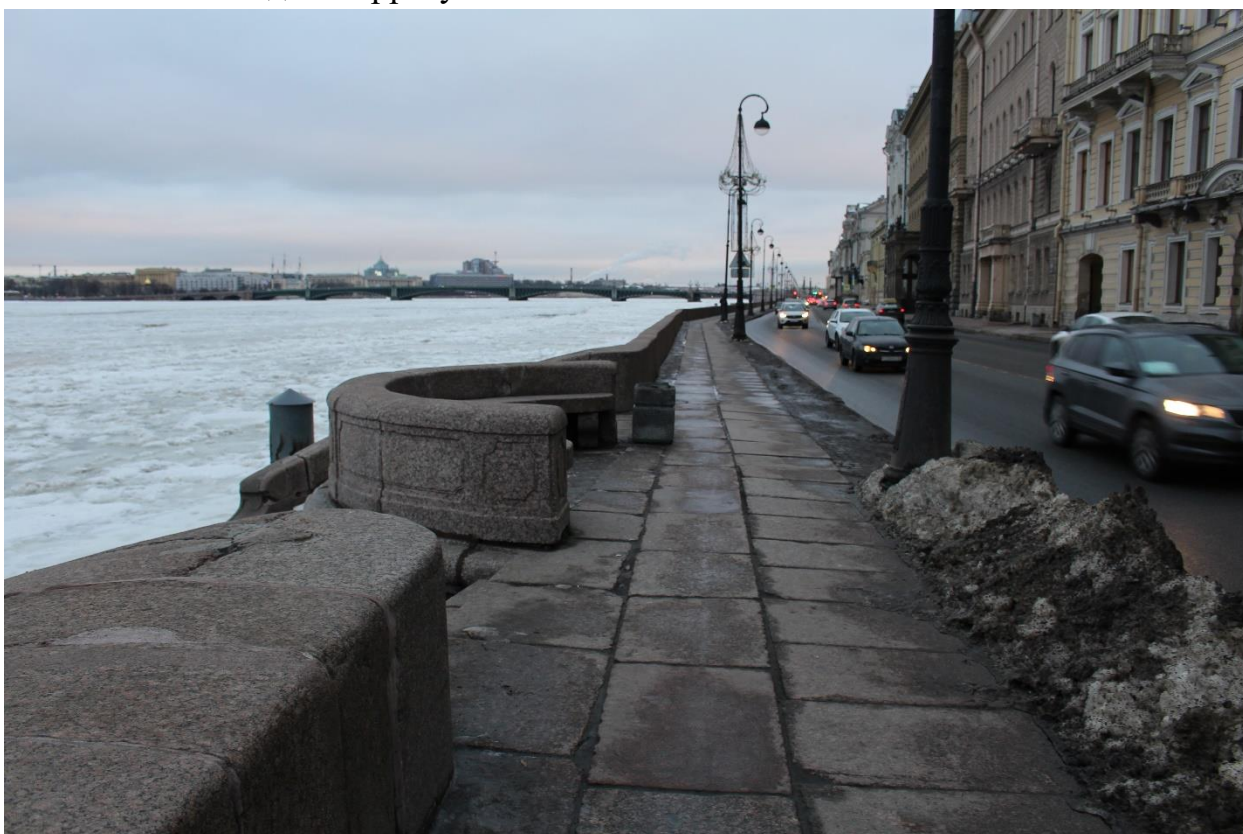
Фото 16. Вид на спуск № 6 с юго-запада.
