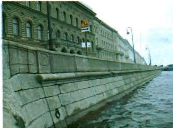
13. Вид стенки набережной от спуска у дома № 24 по течению реки
