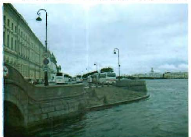
14. Участок набережной, примыкающий к Эрмитажному мосту
