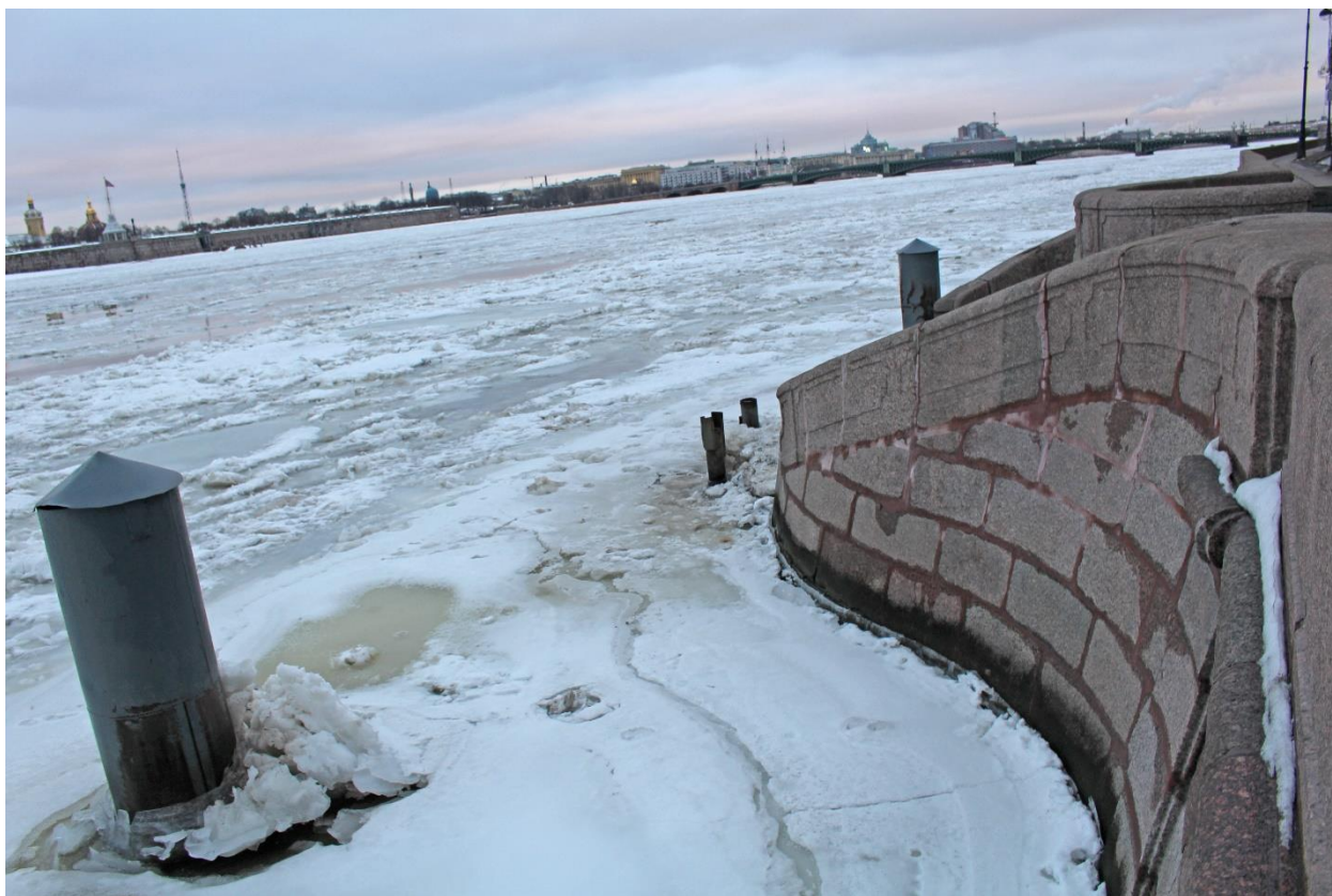
Фото 17. Вид на спуск № 6 с юго-запада.
