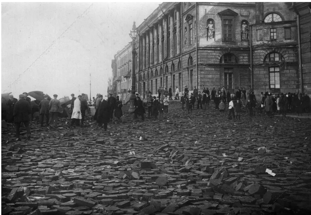
Илл. 13. Разрушенная наводнением мостовая у Эрмитажного театра. 1924 г. (источник: https://pastvu.com/p/911987 ).
