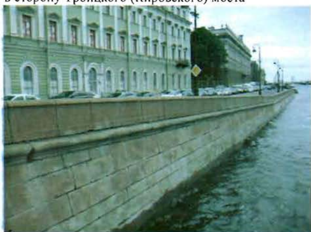
6. Вид стенки набережной от Троицкого (Кировского) моста по течению реки
