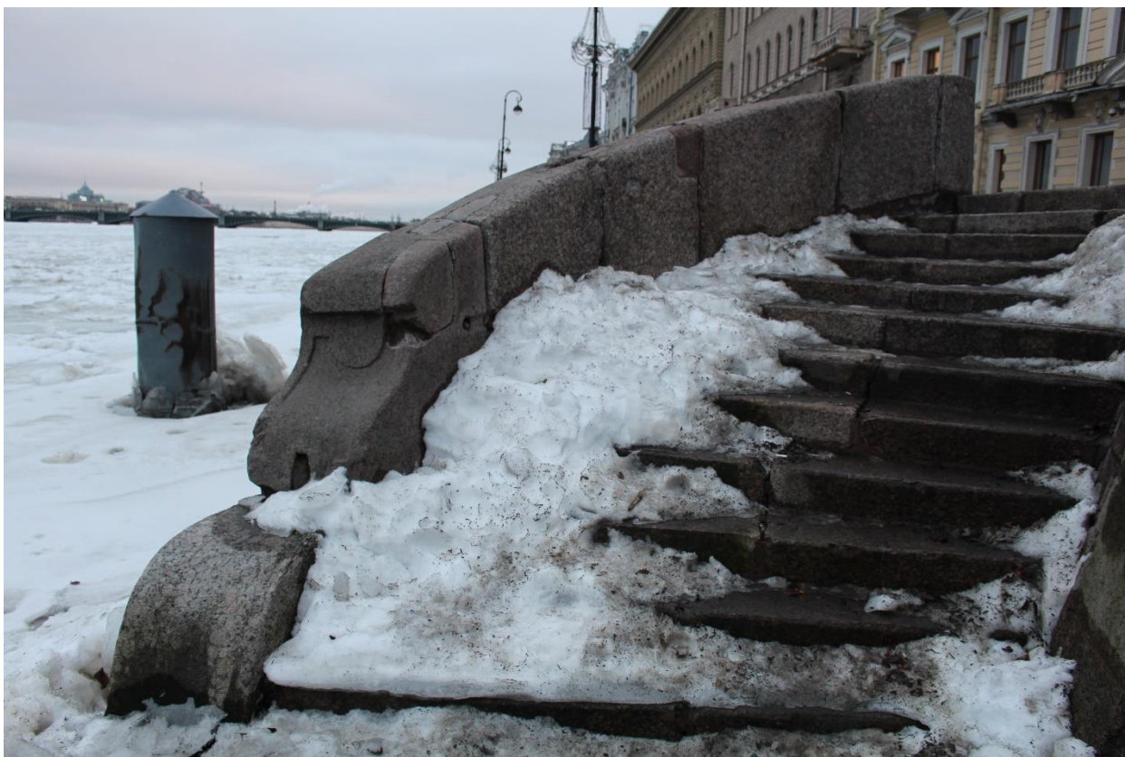
Фото 9. Вид на северо-восточную лестницу спуска № 6 с нижнего яруса.
