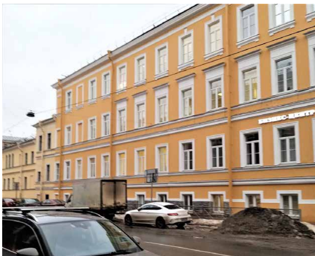
1. Объект культурного наследия регионального значения «10-я и 11-я солдатские казармы», по адресу: Санкт-Петербург, ул. Радищева, д.39, л. Д, в составе объекта культурного наследия регионального значения «Комплекс казарм лейб-гвардии Преображенского полка». Лицевой фасад. Дата съемки: 20.01.2021г.
