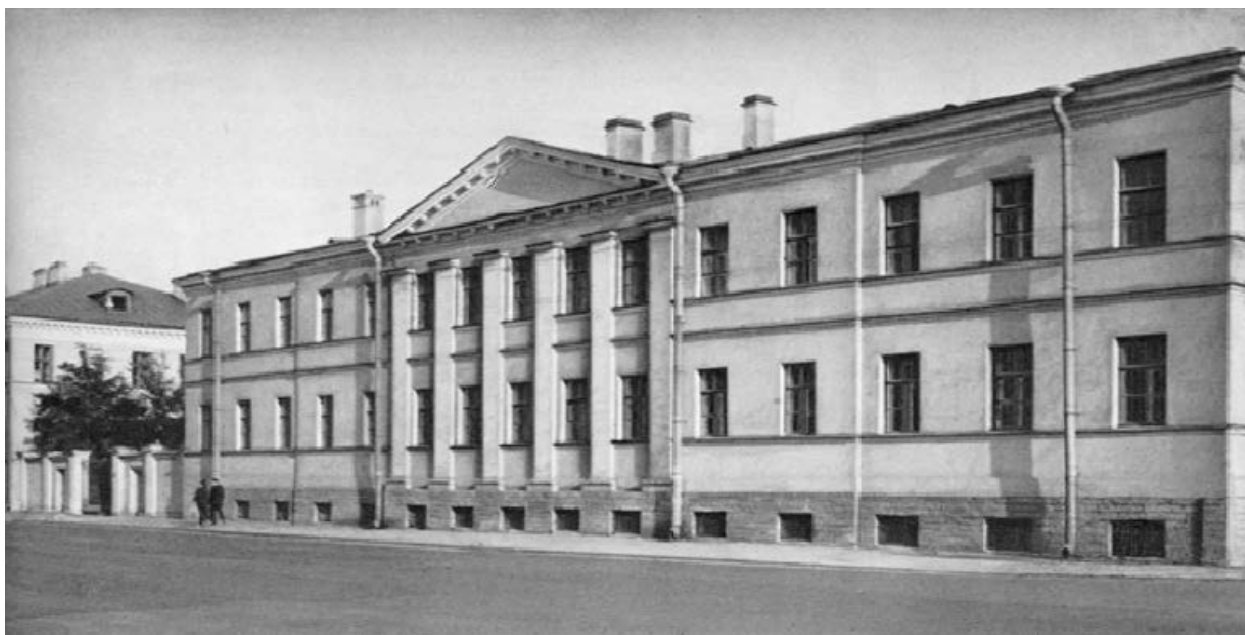
12. Казарма лейб-гвардии Преображенского полка на Кирочной улице. 1972 – 1973 гг. Источник: «Памятники архитектуры Ленинграда. гл. ред. Г.Н. Булдаков Изд. 4-е, перераб. Л., Стройиздат, ЛО, 1975.
