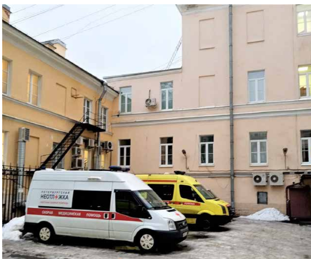
6. Объект культурного наследия регионального значения «10-я и 11-я солдатские казармы», по адресу: Санкт-Петербург, ул. Радищева, д.39, л. Д, в составе объекта культурного наследия регионального значения «Комплекс казарм лейб-гвардии Преображенского полка». Дворовый фасад с восточной стороны. Дата съемки: 20.01.2021г.
