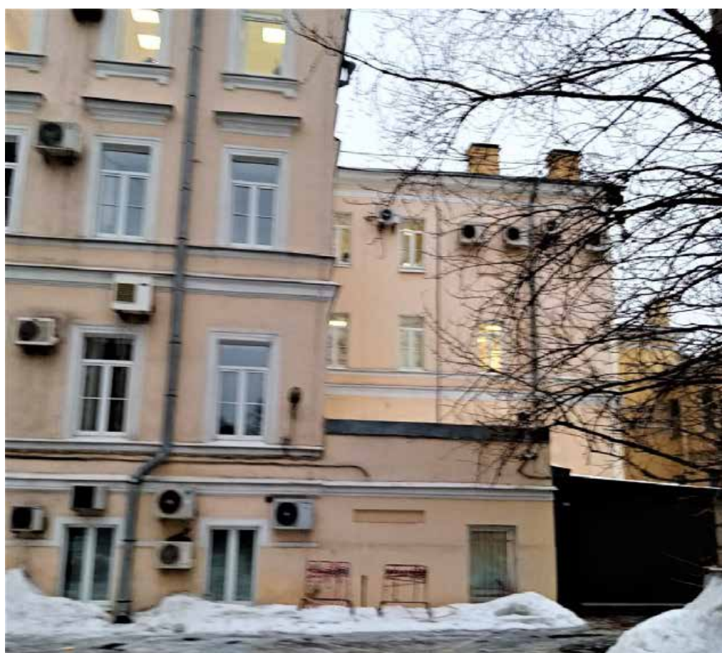
13. Объект культурного наследия регионального значения «10-я и 11-я солдатские казармы», по адресу: Санкт-Петербург, ул. Радищева, д.39, л. Д, в составе объекта культурного наследия регионального значения «Комплекс казарм лейб-гвардии Преображенского полка». Дворовый фасад с восточной стороны. Дата съемки: 20.01.2021г.
