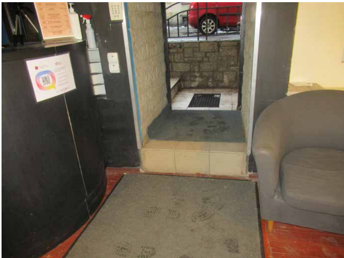
Фото 7. Фойе. Главный вход в помещение. Фрагмент прямка и лестницы.
