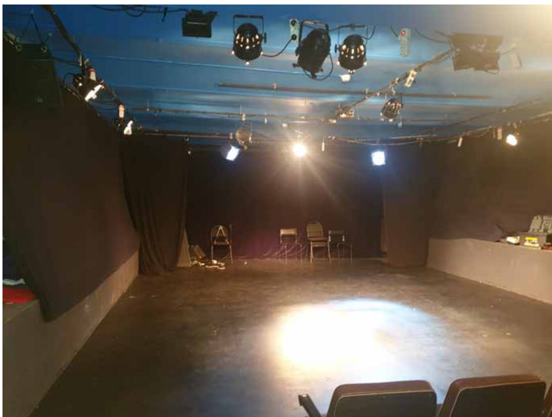
Фото 15. Зрительный зал. Вид на зону сцены, кулисы. По обеим сторонам ГСП конструкции, скрывающие отливы фундаментов.
