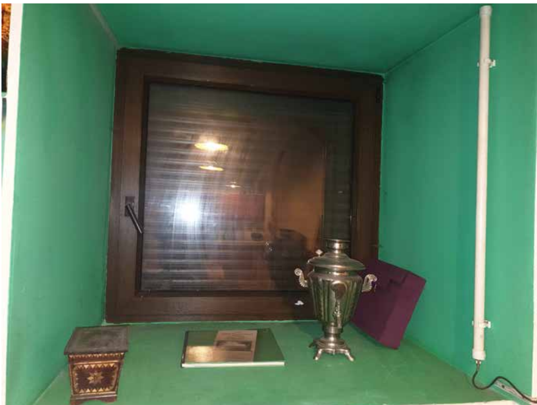
Фото 9. Фойе. Окно. Откосы, защиты конструкциями из плит ГСП
