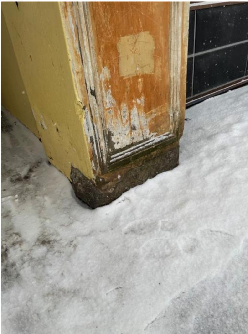
Фото 11. Повреждение фасада у примыкающей стены к демонтируемому зданию.
