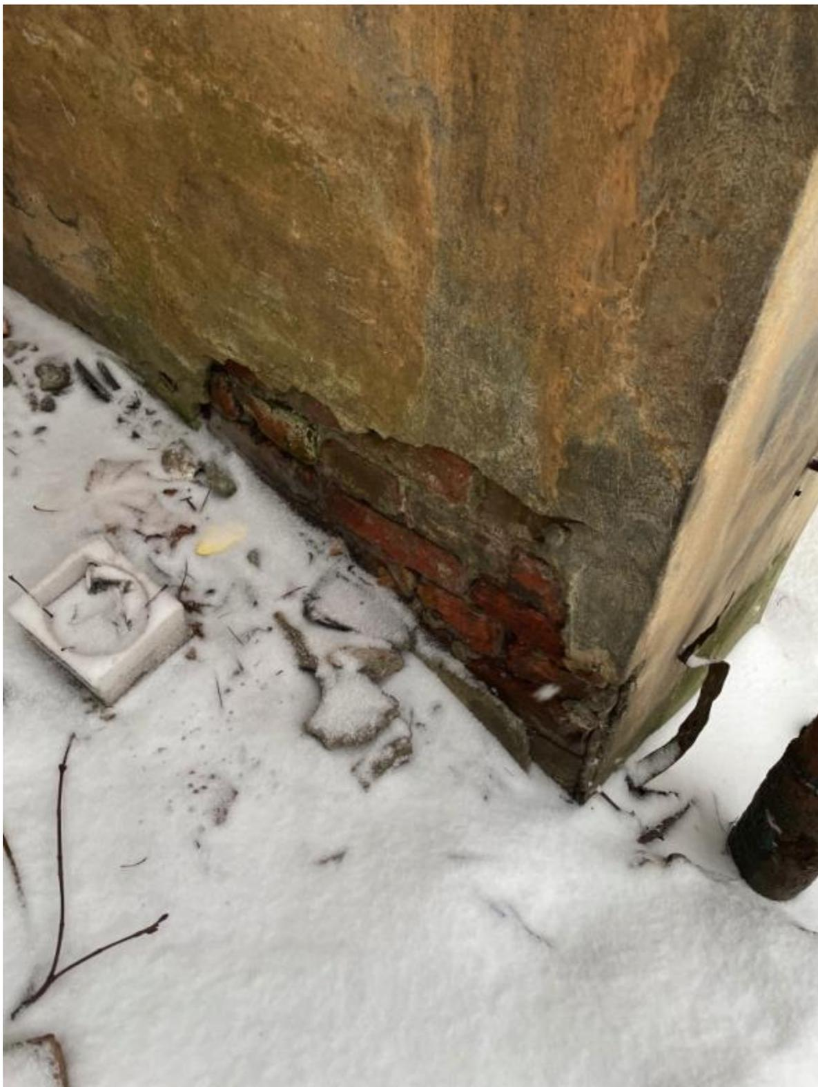
Фото 3. Место примыкания к демонтируемому зданию.
